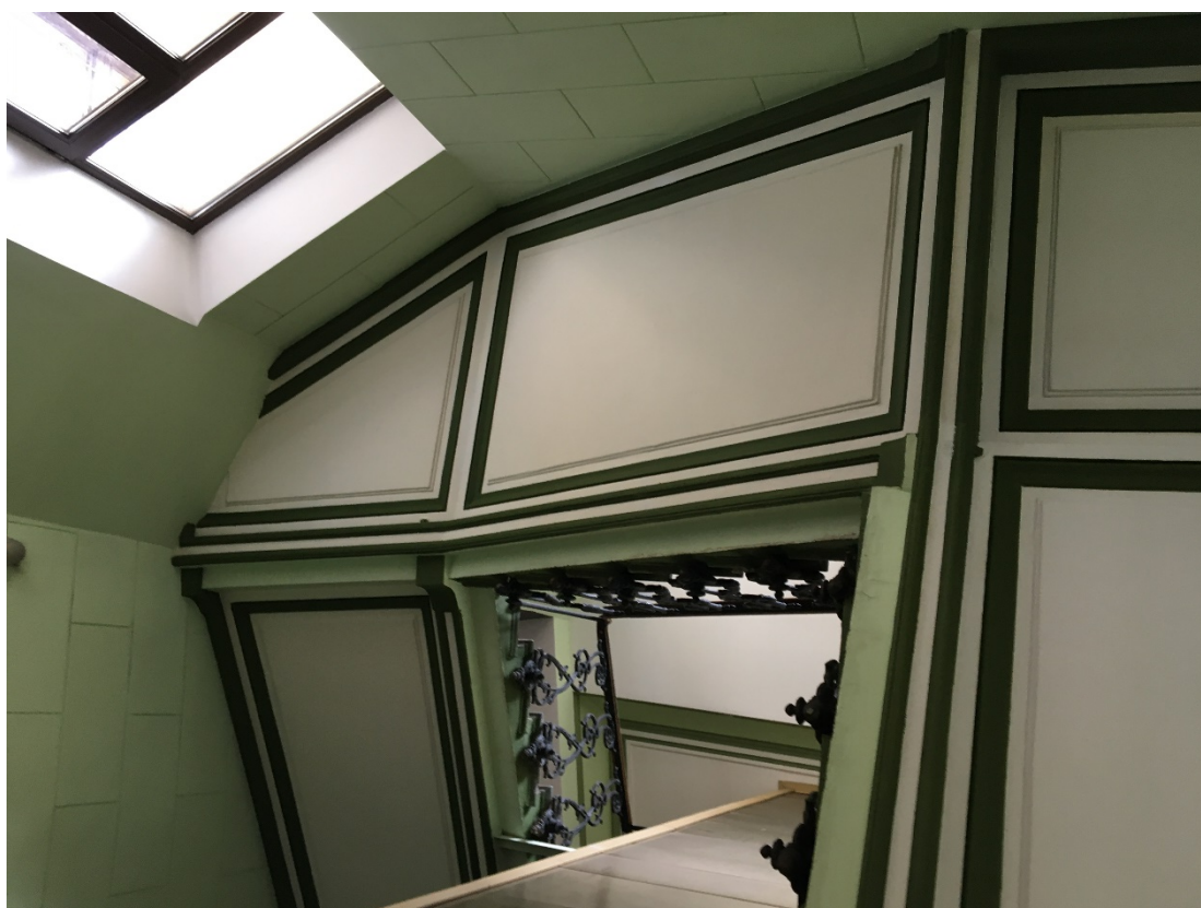
47. Парадная лестница 2ЛК. Оформление оснований площадок между 3 и 4 этажами.
