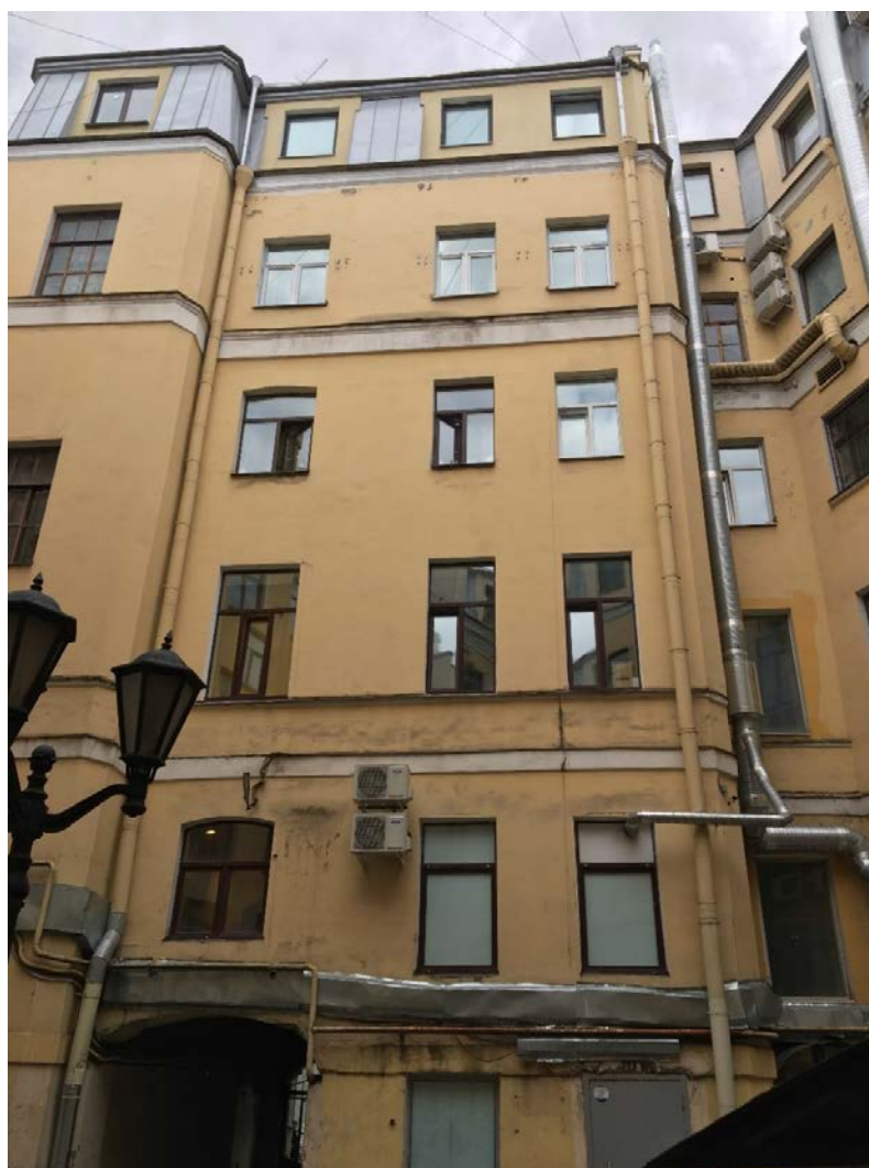
21. Фасад западного двора выявленного объекта культурного наследия «Дом А.И. Трейберга», расположенного по адресу: г. Санкт-Петербург, Невский пр., 11; Морская Малая ул., 2; Кирпичный пер., 2. Общий вид.
