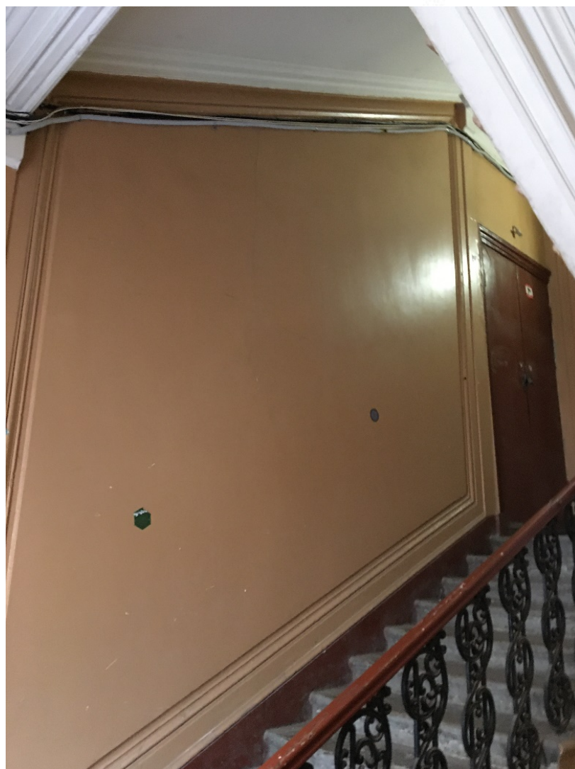
53. Лестница 4ЛК. Оформление стен.
