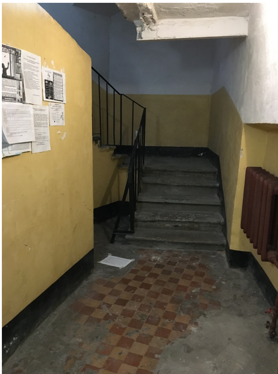
55. Лестница 5ЛК. Общий вид.
