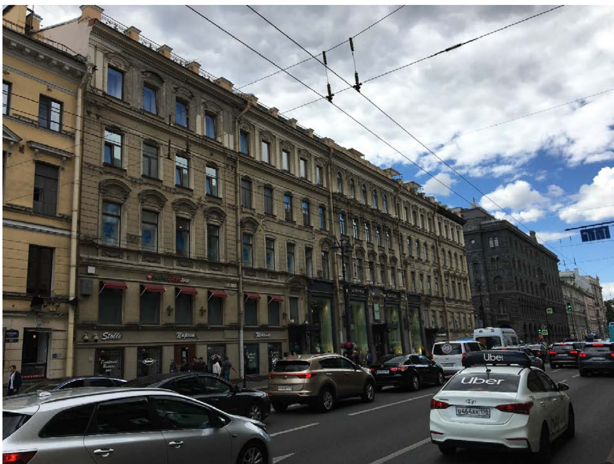
2. Лицевой фасад по Невскому проспекту выявленного объекта культурного наследия «Дом А.И. Трейберга», расположенного по адресу: г. Санкт-Петербург, Невский пр., 11; Морская Малая ул., 2; Кирпичный пер., 2
