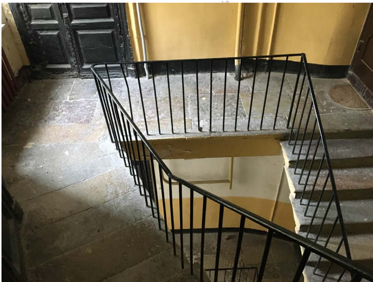
58. Лестница 5ЛК. Площадка 2 этажа.
