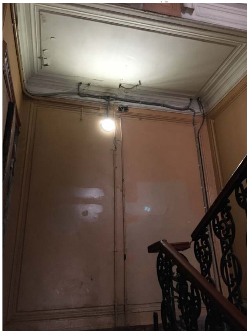
51. Лестница 4ЛК. Площадка 2 этажа.
