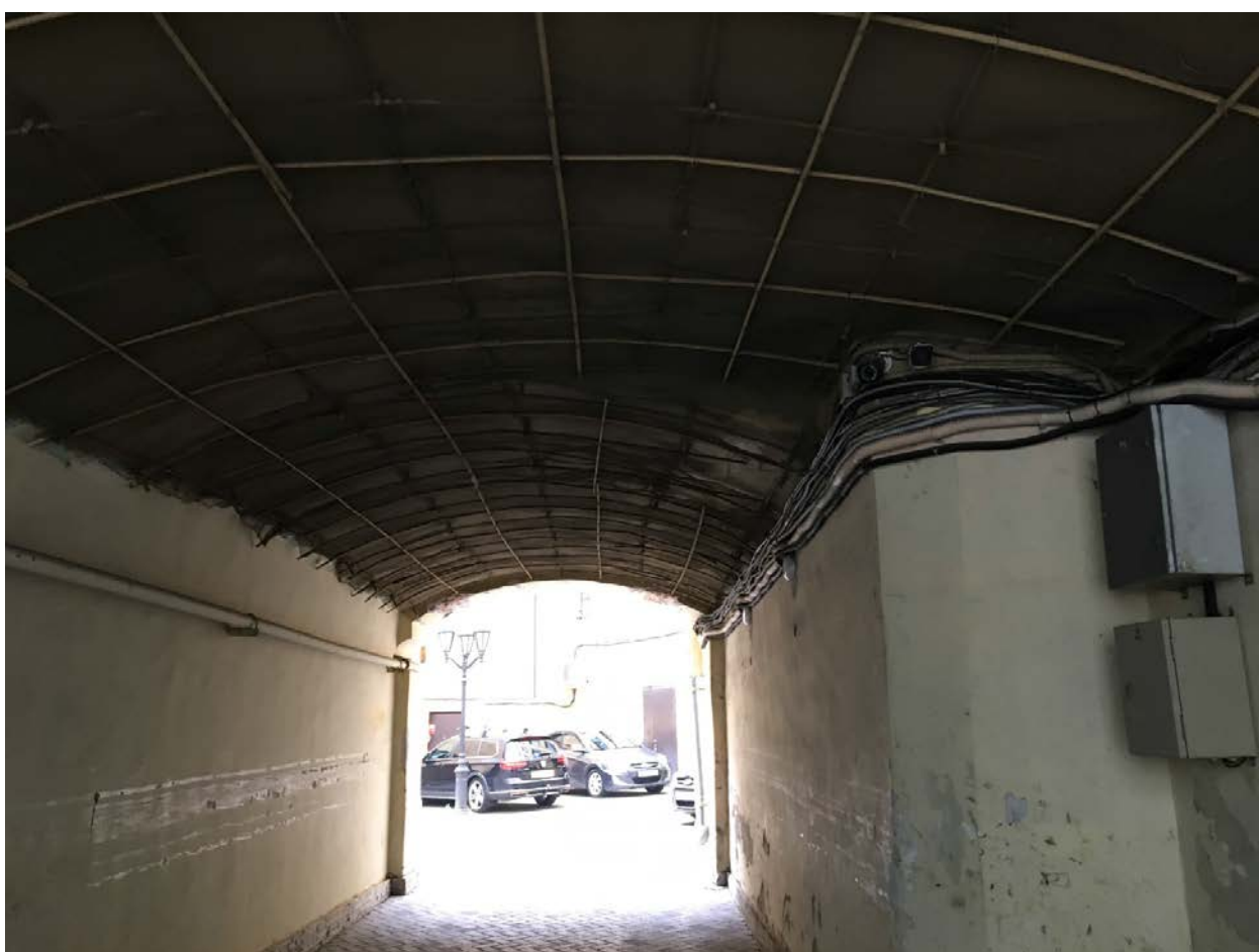
29. Проездная арка с Кирпичного переулка.
