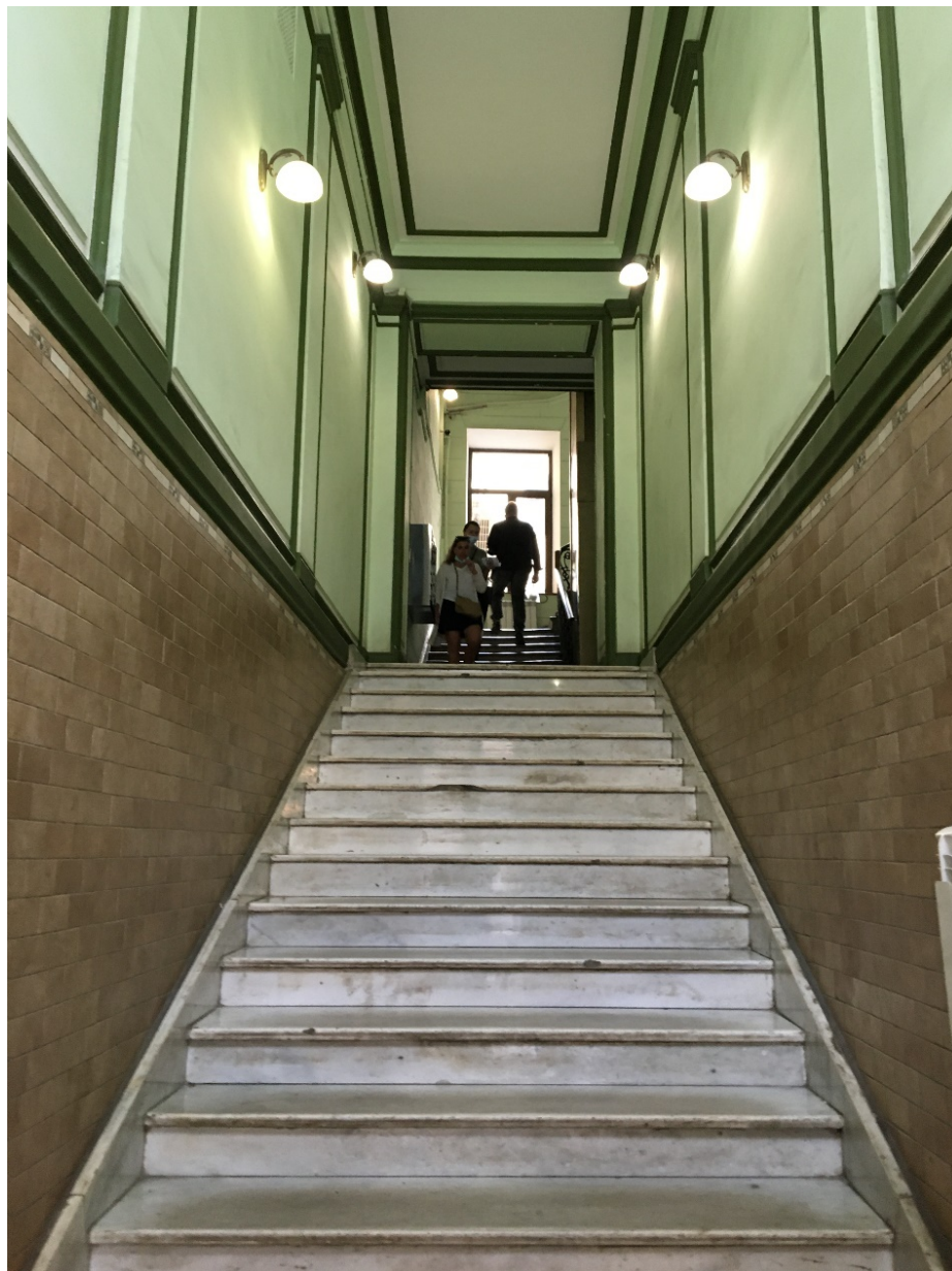
40. Парадная лестница 2ЛК. Парадный вестибюль. Общий вид.
