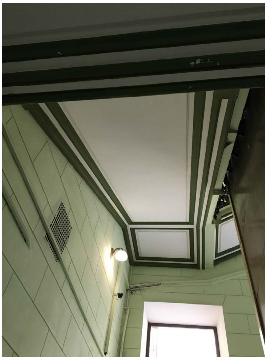
42. Парадная лестница 2ЛК. Общий вид.
