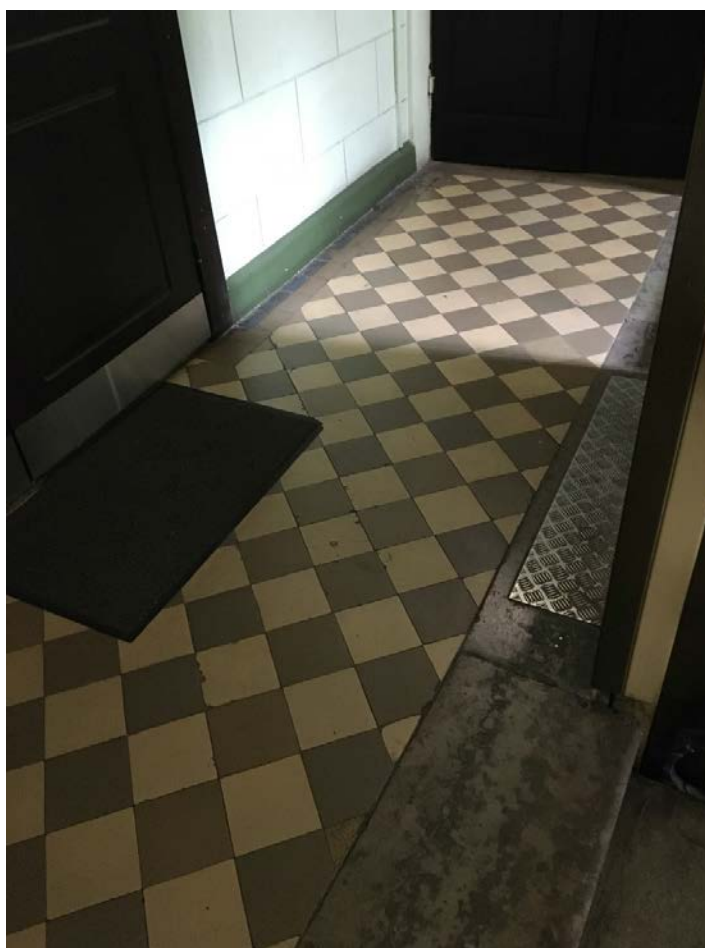
45. Парадная лестница 2ЛК. Площадка 2 этажа.
