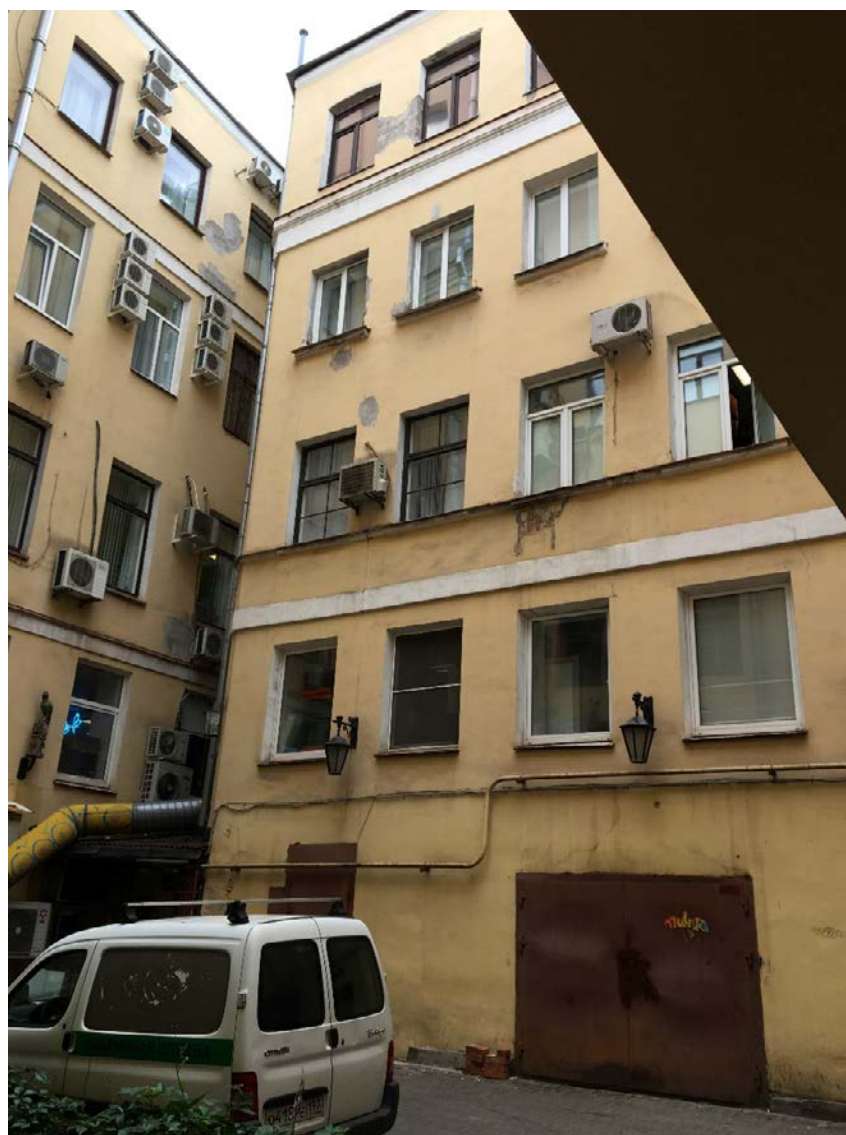
27. Фасад ы восточного двора. Общий вид.
