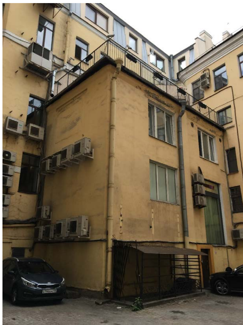
24. Фасад ы западного двора. Общий вид.
