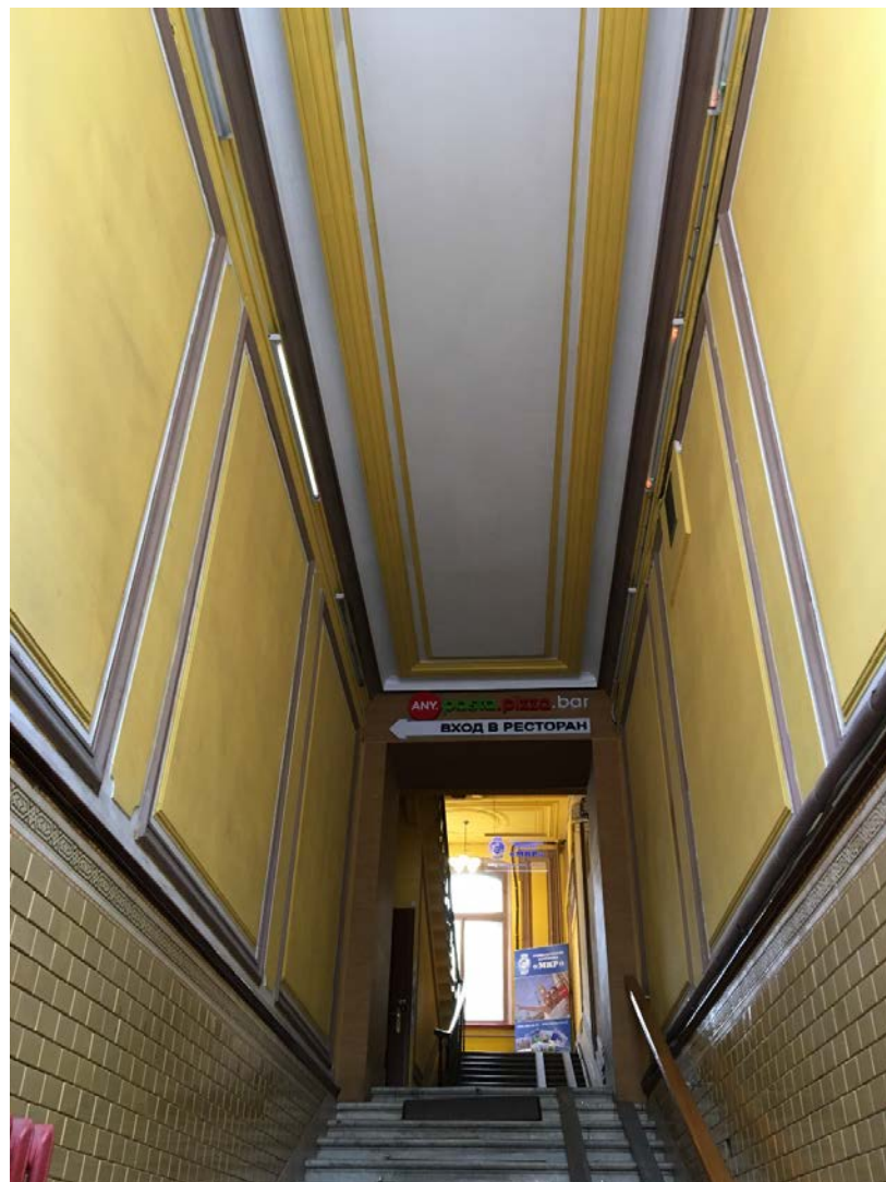
32. Парадная лестница 1ЛК. Парадный вестибюль. Общий вид.
