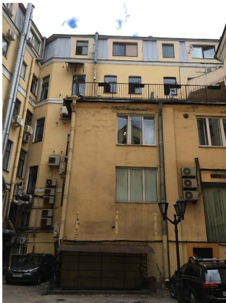
23. Фасад ы западного двора. Общий вид.
