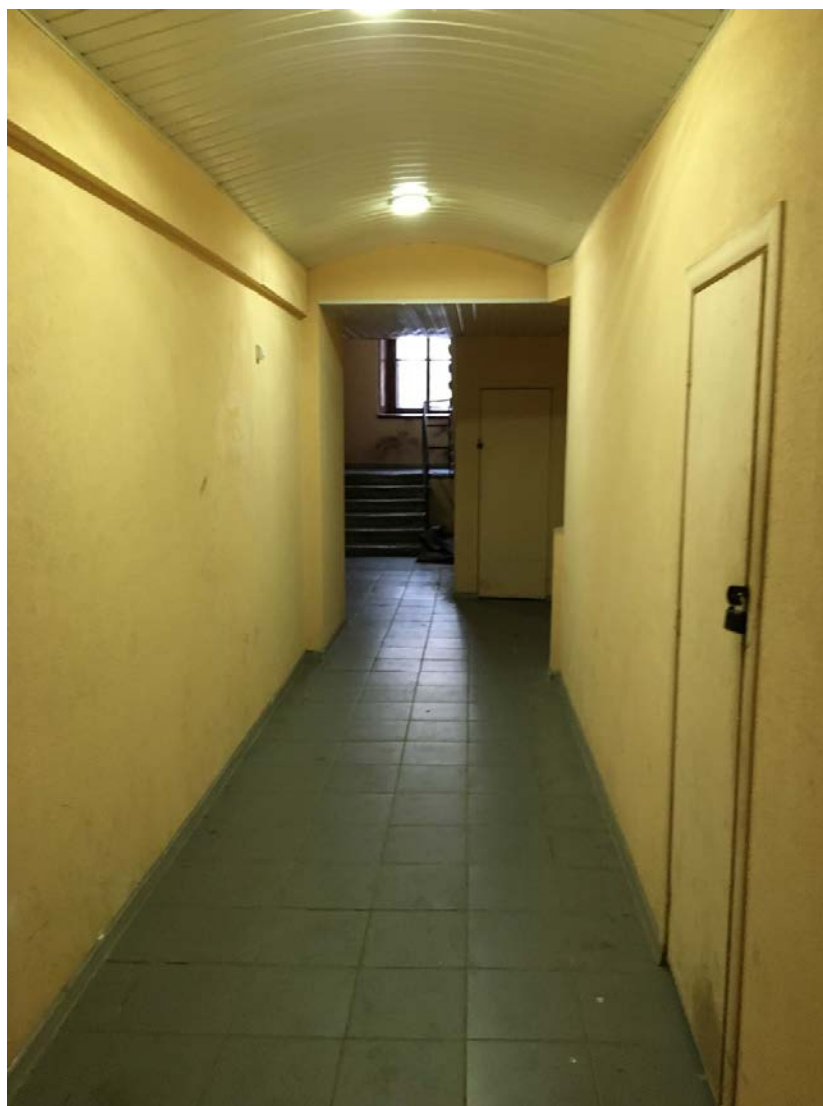
48. Лестница 4ЛК. Вестибюль. Общий вид.
