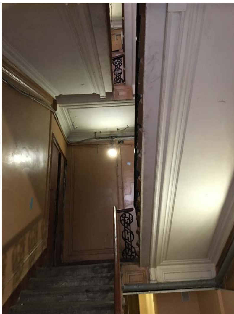
49. Лестница 4ЛК. Общий вид.
