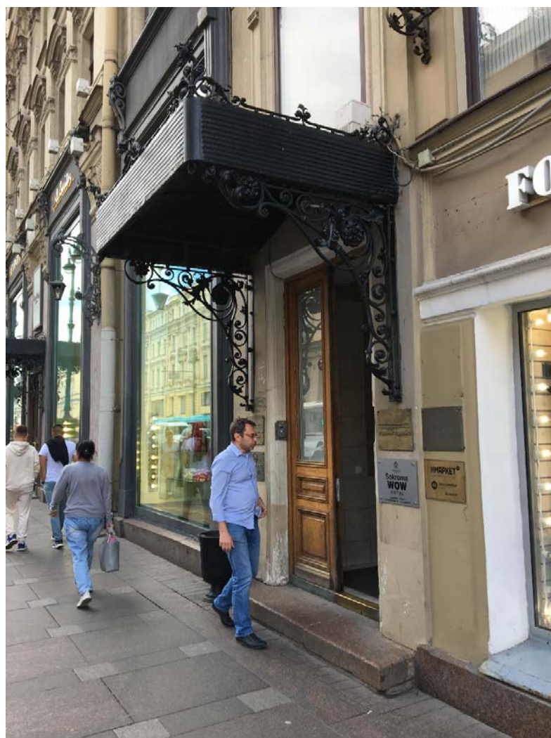
7. Лицевой фасад выявленного объекта культурного наследия «Дом А.И. Трейберга», расположенного по адресу: г. Санкт-Петербург, Невский пр., 11; Морская Малая ул., 2; Кирпичный пер., 2 по Невскому проспекту. Фрагмент. Входной проем 2ЛК.
