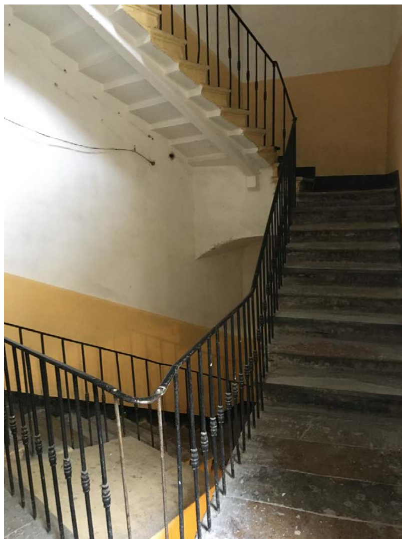
56. Лестница 5ЛК. Общий вид.
