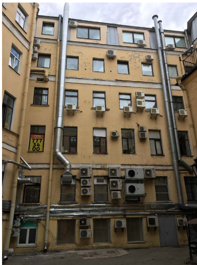
22. Фасад западного двора выявленного объекта культурного наследия «Дом А.И. Трейберга», расположенного по адресу: г. Санкт-Петербург, Невский пр., 11; Морская Малая ул., 2; Кирпичный пер., 2. Общий вид.
