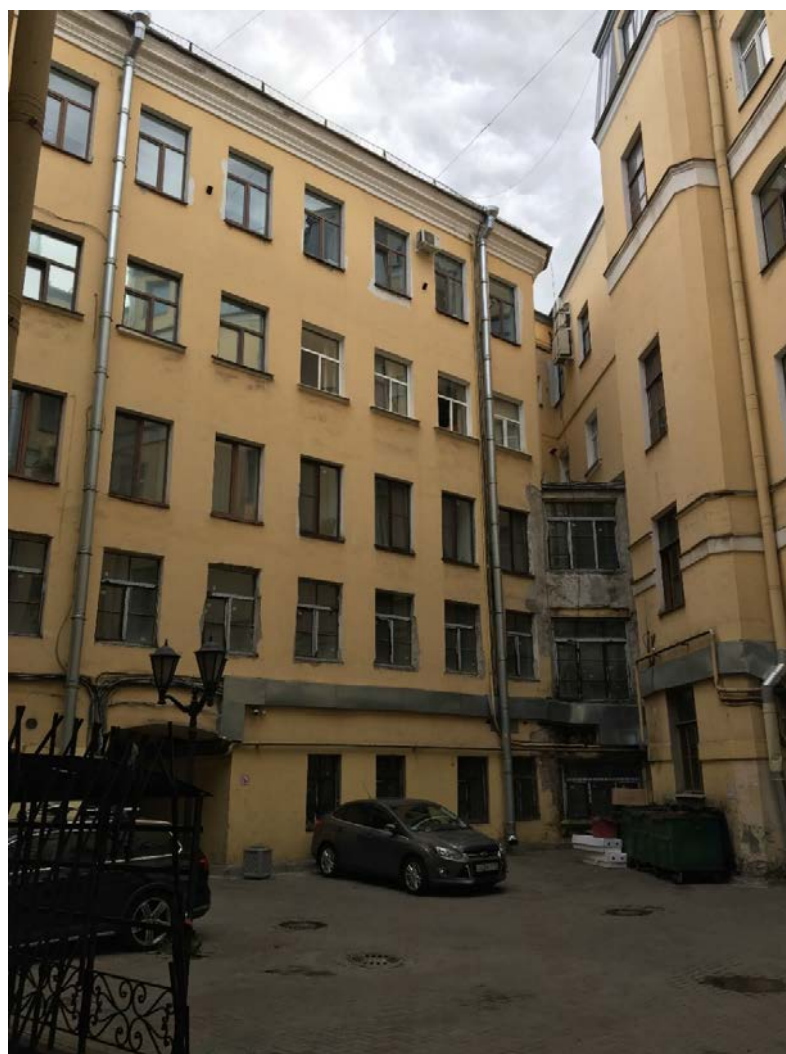
25. Фасады западного двора. Общий вид.
