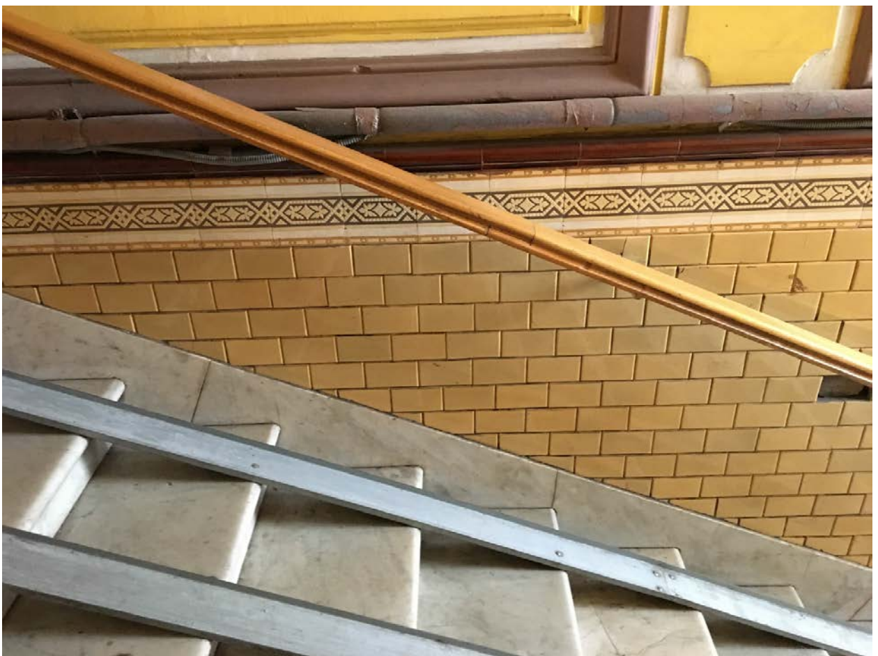
33. Парадная лестница 1ЛК. Оформление стен вестибюля 1 этажа.
