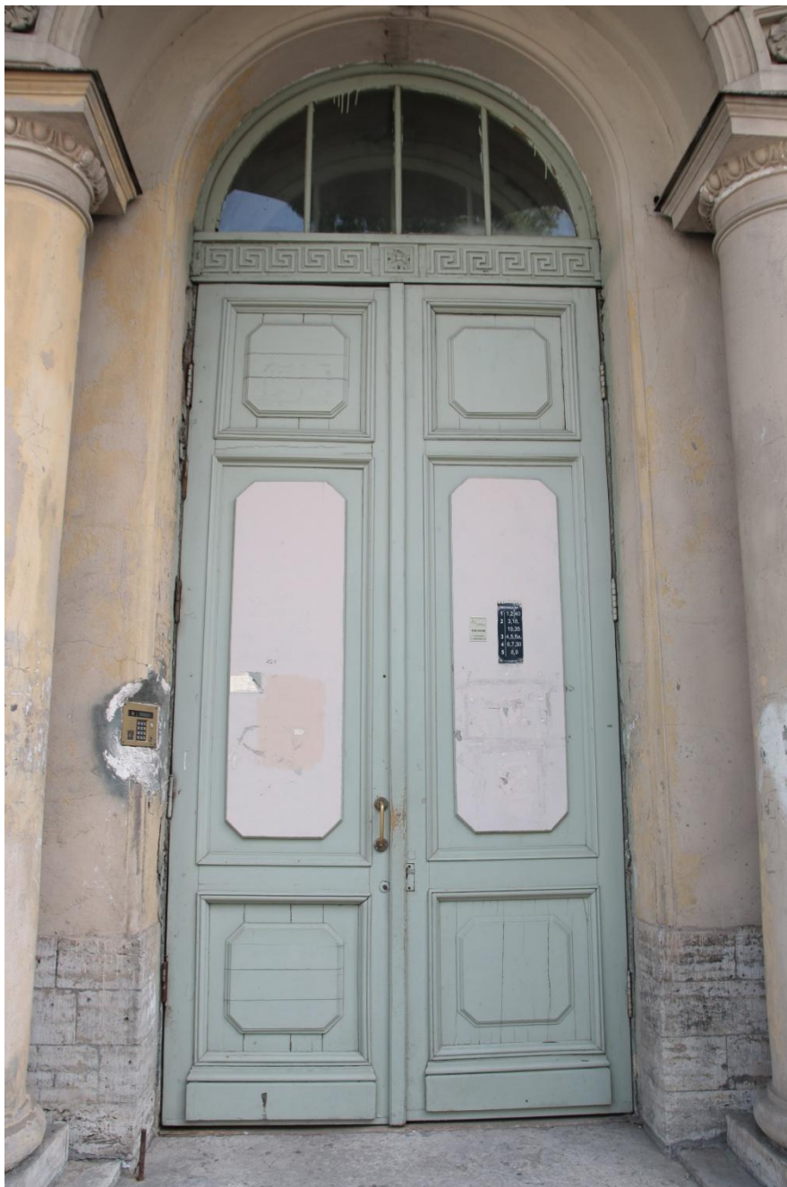
10. Фрагмент центральной части главного фасада по улице Таврическая. Дверь парадного входа. Вид с запада
