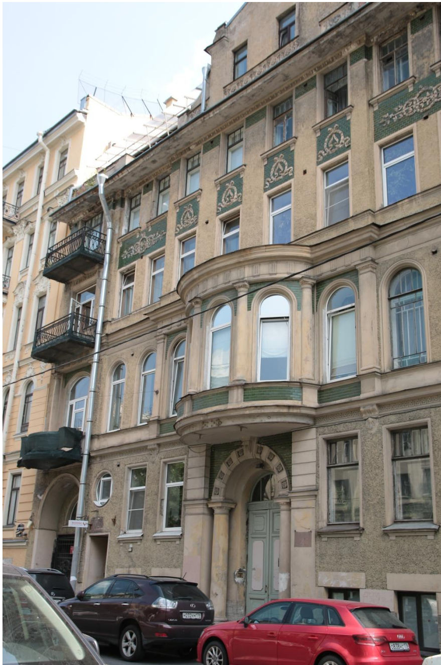
5. Фрагмент центральной части главного фасада по улице Таврическая. Вид с юго-запада
