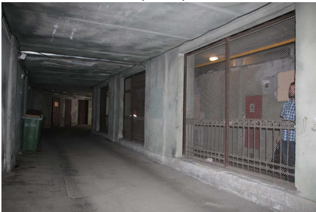
22. Проездная арка. Решетчатые перегородки между проездной аркой и аркой прохода во внутренний двор
