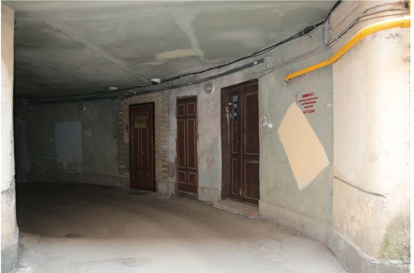
27. Дверные проемы в проездной арке
