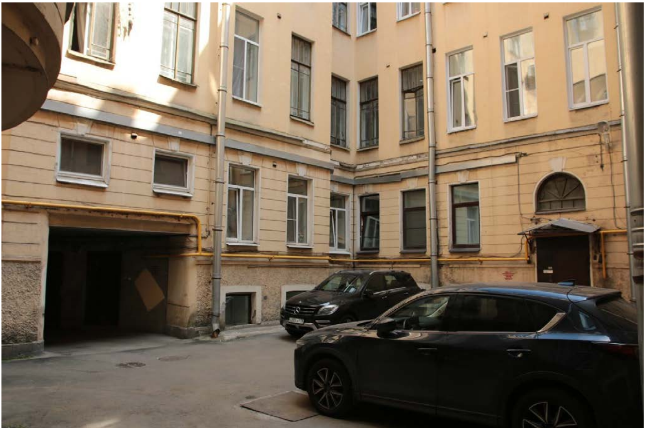
34. Фрагмент дворового фасада. Вид с юго-запада
