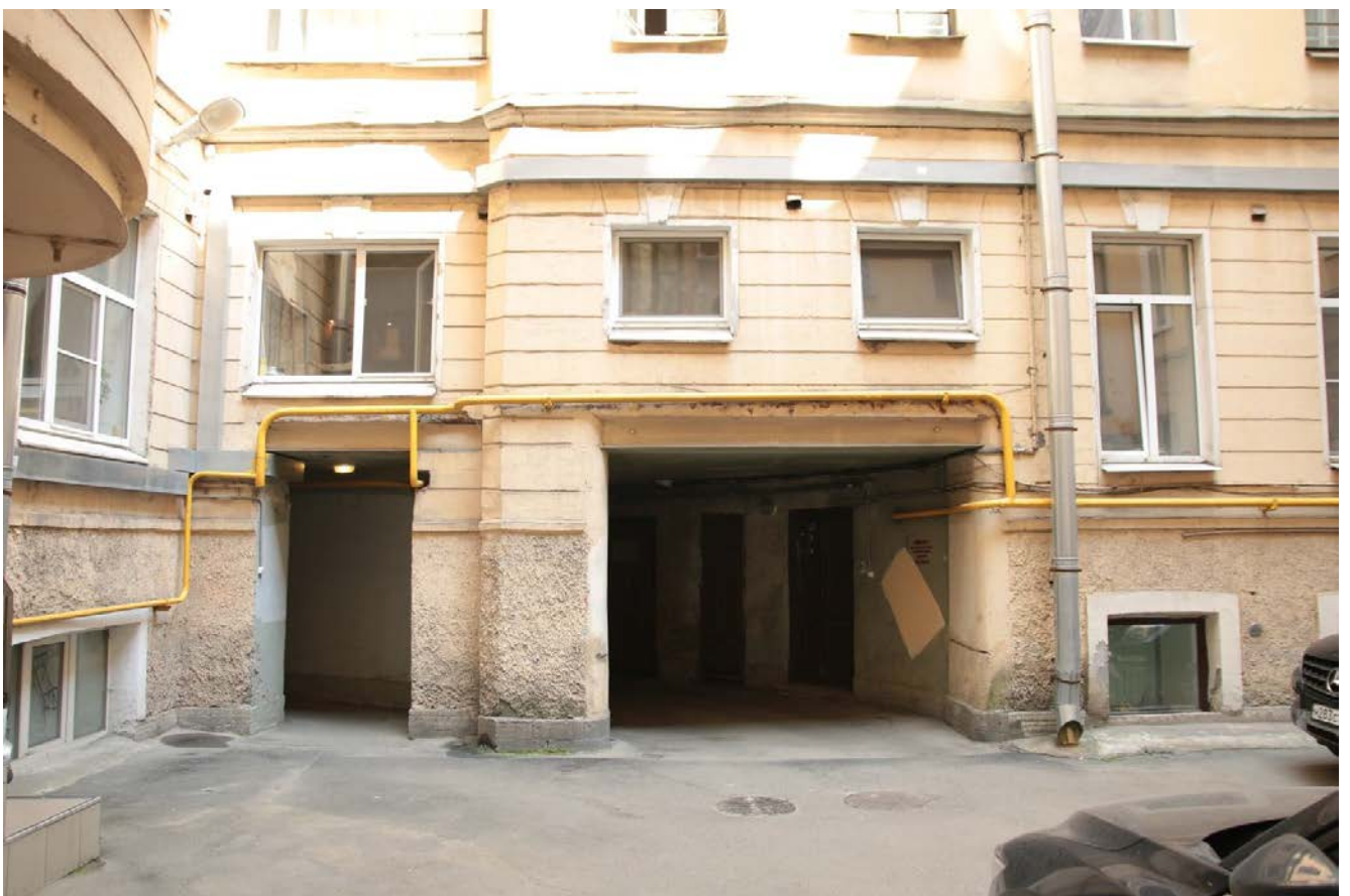
28. Проездная арка и арка прохода во внутренний двор. Оформление оконных проемов над арками. Вид с юга
