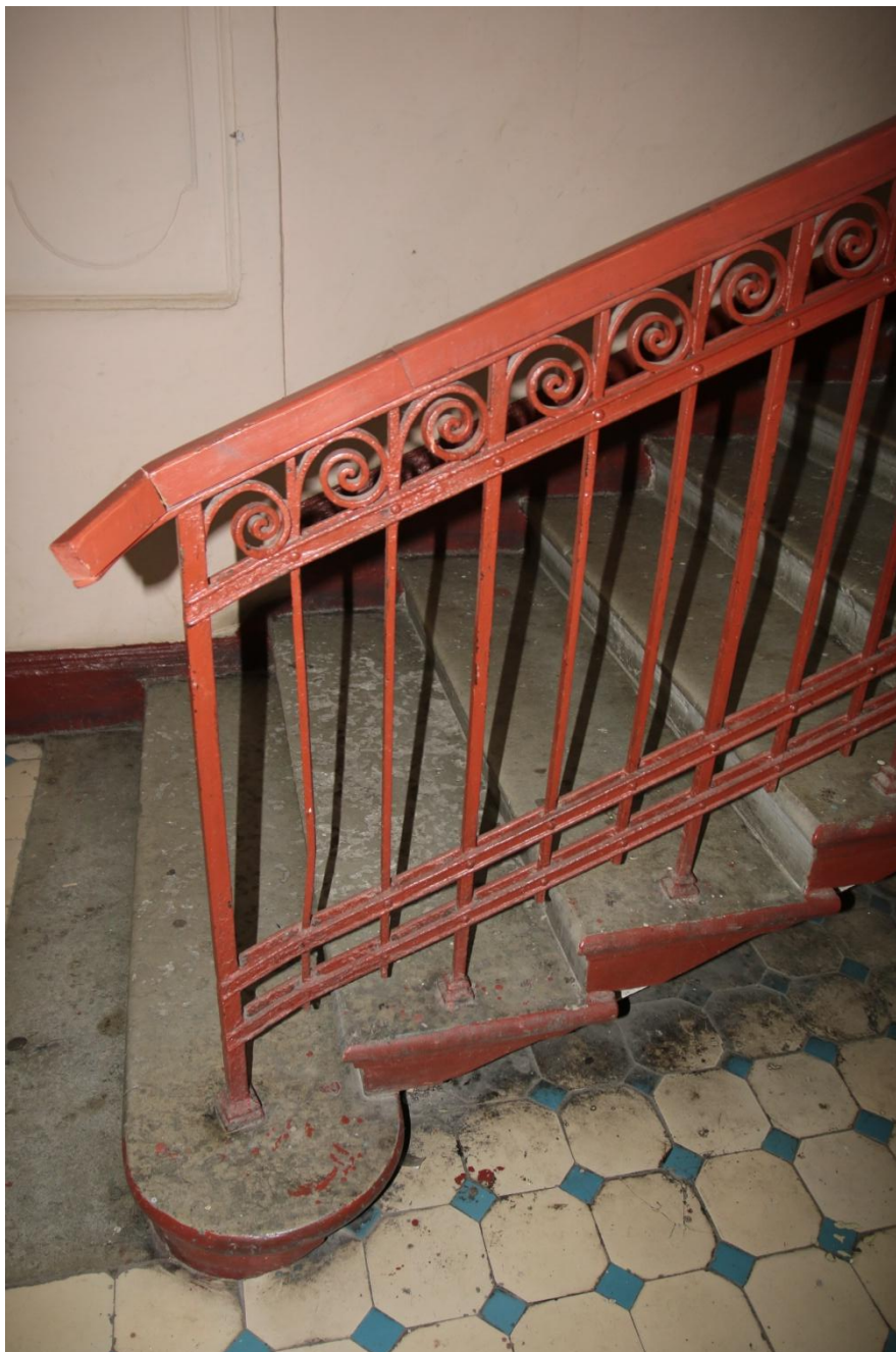
60. Интерьер вестибюля дворовой парадной. Фрагмент лестничного ограждения
