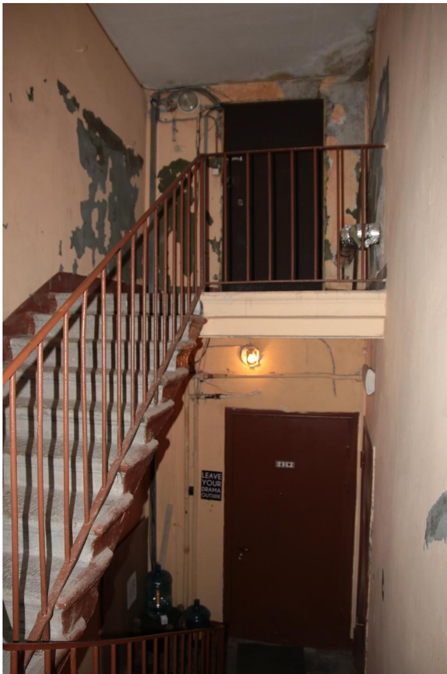
78. Интерьер дворовой парадной в проездной арке. Лестничная площадка мансардного этажа
