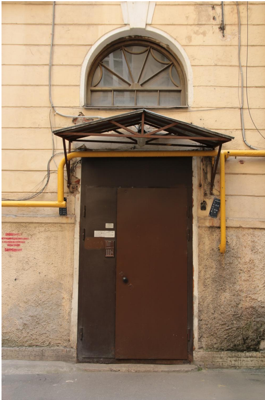
37. Фрагмент дворового фасада. Дверь входа в дворовую парадную с навесным металлическим козырьком. Вид с запада
