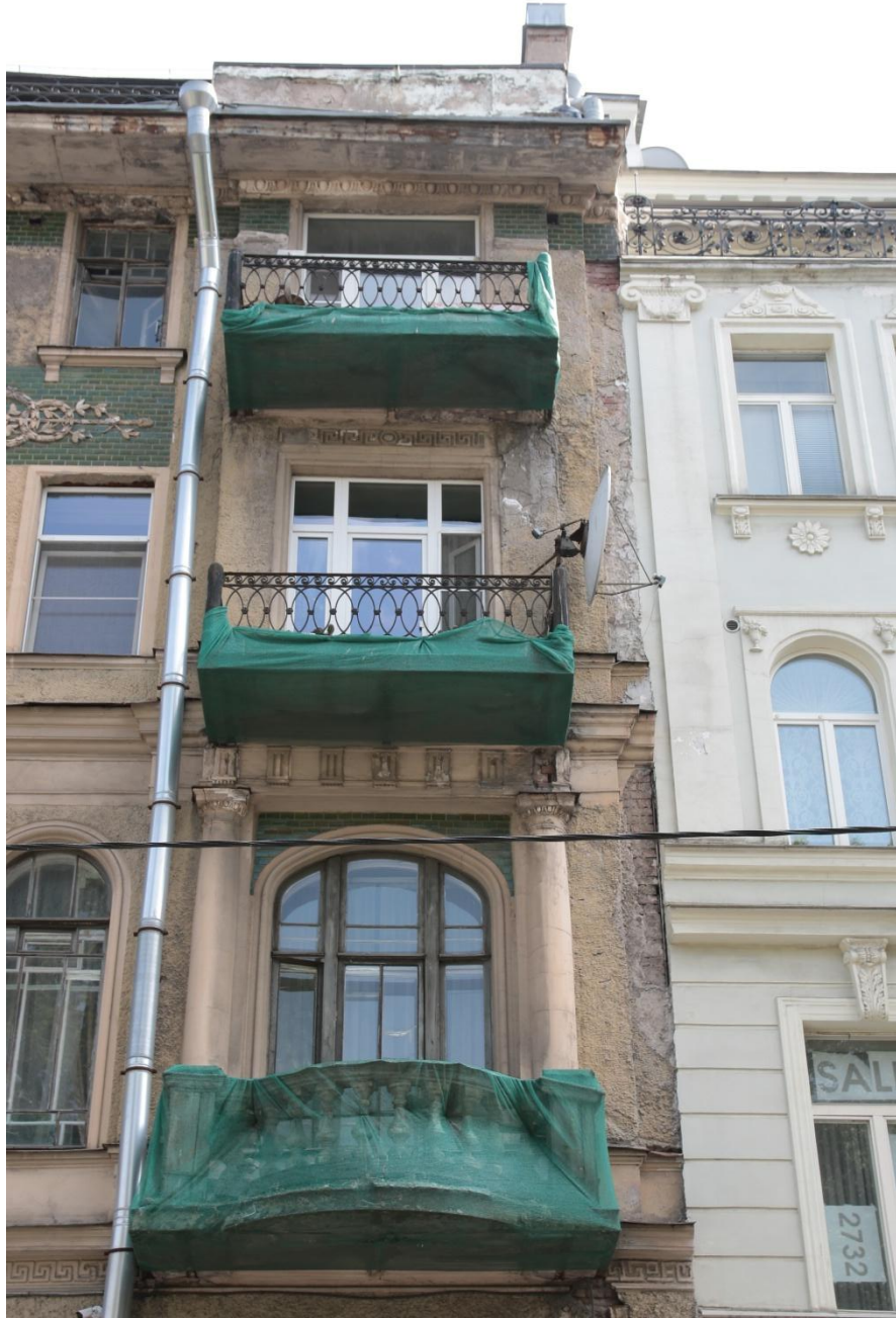
8. Фрагмент главного фасада по улице Таврическая. Оформление оконных проемов и балконов. Вид с запада
