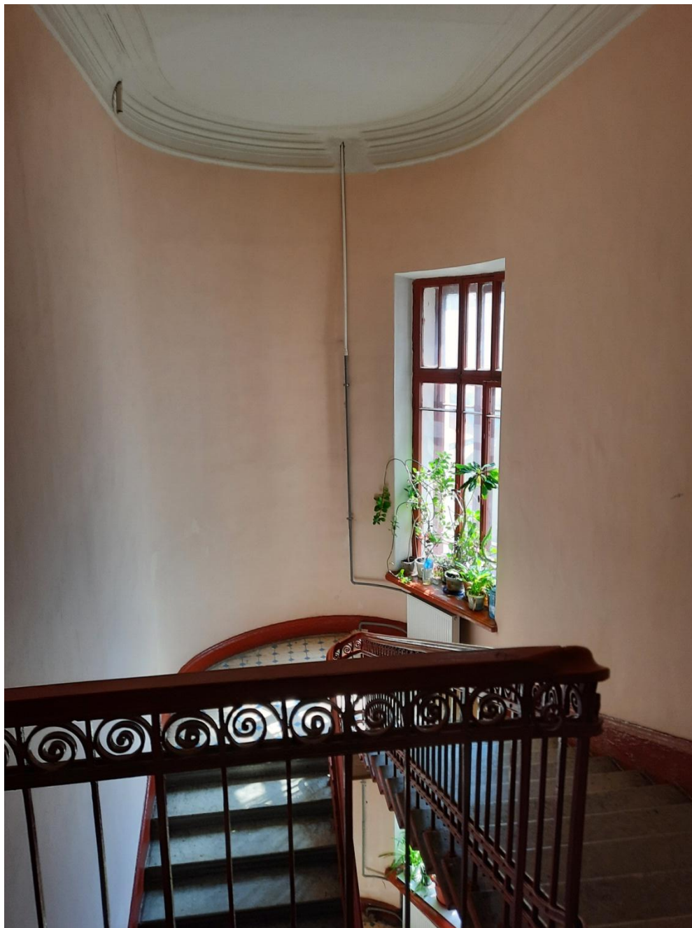
65. Интерьер дворовой парадной. Лестничная площадка пятого этажа
