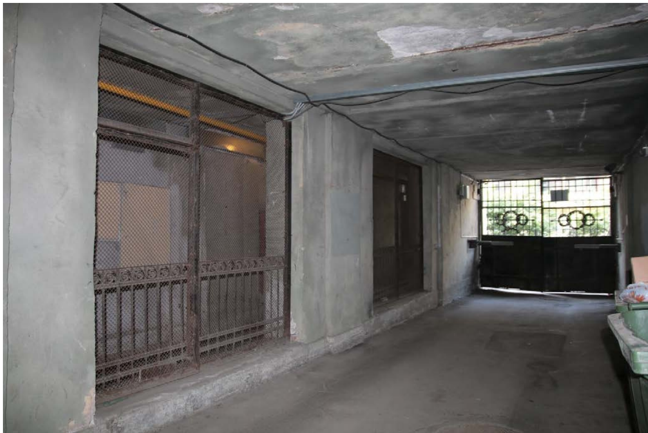
25. Проездная арка. Решетчатые перегородки между проездной аркой и аркой прохода во внутренний двор
