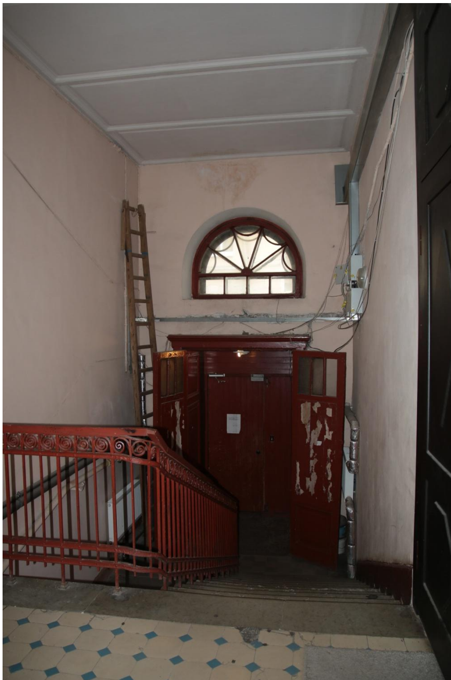
57. Интерьер вестибюля дворовой парадной. Двери тамбура входа
