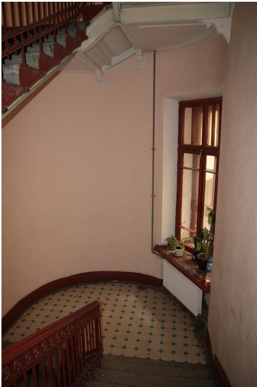
63. Интерьер дворовой парадной. Окно межэтажной лестничной площадки
