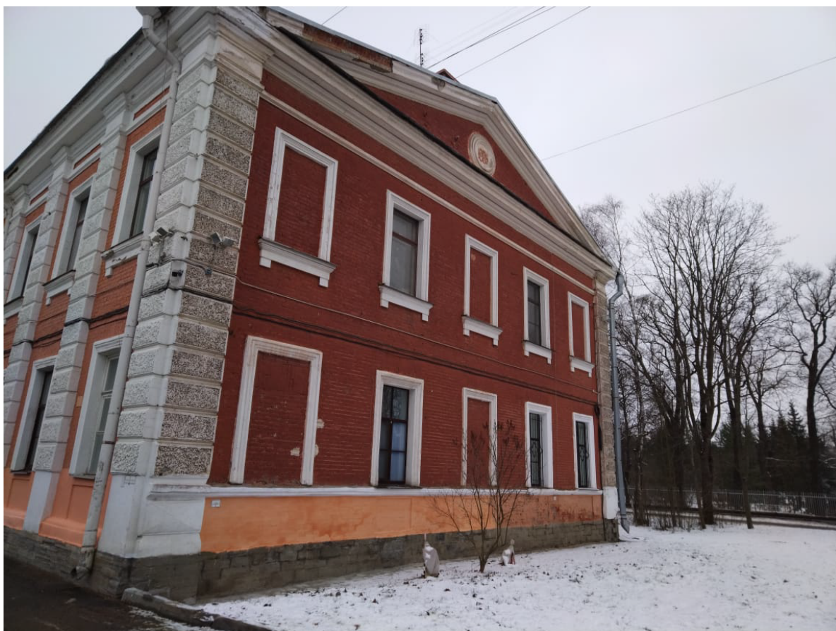
Фото 3. Общий вид здания «Казарма 2-го эскадрона» со стороны Парковой улицы.
