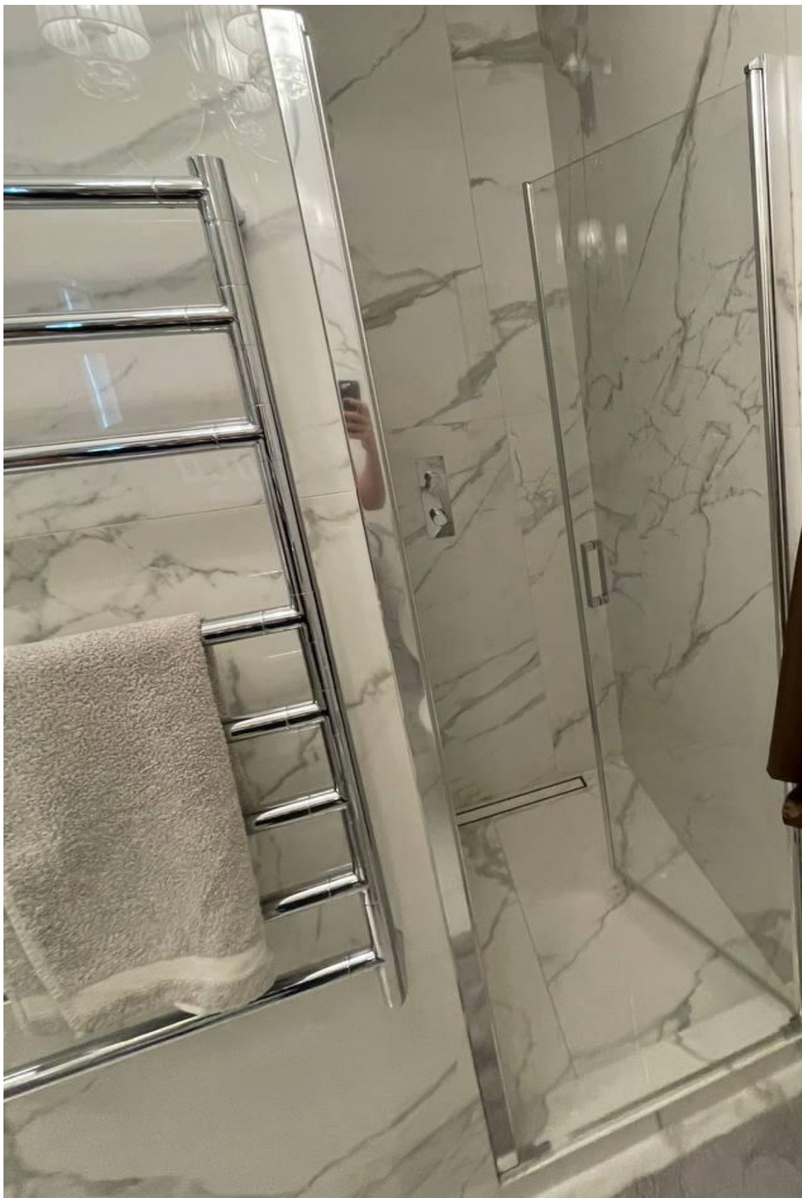
Фото 11. Санузел при гостевой комнате.
