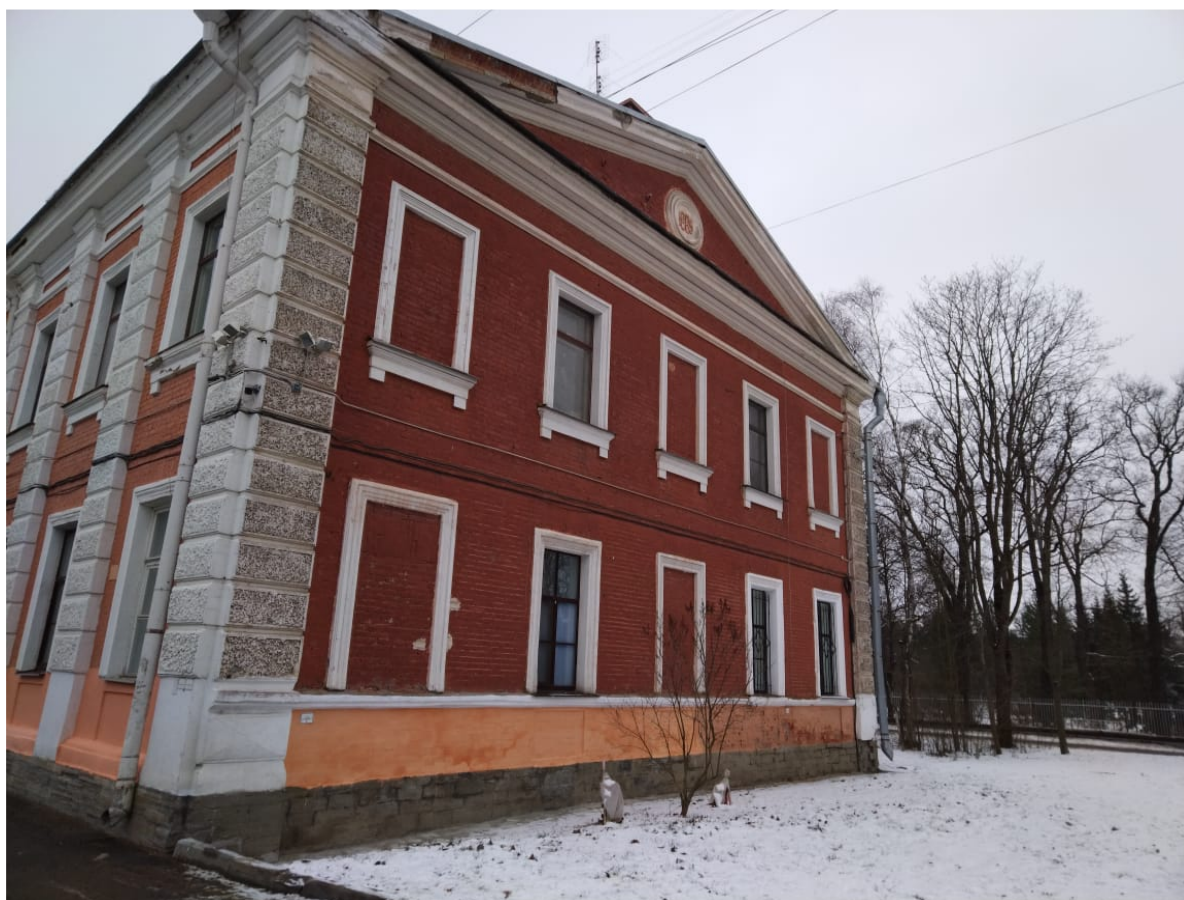
Фото 2. Общий вид здания «Казарма 2-го эскадрона» со стороны двора.
