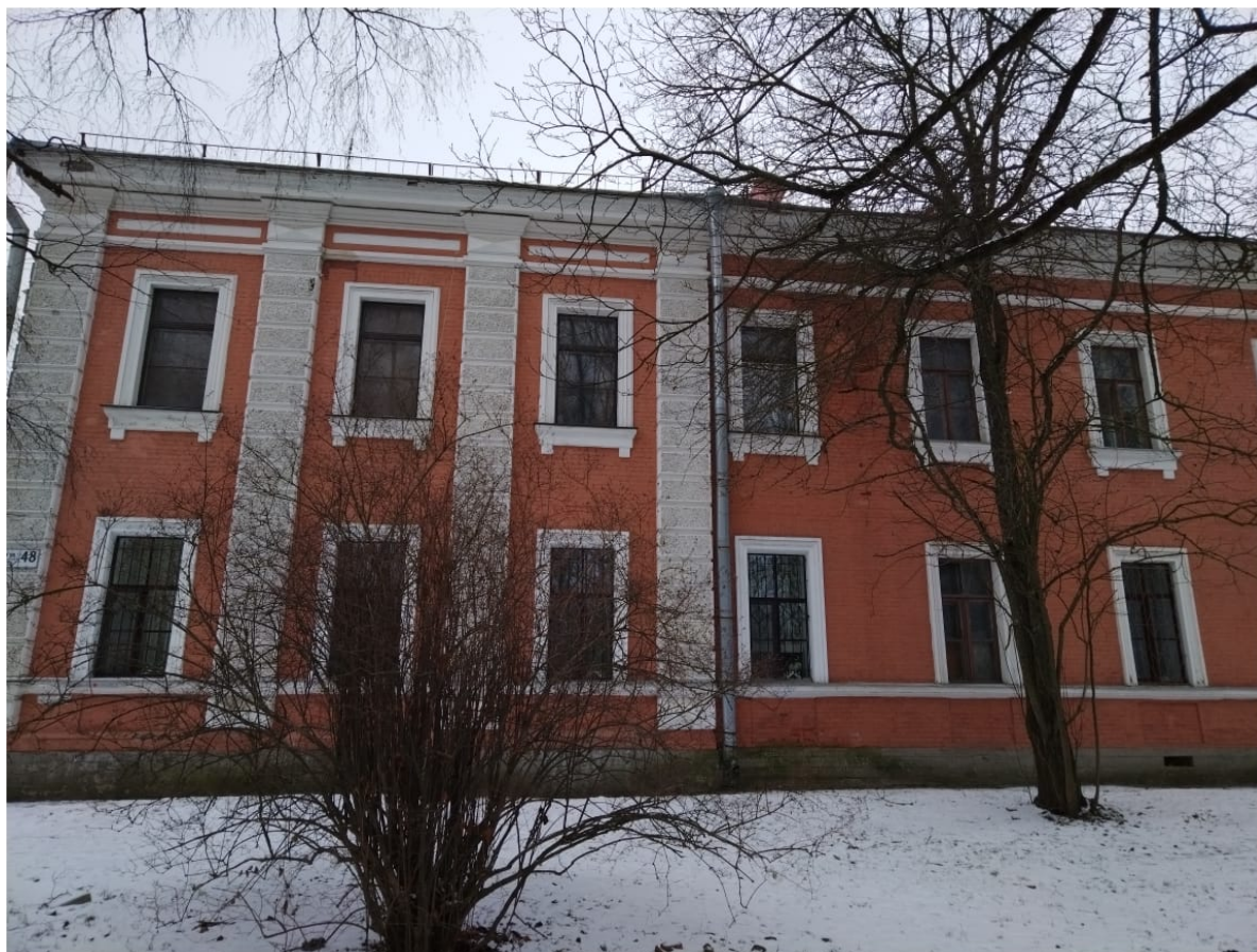
Фото 4. Лицевой фасад здания «Казарма 2-го эскадрона» по Парковой улице.
