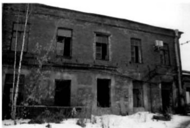
3. (Фрагмент южного фасада)
