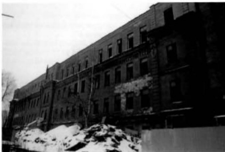
3. (Фрагмент восточного фасада)
