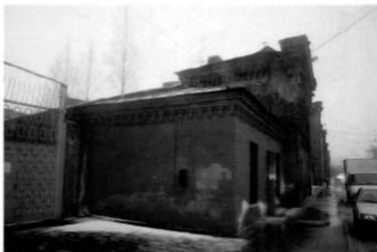
2. (Фрагмент северного фасада)
