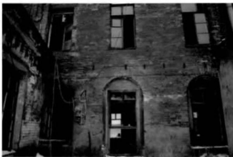
4. (Фрагмент южного фасада)
