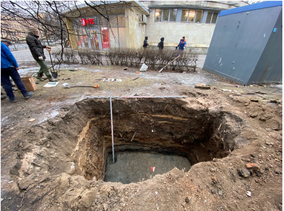
Рис. 30 Санкт-Петербург. Адмиралтейский район. Участок обследования около ст. метро «Фрунзенская». Шурф №1. Общий вид на этапе зачистки поверхности материка. Вид на юг.
