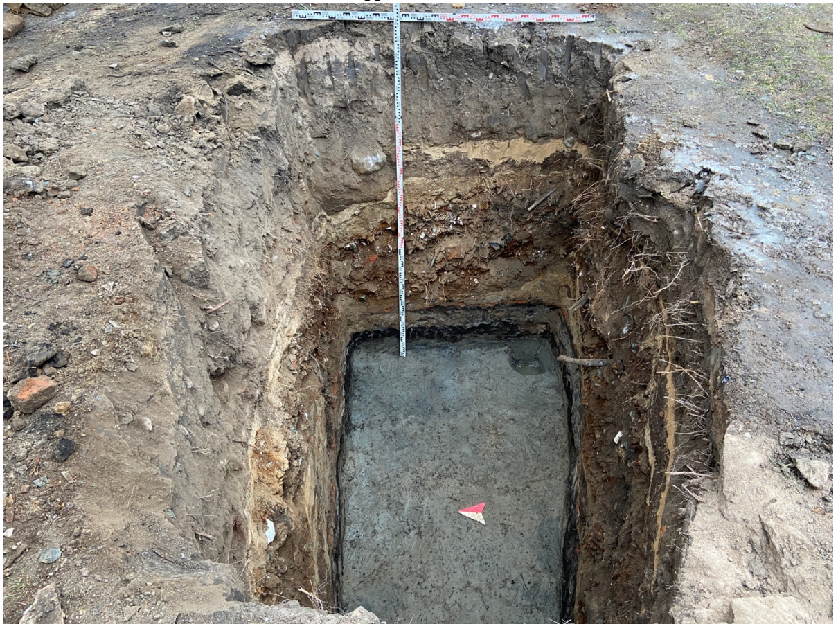
Рис. 34 Санкт-Петербург. Адмиралтейский район. Участок обследования около ст. метро «Фрунзенская». Шурф №1. Фиксация зачистки по материку. Вид на восток.
