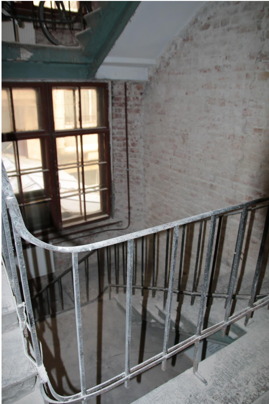
34. «Черная» лестница. Фрагмент оформления лестничного ограждения
