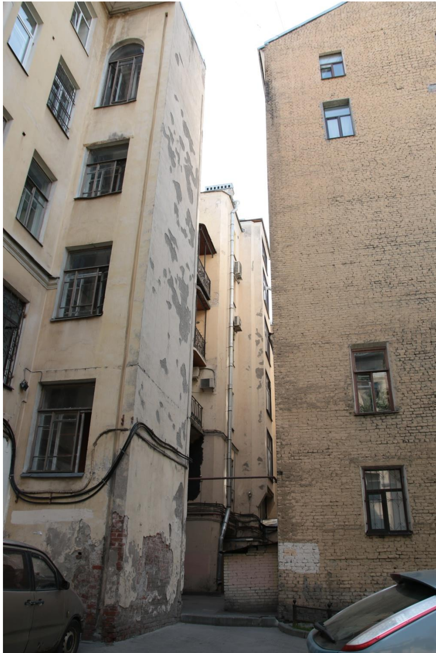
5. Фрагменты фасадов зданий литеры А и литеры Б со стороны внутреннего двора. Вид с северо-востока
