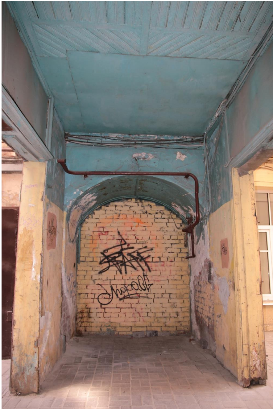
9. Фрагмент фасада внутреннего двора здания. Сторона арки, соединяющей литеру А и литеру Б, примыкающая к стене фасада литеры А. Вид с северо-запада
