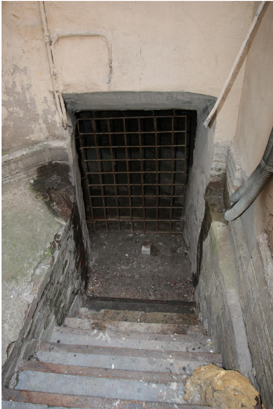
11. Вход в подвал
