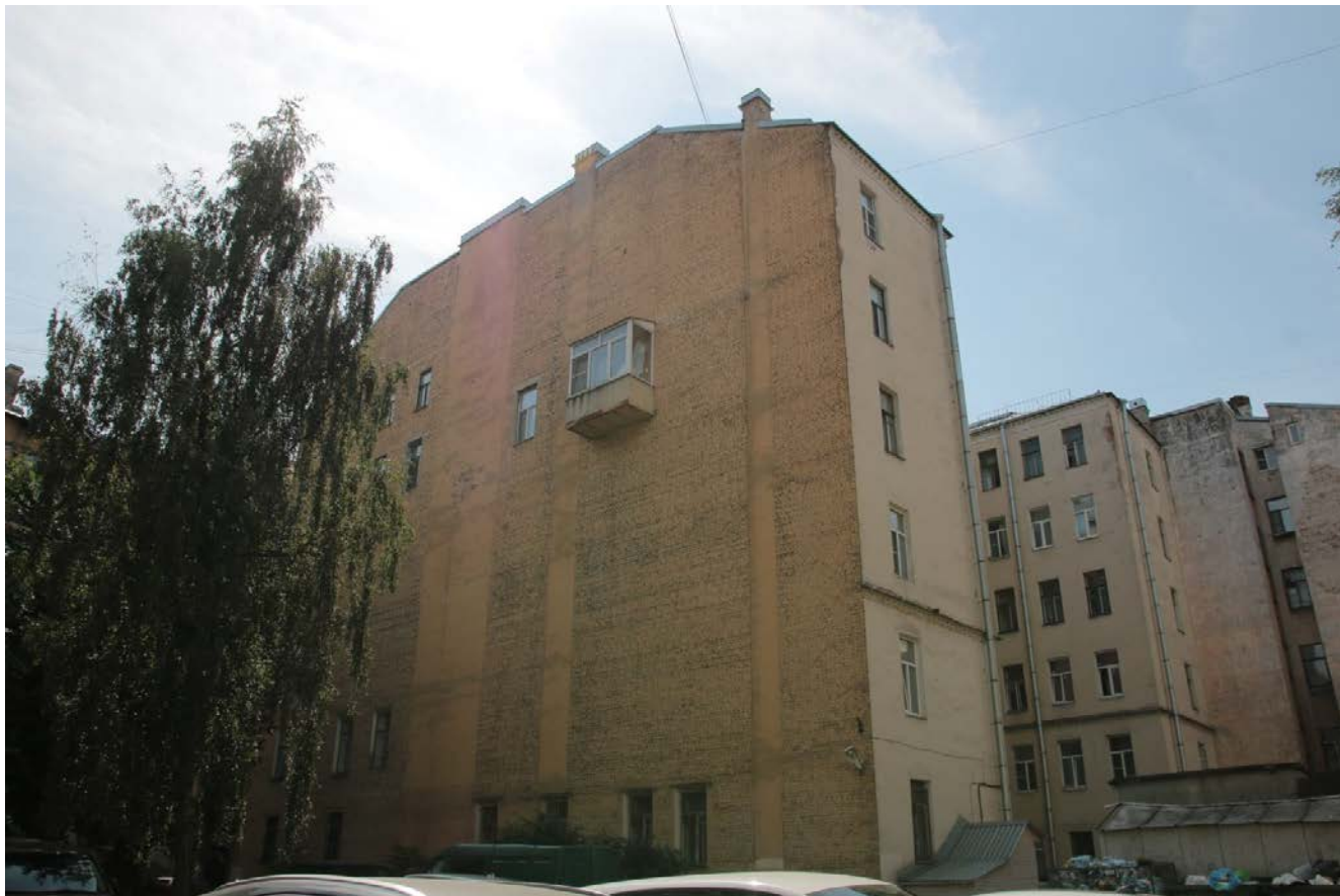
4. Фасад здания со стороны внутреннего двора. Вид с севера
