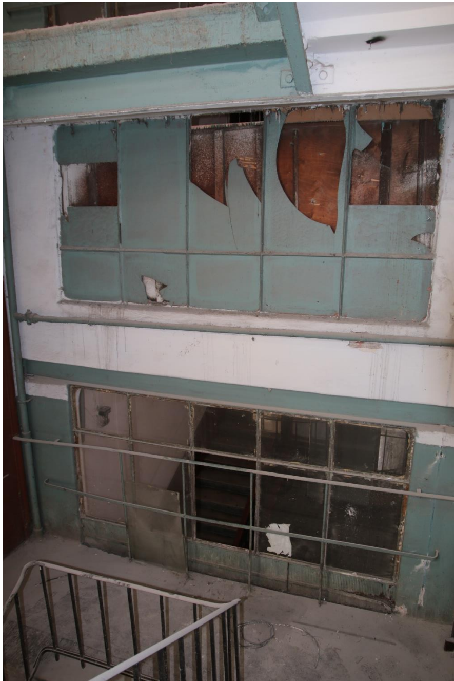
37. Перегородка между парадной и «черной» лестницами
