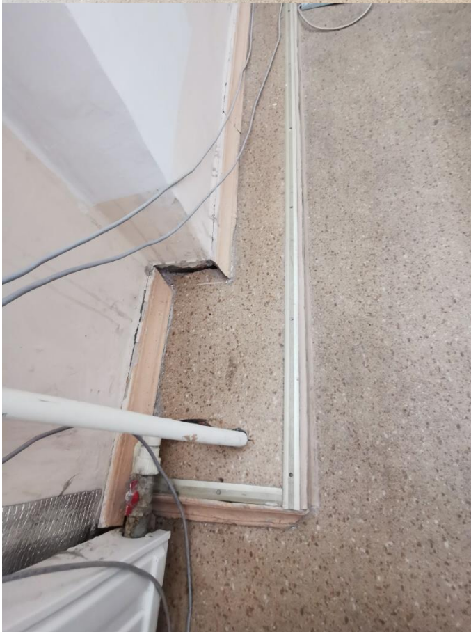
Фото 58. Объект культурного наследия федерального значения «Гостиный двор Новобиржевой», помещения входной группы. Помещение 9. Учебный класс. «Ступень» закрывающая трубы отопления. 20 января 2023г
