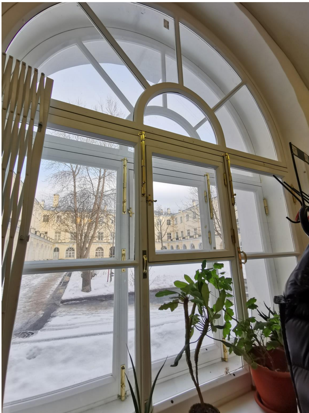
Фото 43. Объект культурного наследия федерального значения «Гостиный двор Новобиржевой», помещения входной группы. Помещение 8. Гардероб. Окно. 20 января 2023г
