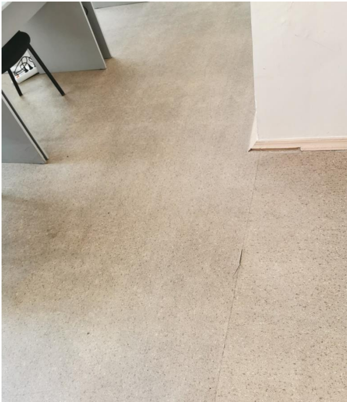
Фото 57. Объект культурного наследия федерального значения «Гостиный двор Новобиржевой», помещения входной группы. Помещение 9. Учебный класс. Покрытие пола – линолеум. 20 января 2023г
