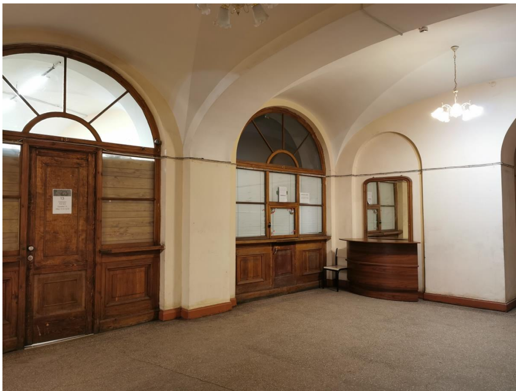
Фото 11. Объект культурного наследия федерального значения «Гостинный двор Новобиржевой», помещения входной группы. Помещение 2а. Вестибюль. Вид на арочные проёмы. 20 января 2023г
