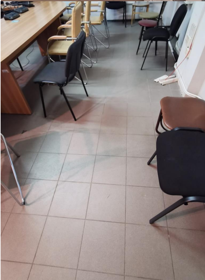
Фото 69. Объект культурного наследия федерального значения «Гостиный двор Новобиржевой», помещения входной группы. Помещение 3. Конференц-зал. Покрытие пола – керамогранит. 20 января 2023г
