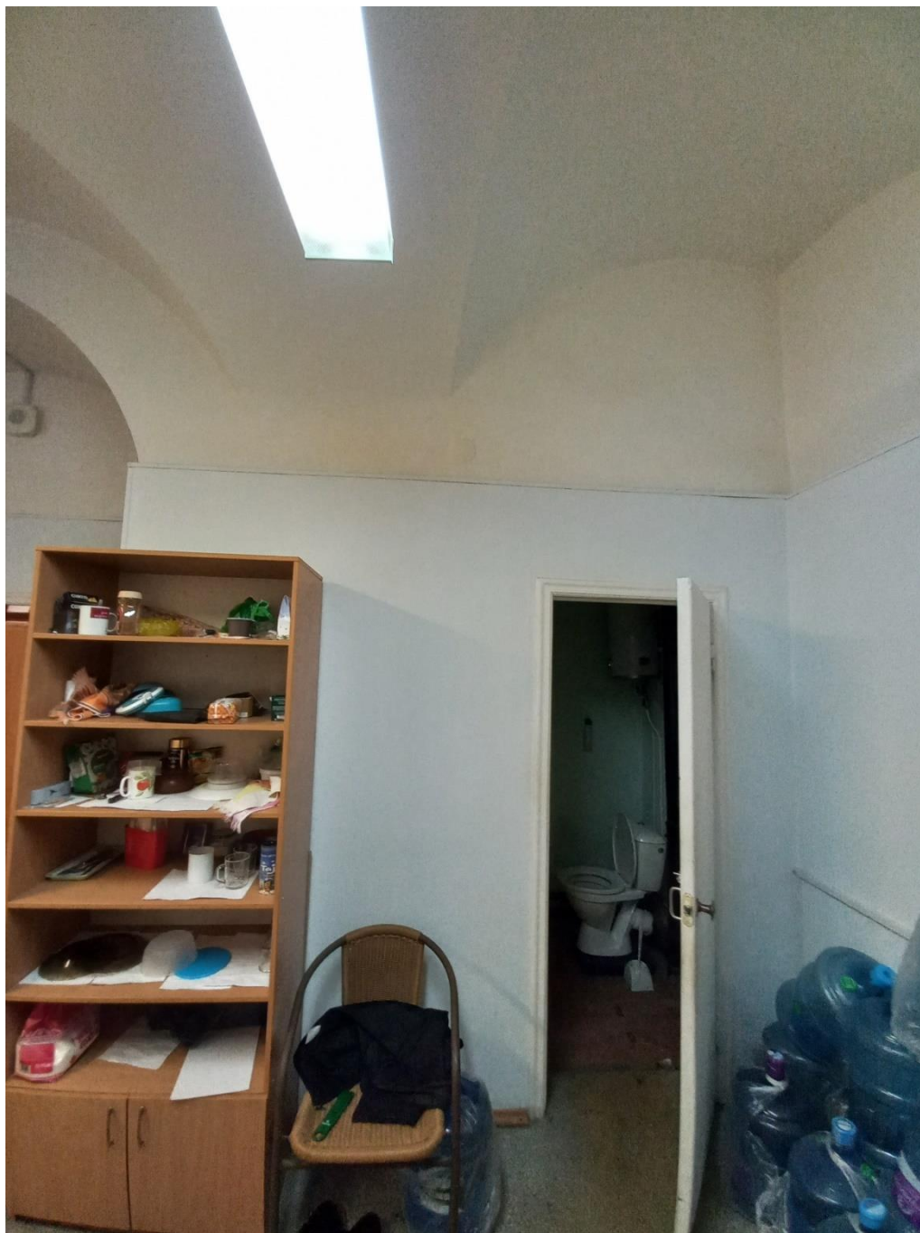
Фото 30. Объект культурного наследия федерального значения «Гостиный двор Новобиржевой», помещения входной группы. Помещение 6. Дверь в помещение с/у. .20 января 2023г
