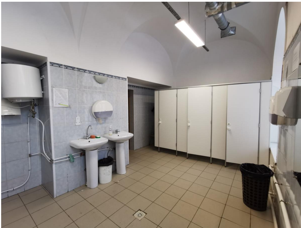
Фото 59. Объект культурного наследия федерального значения «Гостиный двор Новобиржевой», помещения входной группы. Помещение 10. Сан. узел. Общий вид. 20 января 2023г
