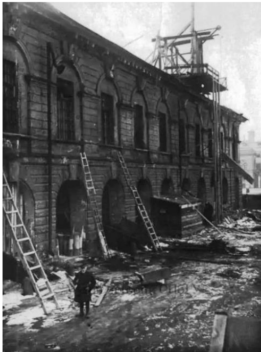
10. 1935. Реконструкция (надстройка третьего этажа) исторического факультета ЛГУ им. А.С.Бубнова. Вид со стороны Тифлисской улицы. Источник: Архивный фонд Музея истории СПбГУ https://history.spbu.ru/institut/istoriya-fakulteta/fotoletopis-istoricheskogo-fakulteta/671-1930-1940-e-gody.html https://pastvu.com/p/1217285
