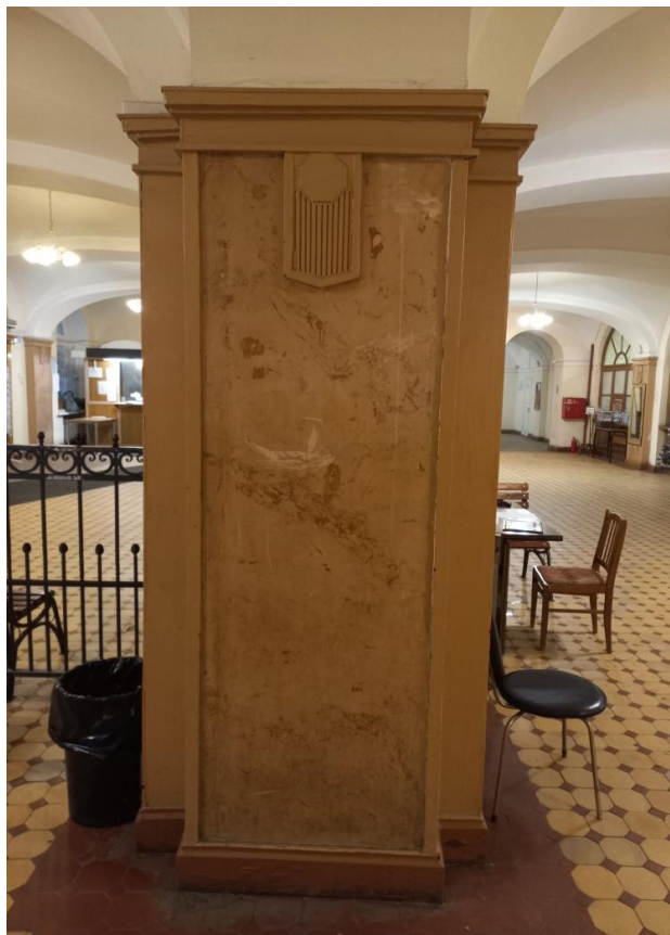
Фото 10. Объект культурного наследия федерального значения «Гостиный двор Новобиржевой», помещения входной группы. Помещение 2. Вестибюль. Пилон. 20 января 2023г
