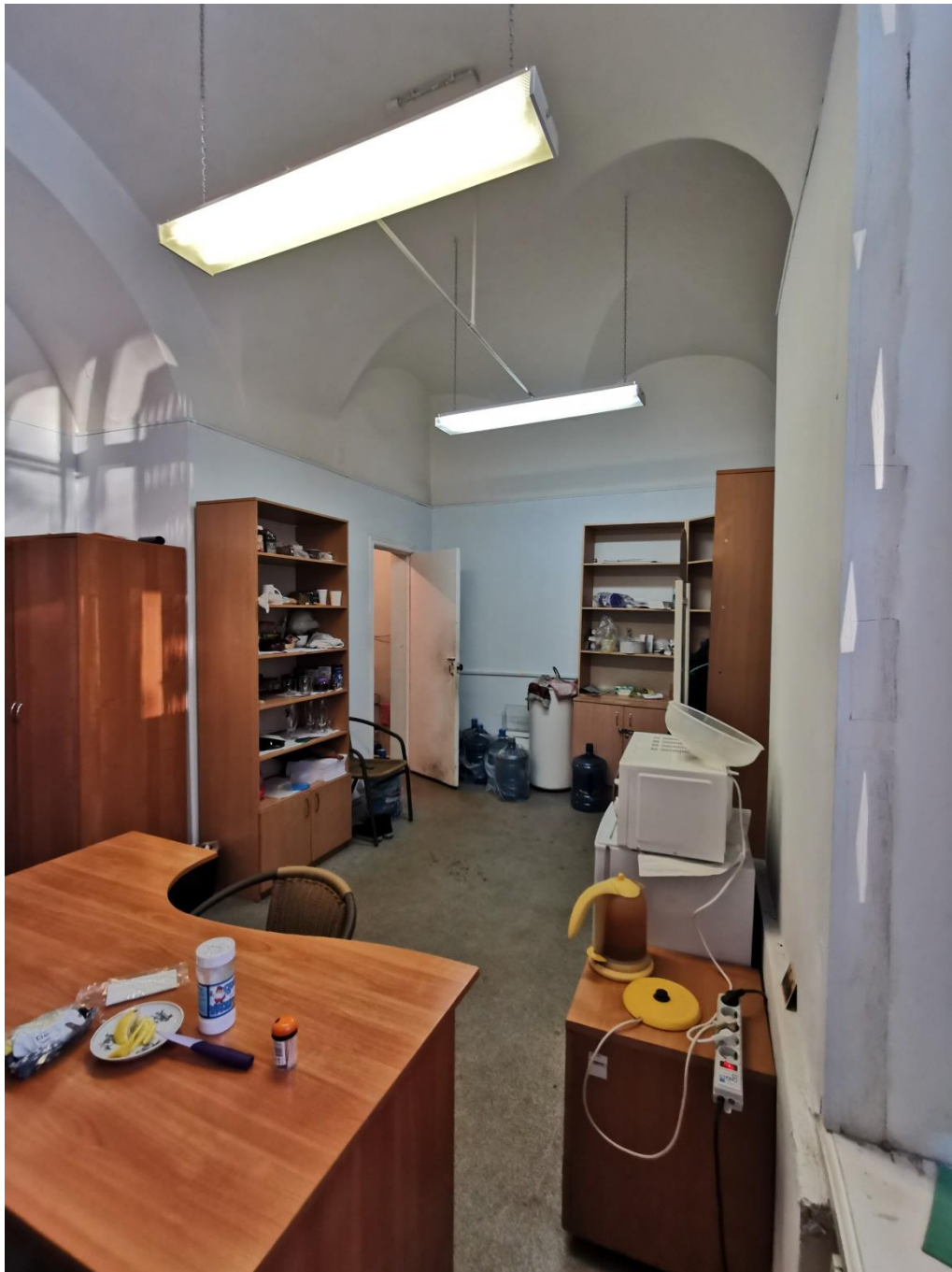
Фото 29. Объект культурного наследия федерального значения «Гостиный двор Новобиржевой», помещения входной группы. Помещение 6. Общий вид. .20 января 2023г
