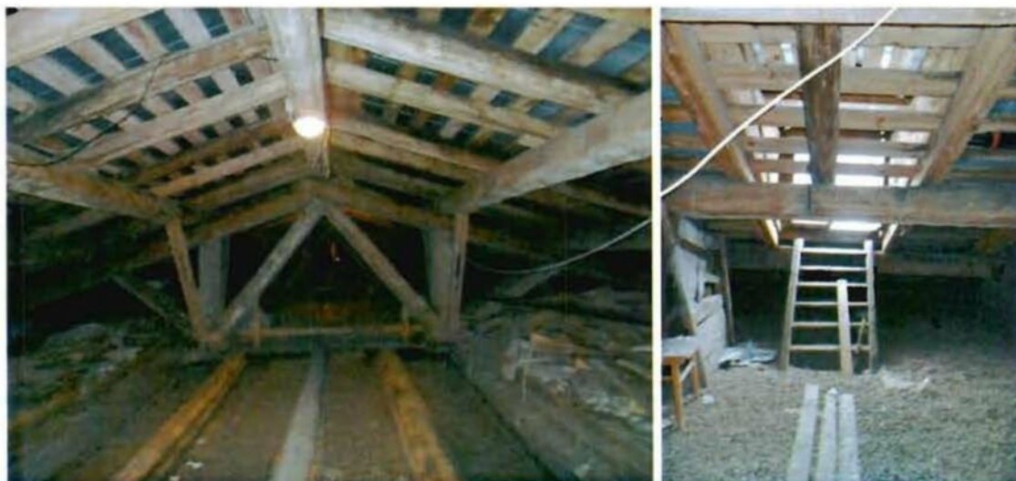
23, 24. Стропильная система здания
