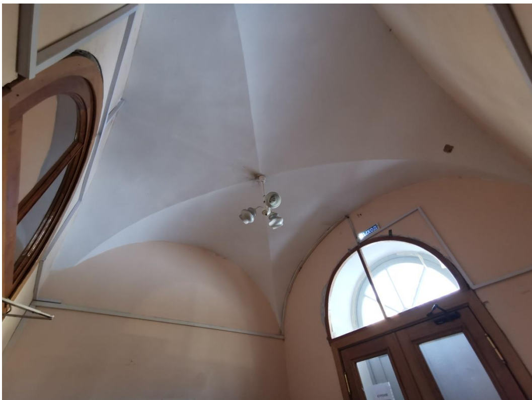
Фото 51. Объект культурного наследия федерального значения «Гостинный двор Новобиржевой», помещения входной группы. Помещение 1. Тамбур. Крестовый свод. 20 января 2023г
