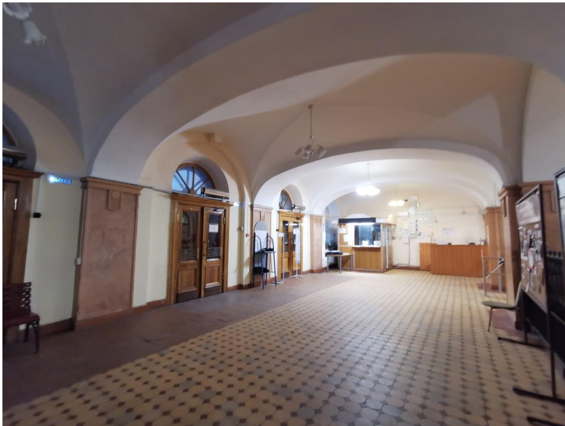
Фото 1. Объект культурного наследия федерального значения «Гостиный двор Новобиржевой», помещения входной группы. Помещение 2. Вестибюль, входная зона. Общий вид. 20 января 2023г
