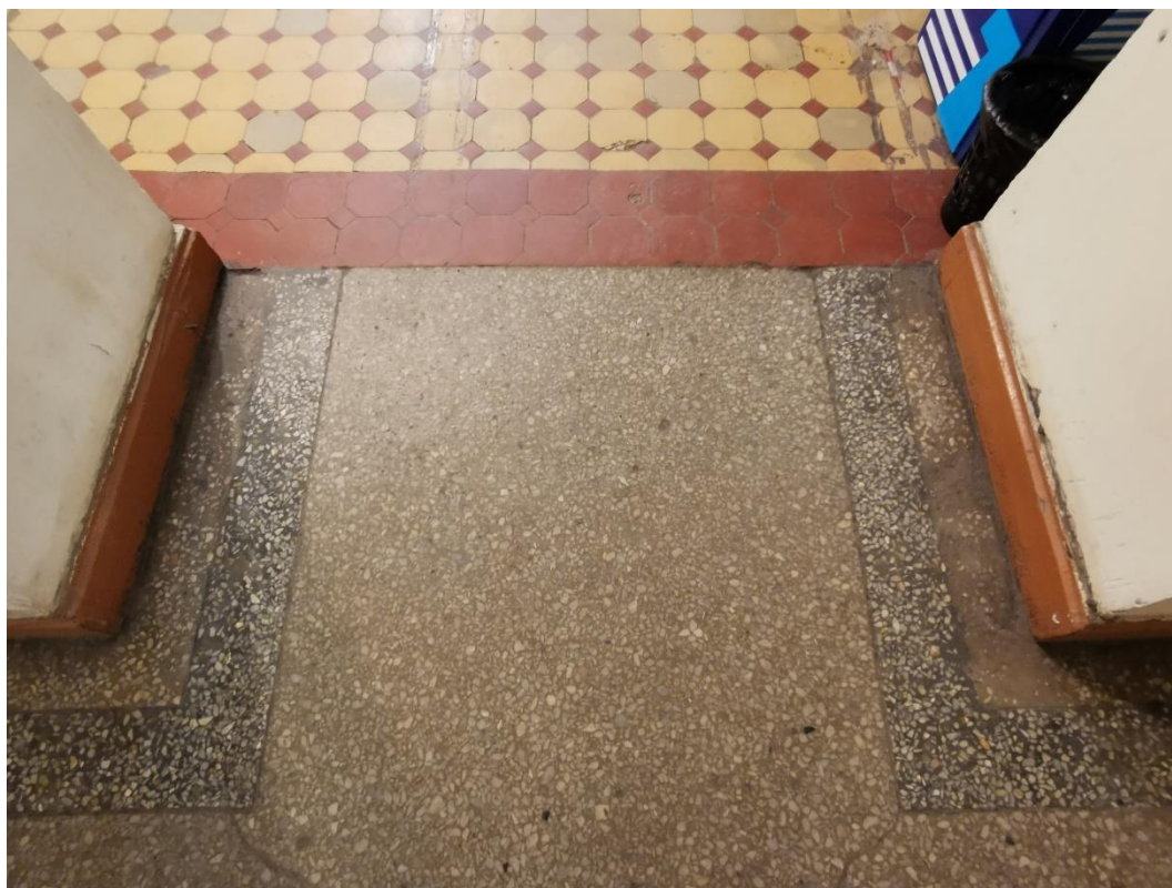
Фото 14. Объект культурного наследия федерального значения «Гостиный двор Новобиржевой», помещения входной группы. Помещение 2а. Вестибюль. Покрытие пола – тератцо, метлахская плитка. 20 января 2023г
