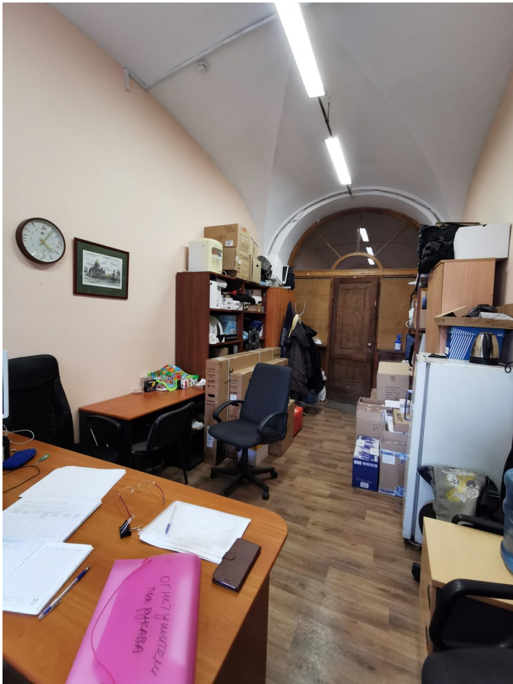
Фото 20. Объект культурного наследия федерального значения «Гостиный двор Новобиржевой», помещения входной группы. Помещение 4. Комната коменданта. Вид на дверной проём. 20 января 2023г
