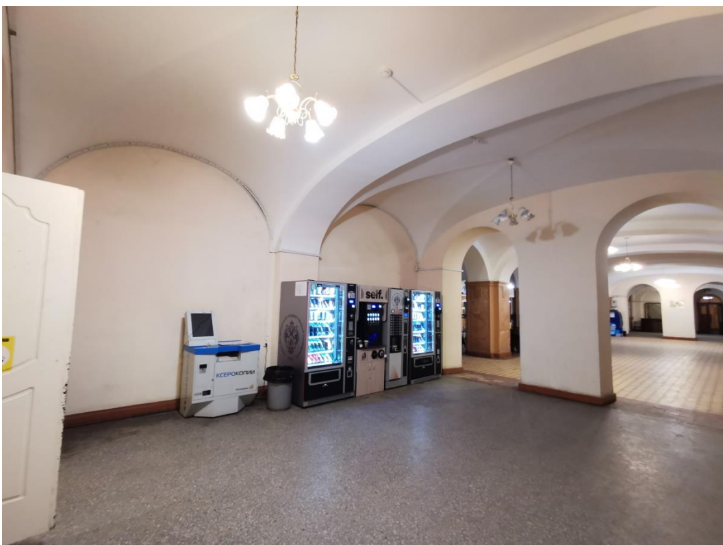
Фото 16. Объект культурного наследия федерального значения «Гостинный двор Новобиржевой», помещения входной группы. Помещение 26. Вестибюль. Вид на арочные проёмы. 20 января 2023г
