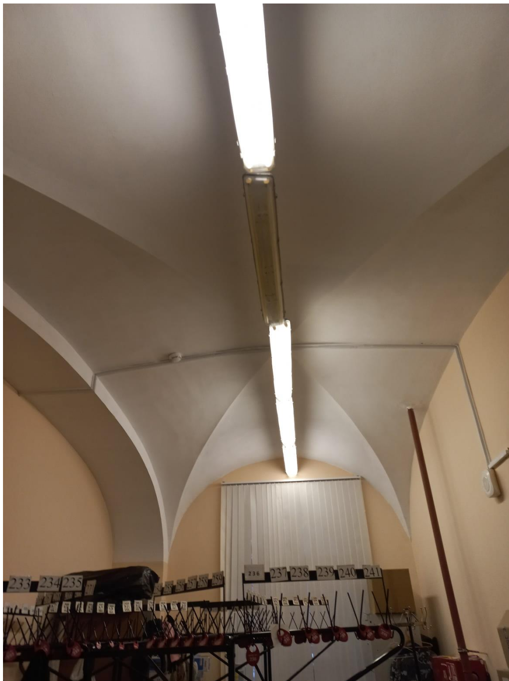
Фото 27. Объект культурного наследия федерального значения «Гостиный двор Новобиржевой», помещения входной группы. Помещение 5. Гардероб. Крестовый свод. 20 января 2023г
