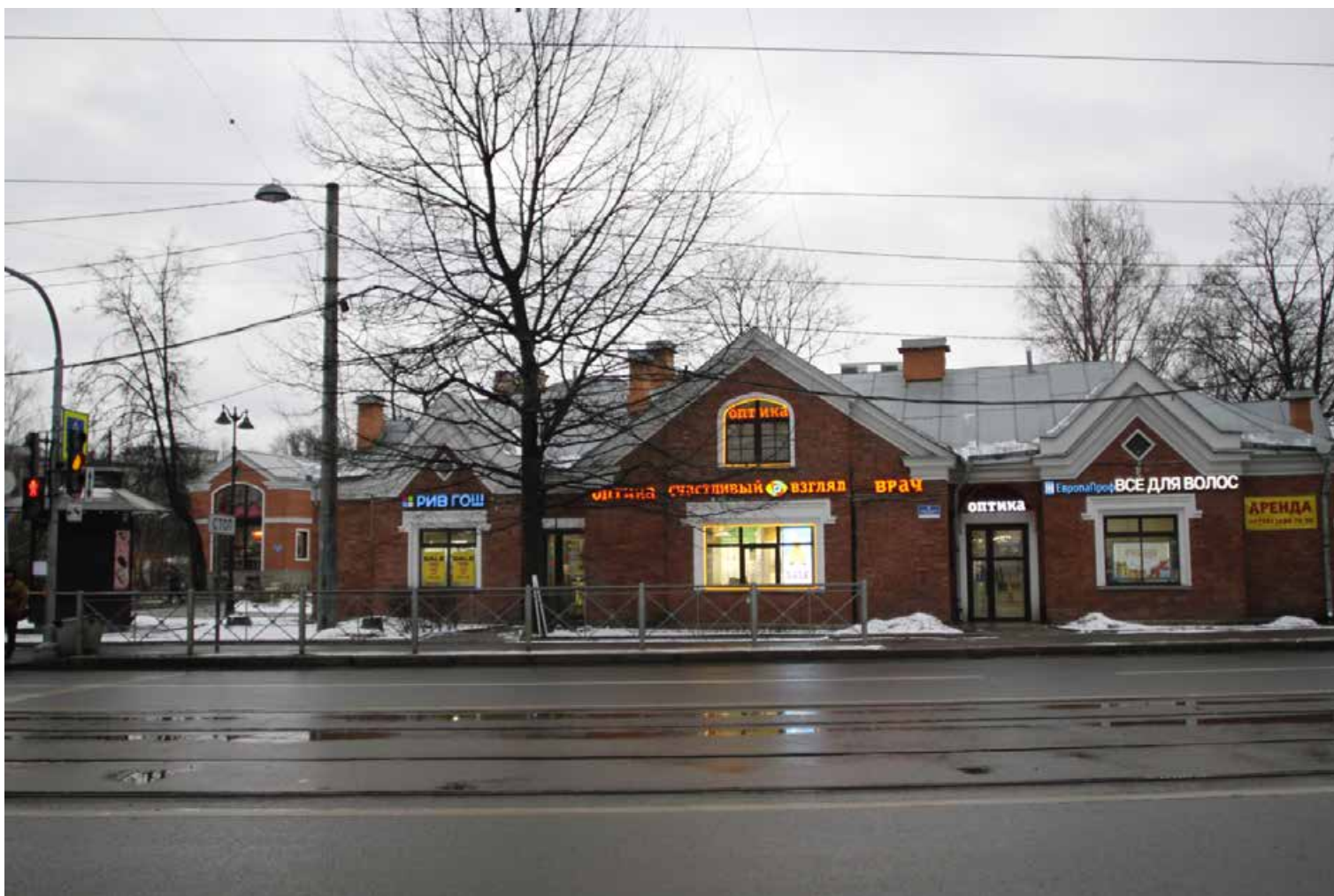
16. Вид на территорию ОКН регионального значения «Дача Салтыковых». Фото: 01.02.2023.
