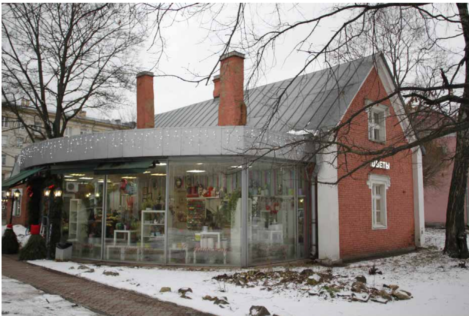
18. Вид на территорию ОКН регионального значения «Дача Салтыковых». Фото: 01.02.2023.
