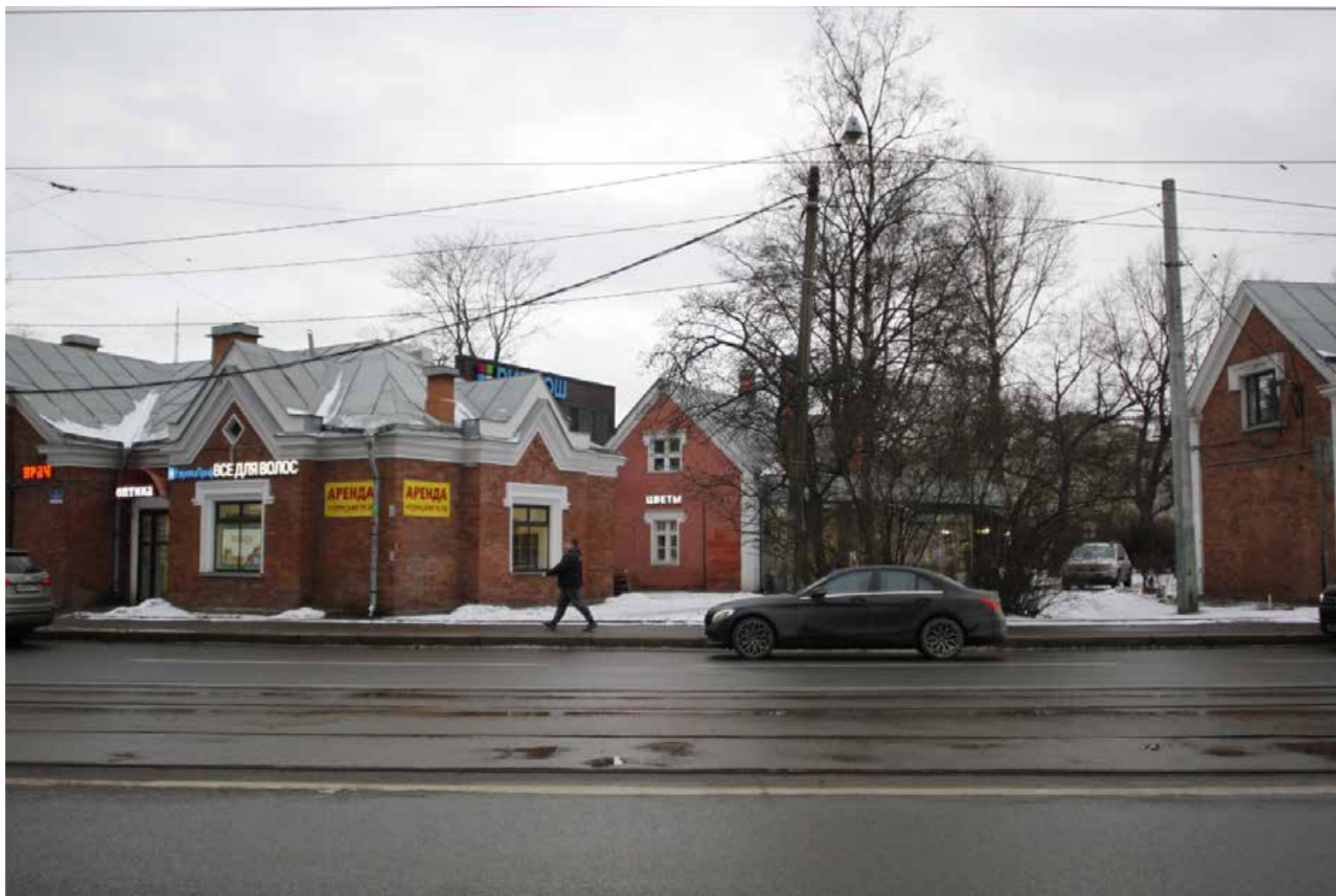
17. Вид на территорию ОКН регионального значения «Дача Салтыковых». Фото: 01.02.2023.
