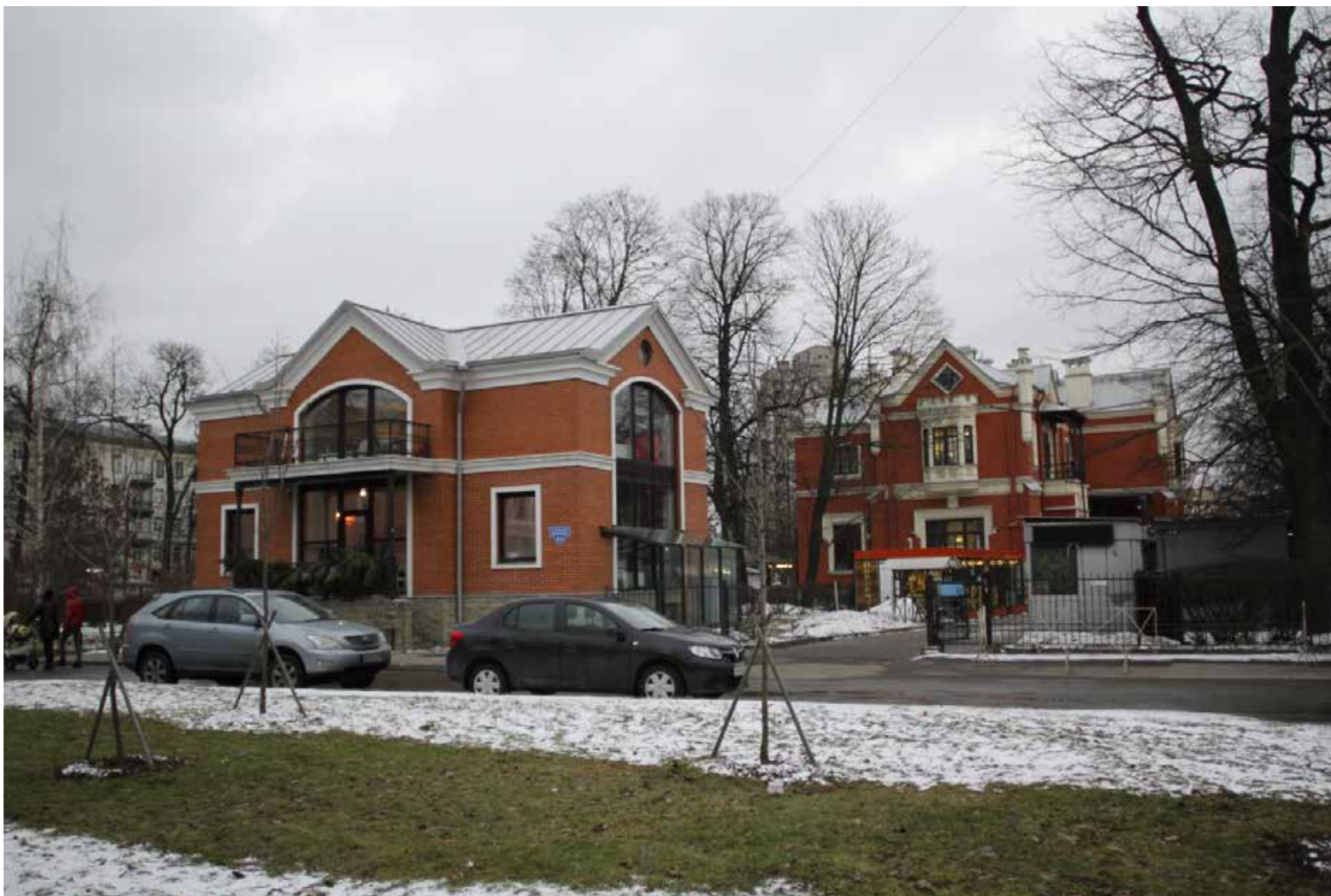
14. Вид на территорию ОКН регионального значения «Дача Салтыковых». Фото: 01.02.2023.
