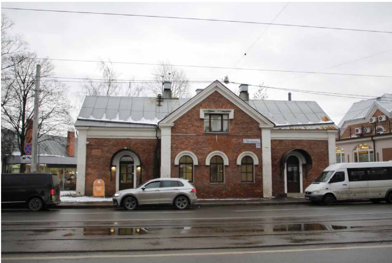
15. Вид на территорию ОКН регионального значения «Дача Салтыковых». Фото: 01.02.2023.
