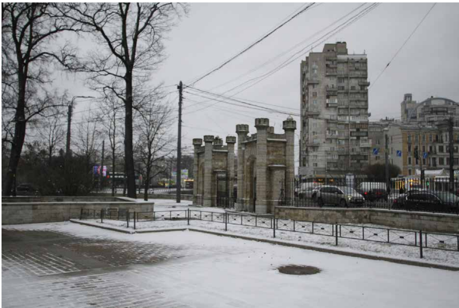
9. Вид на территорию ОКН регионального значения «Дача Салтыковых». Фото: 01.02.2023.
