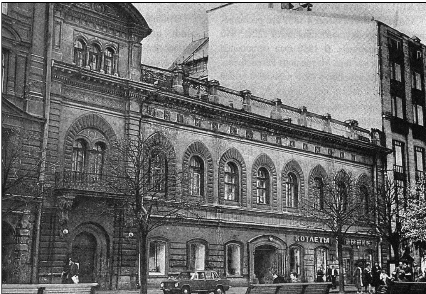
Илл. 23. Здание бывшей французской реформатской церкви апостола Павла на Большой Конюшенной улице, 25. Фотография. 1981 – 1984 гг.
