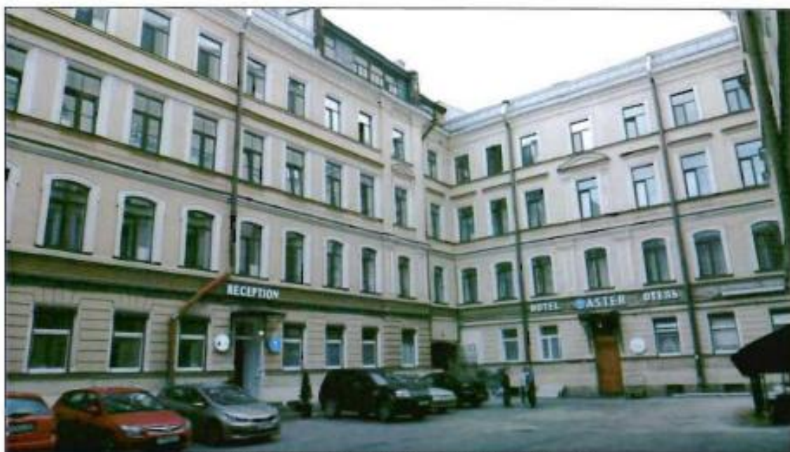
3. Дворовые фасады. Вид с северо-востока.
