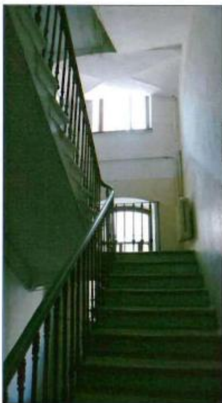
7. Лестница в южном флигеле.
