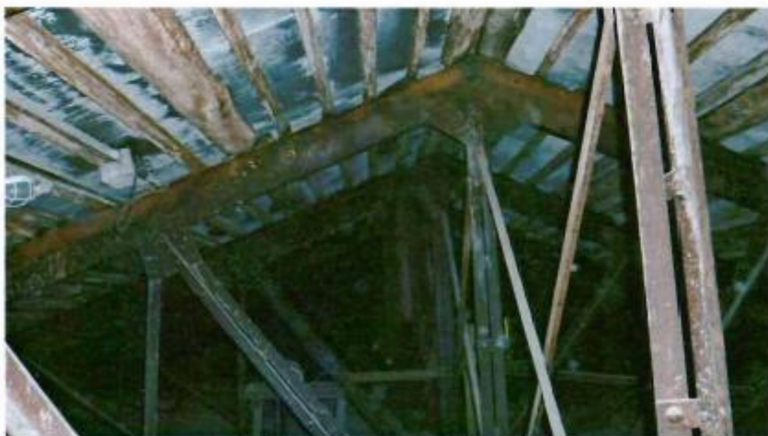
5. Стропильная система. Чердак.
