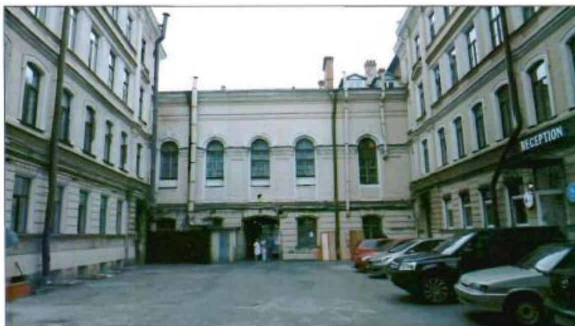
2. Дворовые фасады. Вид с запада.
