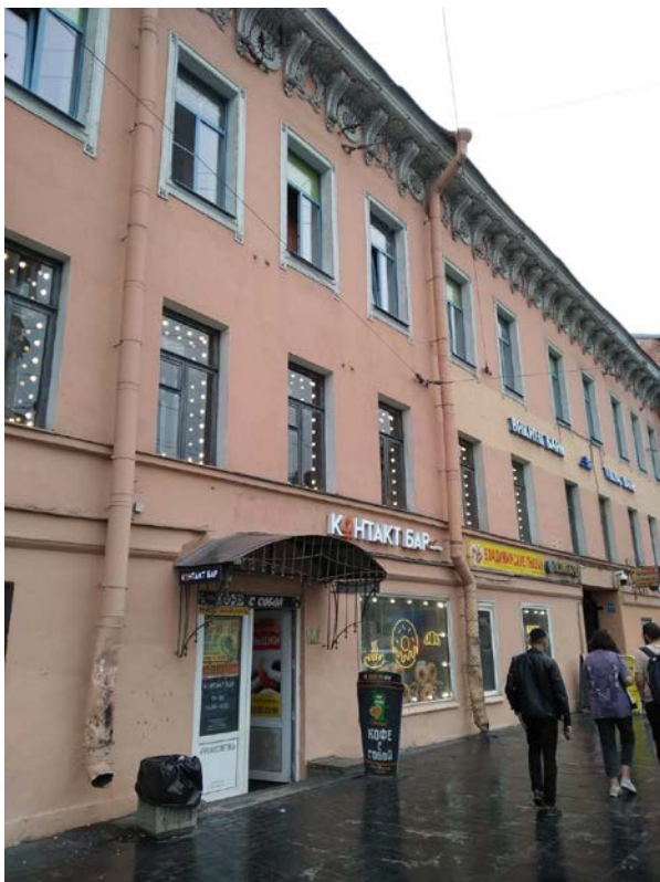
Фото 5. Фрагмент лицевого фасада объекта культурного наследия регионального значения «Дом Общества Санкт-Петербургского частного ломбарда», входное дверное заполнение пом. 1-Н
