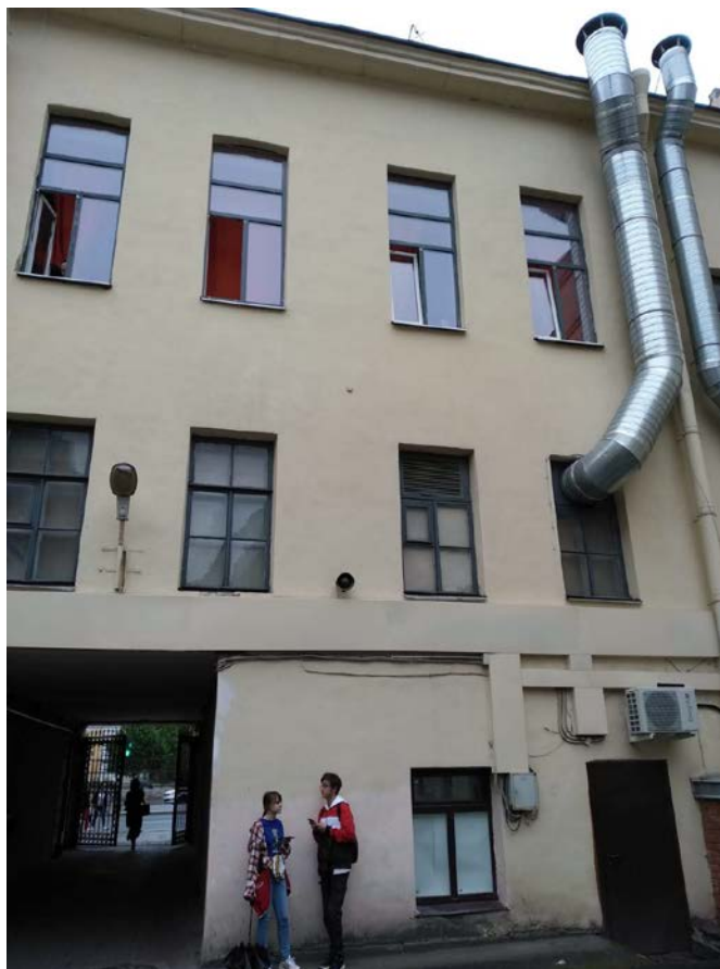
Фото 8. Фрагмент дворового фасада объекта культурного наследия регионального значения «Дом Общества Санкт-Петербургского частного ломбарда»
