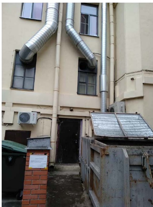
Фото 7. Фрагмент дворового фасада объекта культурного наследия регионального значения «Дом Общества Санкт-Петербургского частного ломбарда», вход пом. 1-Н
