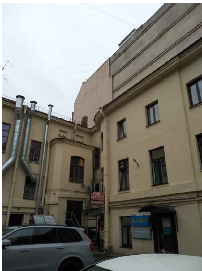
Фото 9. Фрагмент дворового фасада объекта культурного наследия регионального значения «Дом Общества Санкт-Петербургского частного ломбарда»
