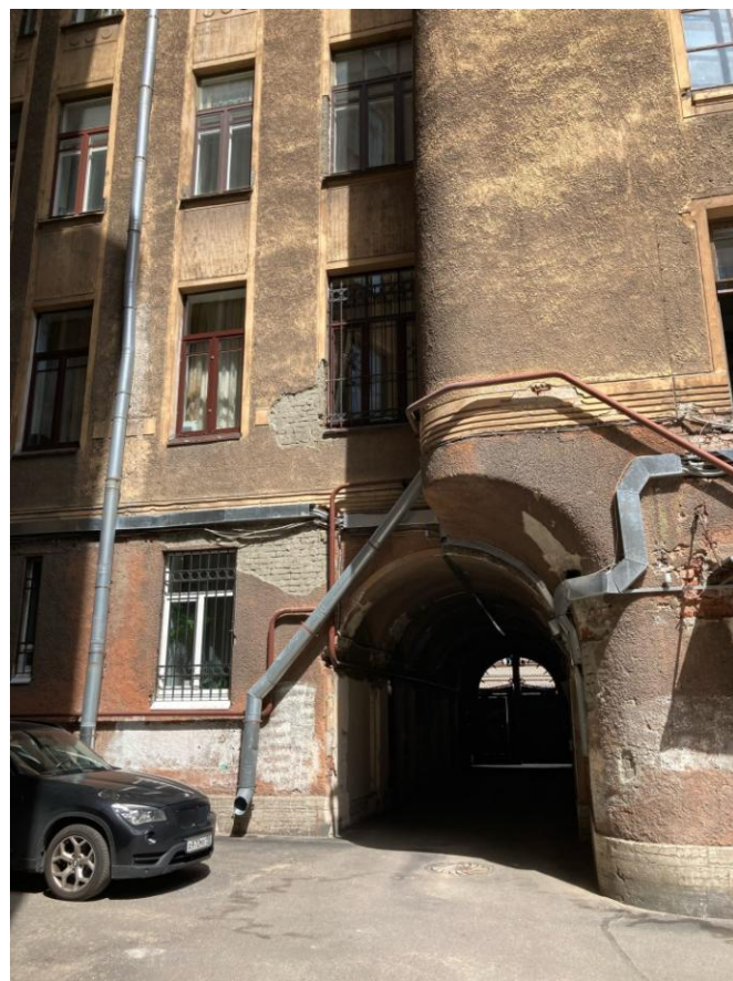
Фото 8. Фрагмент дворового фасада объекта культурного наследия регионального значения «Дом Л.Л. Кенига»
