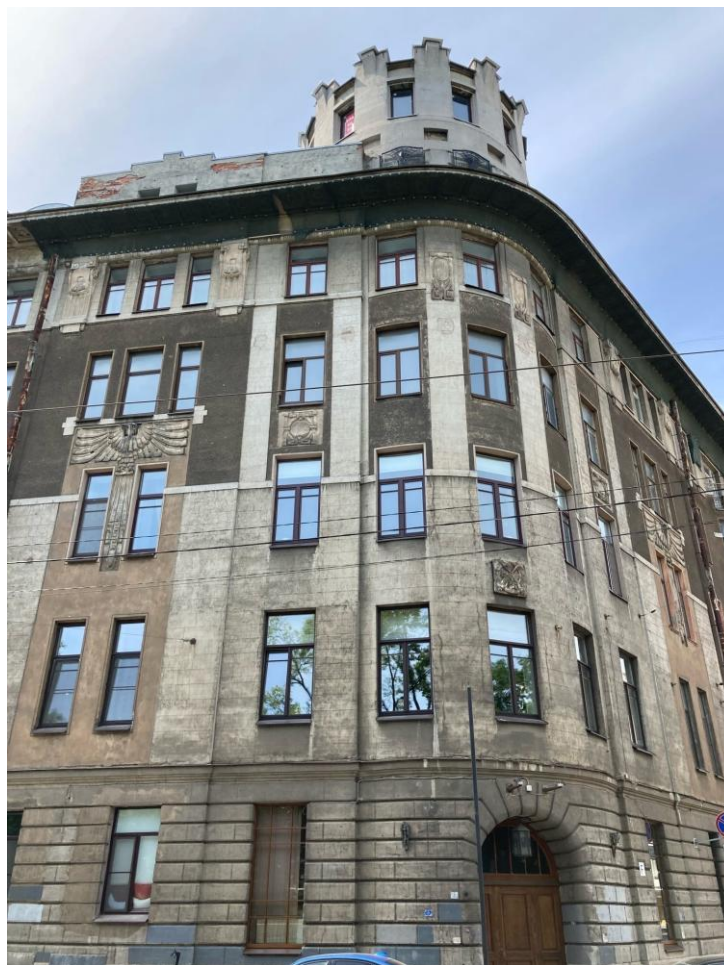
Фото 3. Фрагмент лицевого фасада объекта культурного наследия регионального значения «Дом Л.Л. Кенига»
