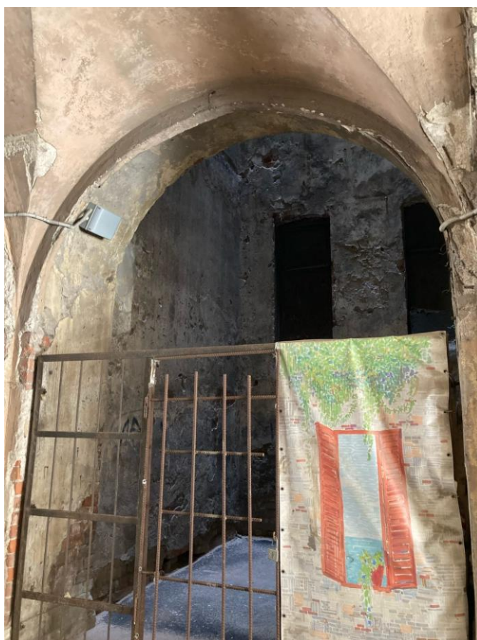
Фото 6. Фрагмент дворового фасада объекта культурного наследия регионального значения «Дом Л.Л. Кенига»
