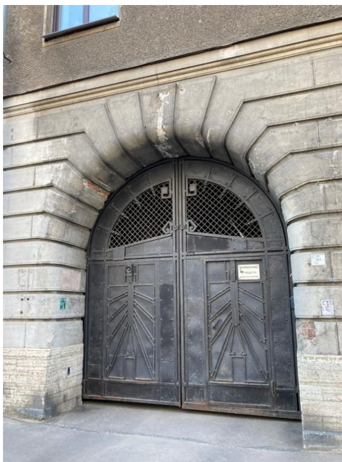
Фото 2. Фрагмент лицевого фасада объекта культурного наследия регионального значения «Дом Л.Л. Кенига»
