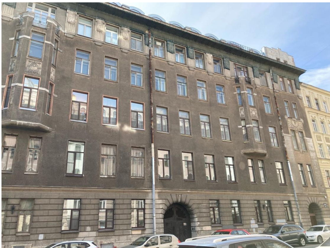
Фото 1. Фрагмент лицевого фасада объекта культурного наследия регионального значения «Дом Л.Л. Кенига»
