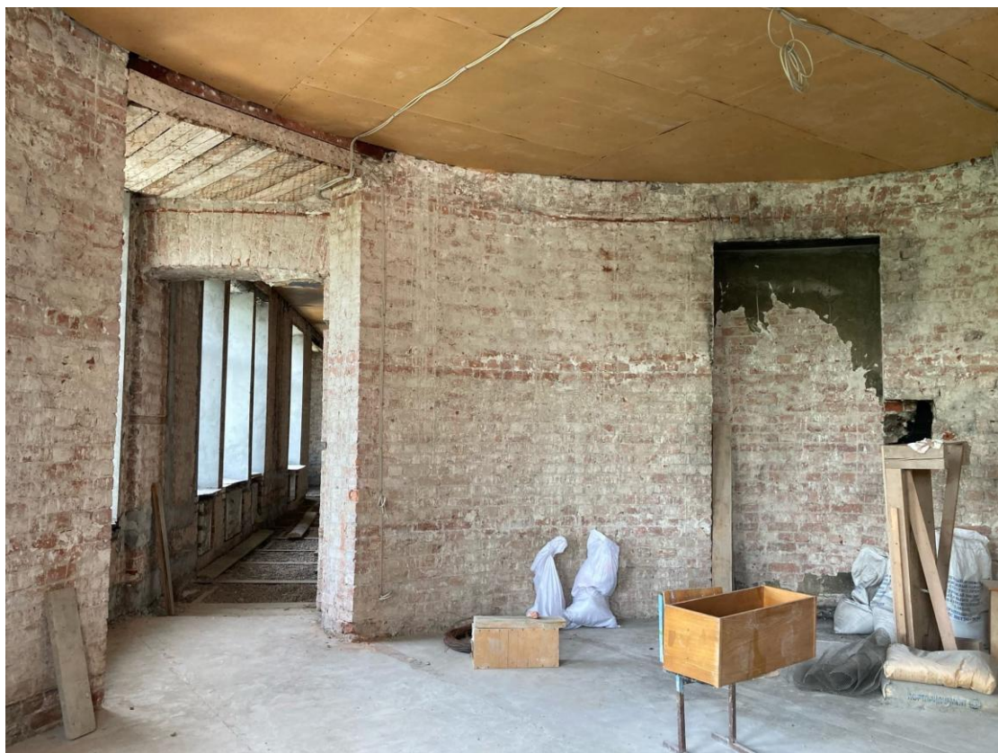
Фото 25. Интерьер квартиры №18 объекта культурного наследия регионального значения «Дом Л.Л. Кенига»
