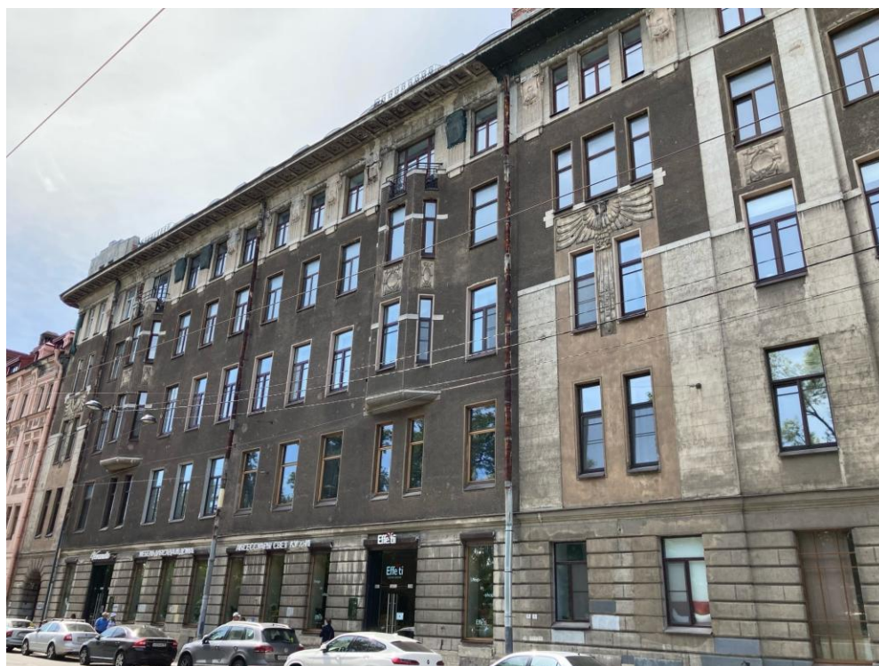
Фото 4. Фрагмент лицевого фасада объекта культурного наследия регионального значения «Дом Л.Л. Кенига»
