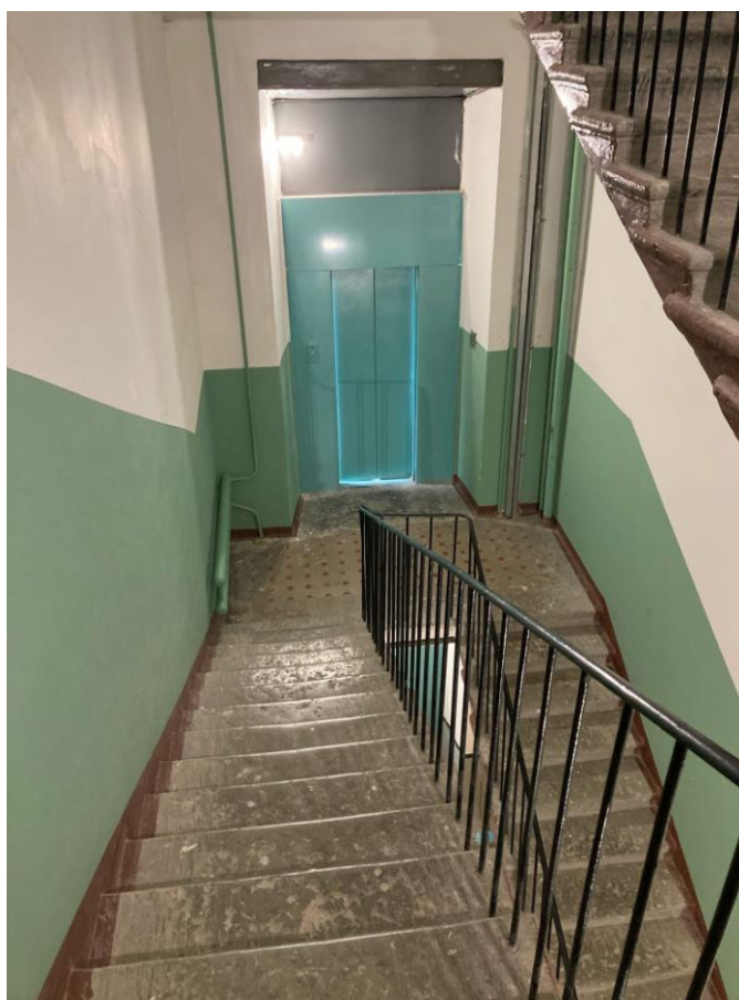
Фото 34. Фрагмент интерьера объекта культурного наследия регионального значения «Дом Л.Л. Кенига», лестничная клетка 4 этажа
