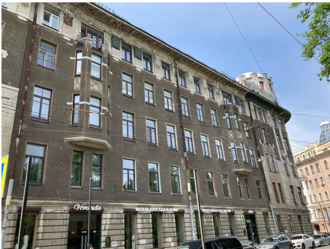
Фото 5. Фрагмент лицевого фасада объекта культурного наследия регионального значения «Дом Л.Л. Кенига»
