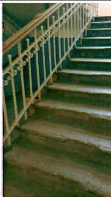
Фото 57. Лестница в центральной части здания. Фрагмент.
