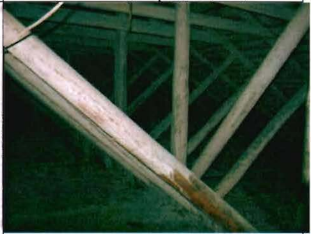
Фото 88. Конструкции крыши. Общий вид.
