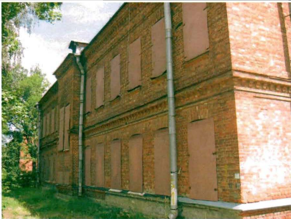
Фото 119. Западный фасад. Общий вид.
