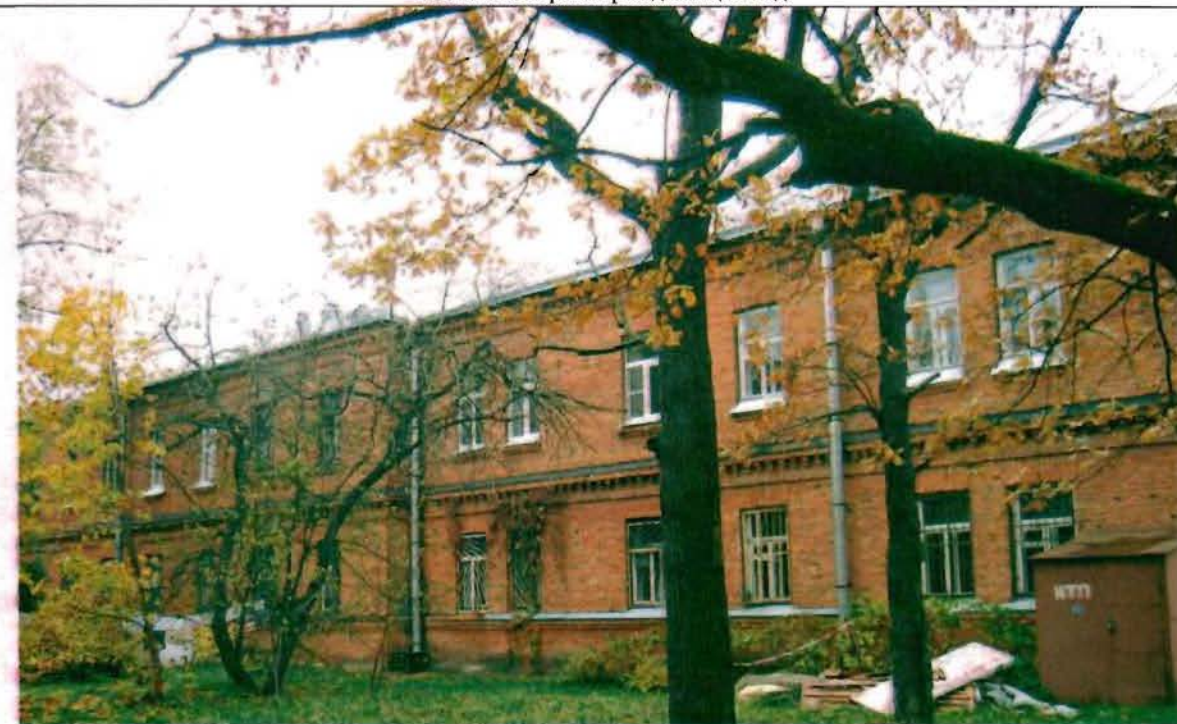
Фото 84. Южный фасад. Общий вид.
