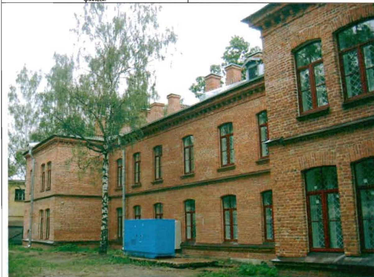
Фото 42. Западный фасад. Общий вид.
