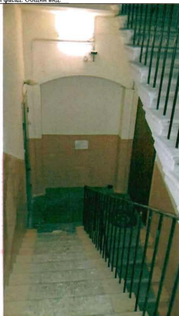
Фото 173. Лестница № 1 в северной части здания. Фрагмент.
