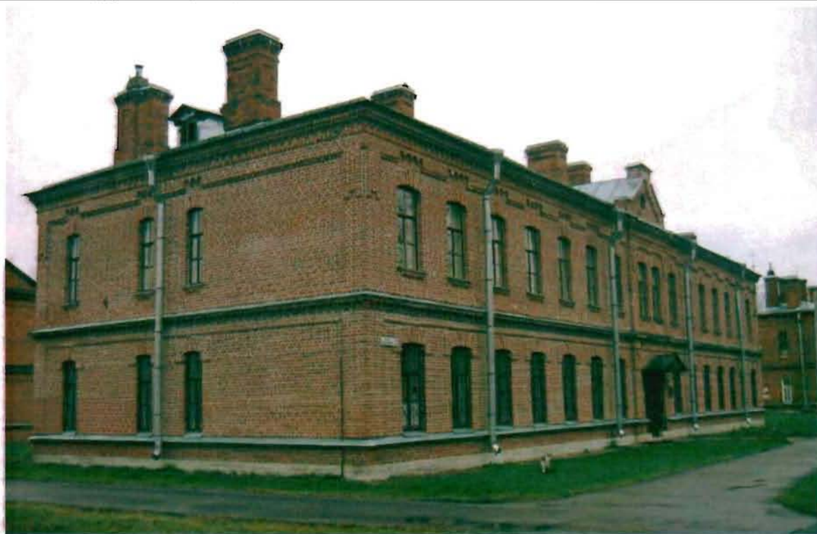
Фото 132. Западный, северный фасады. Общий вид.
