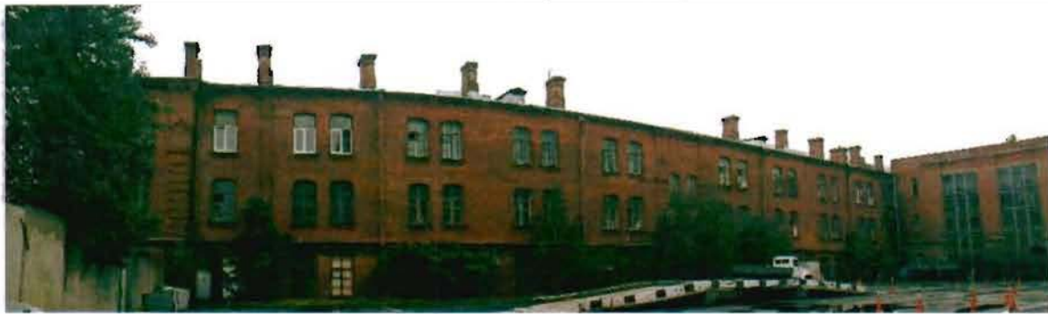
Фото 29. Западный фасад. Общий вид.
