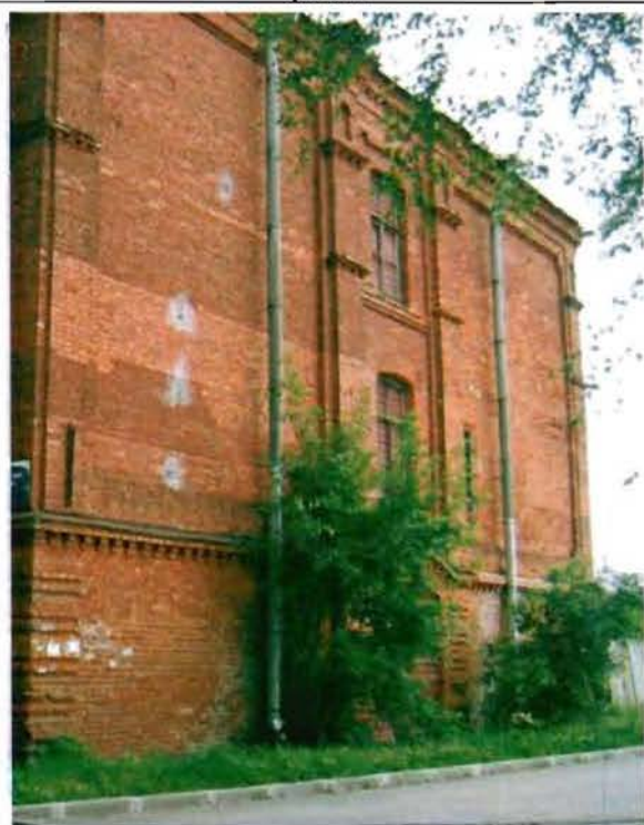
Фото 5. Южный фасад. Общий вид.
