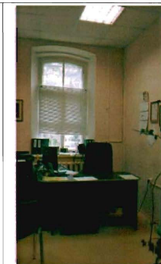
Фото 93. Помещение в уровне 1-го этажа.
