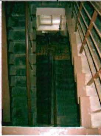
Фото 87. Лестница № 1. Общий вид.
