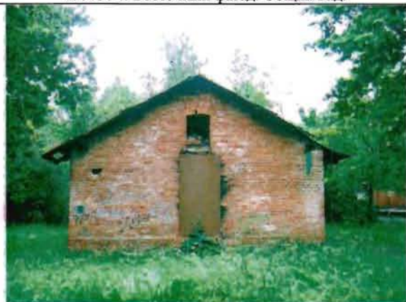
Фото 96. Западный фасад. Общий вид.
