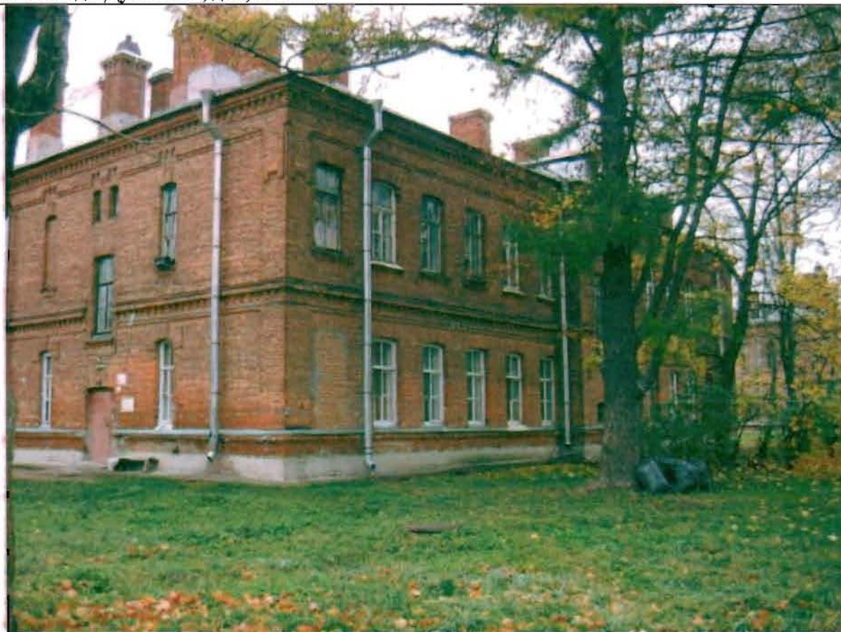
Фото 145. Восточный фасад. Общий вид.
