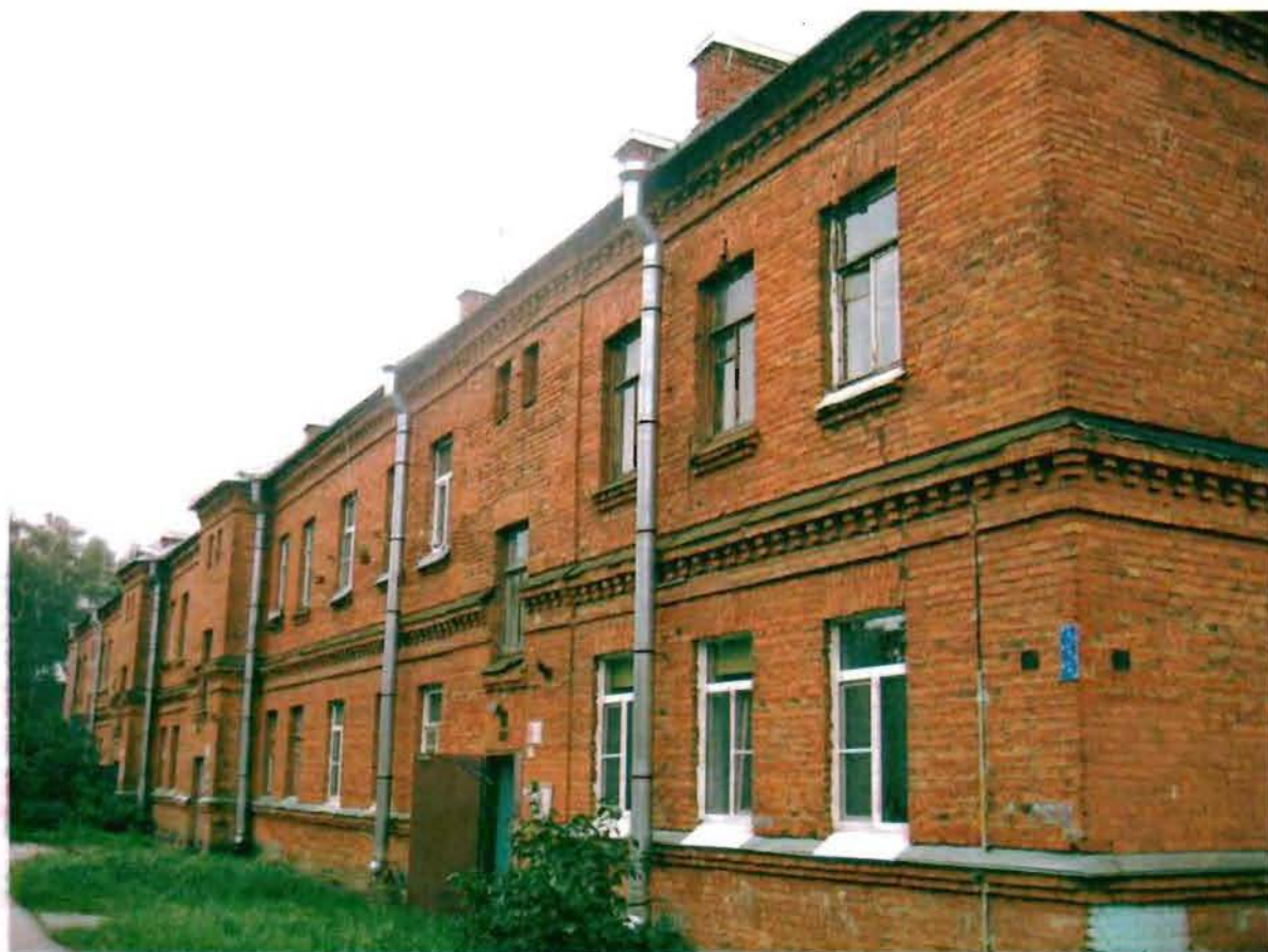
Фото 83. Северный фасад. Общий вид.
