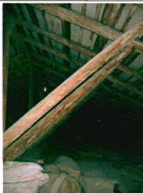
Фото 27. Конструкции крыши. Фрагмент.
