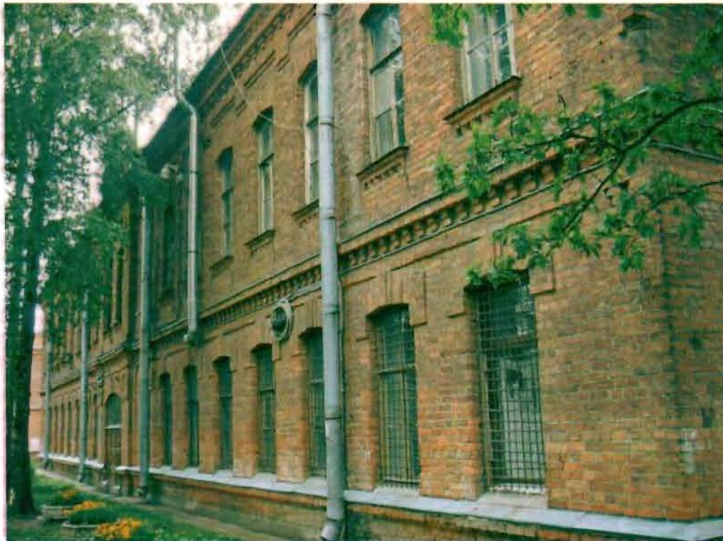
Фото 163. Восточный фасад. Общий вид.
