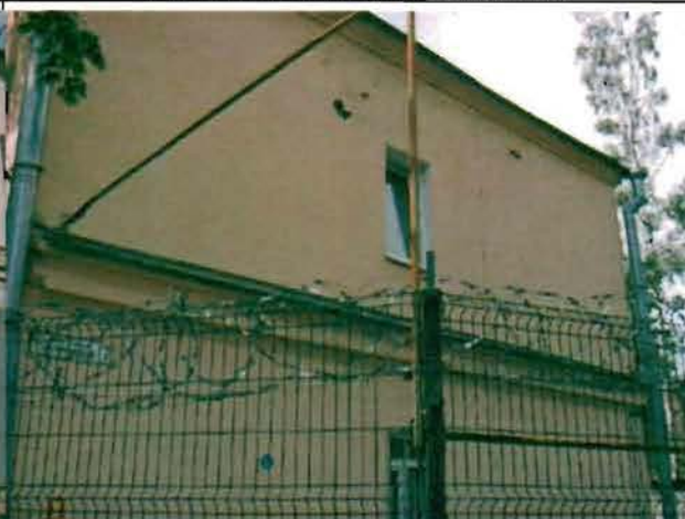
Фото 113. Северный фасад. Общий вид.
