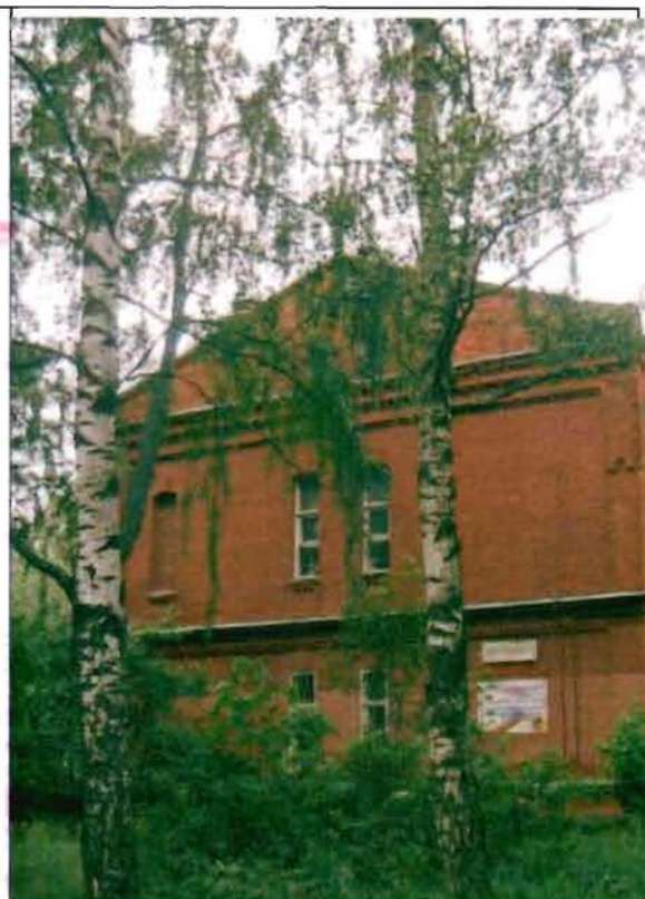
Фото 91. Северный фасад. Общий вид.
