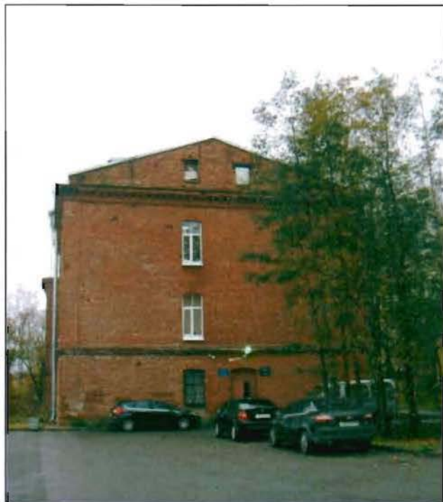
Фото 15. Северный фасад. Общий вид.
