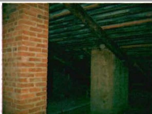
Фото 152. Конструкции крыши. Фрагмент.
