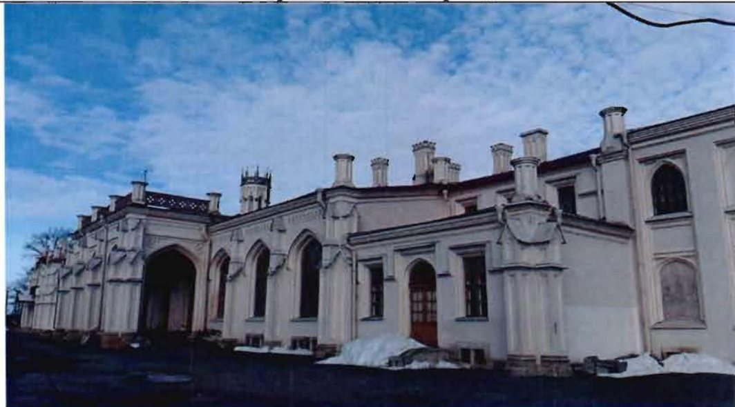
5. Фрагмент южного фасада
