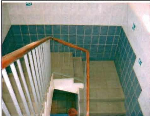
Фото 114. Лестница. Общий вид.
