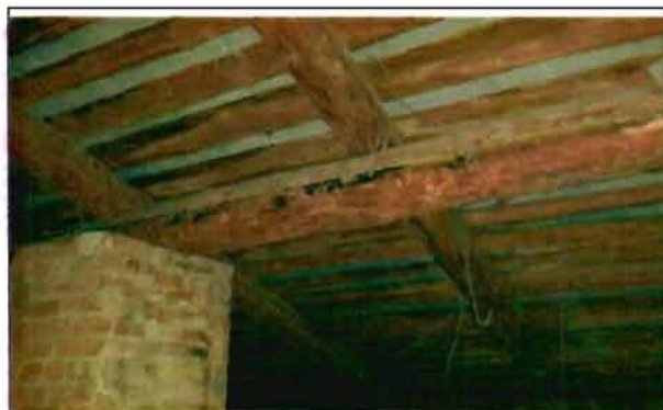
Фото 62. Конструкции крыши. Общий вид.
