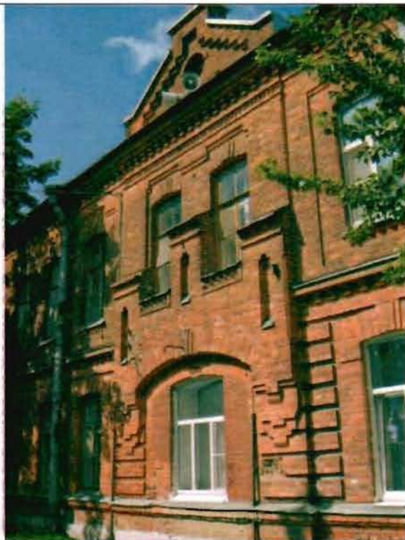
Фото 137. Восточный фасад. Фрагмент.
