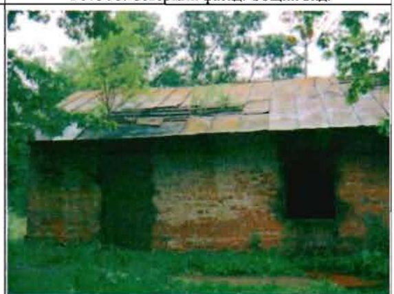
Фото 97. Южный фасад. Общий вид.
