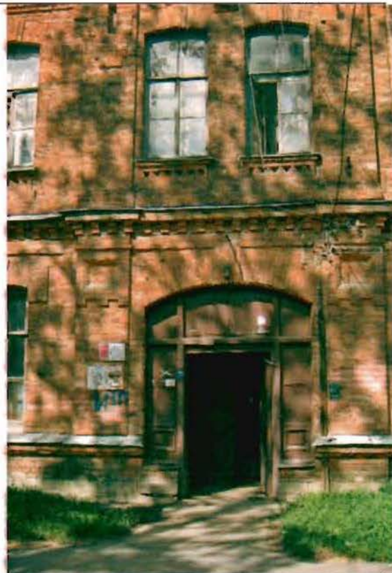
Фото 178. Восточный фасад. Центральная часть. Фрагмент.
