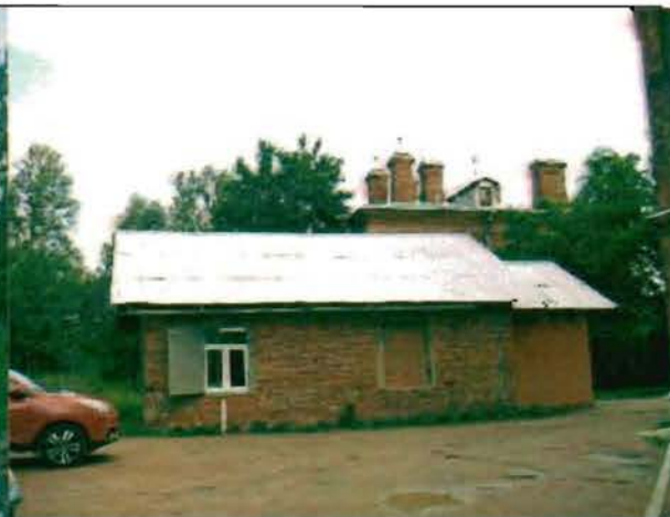
Фото 154. Южный фасад. Общий вид.
