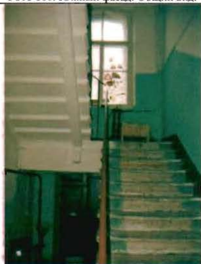
Фото 168. Лестница в южной части здания. Общий вид.
