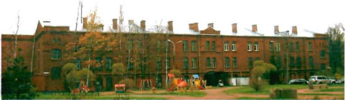
Фото 28. Восточный фасад. Общий вид.
