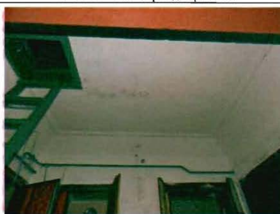
Фото 102. Отделка потолка тамбура. Общий вид.
