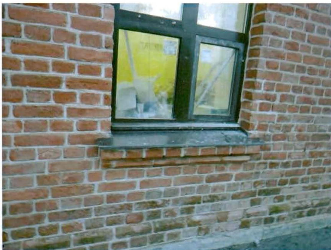
Ступенчатые подоконные доски. Съемка 20.11.2012, Воронина Н.В.
