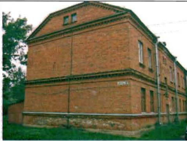
Фото 85. Восточный фасад. Общий вид.
