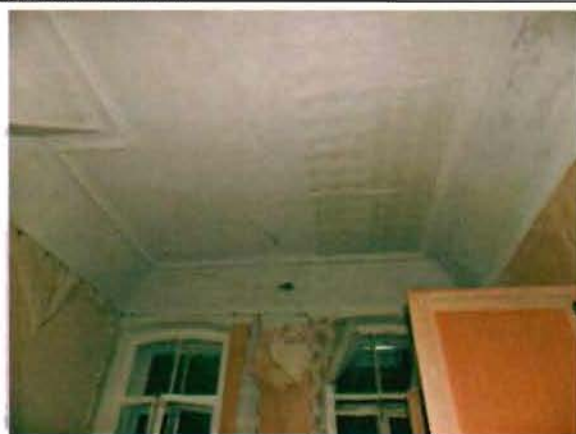
Фото 121. Помещение 1-го этажа.
