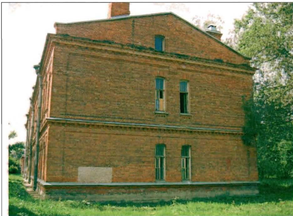
Фото 180. Северный фасад. Общий вид.
