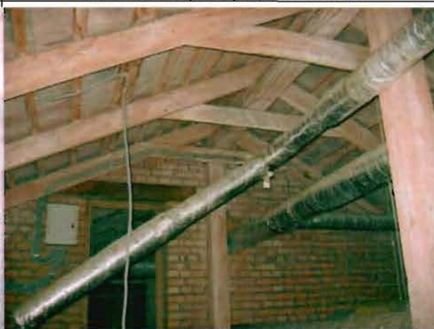
Фото 115. Конструкции крыши. Фрагмент.
