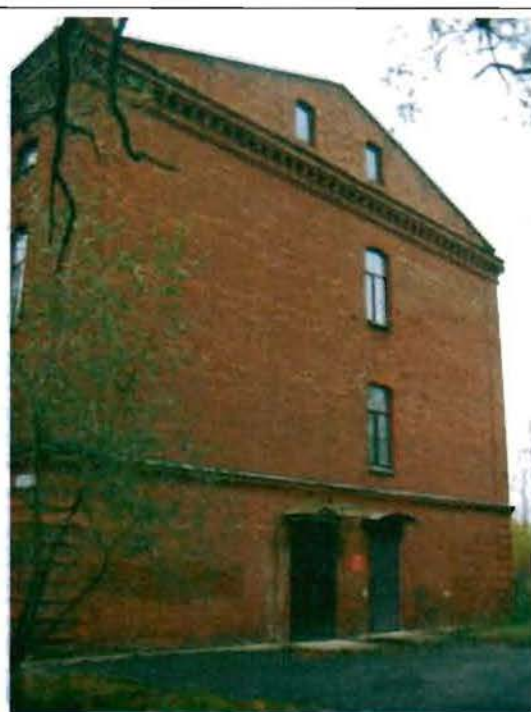
Фото 16. Южный фасад. Общий вид.
