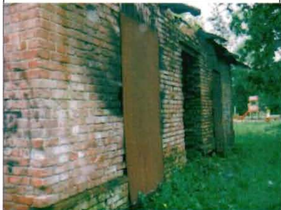
Фото 95. Северный фасад. Общий вид.
