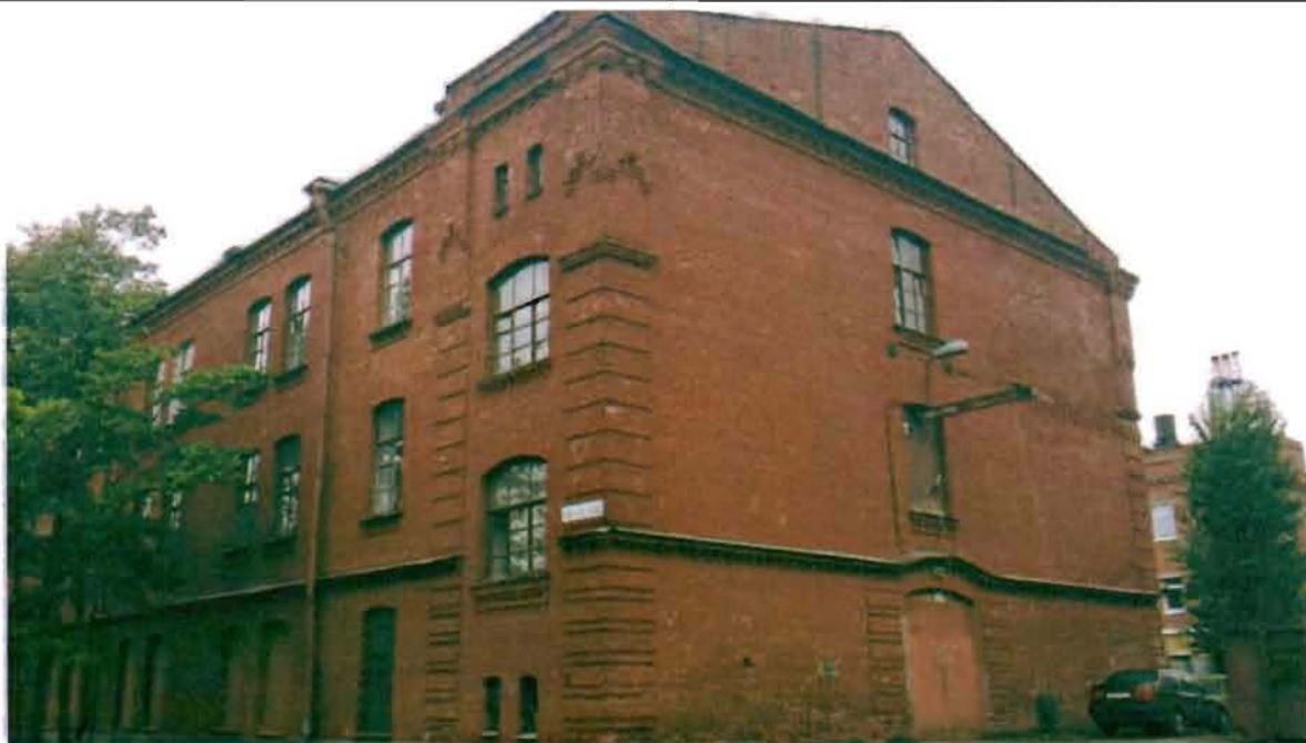
Фото 30. Северный фасад. Общий вид.
