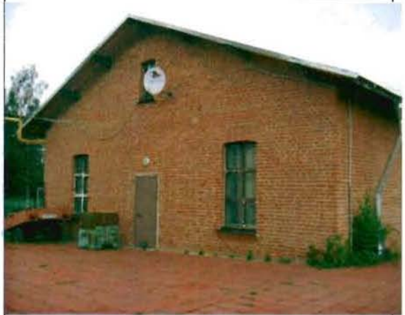
Фото 21. Южный фасад. Общий вид.
