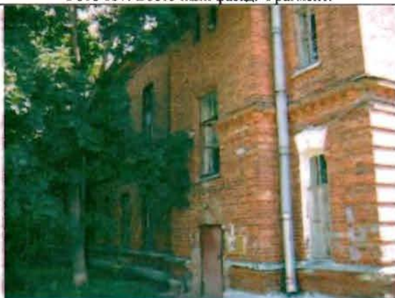
Фото 139. Западный фасад. Фрагмент.
