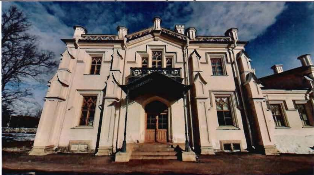
4. Фрагмент южного фасада
