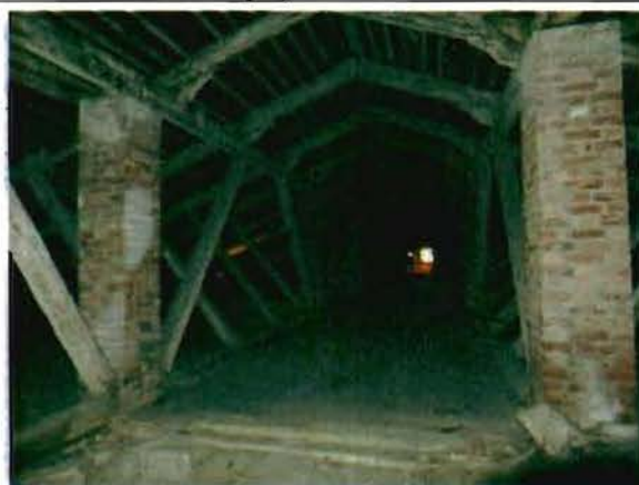
Фото 12. Конструкции крыши. Общий вид. 29.12.2015.
