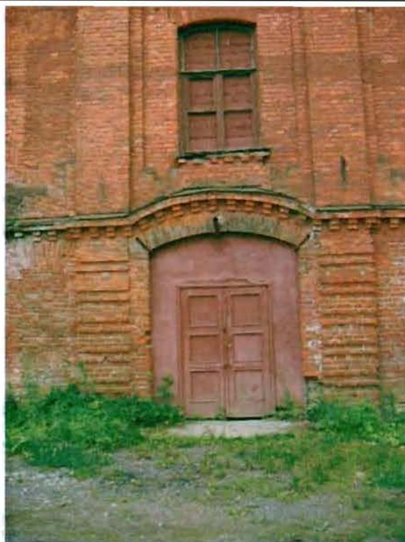
Фото 4. Западный фасад. Фрагмент центральной части фасада.
