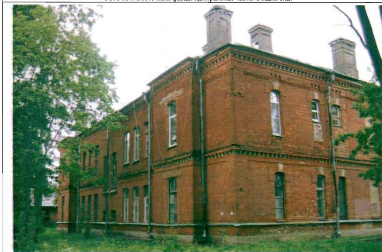
Фото 105. Западный, южный фасады. Общий вид.
