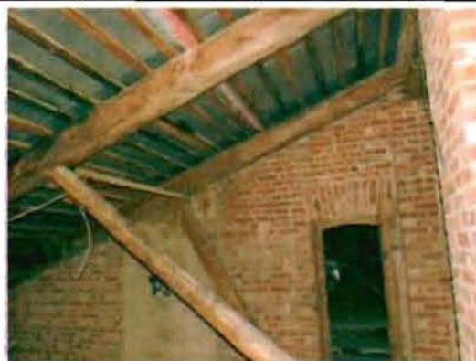
Фото 127. Конструкции крыши. Общий вид.
