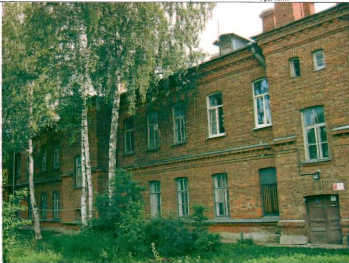
Фото 179. Западный фасад. Общий вид.
