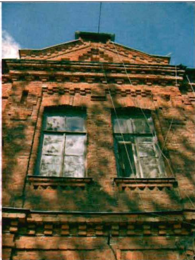
Фото 177. Восточный фасад. Центральная часть. Фрагмент.
