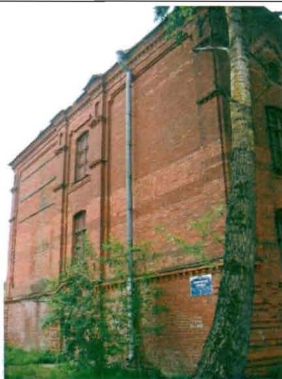
Фото 6. Северный фасад. Общий вид.
