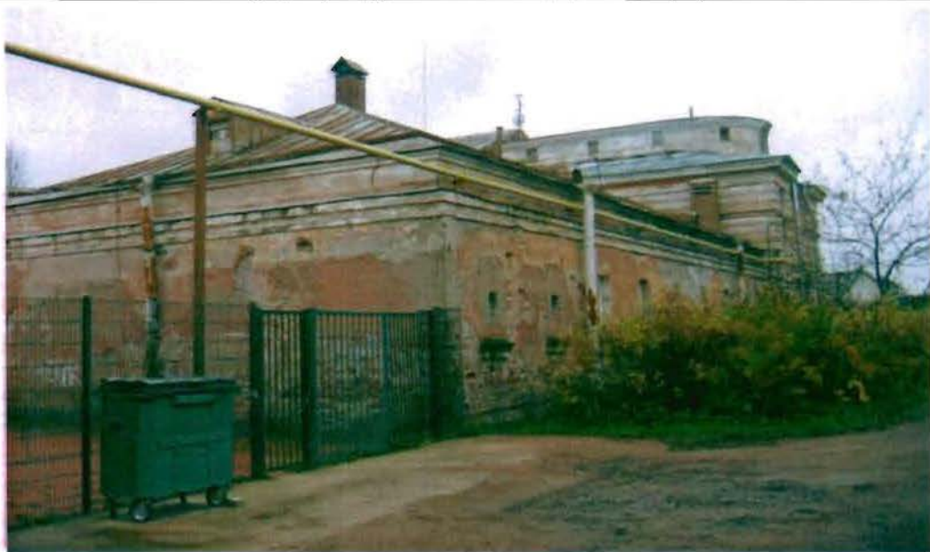
Фото 24. Западный, северный фасады. Общий вид.
