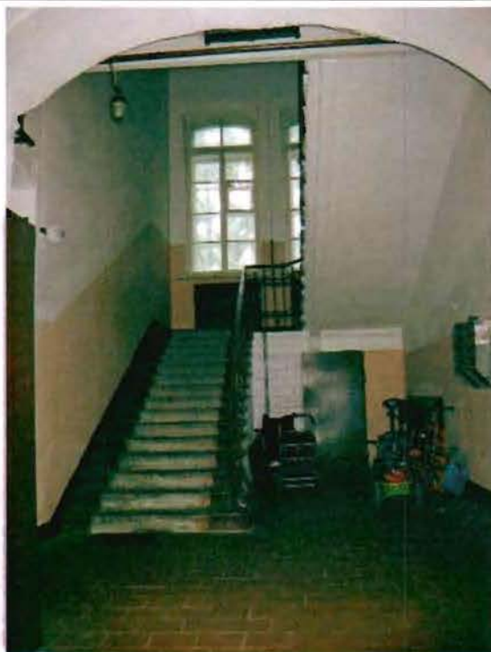
Фото 106. Парадная лестница в центральной части здания. Общий вид.
