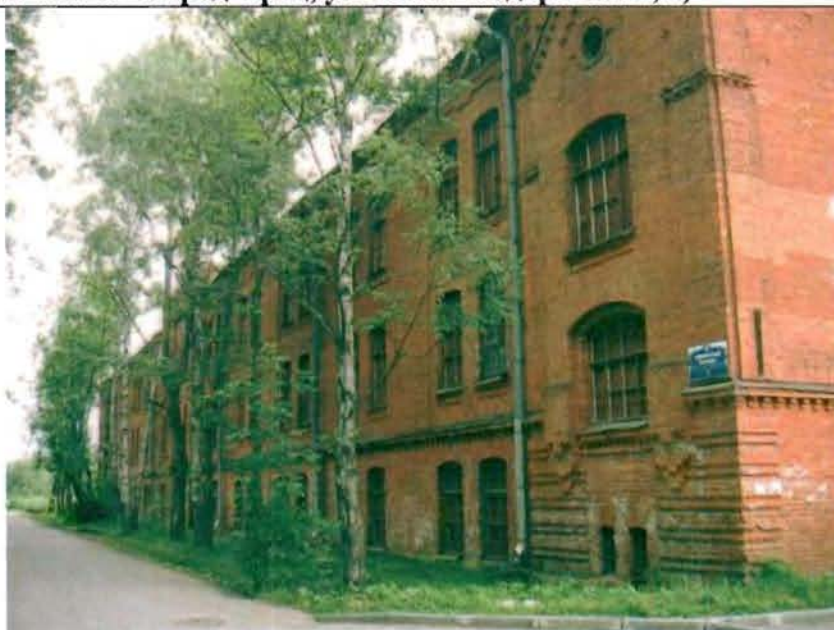
Фото 1. Западный фасад. Общий вид.
