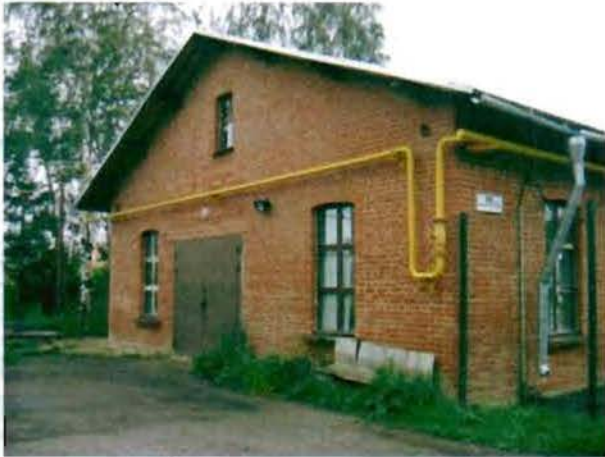
Фото 20. Северный фасад. Общий вид.
