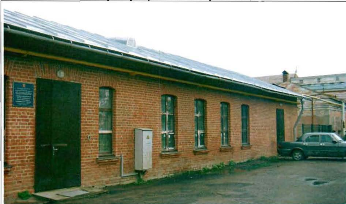
Фото 18. Западный фасад. Общий вид.
