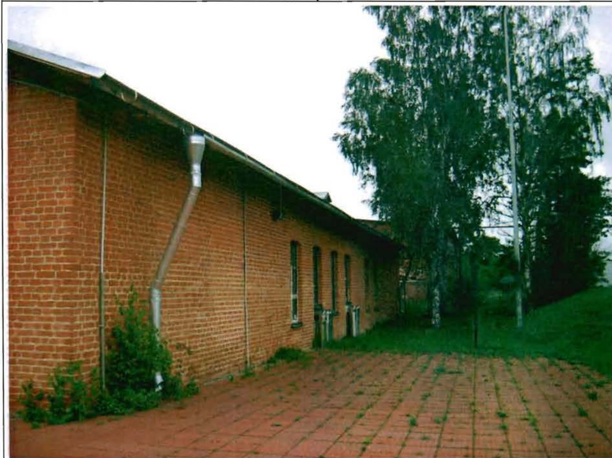
Фото 19. Восточный фасад. Общий вид.
