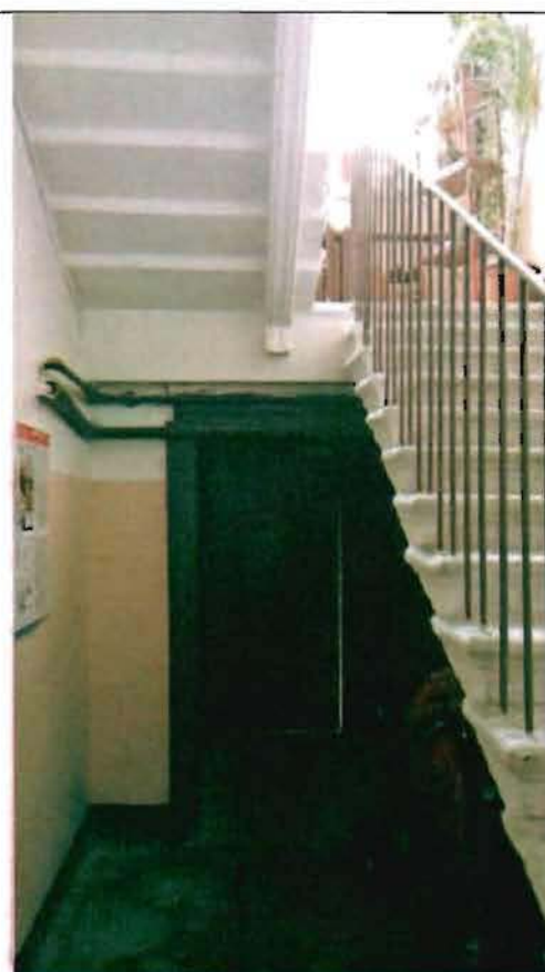
Фото 131. Лестница № 2 в северной части здания. Общий вид.
