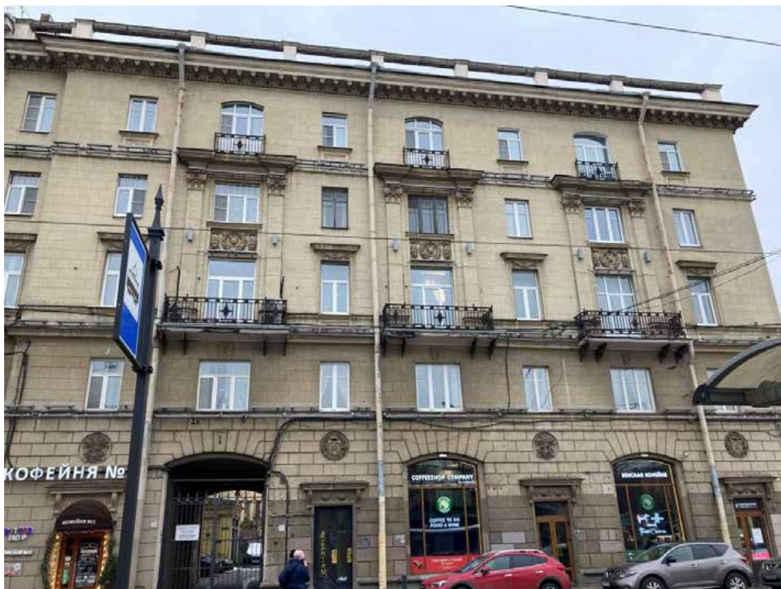
Фото 56. Фрагмент лицевого фасада объекта культурного наследия регионального значения «Дом жилой» (со стороны Кронверкского проспекта)
