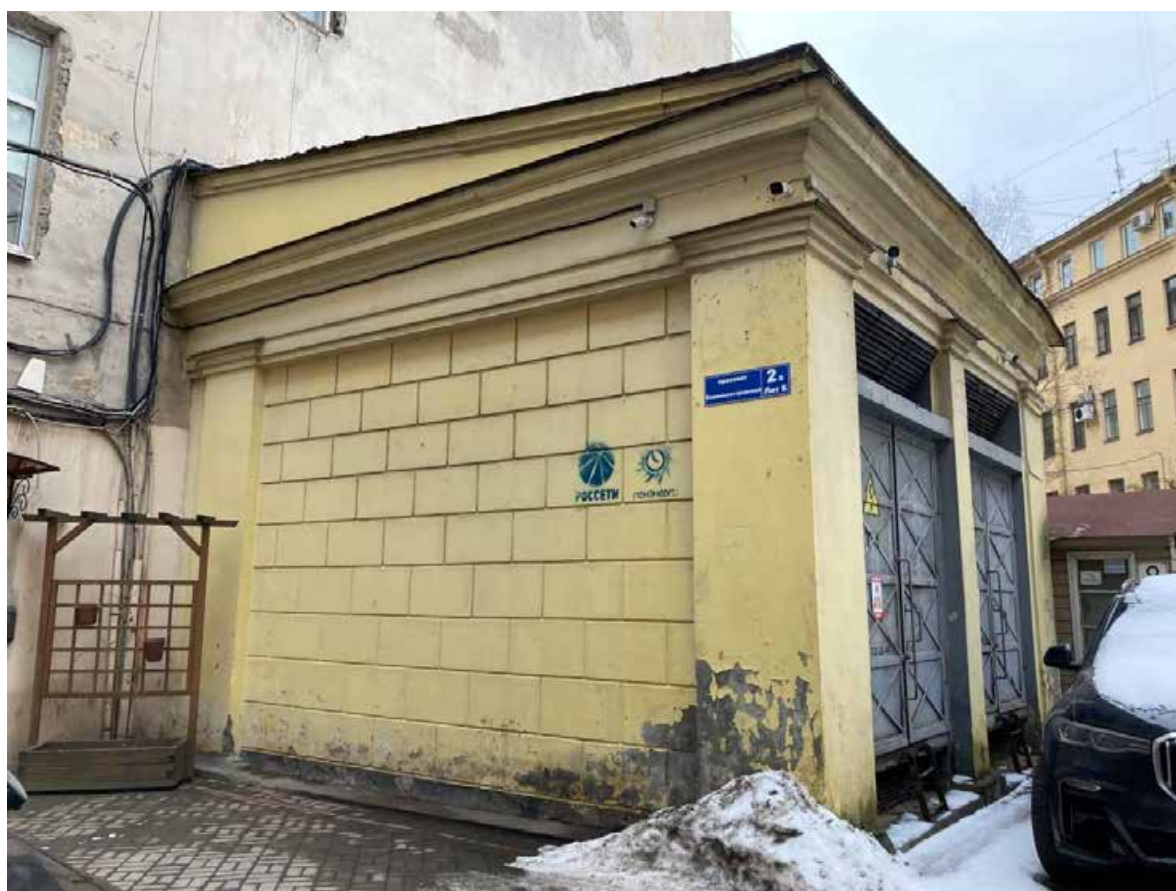
Фото 57. Фрагмент дворового фасада объекта культурного наследия регионального значения «Дом жилой», трансформаторная подстанция 2АБ
