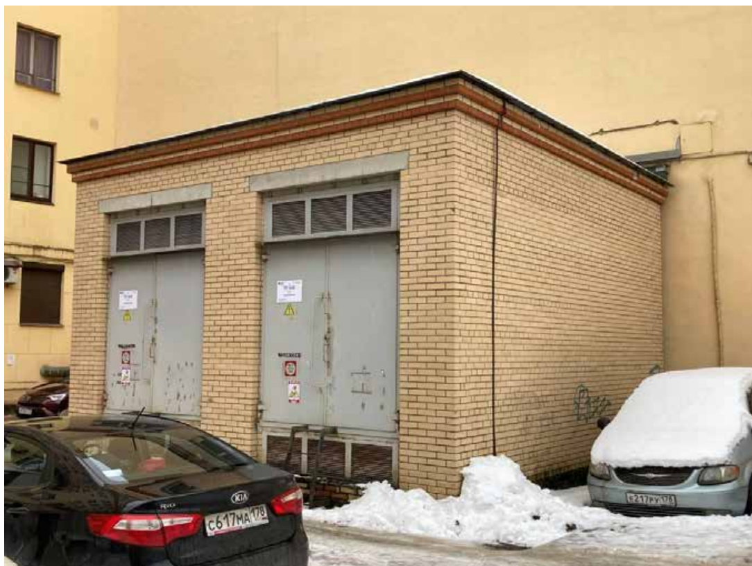
Фото 54. Фрагмент дворового фасада выявленного объекта культурного наследия «Жилой дом специалистов «Иностранный ударник», трансформаторная подстанция 45Т
