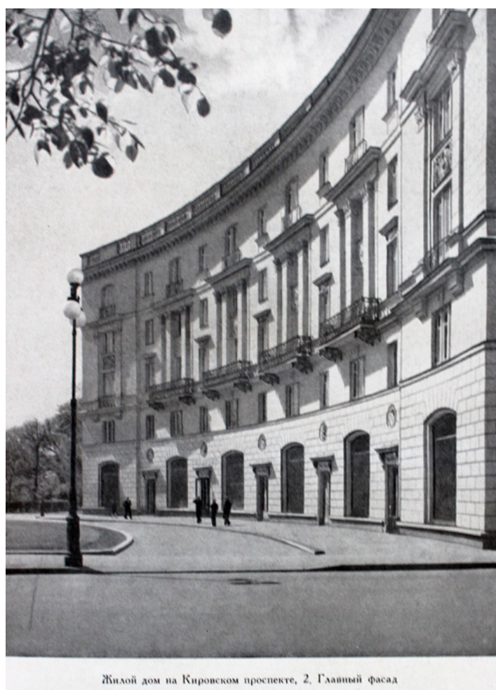
45. Жилой дом на Кировском пр., 2. Главный фасад. — Ежегодник ЛОССА. 1953. С. 63.
