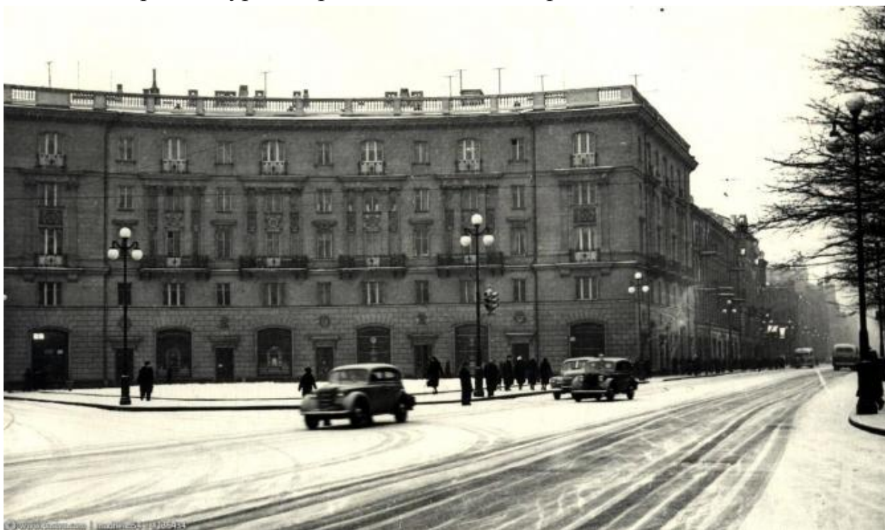
49. Кировский проспект. 1952-1957 г. — Жилой дом // Citywalls.ru – архитектурный сайт Петербурга [Электронный ресурс]. URL: https://www.citywalls.ru/house1131.html .
