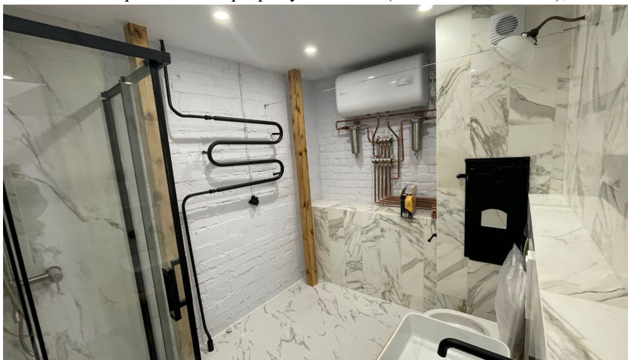
7. Фрагмент интерьера помещения №3 и №4;
