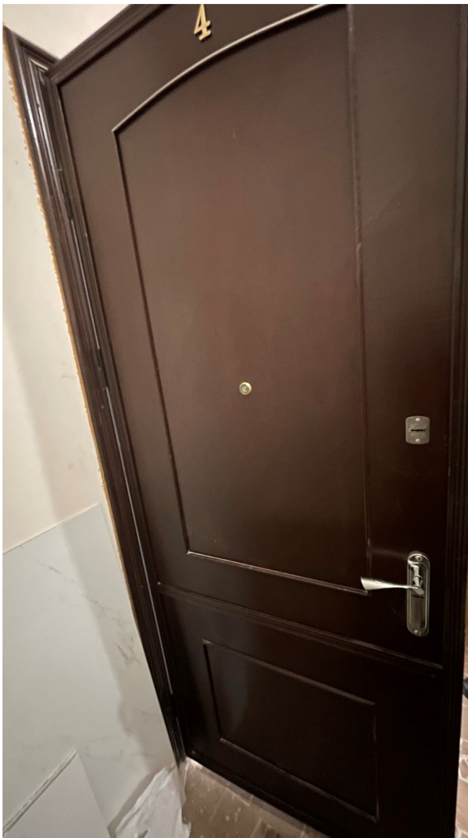
3. Вид на входную дверь в квартиру №4;
