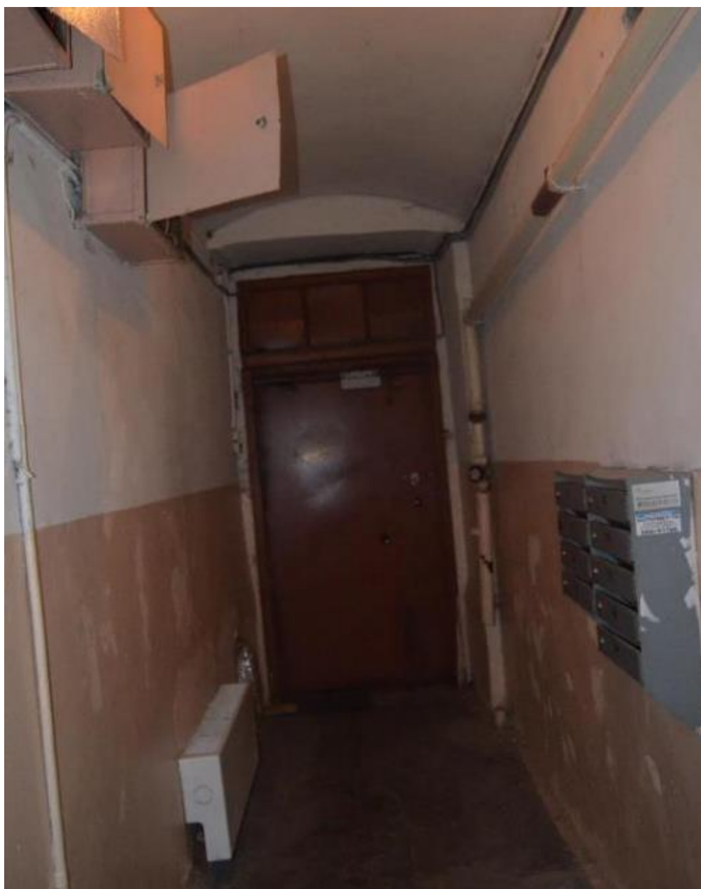
84. Выявленный объект культурного наследия «Дом П. Ф. Дыренкова». Вестибюль черной лестницы по южному дворовому фасаду (Л 5). Съемка 26.04.2021.
