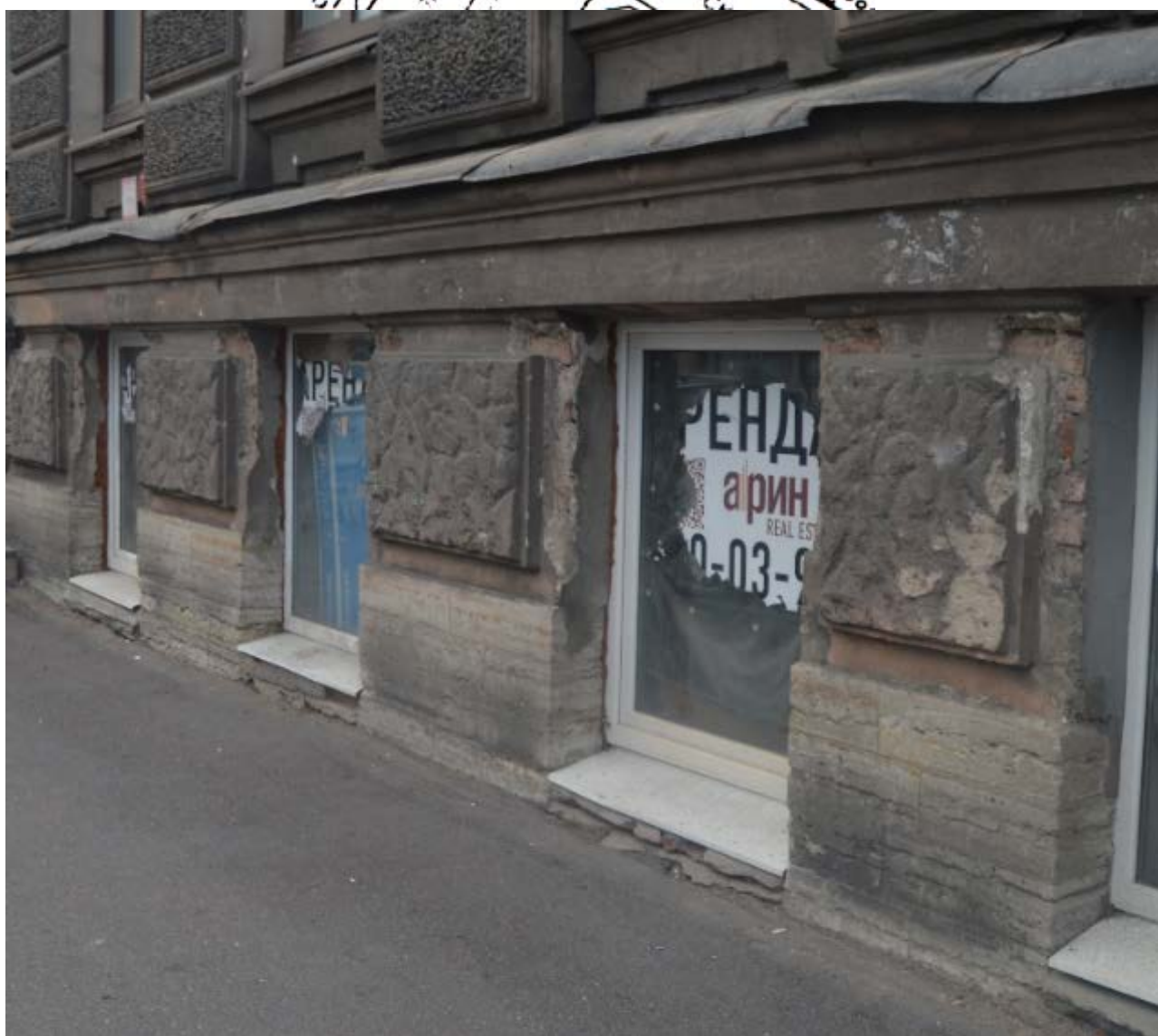
16. Выявленный объект культурного наследия «Дом П. Ф. Дыренкова». Оформление цокольных оконных проемов восточного лицевого фасада. Вид с востока. Съемка 26.04.2021.
