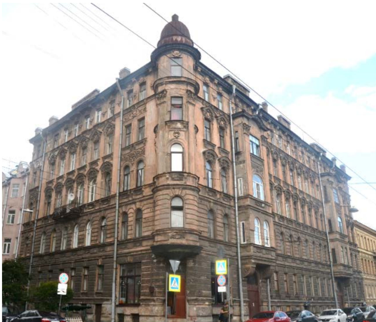
2. Выявленный объект культурного наследия «Дом П. Ф. Дыренкова». Лицевые (южный и восточный) фасады. Общий вид. Вид с юга. Съемка 26.04.2021.
