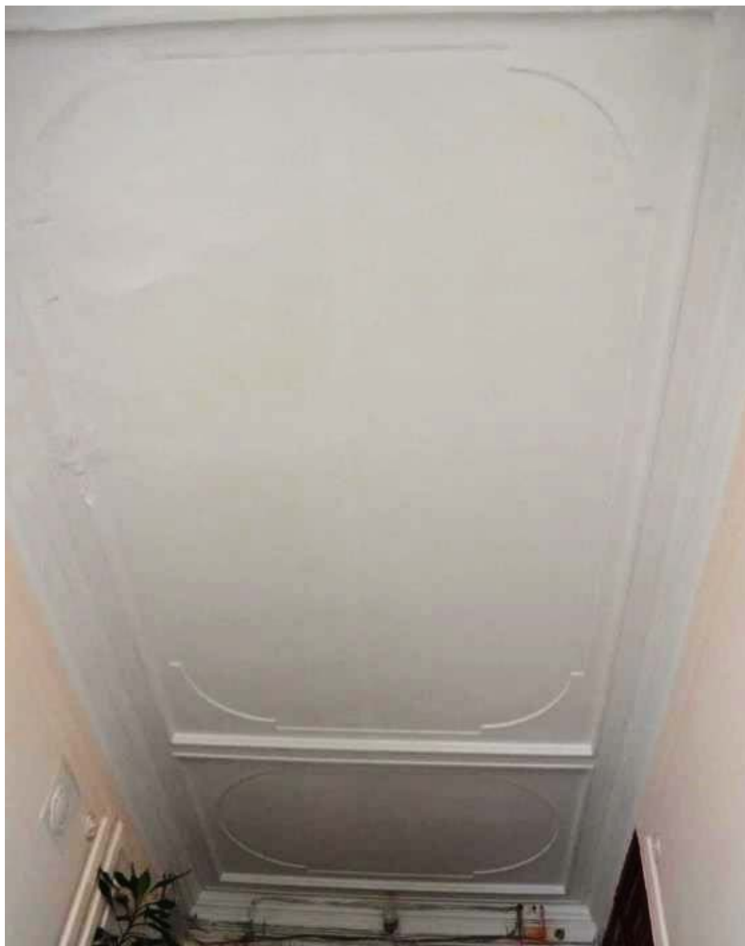
54. Выявленный объект культурного наследия «Дом П. Ф. Дыренкова». Северная парадная лестница (Л 2). Оформление потолка завершения лестничной клетки. Вид с северо-запада. Съемка 26.04.2021.
