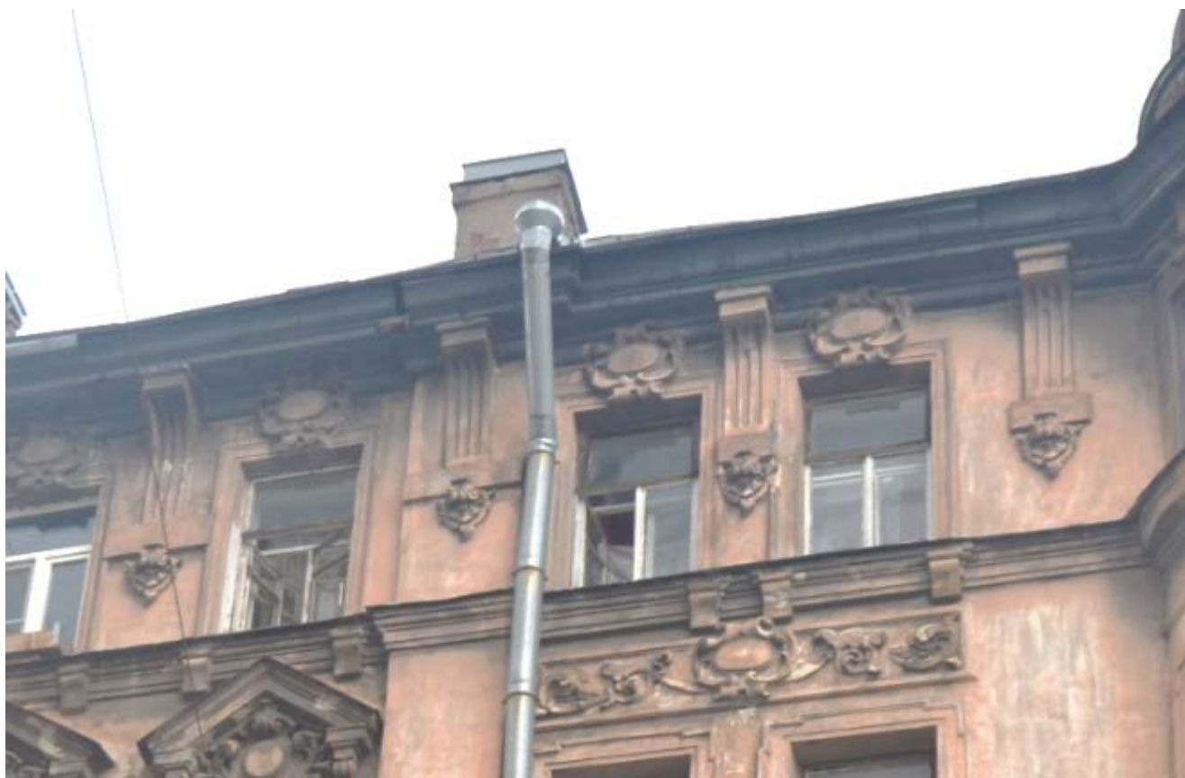
11. Выявленный объект культурного «Дом П. Ф. Дыренкова». Оформление оконных проемов и простенков пятого этажа южного лицевого фасада. Вид с юга. Съемка 26.04.2021.
