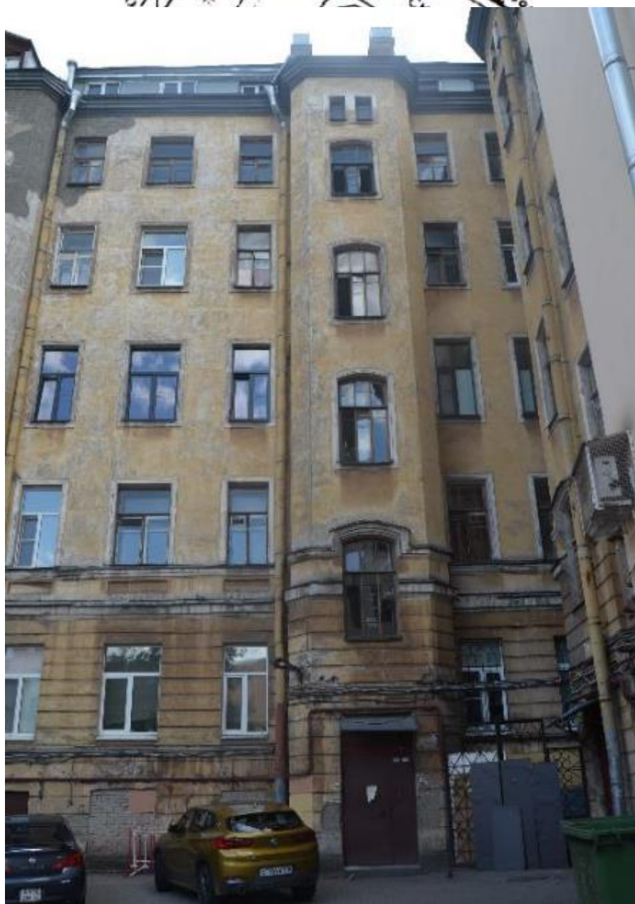
33. Выявленный объект культурного наследия «Дом П. Ф. Дыренкова». Южная часть западного дворового фасада. Вид с запада. Съемка 26.04.2021.
