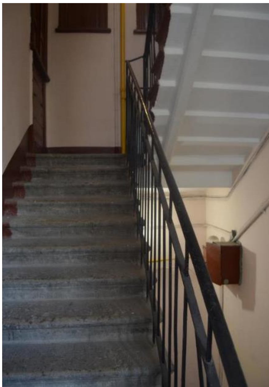
81. Выявленный объект культурного наследия «Дом П. Ф. Дыренкова». Черная лестница по северному дворовому фасаду (Л 3). Конструкция маршей. Вид с северо-запада. Съемка 26.04.2021.
