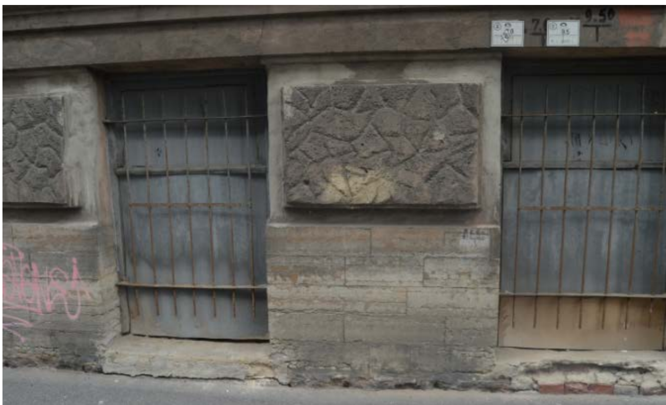
7. Выявленный объект культурного наследия «Дом П. Ф. Дыренкова». Оформление цокольных оконных проемов южного лицевого фасада. Вид с юго-запада. Съемка 26.04.2021.
