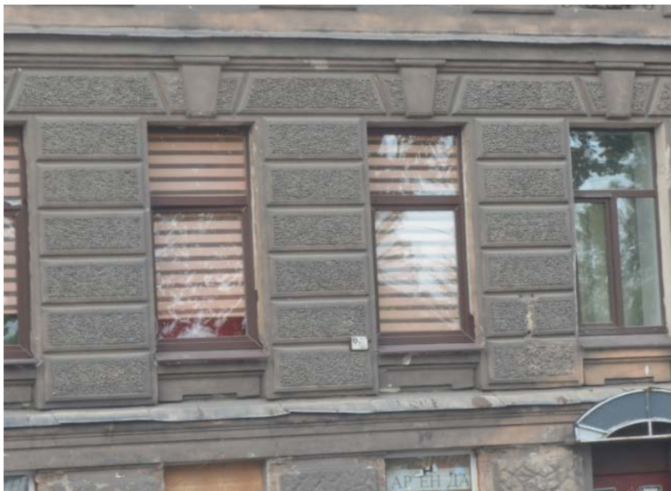
18. Выявленный объект культурного наследия «Дом П. Ф. Дыренкова». Оформление оконных проемов первого этажа восточного лицевого фасада. Вид с востока. Съемка 26.04.2021.
