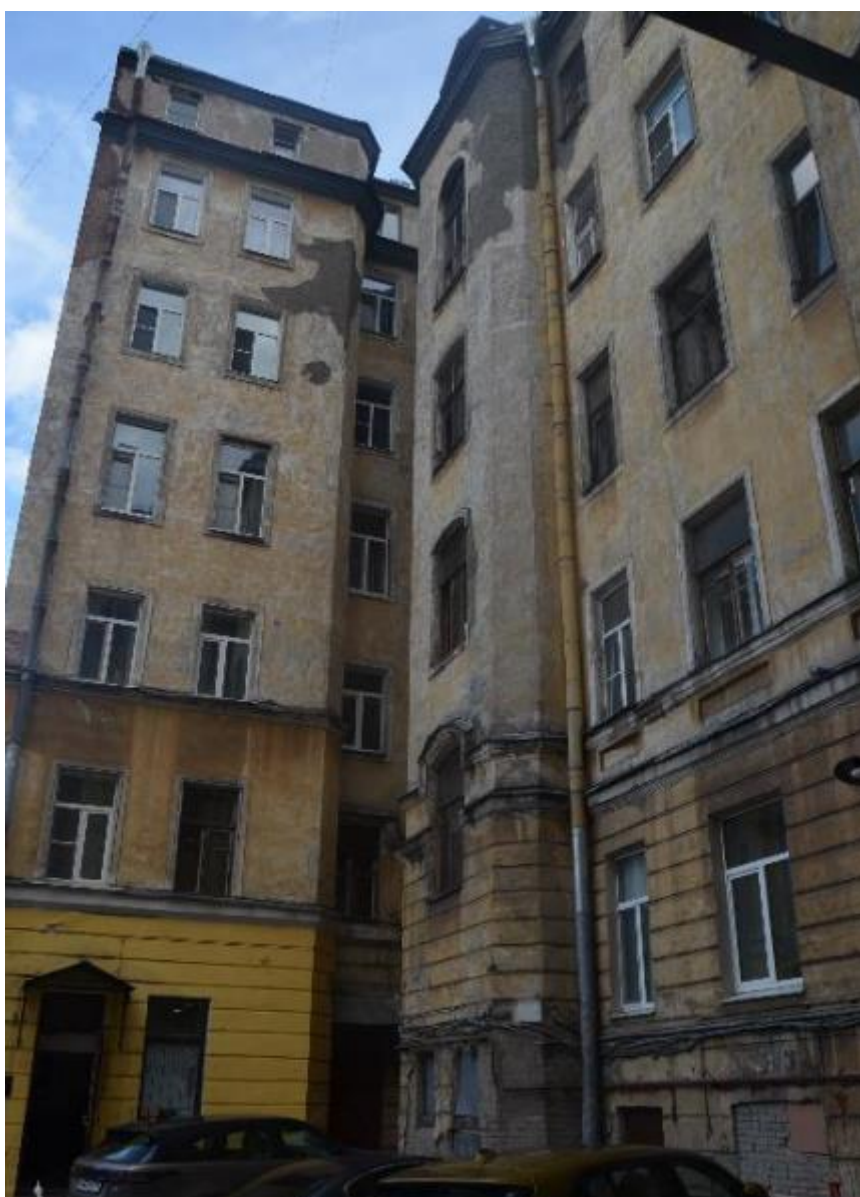
30. Выявленный объект культурного наследия «Дом П. Ф. Дыренкова». Южный и западный дворовые фасады. Вид с запада. Съемка 26.04.2021.
