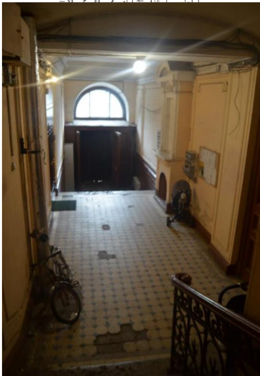
55. Выявленный объект культурного наследия «Дом П. Ф. Дыренкова». Вестибюль южной парадной лестницы (Л 1). Вид с северо-запада. Съемка 26.04.2021.
