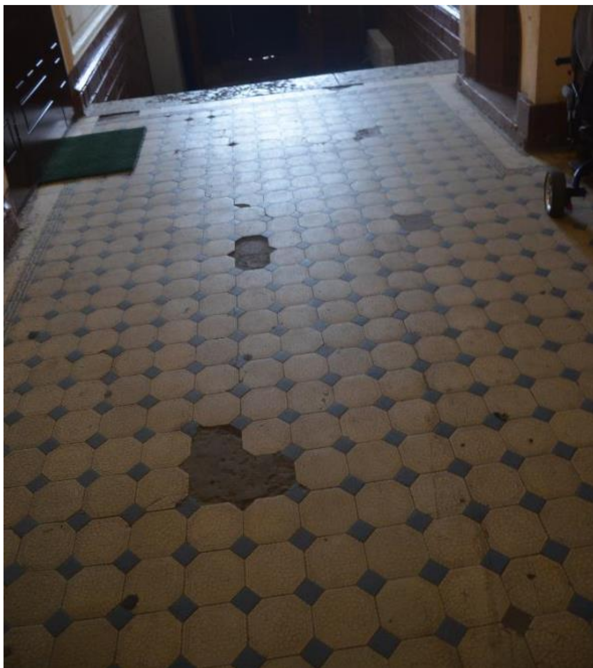
59. Выявленный объект культурного наследия «Дом П. Ф. Дыренкова». Оформление пола вестибюля южной парадной лестницы (Л1). Вид с северо-запада. Съемка 26.04.2021.
