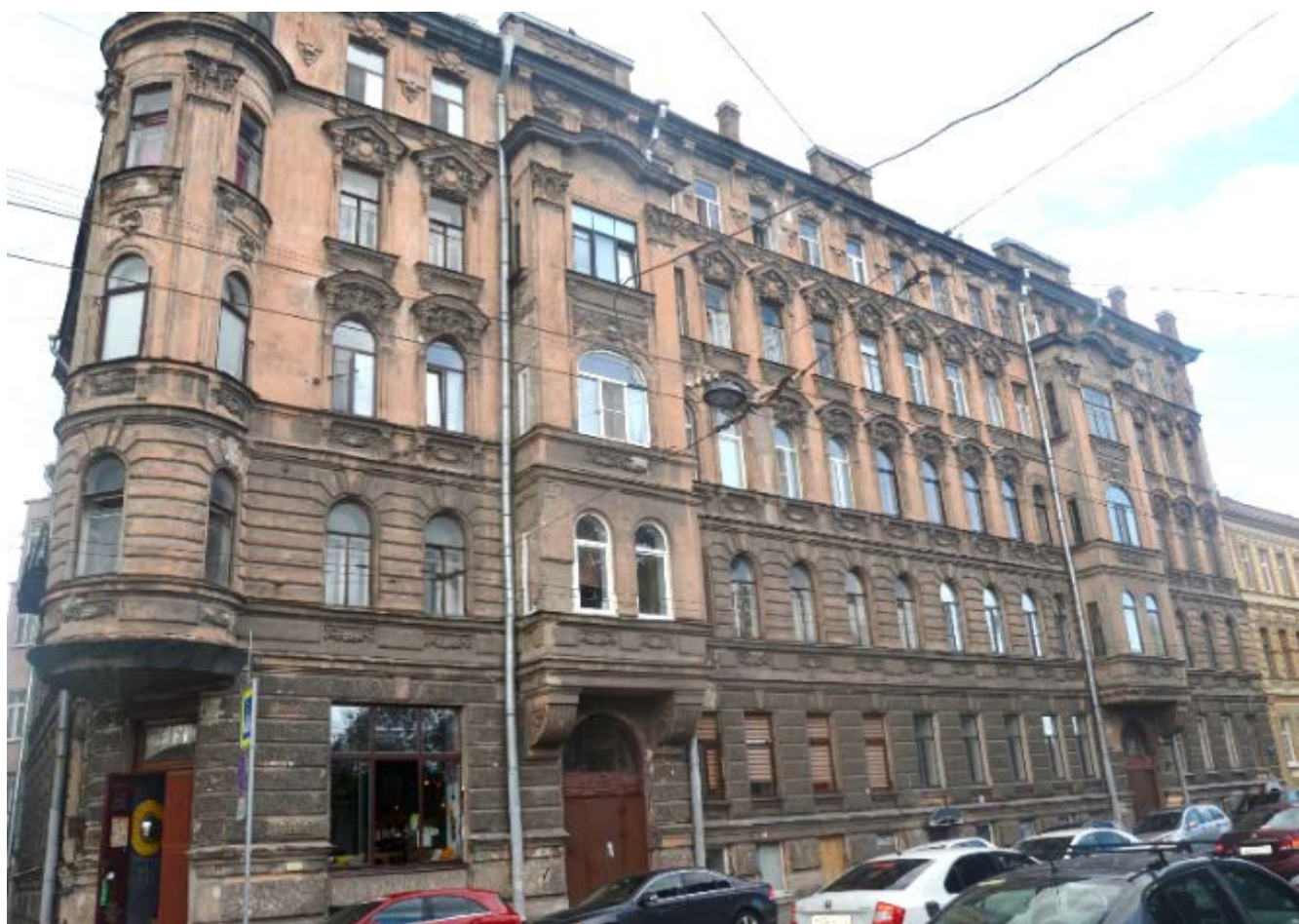
3. Выявленный объект культурного наследия «Дом П. Ф. Дыренкова». Восточный лицевой фасад. Общий вид. Вид с юго-востока. Съемка 26.04.2021.
