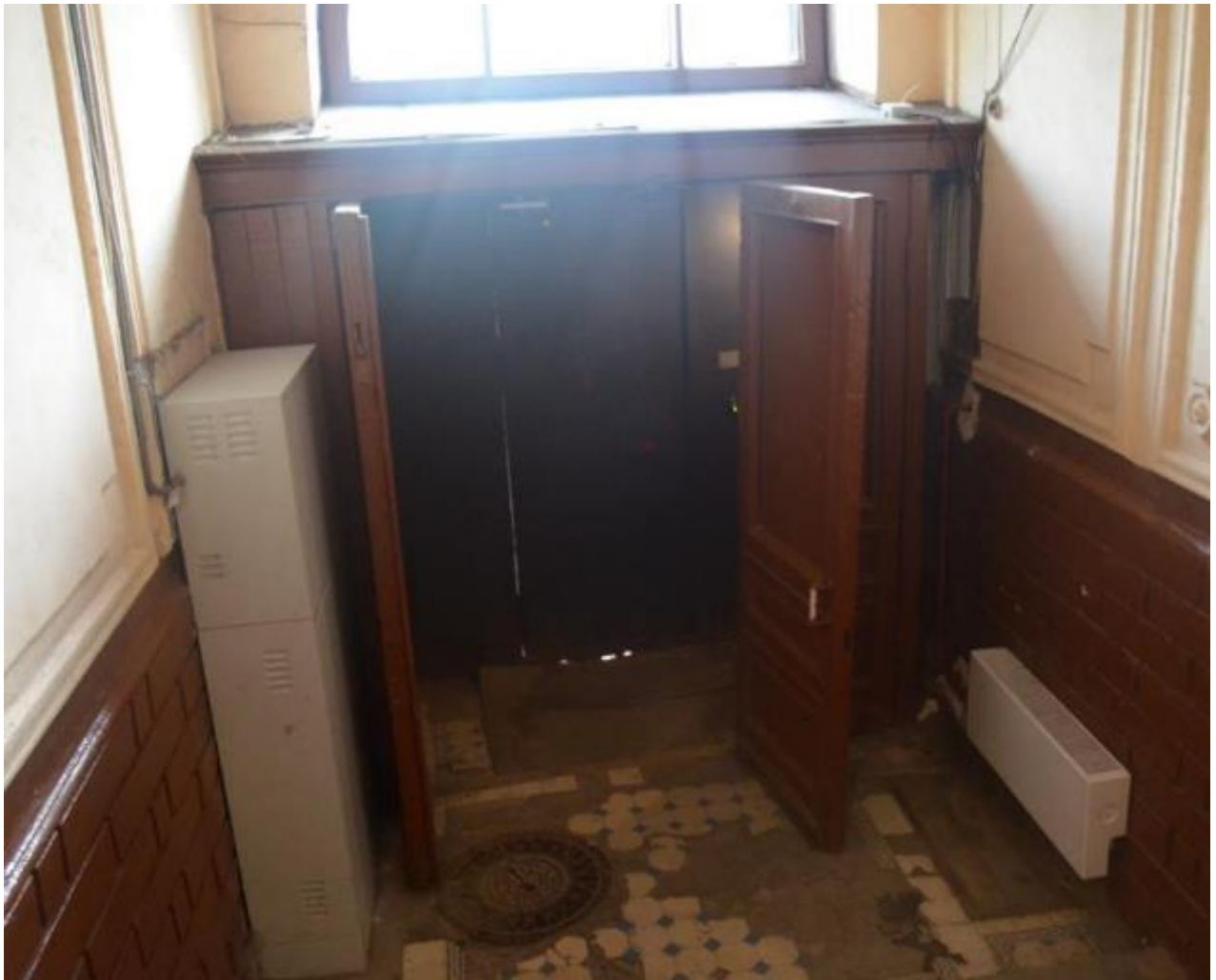
56. Выявленный объект культурного наследия «Дом П. Ф. Дыренкова». Исторический тамбур вестибюля южной парадной лестницы (Л 2). Вид с северо-запада. Съемка 26.04.2021.
