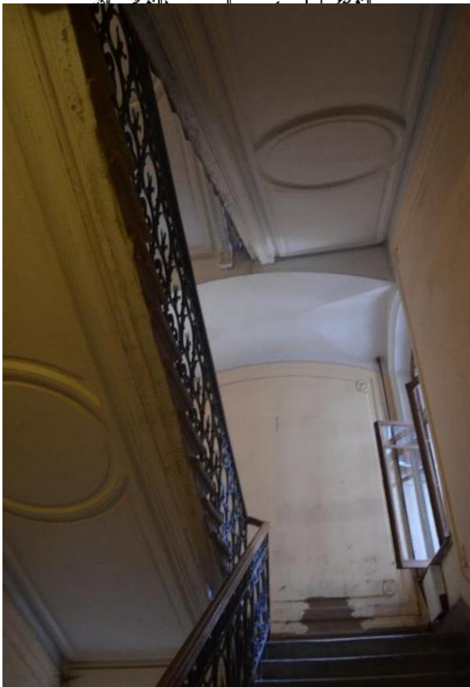
64. Выявленный объект культурного наследия «Дом П. Ф. Дыренкова». Южная парадная лестница (Л 1). Конструкция маршей и площадок. Съемка 26.04.2021.
