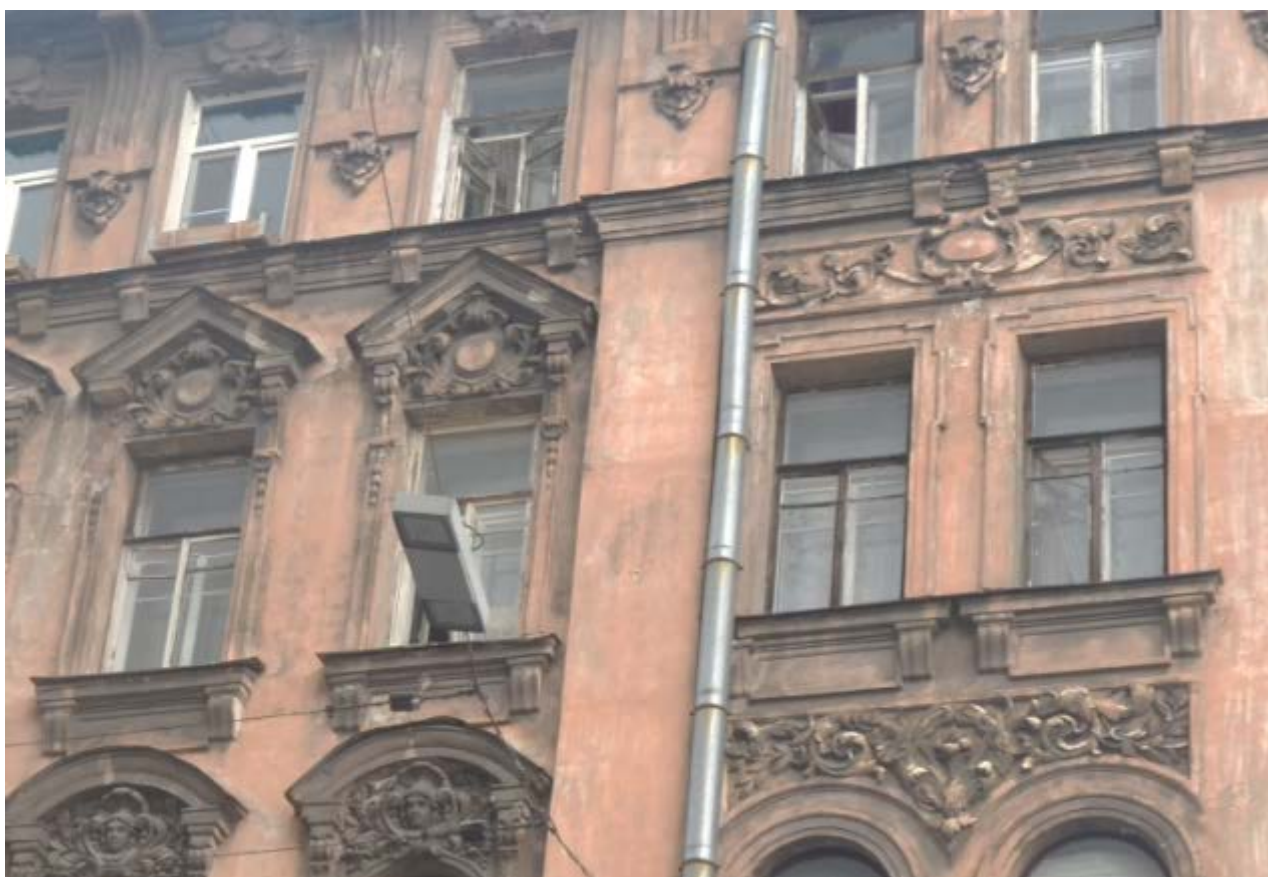
10. Выявленный объект культурного «Дом П. Ф. Дыренкова». Оформление оконных проемов четвертого этажа южного лицевого фасада. Вид с юга. Съемка 26.04.2021.
