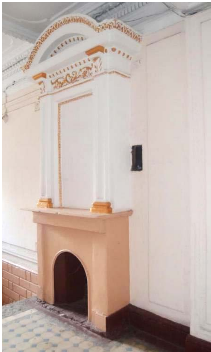
40. Выявленный объект культурного наследия «Дом П. Ф. Дыренкова». Средистенная печь вестибюля северной парадной лестницы (Л 2). Съемка 26.04.2021.
