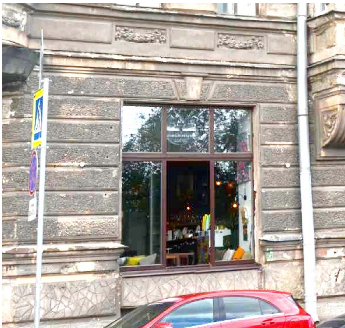
17. Выявленный объект культурного «Дом П. Ф. Дыренкова». Оформление витринного оконного проема в уровне первого этажа по крайней восточной оси южного лицевого фасада. Вид с юго-запада. Съемка 26.04.2021.
