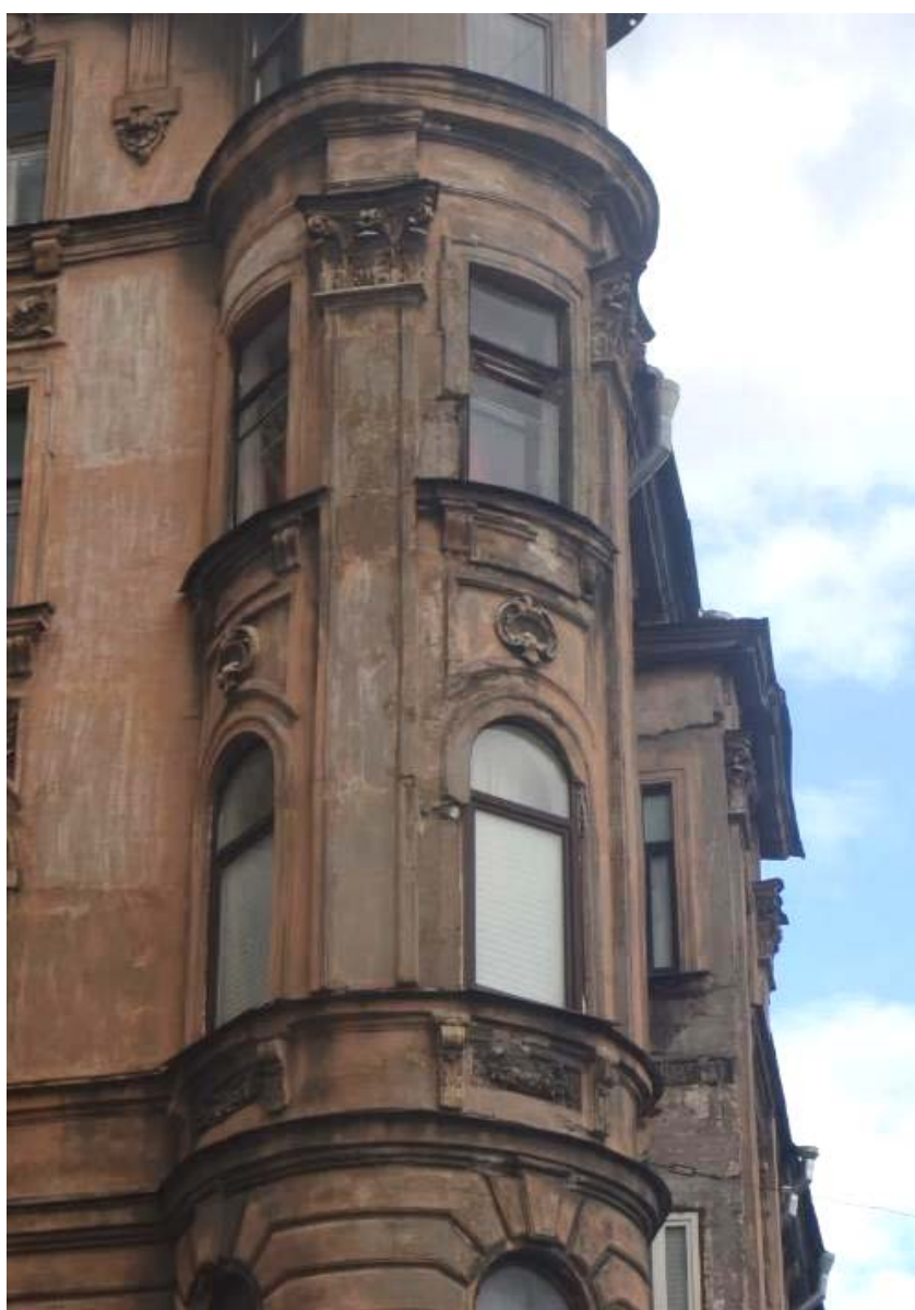
27. Выявленный объект культурного наследия «Дом П. Ф. Дыренкова». Оформление центральной части углового эркера между лицевыми фасадами. Вид с юго-запада. Съемка 26.04.2021.
