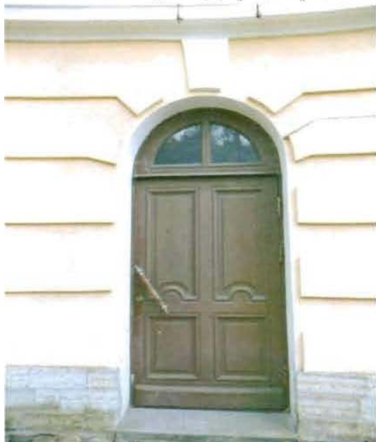
5. Входной дверной проем
