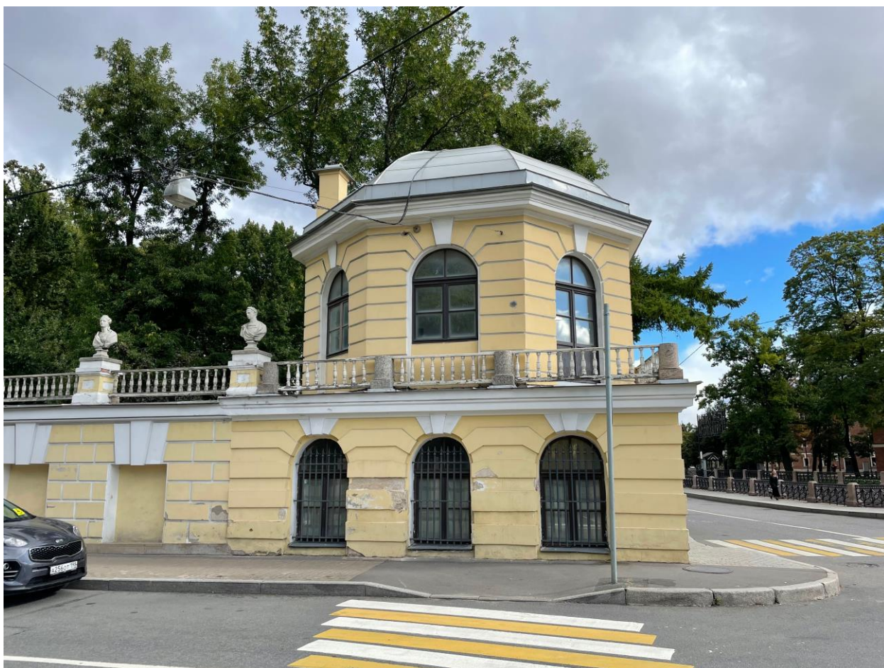
Фото 3. Юго-западный фасад здания павильона.
