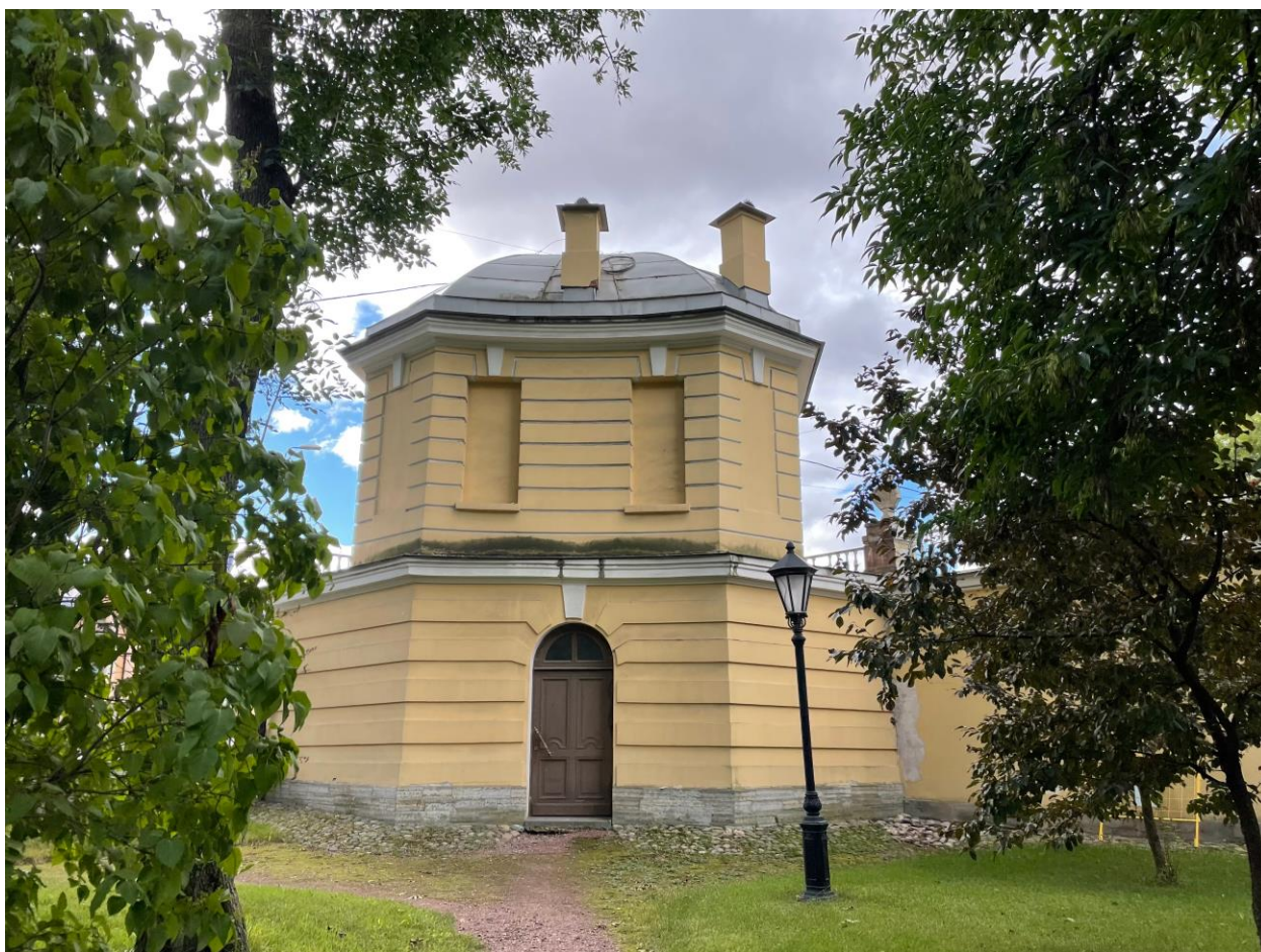
Фото 4. Северный фасад здания павильона.
