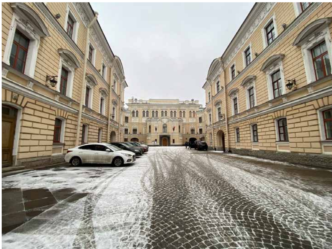
Фото 6. Вид на западный фасад главного поперечного корпуса с Царским павильоном и с концертным залом.
