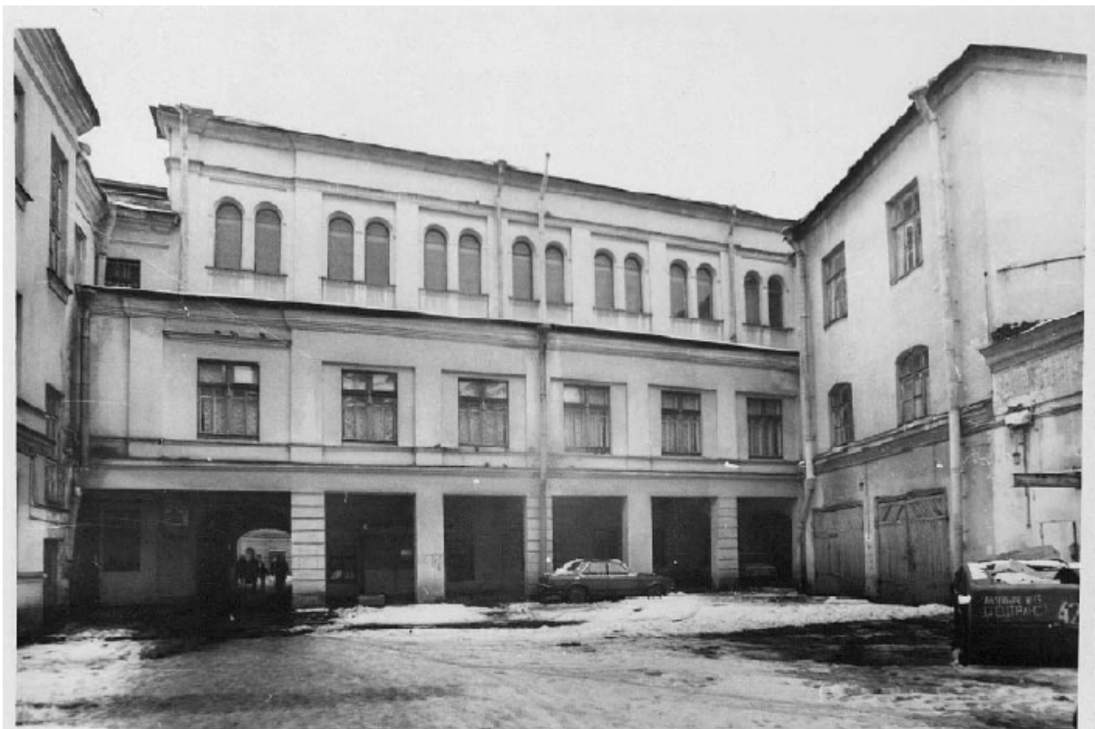
56. Дворовые фасады, 1997 г. Паспорт ОКН. Архив КГИОП
