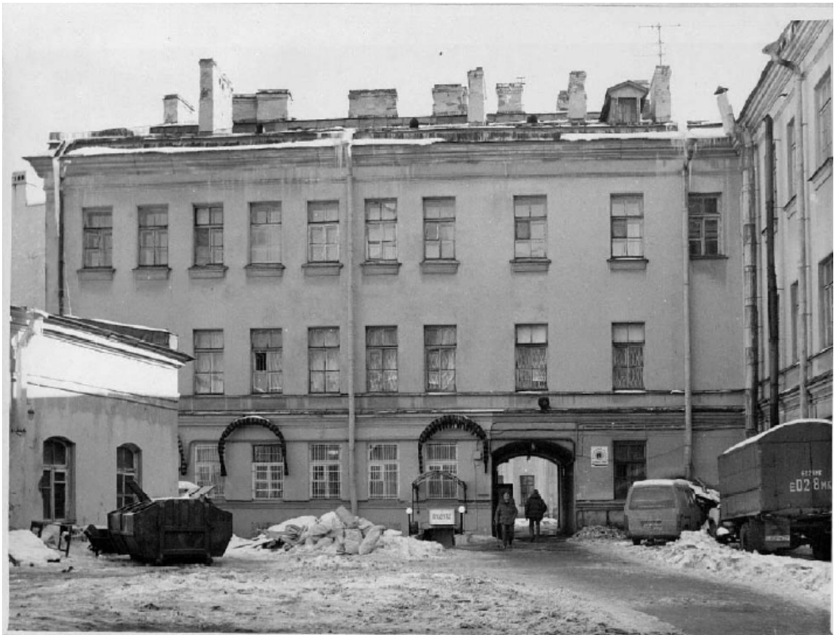
57. Дворовые фасады. 1997 г. Паспорт ОКН. Архив КГИОП
