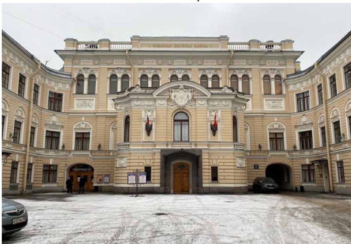
Фото 7. Вид на аттиковое ограждение западного фасада главного поперечного корпуса с Царским павильоном и с концертным залом с демонтированными вазонами.
