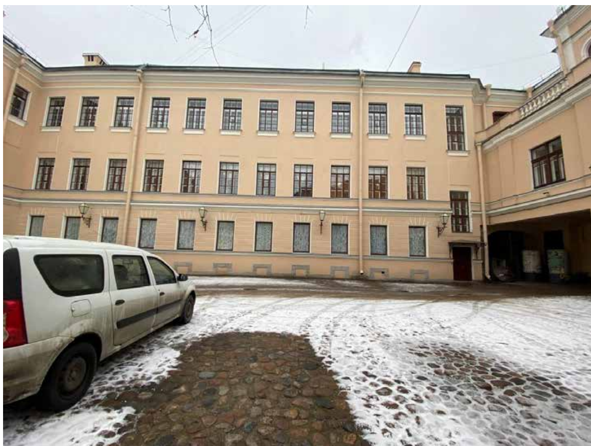
Фото 11. Вид на южный дворовый флигель.
