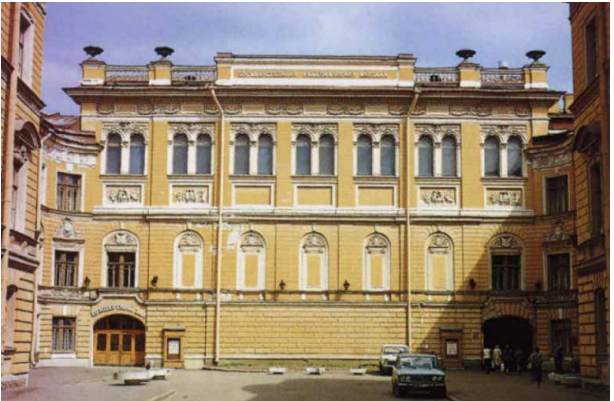
55. Главный фасад здания Капеллы, 1990-1994 гг. [Электронный ресурс] URL: https://pastvu.com/p/448757
