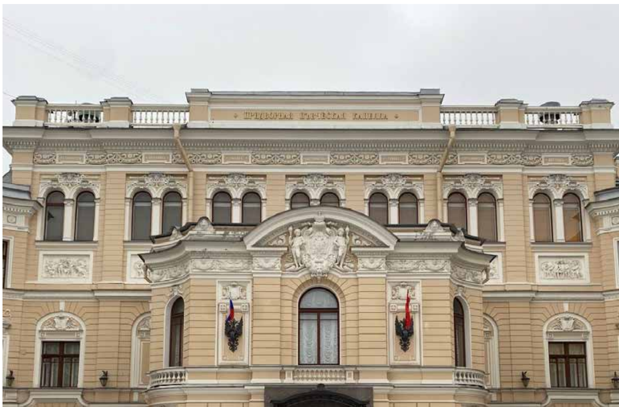
Фото 8. Вид на северную часть аттикового ограждения западного фасада главного поперечного корпуса с Царским павильоном и с концертным залом с демонтированными вазонами.
