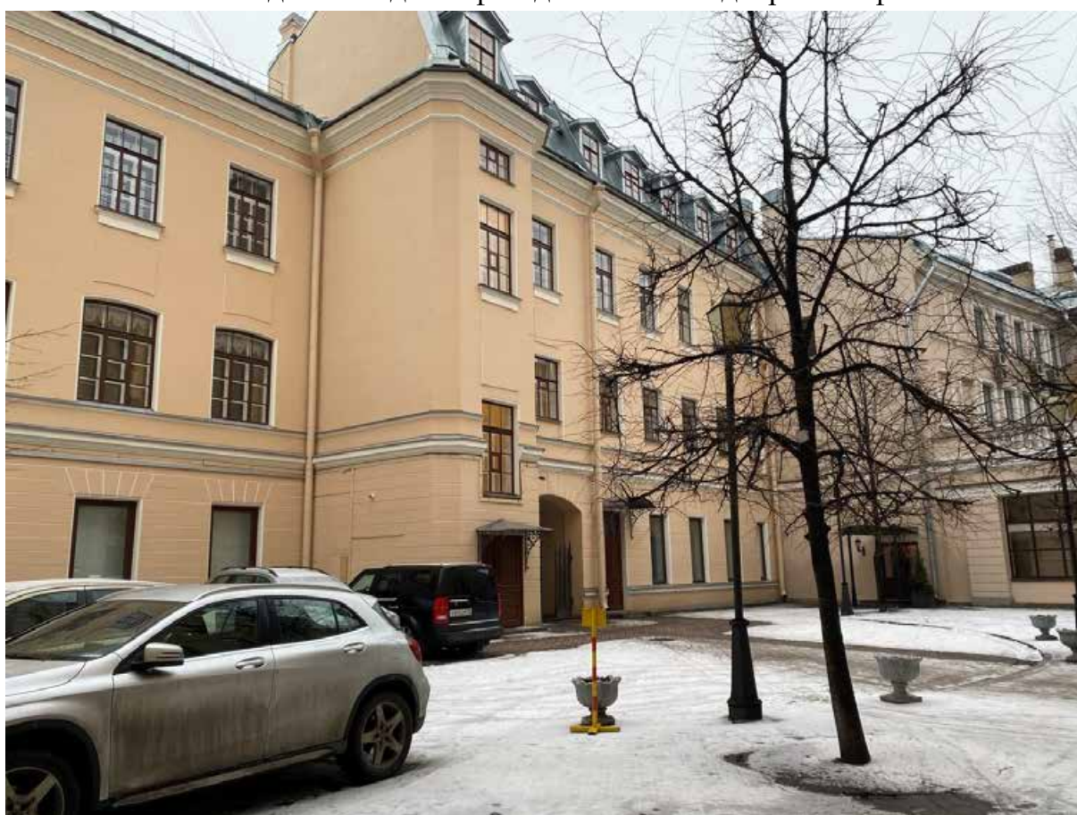
Фото 13. Вид на восточный фасад восточного дворового флигеля.
