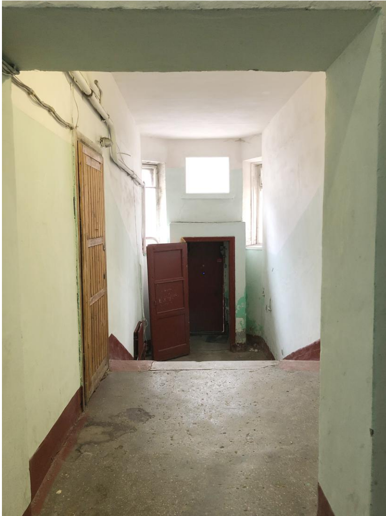
7. Вестибюль парадного входа в подъезд со стороны двора.
