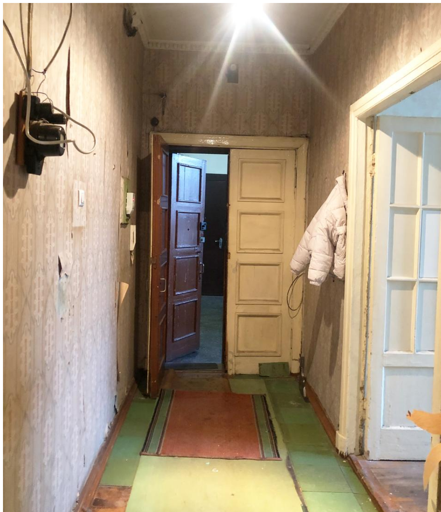
15. Холл квартиры (помещение 16). Вид в сторону входной двери.
