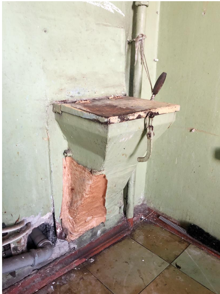
22. Кухня (помещение 5). Мусоропровод.
