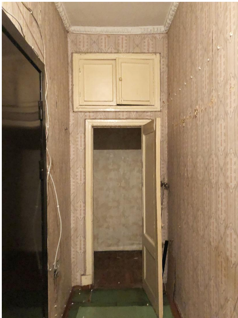
14. Коридор (помещение 16). Кладовка (помещение 2)
