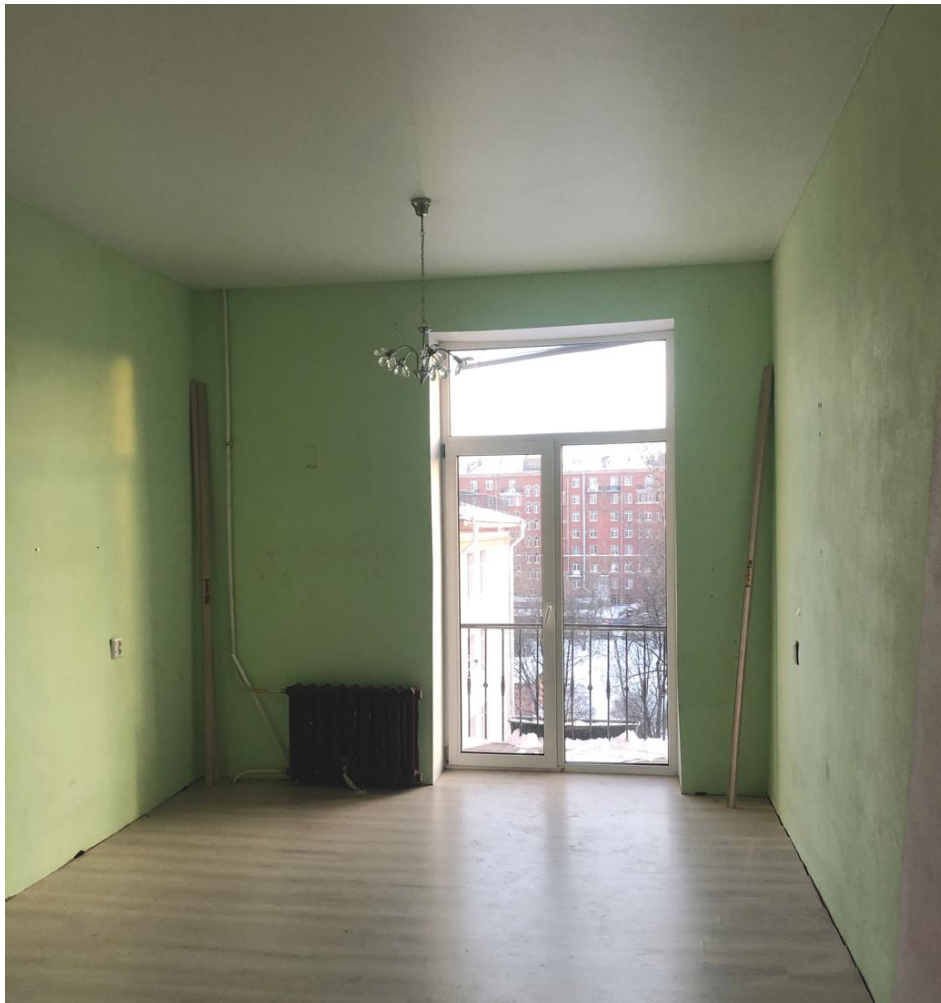
23. Комната (помещение 6). Вид в сторону окна.
