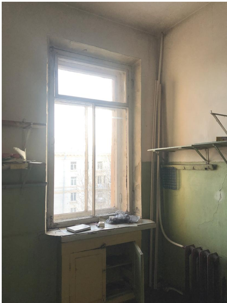
21. Кухня (помещение 5). Вид в сторону окна.
