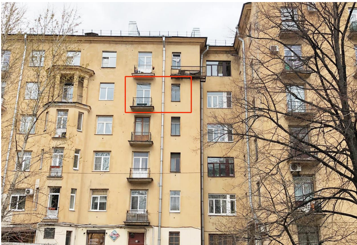
4. Фрагмент дворового фасада дома №20 по Ивановской улице. Отмечены окна квартиры №22.
