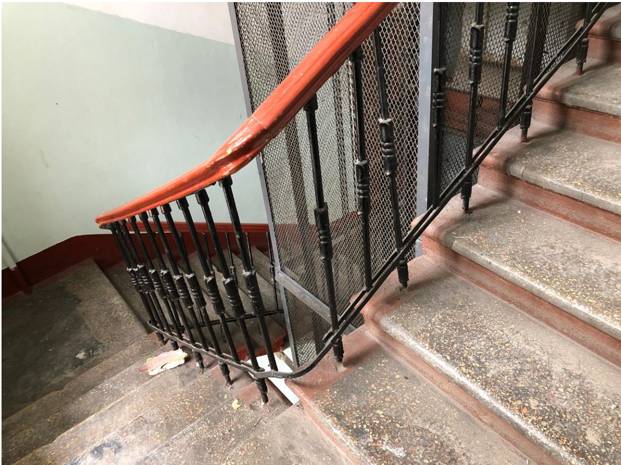
11. Ограждение и ступени лестницы.
