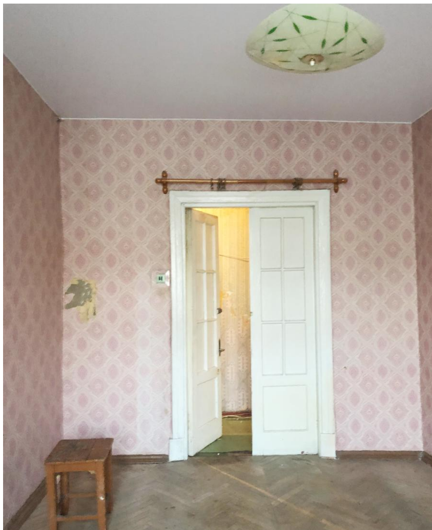
27. Комната (помещение 8). Вид в сторону коридора.
