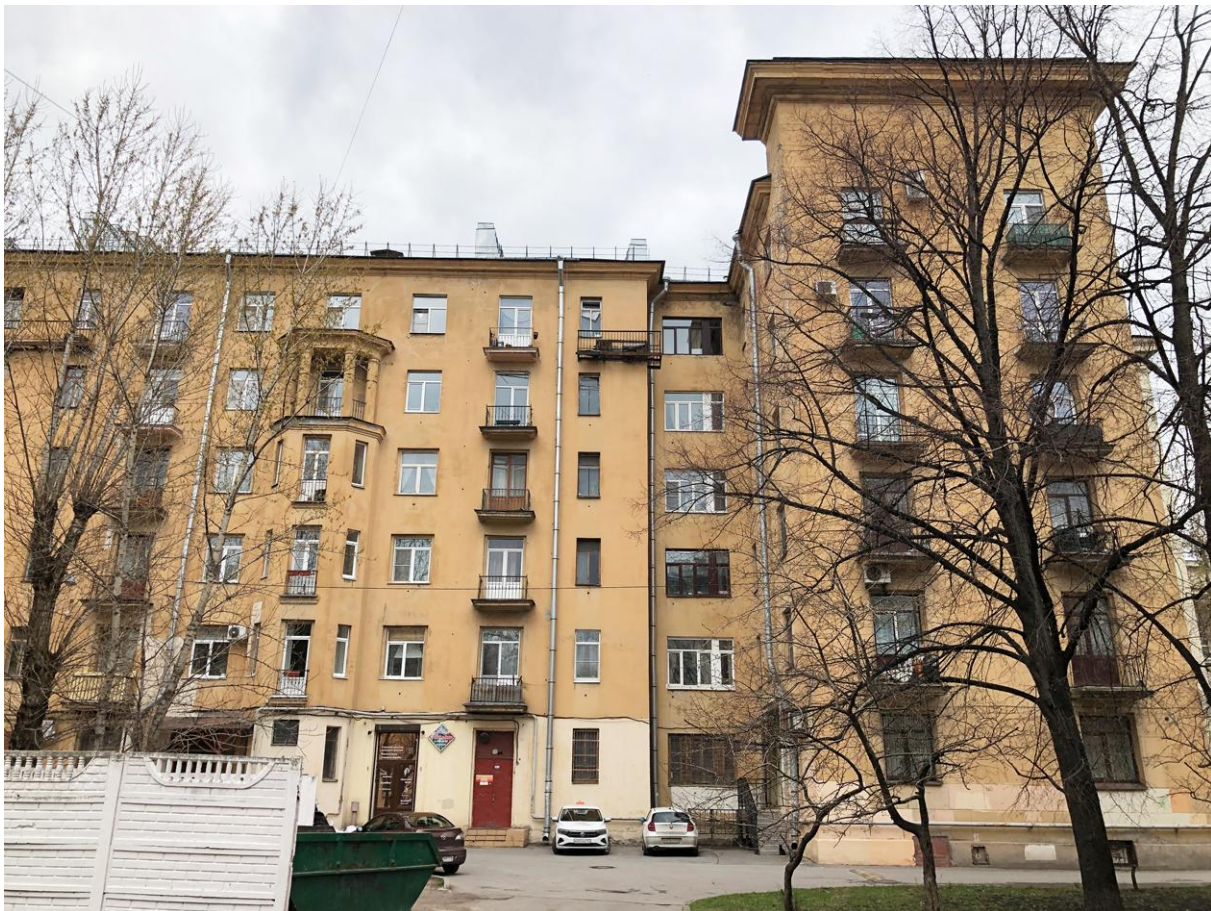
3. Часть дворового фасада (северо-восточная) дома №20 по Ивановской улице.
