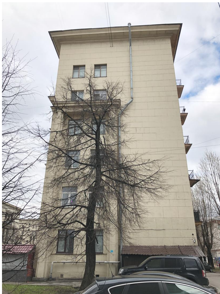
6. Торцевой фасад (юго-западный) дома №20 по Ивановской улице.
