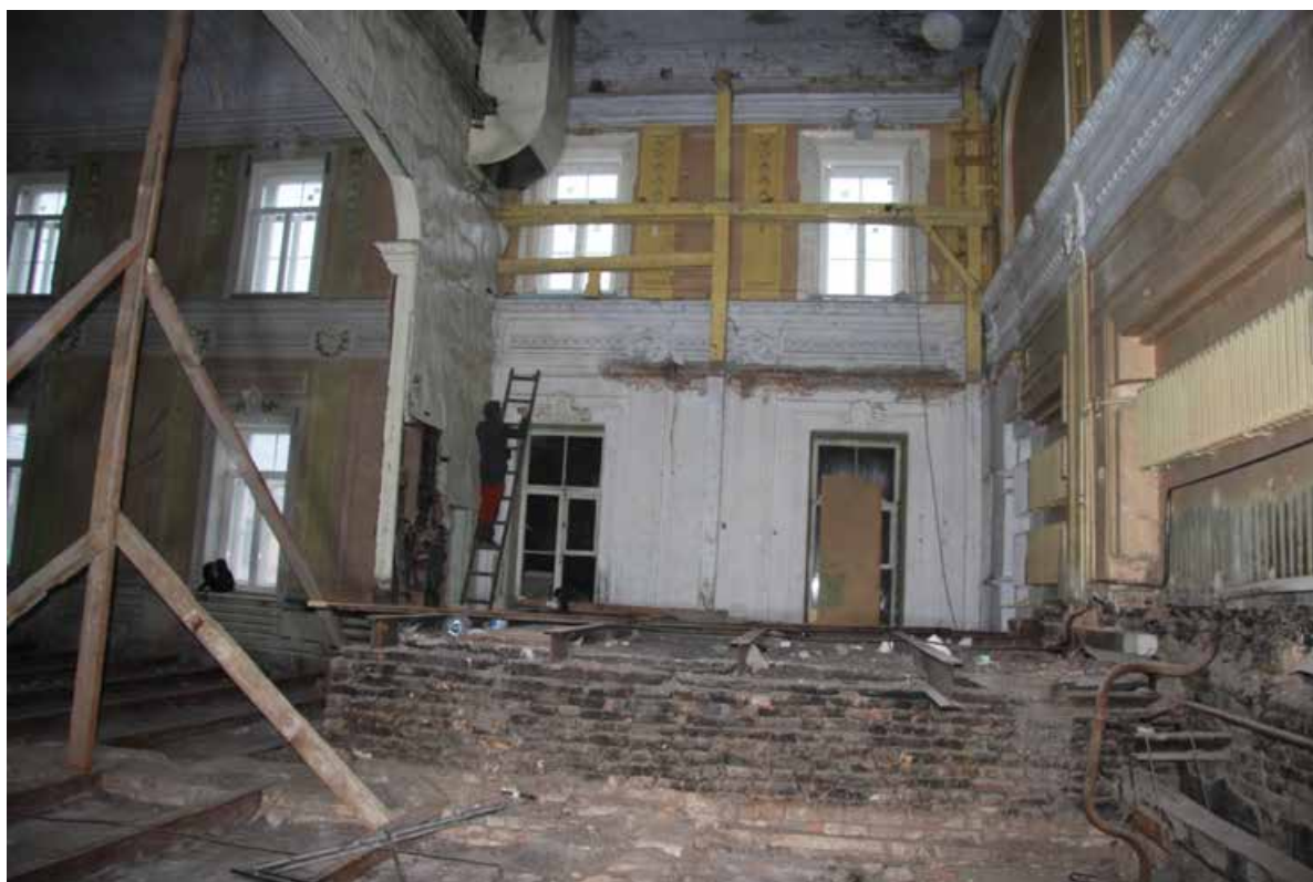
2.10. Вид на стену эстрады по ул. Велешинского. Объект культурного наследия регионального значения «Дом Никитина», расположенный по адресу: Санкт-Петербург, г. Кронштадт, пр. Ленина, дом 39а, литера А (г. Кронштадт, Ленина пр., 39). Дата съемки: 15.04.2022г.
