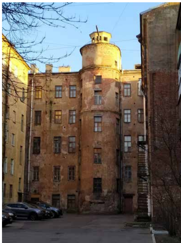
87. Дом Никитина со двора. Вид на главный корпус. 2020г. URL: https://www.citywalls.ru/ .
