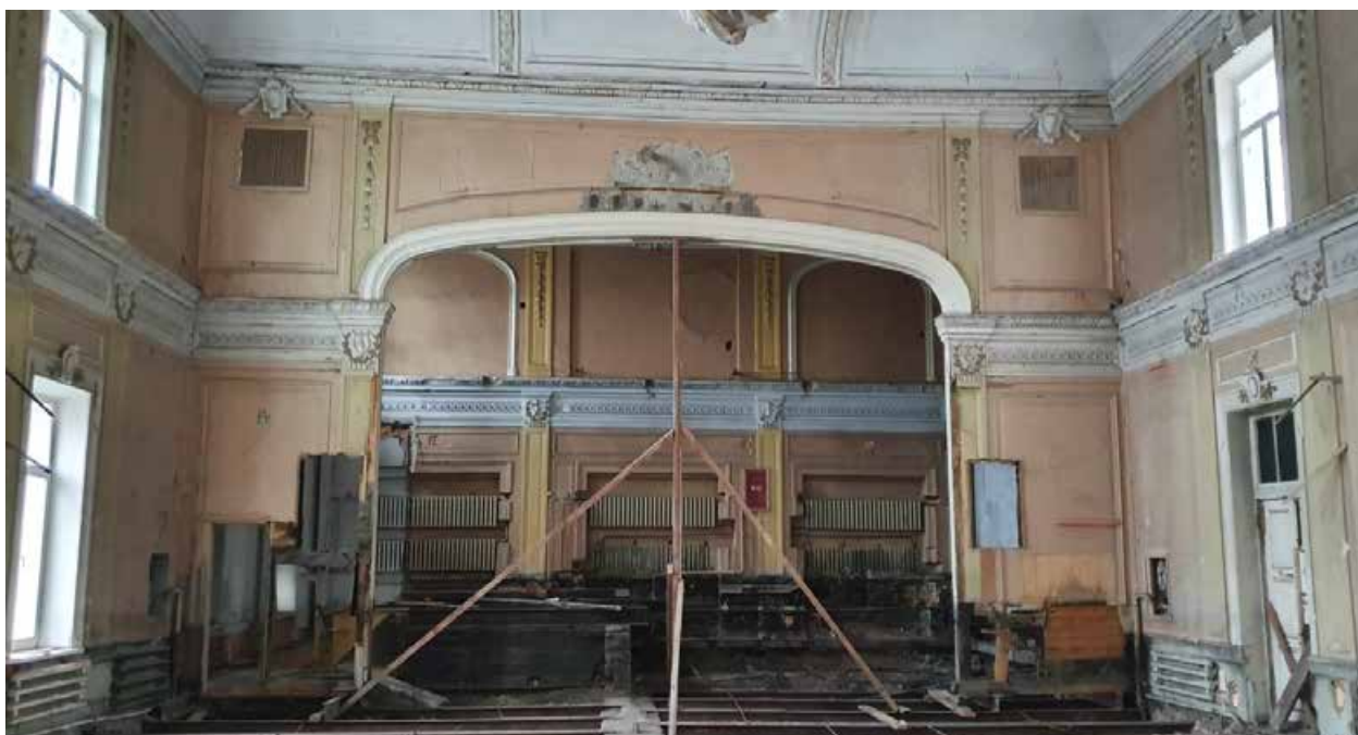
2.8. Общий вид на портал эстрады двухсветного зала. Объект культурного наследия регионального значения «Дом Никитина», расположенный по адресу: Санкт-Петербург, г. Кронштадт, пр. Ленина, дом 39а, литера А (г. Кронштадт, Ленина пр., 39). Дата съемки: 15.04.2022г.
