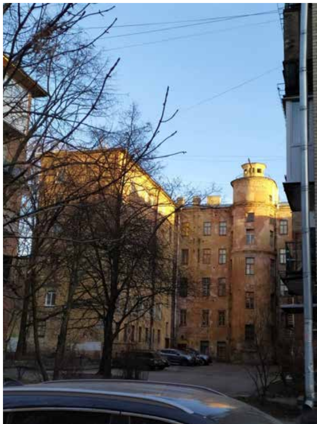
85. Дом Никитина со двора. Вид на главный корпус. 2020г. URL: https://www.citywalls.ru/ .
