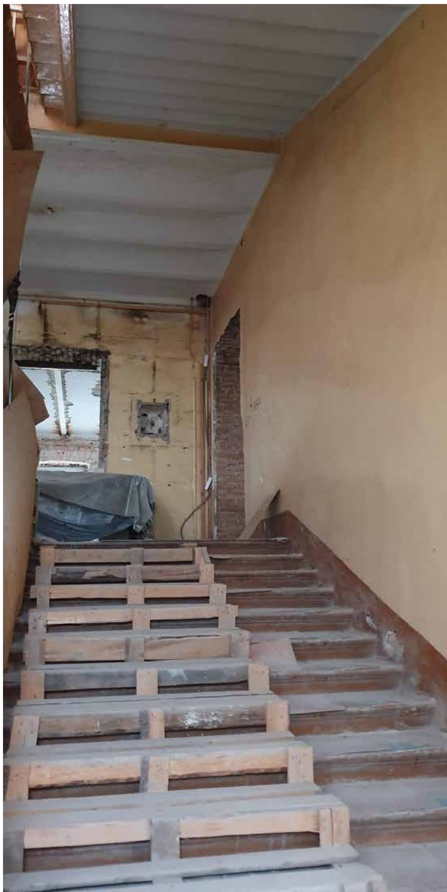
3.8. Вид на площадку четвёртого этажа. Объект культурного наследия регионального значения «Дом Никитина», расположенный по адресу: Санкт-Петербург, г. Кронштадт, пр. Ленина, дом 39а, литера А (г. Кронштадт, Ленина пр., 39). Дата съемки: 15.04.2022г.
