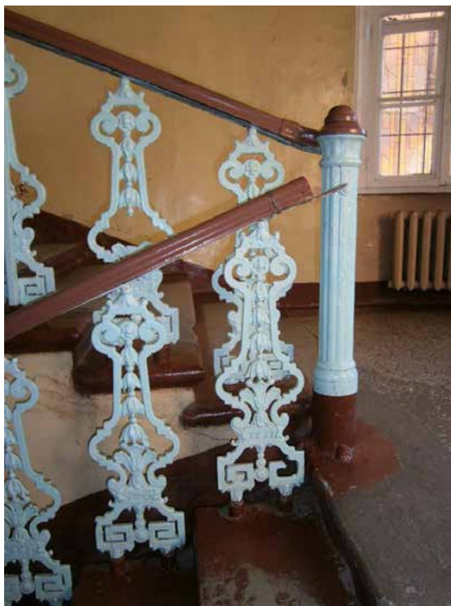
73. Главная лестница. Литые чугунные перила и кольца для прутков. 2013г. URL: https://www.citywalls.ru/ .
