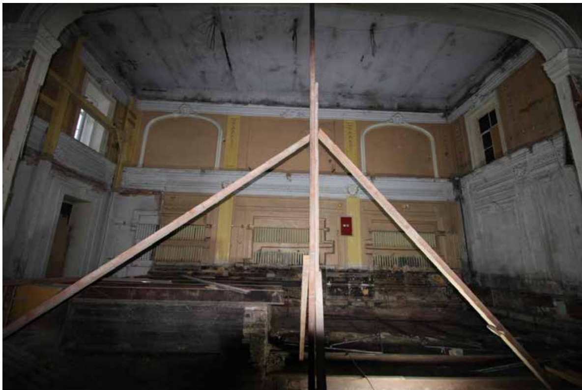
2.9. Общий вид на заднюю стену эстрады двухсветного зала. Объект культурного наследия регионального значения «Дом Никитина», расположенный по адресу: Санкт-Петербург, г. Кронштадт, пр. Ленина, дом 39а, литера А (г. Кронштадт, Ленина пр., 39). Дата съемки: 15.04.2022г.
