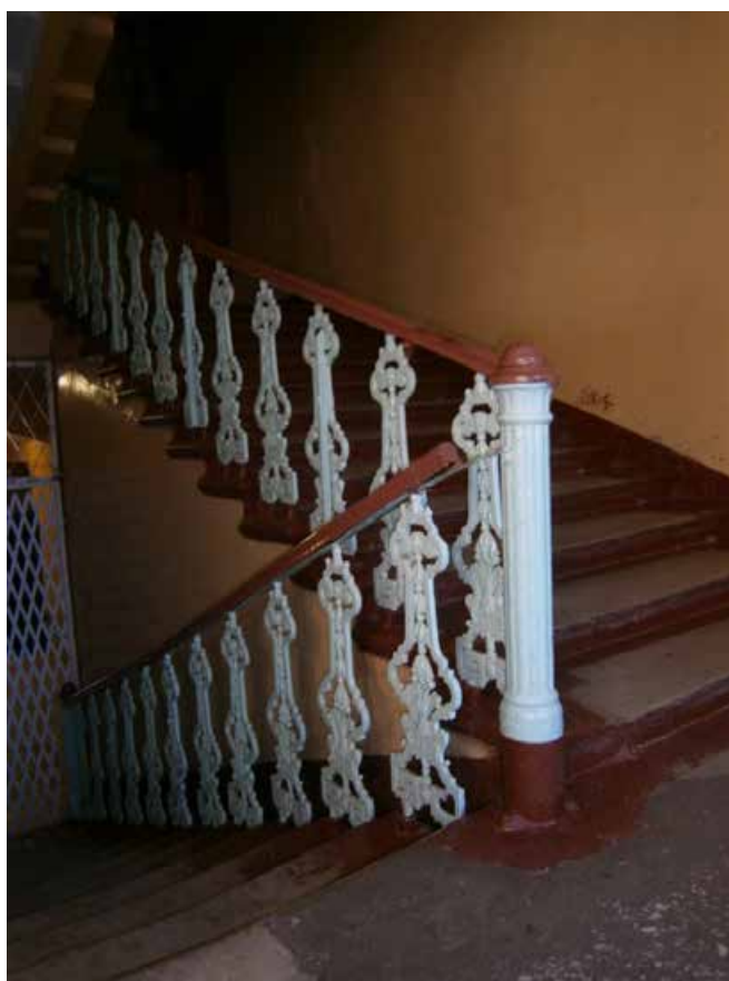
74. Главная лестница. Литые чугунные перила. 2013г. URL: https://www.citywalls.ru/ .
