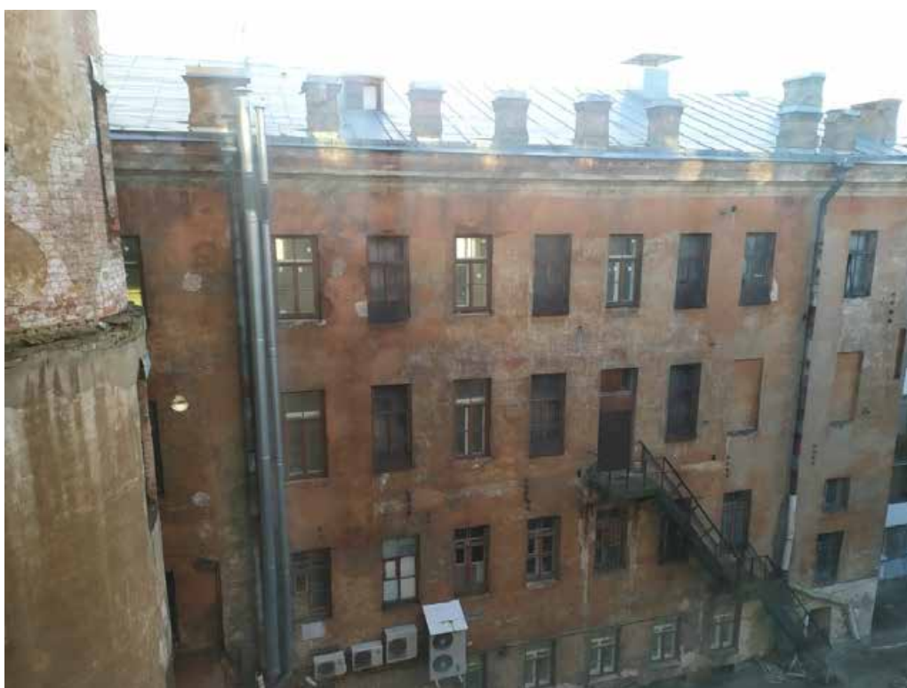
94. Дом Никитина со двора. Вид на корпус по ул. Велещинского. 2020г. URL: https://www.citywalls.ru/ .
