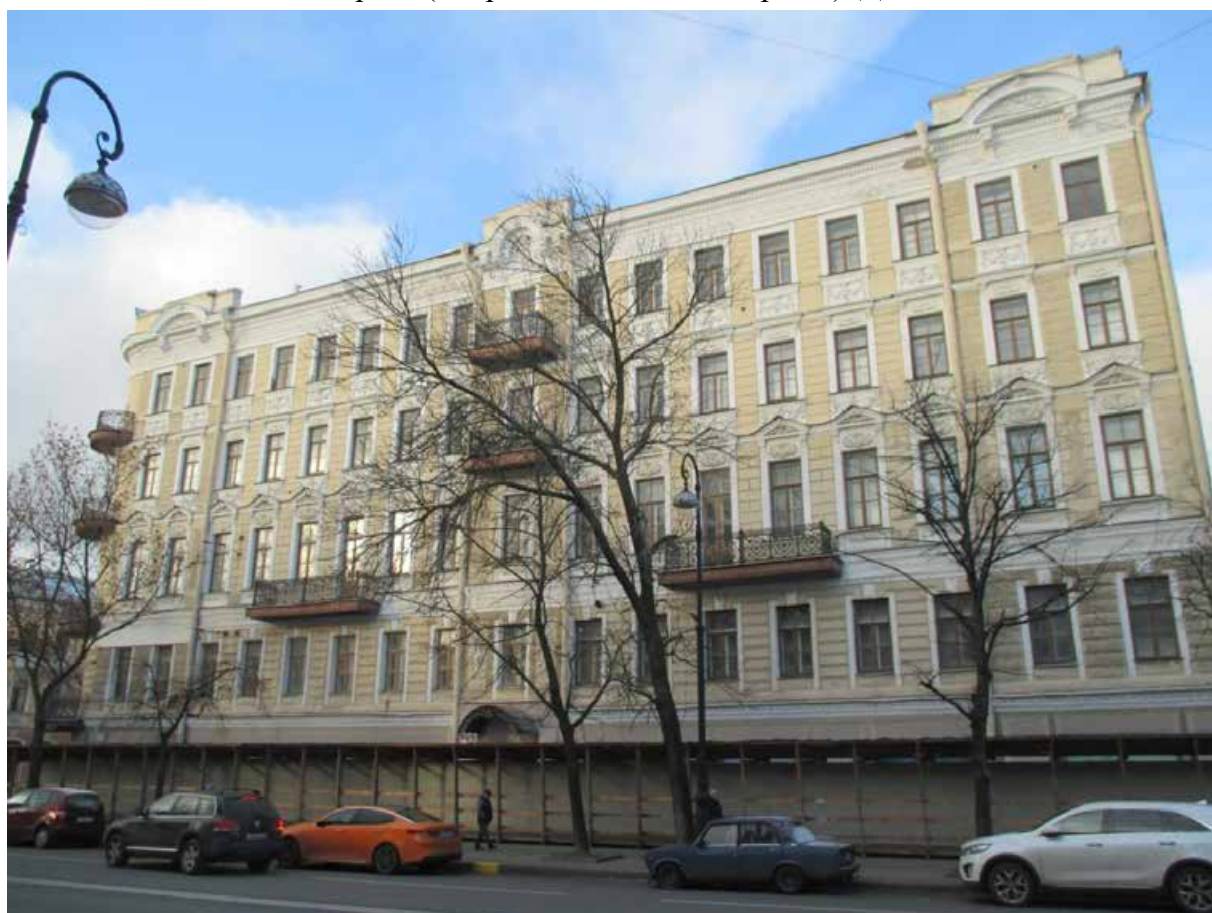
1.2. Общий вид на фасад с пр. Ленина. Объект культурного наследия регионального значения «Дом Никитина», расположенный по адресу: Санкт-Петербург, г. Кронштадт, пр. Ленина, дом 39а, литера А (г. Кронштадт, Ленина пр., 39). Дата съемки: 15.04.2022г.
