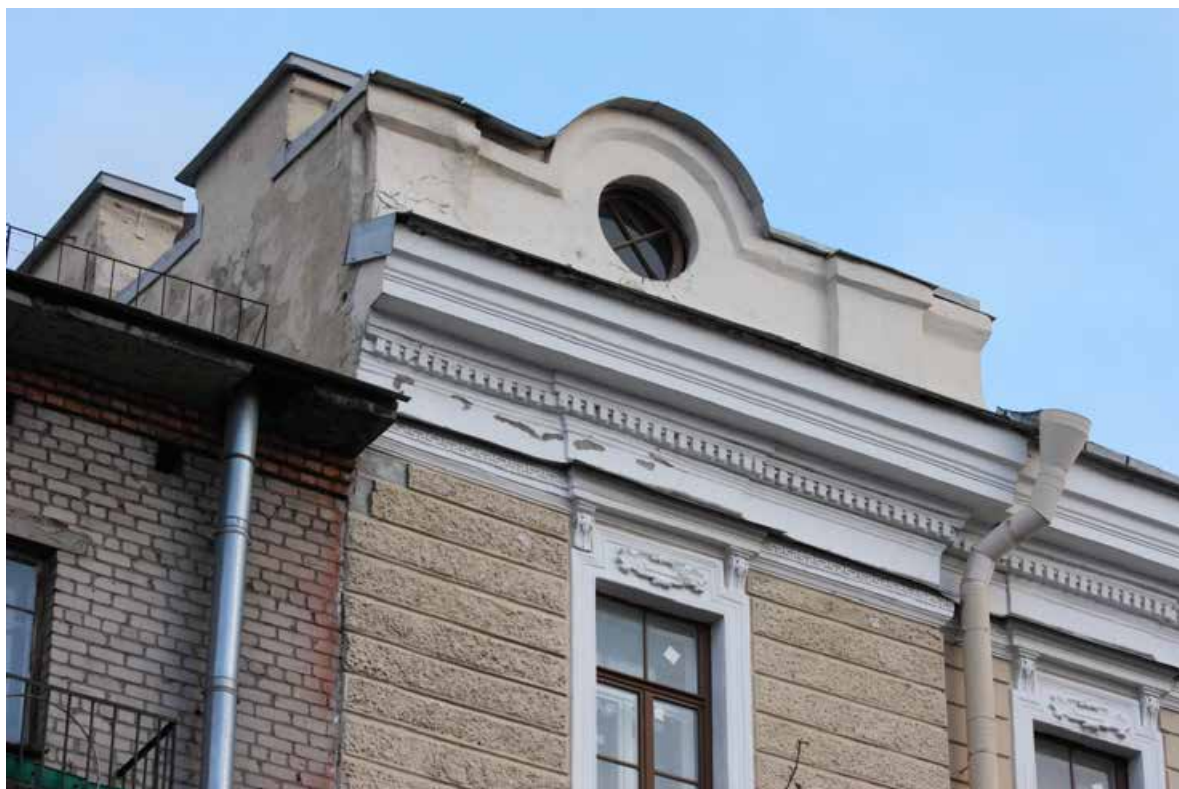
1.7. Вид на окно-люкарну по ул. Велещинского. Объект культурного наследия регионального значения «Дом Никитина», расположенный по адресу: Санкт-Петербург, г. Кронштадт, пр. Ленина, дом 39а, литера А (г. Кронштадт, Ленина пр., 39). Дата съемки: 15.04.2022г.
