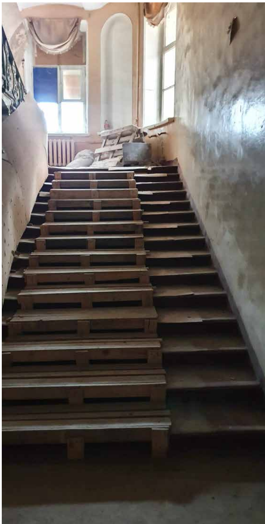
3.4. Вид на промежуточную площадку второго и третьего этажей. Объект культурного наследия регионального значения «Дом Никитина», расположенный по адресу: Санкт-Петербург, г. Кронштадт, пр. Ленина, дом 39а, литера А (г. Кронштадт, Ленина пр., 39). Дата съемки: 15.04.2022г.
