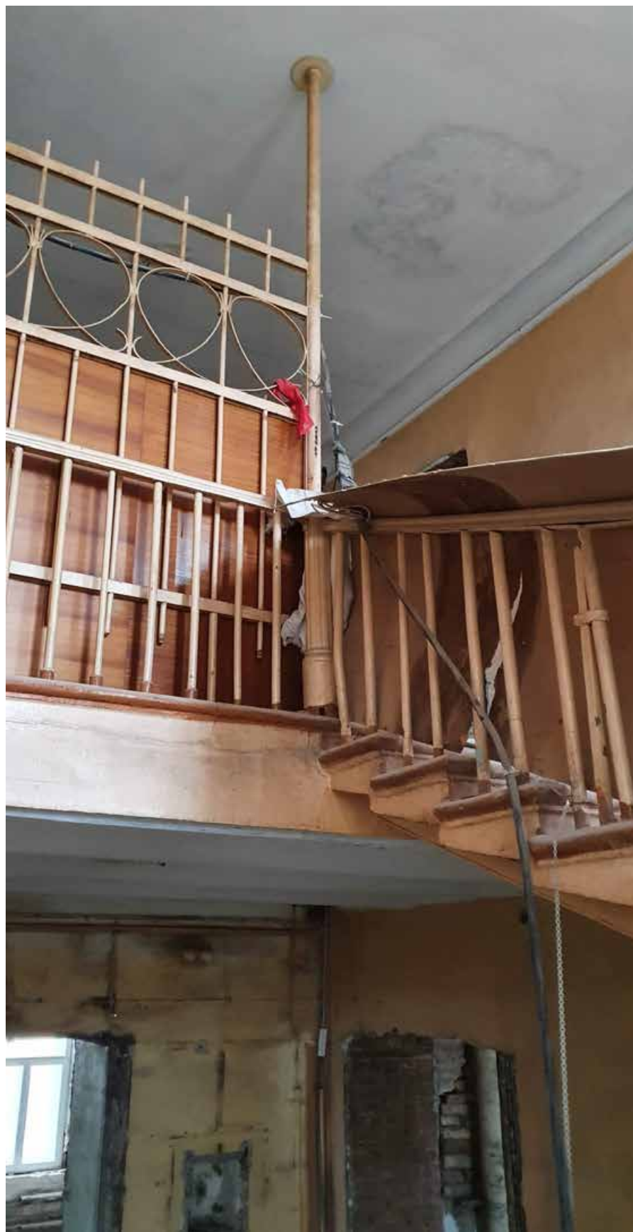
3.10. Вид на площадку пятого этажа. Объект культурного наследия регионального значения «Дом Никитина», расположенный по адресу: Санкт-Петербург, г. Кронштадт, пр. Ленина, дом 39а, литера А (г. Кронштадт, Ленина пр., 39). Дата съемки: 15.04.2022г.
