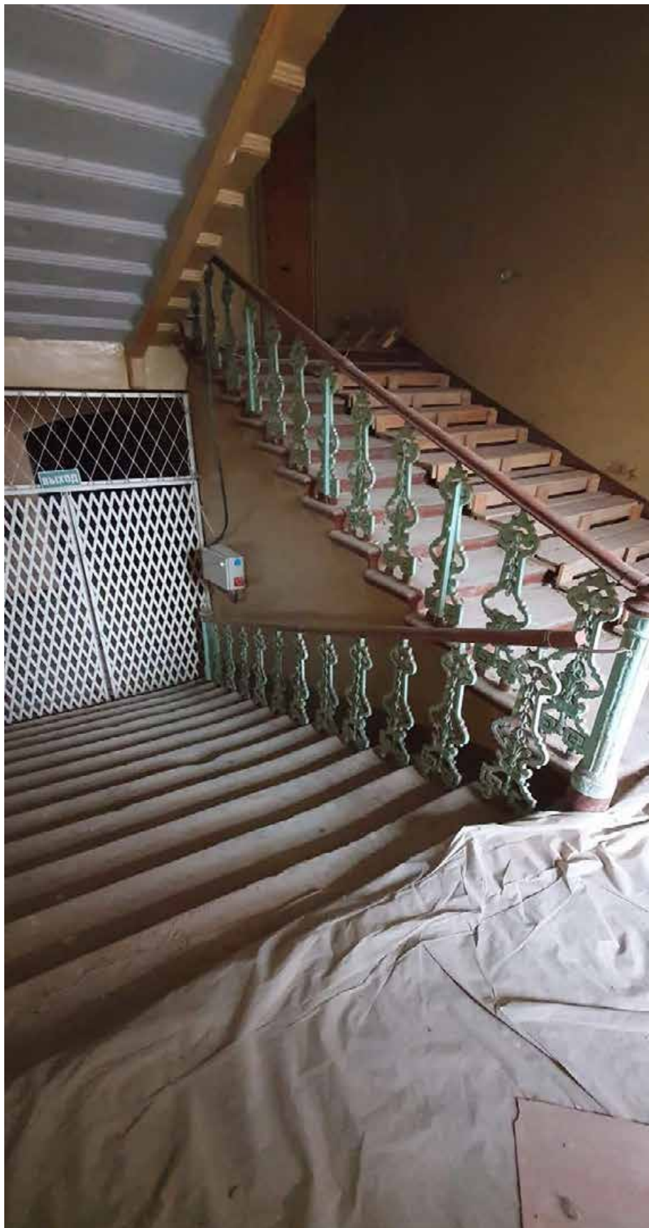
3.2. Вид на уровень первого этажа. Объект культурного наследия регионального значения «Дом Никитина», расположенный по адресу: Санкт-Петербург, г. Кронштадт, пр. Ленина, дом 39а, литера А (г. Кронштадт, Ленина пр., 39). Дата съемки: 15.04.2022г.
