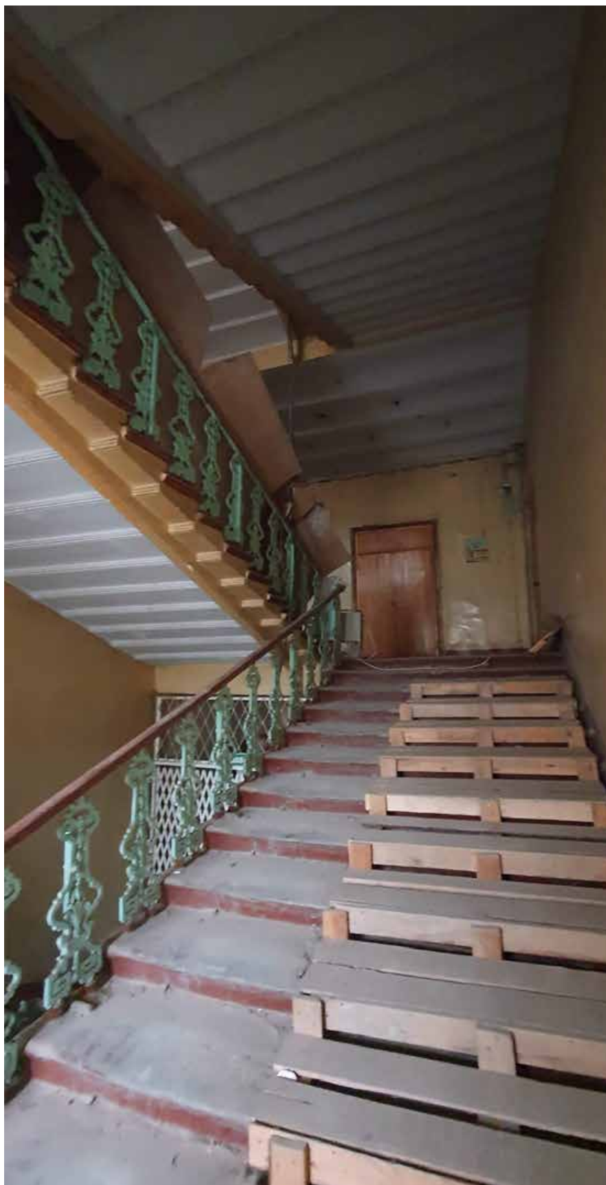
3.3. Вид на площадку второго этажа. Объект культурного наследия регионального значения «Дом Никитина», расположенный по адресу: Санкт-Петербург, г. Кронштадт, пр. Ленина, дом 39а, литера А (г. Кронштадт, Ленина пр., 39). Дата съемки: 15.04.2022г.
