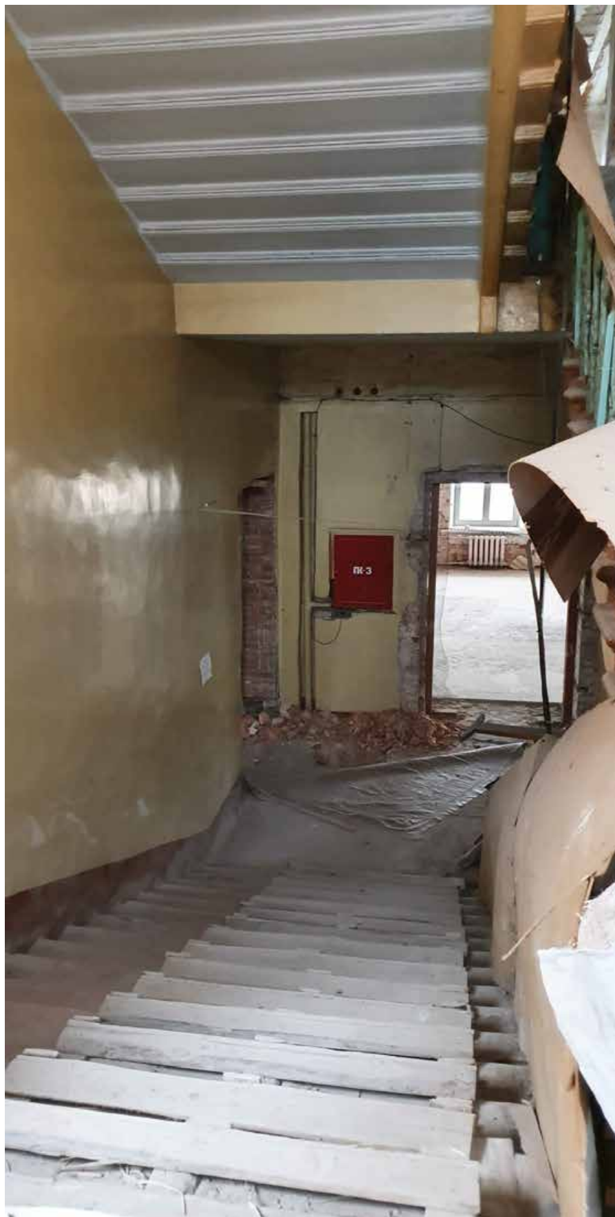
3.7. Вид на площадку третьего этажа. Объект культурного наследия регионального значения «Дом Никитина», расположенный по адресу: Санкт-Петербург, г. Кронштадт, пр. Ленина, дом 39а, литера А (г. Кронштадт, Ленина пр., 39). Дата съемки: 15.04.2022г.
