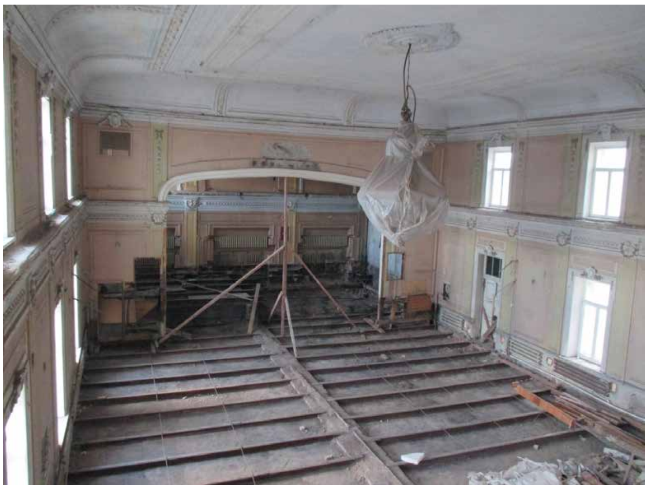
2.2. Общий вид на двухсветный зал со второго яруса. Объект культурного наследия регионального значения «Дом Никитина», расположенный по адресу: Санкт-Петербург, г. Кронштадт, пр. Ленина, дом 39а, литера А (г. Кронштадт, Ленина пр., 39). Дата съемки: 15.04.2022г.
