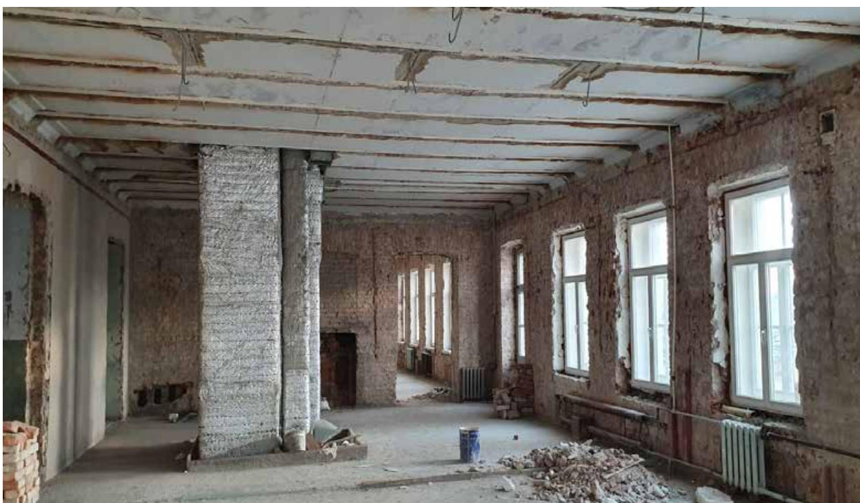
4.10. Зал четвёртого этажа по пр. Ленина. Объект культурного наследия регионального значения «Дом Никитина», расположенный по адресу: Санкт-Петербург, г. Кронштадт, пр. Ленина, дом 39а, литера А (г. Кронштадт, Ленина пр., 39). Дата съемки: 15.04.2022г.
