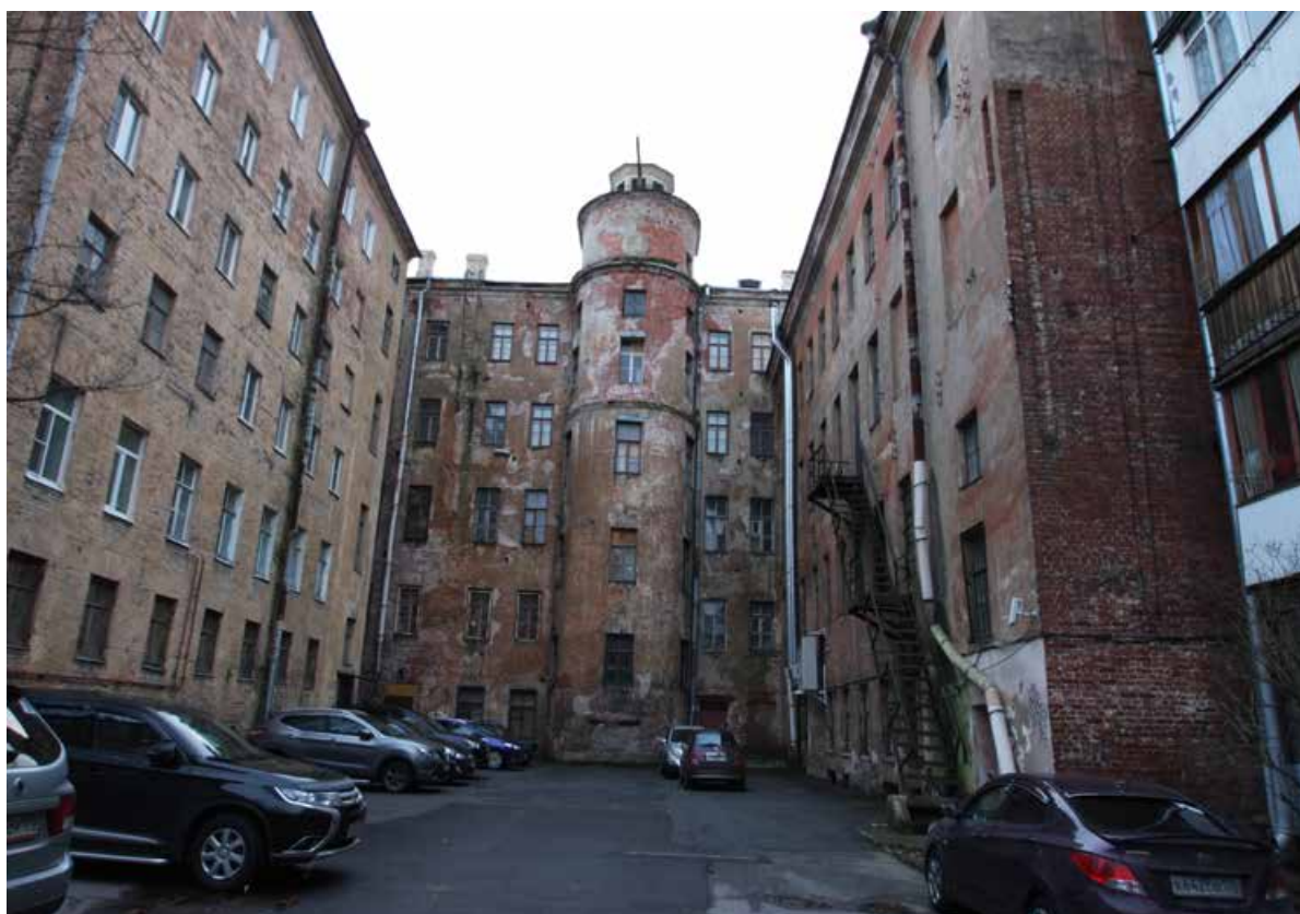
1.12. Общий вид на дворовые фасады. Объект культурного наследия регионального значения «Дом Никитина», расположенный по адресу: Санкт-Петербург, г. Кронштадт, пр. Ленина, дом 39а, литера А (г. Кронштадт, Ленина пр., 39). Дата съемки: 15.04.2022г.
