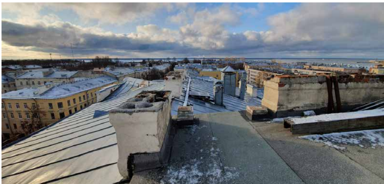
1.18. Вид на крышу угловой части здания. Объект культурного наследия регионального значения «Дом Никитина», расположенный по адресу: Санкт-Петербург, г. Кронштадт, пр. Ленина, дом 39а, литера А (г. Кронштадт, Ленина пр., 39). Дата съемки: 15.04.2022г.
