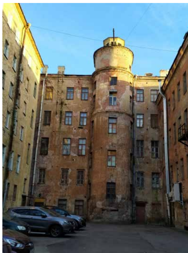
88. Дом Никитина со двора. Вид на главный корпус. 2020г. URL: https://www.citywalls.ru/ .
