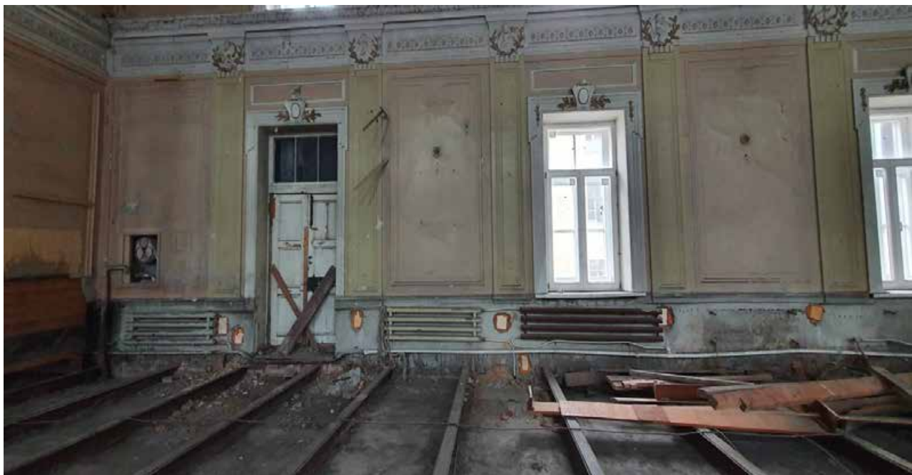
2.3. Вид на стену по дворовому фасаду. Объект культурного наследия регионального значения «Дом Никитина», расположенный по адресу: Санкт-Петербург, г. Кронштадт, пр. Ленина, дом 39а, литера А (г. Кронштадт, Ленина пр., 39). Дата съемки: 15.04.2022г.
