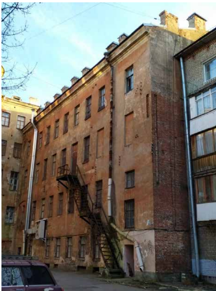
89. Дом Никитина со двора. Вид на корпус по ул. Велещинского. 2020г. URL: https://www.citywalls.ru/ .
