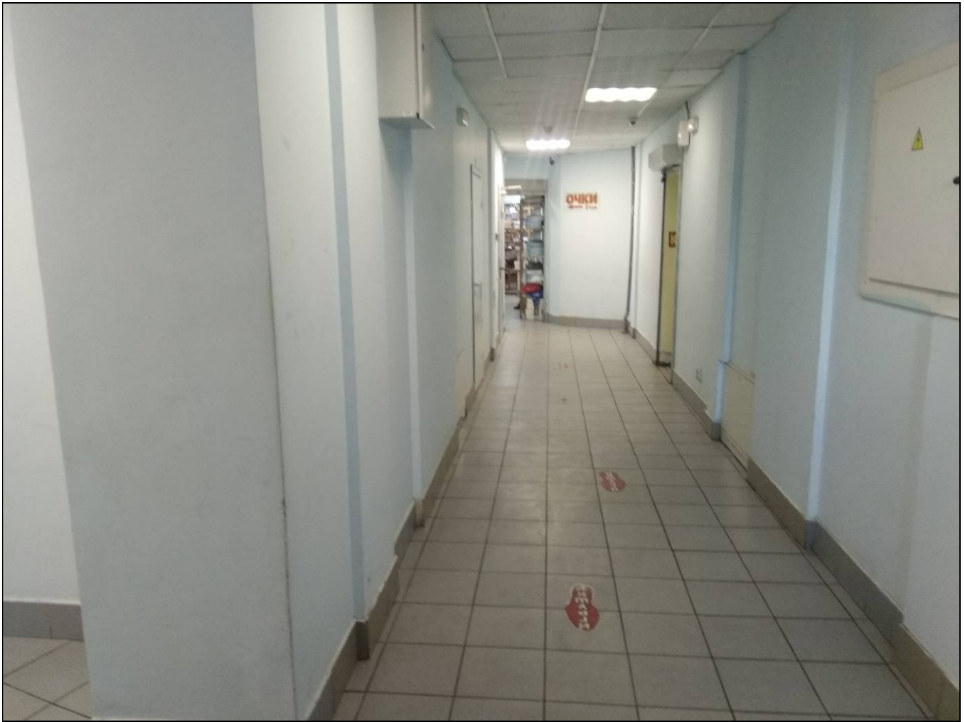
10. Корпус 15, литера К15, пом. 3-Н. Второй этаж. Фрагмент интерьера в зоне планируемых работ.*
