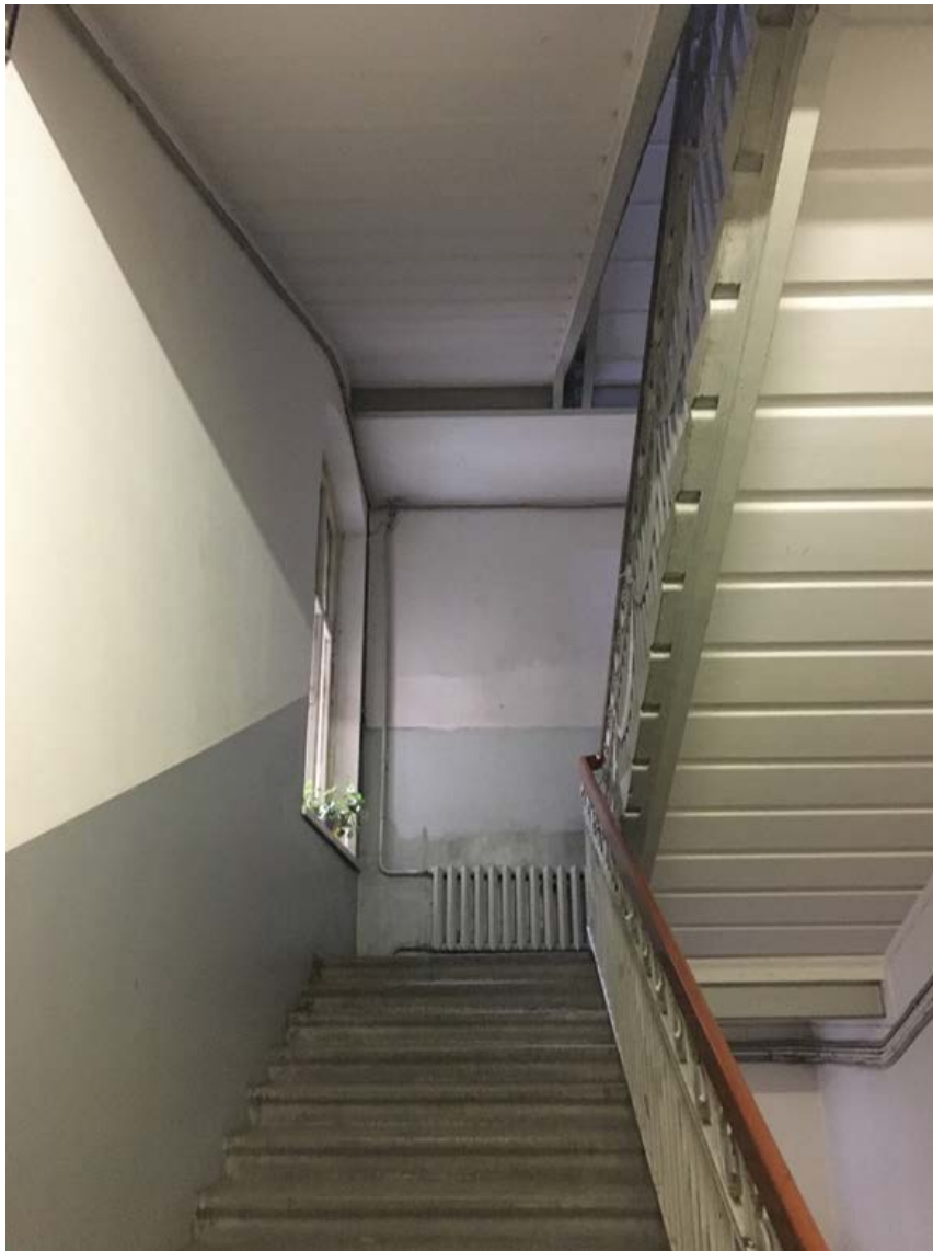
21. Парадная лестница 1ЛК. Общий вид.
