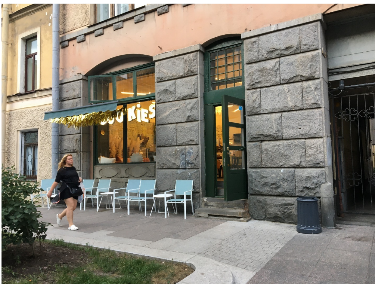
8. Лицевой фасад. Фрагмент.
