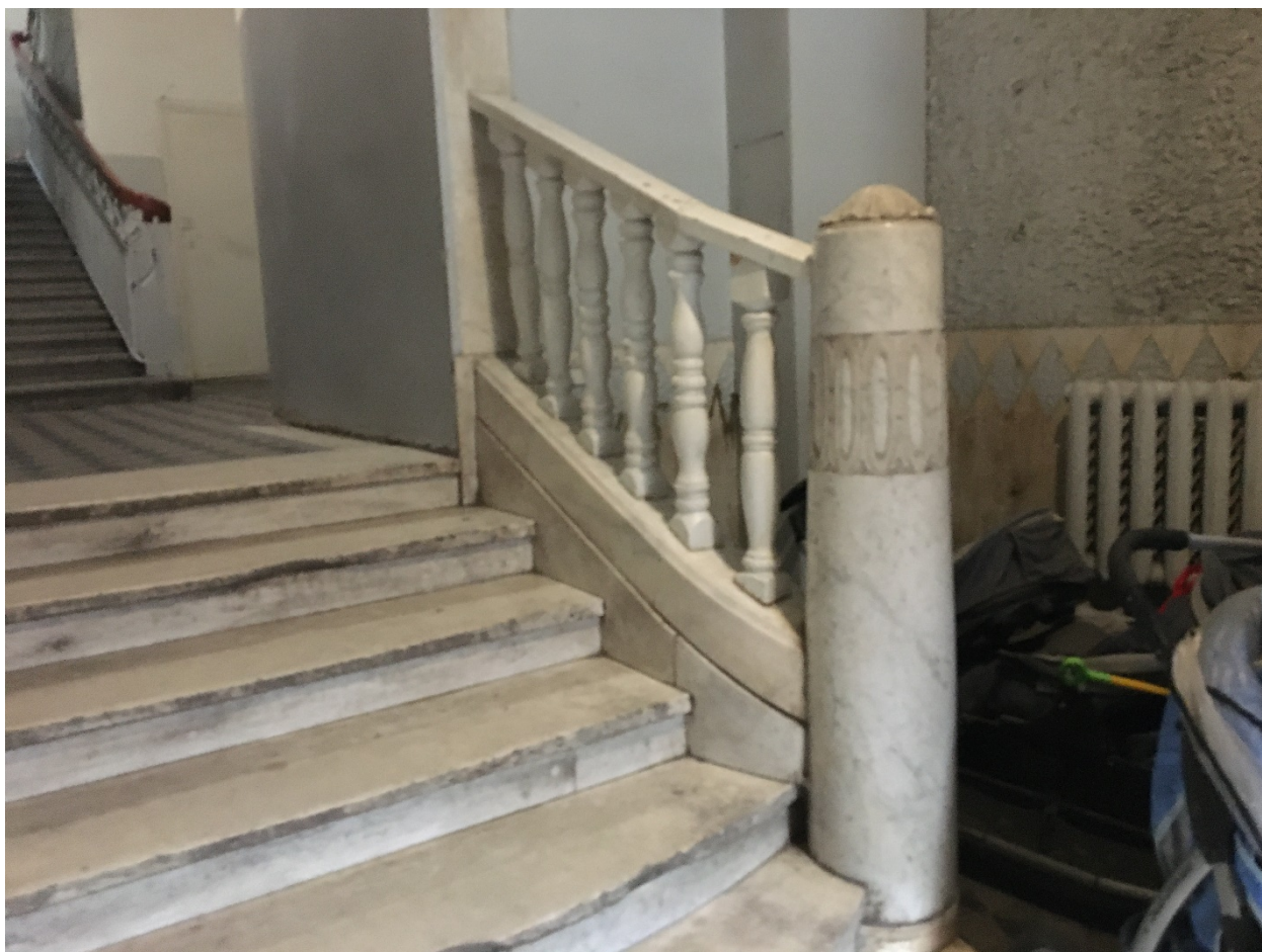
15. Парадная лестница 1ЛК. Ограждение лестницы вестибюля.
