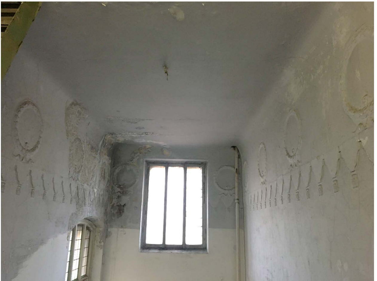
23. Парадная лестница 1ЛК. Перекрытие объема лестницы.
