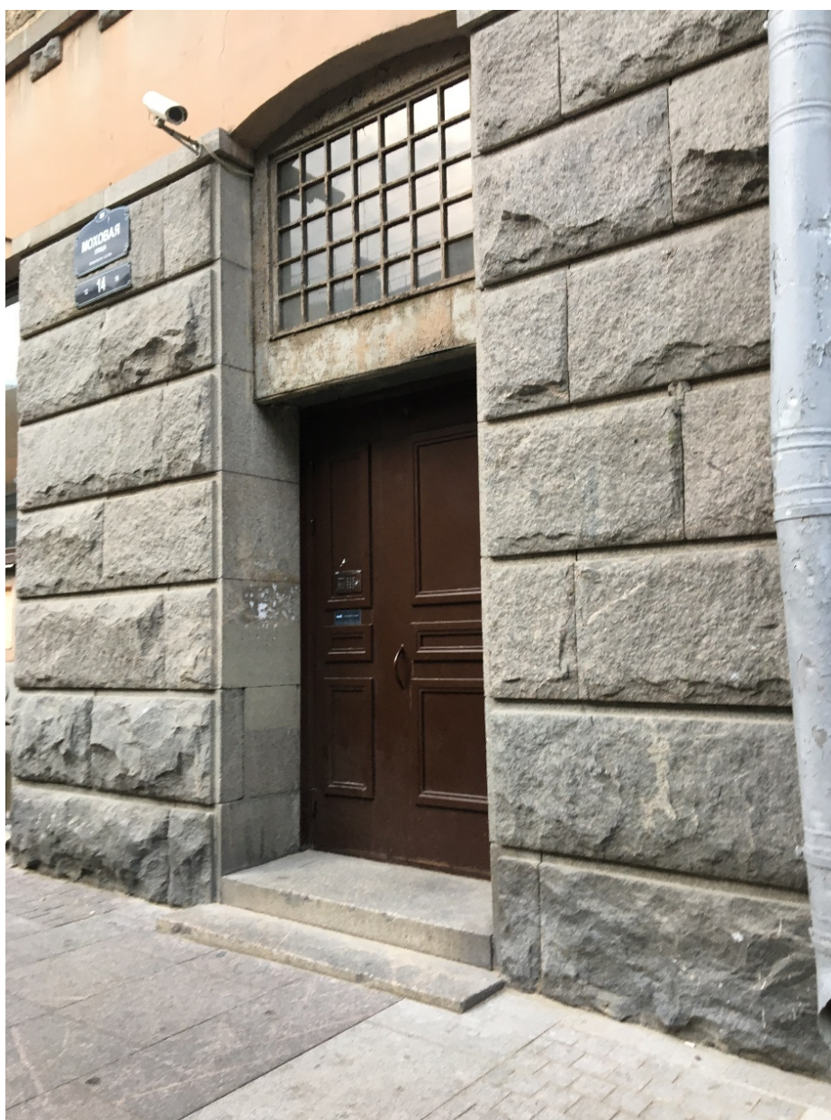
6. Лицевой фасад выявленного объекта культурного наследия «Дом О.И. Либих», расположенного по адресу: г. Санкт-Петербург, Моховая ул., д. 14. Фрагмент
