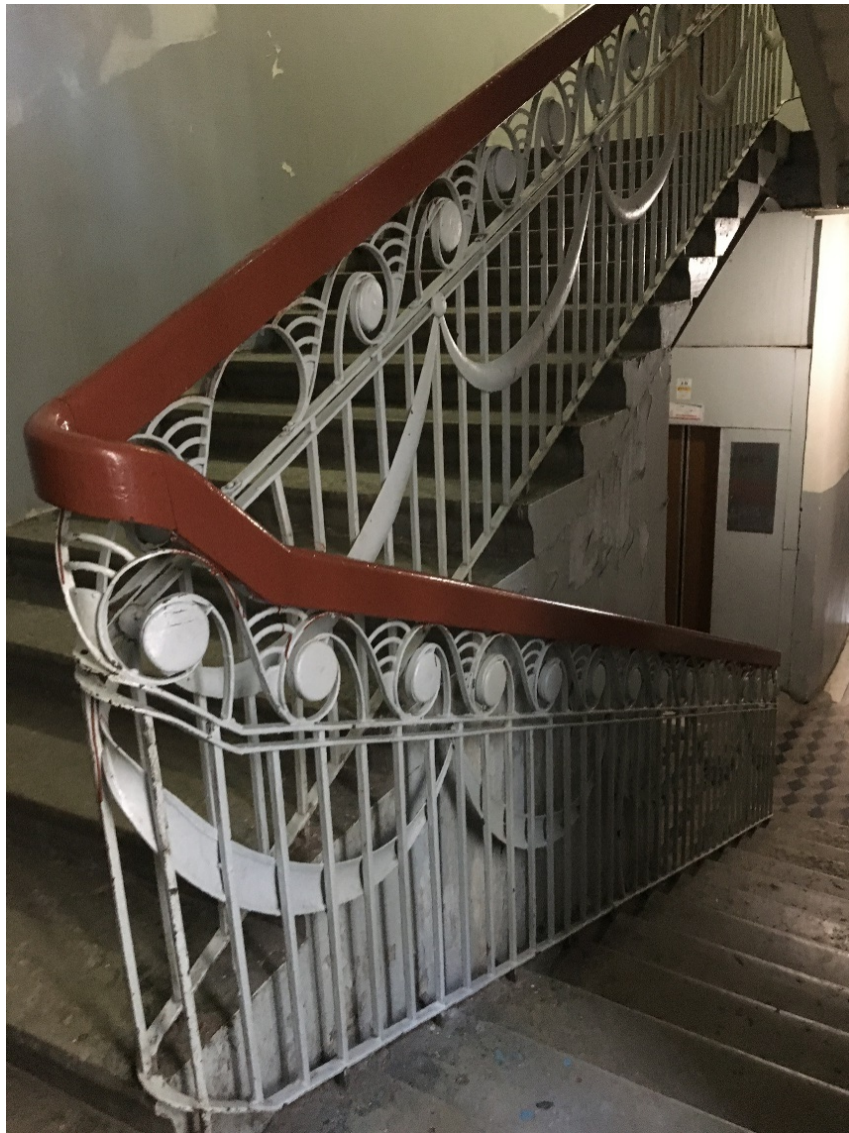
18. Парадная лестница 1ЛК. Ограждения лестницы.
