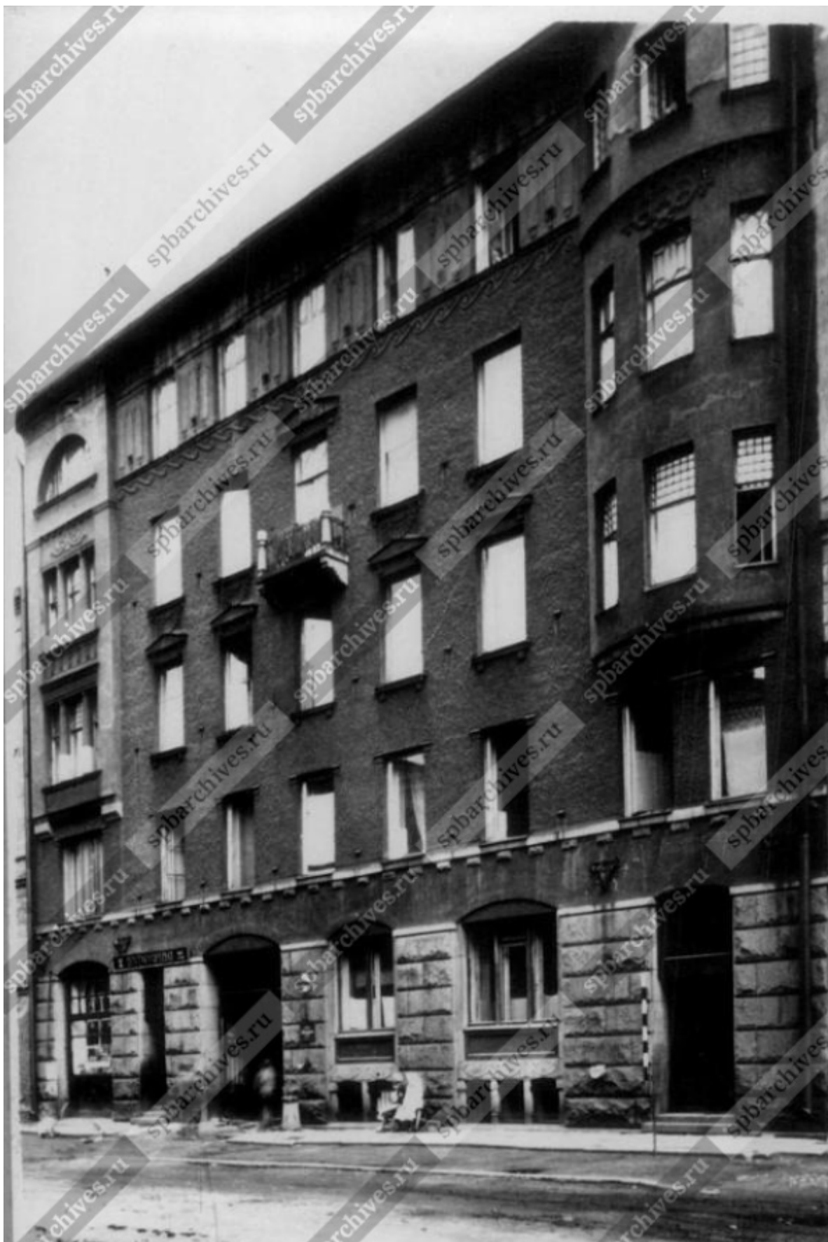
5. ЦГА КФФД СПб Гр 75403 1960 г. Вид фасада дома №14 на Моховой улице. Ленинград.
