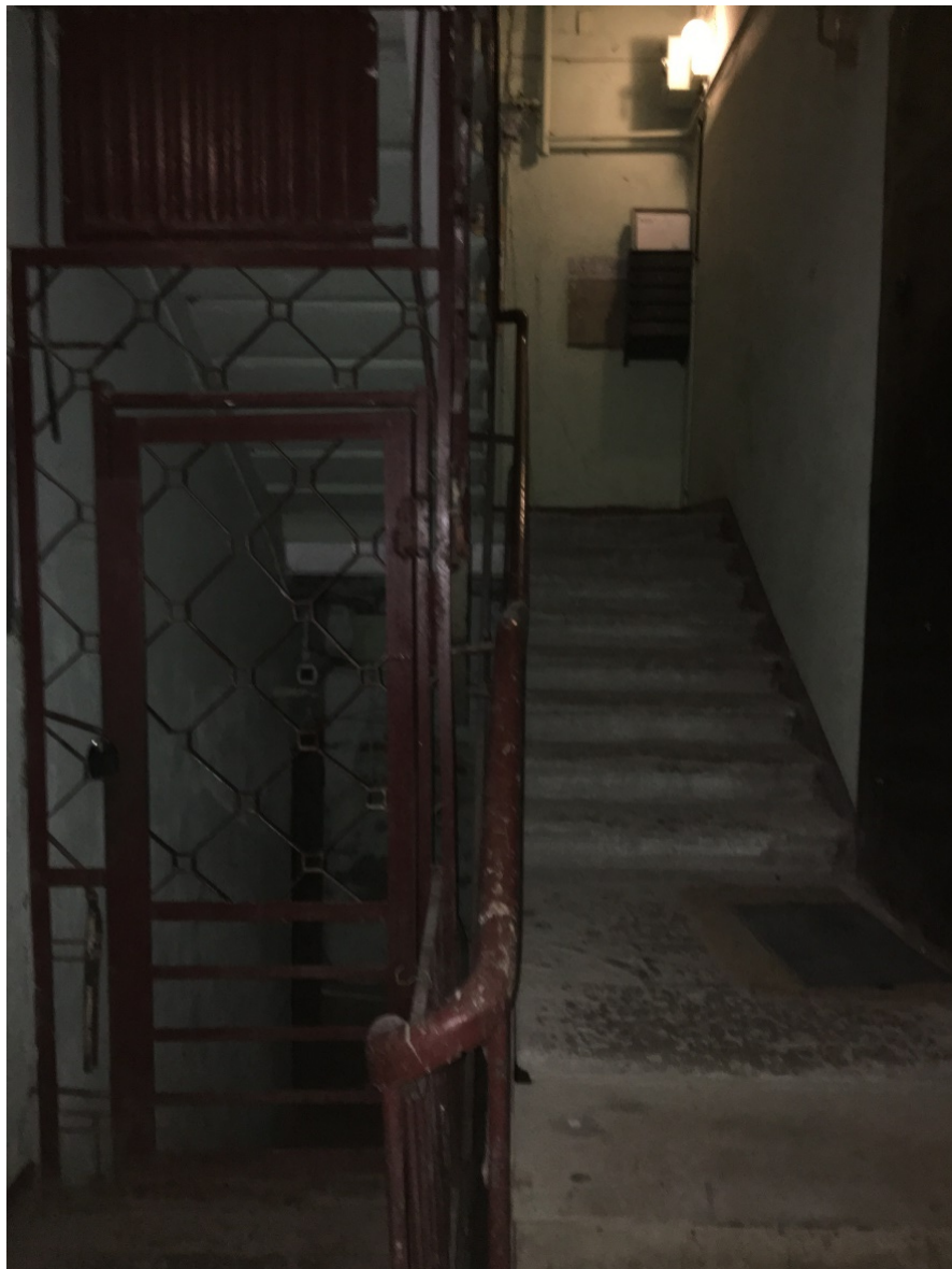
25. Лестница 2ЛК. Площадка 1 этажа.
