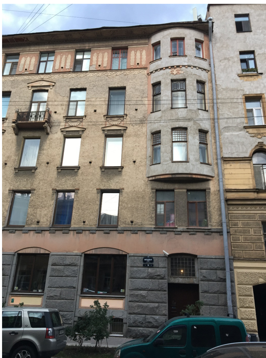
4. Лицевой фасад выявленного объекта культурного наследия «Дом О.И. Либих», расположенного по адресу: г. Санкт-Петербург, Моховая ул., д. 14.
