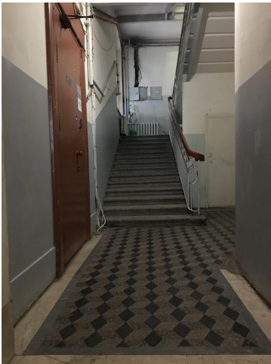
17. Парадная лестница 1ЛК. Площадка 1 этажа.
