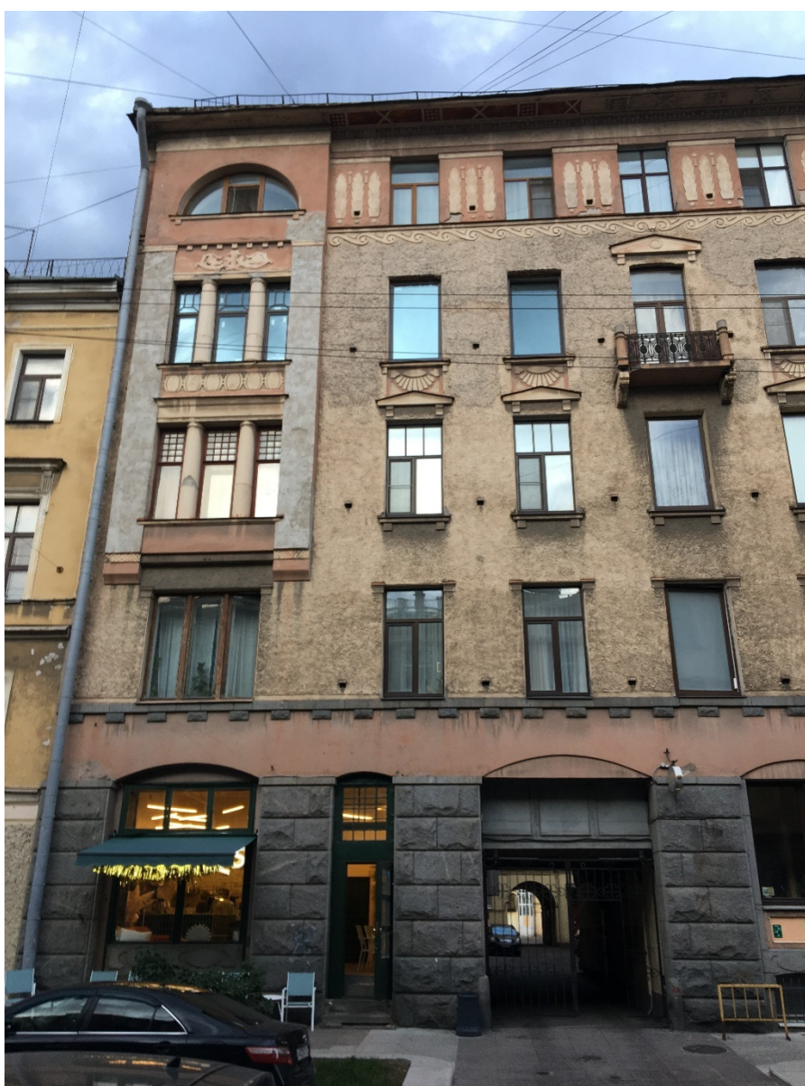
5. Лицевой фасад выявленного объекта культурного наследия «Дом О.И. Либих», расположенного по адресу: г. Санкт-Петербург, Моховая ул., д. 14.
