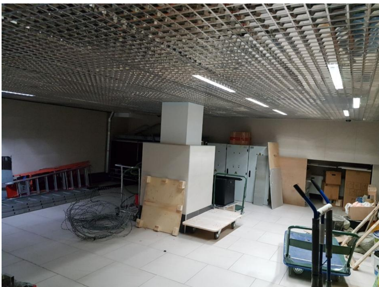
31. ОКН регионального значения «Международный коммерческий банк» по адресу г. Санкт-Петербург, Невский проспект, д.58, литера А. Подвальное помещение
