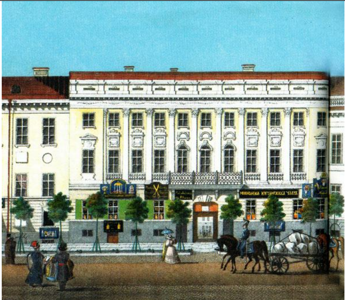
2. Здание на Невском пр., 58. 1830-е гг. В.С.Садовников. Панорама Невского проспекта . Фрагмент.
