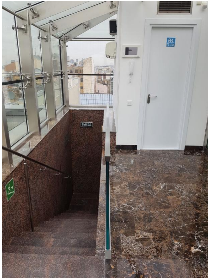
67. ОКН регионального значения «Международный коммерческий банк» по адресу г. Санкт-Петербург, Невский проспект, д.58, литера А. Помещение 5 этажа.
