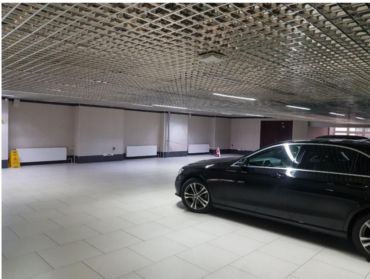
12. ОКН регионального значения «Международный коммерческий банк» по адресу г. Санкт-Петербург, Невский проспект, д.58, литера А. Помещение 1 этажа.
