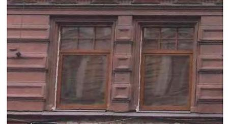
междуэтажный профилированный карниз, фриз с каннелированными метопами и брильянтовым рустом - между 2-м и 3-м этажами;
