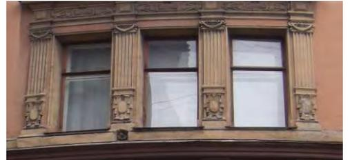
профилированные наличники оконных проемов 4-го этажа; каннелированные пилястры с капителями ионического ордера - в простенках между оконных проемов; подоконный орнаментированный фриз с композициями из львиных маскаронов;
