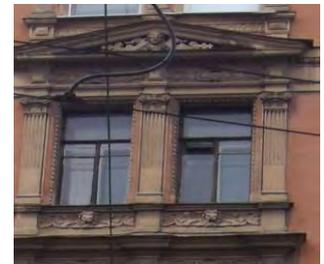
профилированные наличники оконных проемов 5-го этажа; пилястры с капителями ионического ордера, декором из пальметт и лавровых гирлянд - в простенках между оконных проемов; подоконный орнаментированный фриз;
