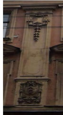
профилированный междуэтажный карниз с пояском из иоников - между 4-м и 5-м этажами;
