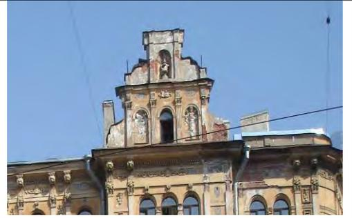
атиковый объем – местоположение (над уплощенным ризалитом), конфигурация, габариты; профилированная аттиковая стенка, две люкарны с лучковым завершением;
