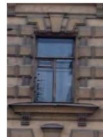
профилированные наличники, горизонтальные филенки с лепным декором над оконными перемычками, лучковые разорванные сандрики с львиным горельефным изображением в тимпане, филенки с декором из пальметт в подоконном пространстве оконных проемов 3-го этажа;
