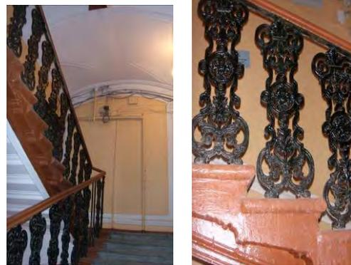
парадная лестница (по 6-й оси восточного лицевого фасада по просп. Бакунина) - местоположение, габариты, конфигурация (маршевая с поворотом), материал (каменная), ступени из лещадной плиты;
