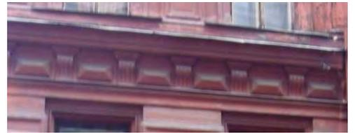
профилированные наличники оконных проемов 3-го этажа; каннелированные пилястры с капителями дорического ордера и картушами - в простенках между оконных проемов; орнаментированный фриз над оконными перемычками 3-го этажа;
