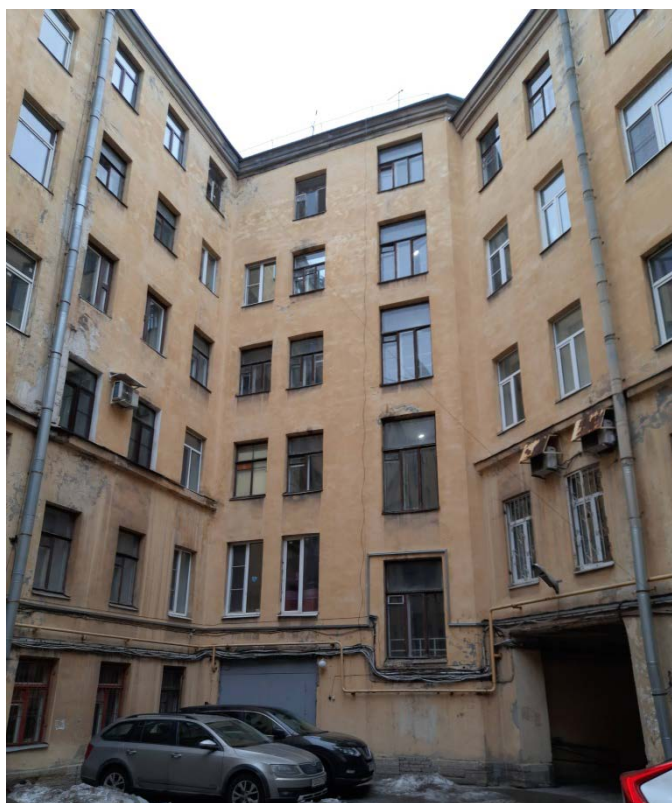
Фото 8 Фрагмент дворового фасада выявленного объекта культурного наследия «Дом Р.С.Грובה» по адресу: Санкт-Петербург, Марата ул., д. 55/5, лит. А
