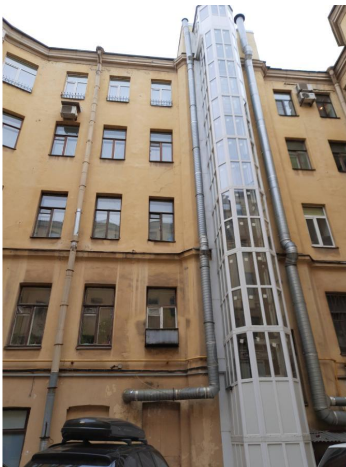
Фото 7 Фрагмент дворового фасада выявленного объекта культурного наследия «Дом Р.С.Грובה» по адресу: Санкт-Петербург, Марата ул., д. 55/5, лит. А
