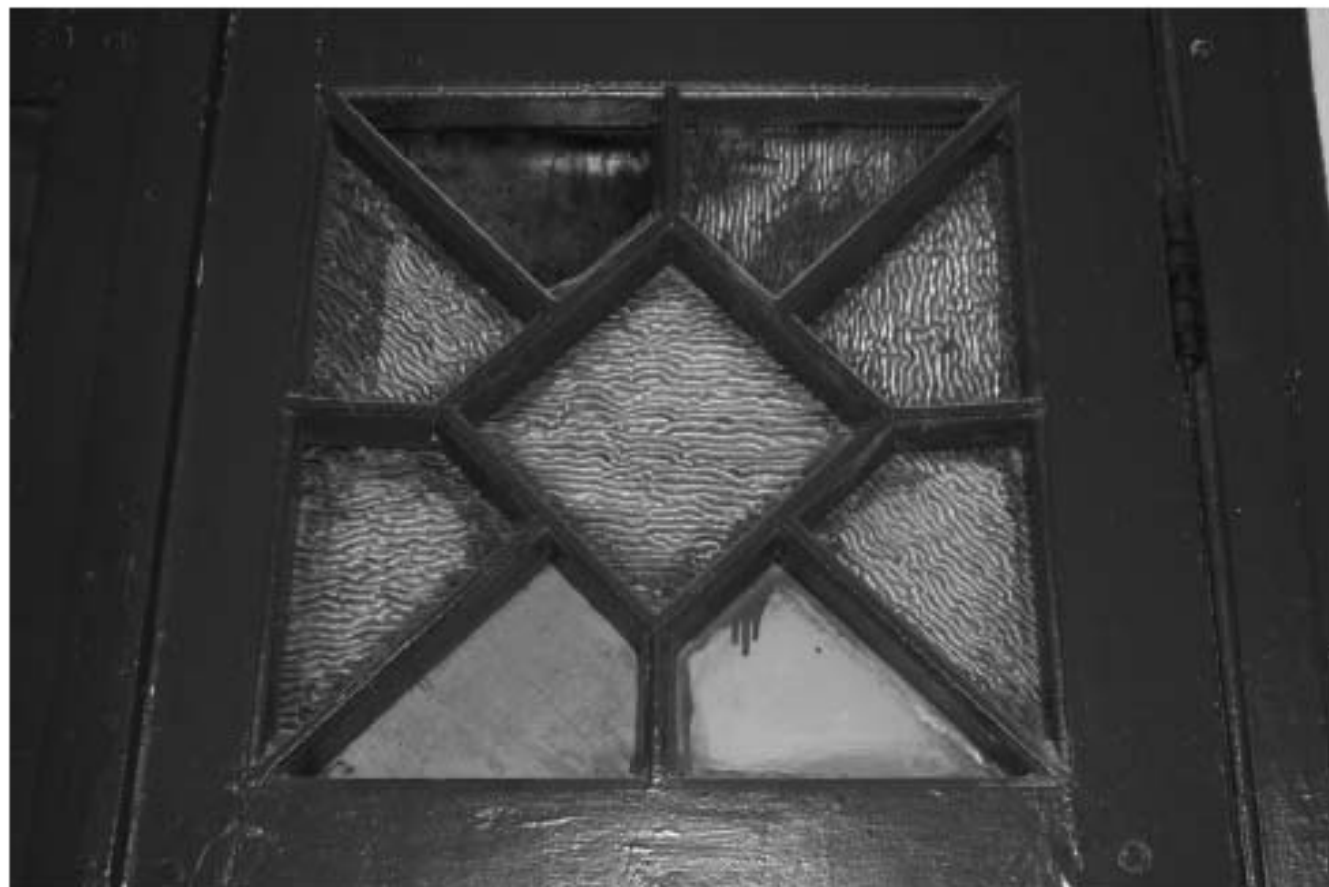
45. Интерьер парадной. Фрагмент дверных заполнений жилого помещения.
