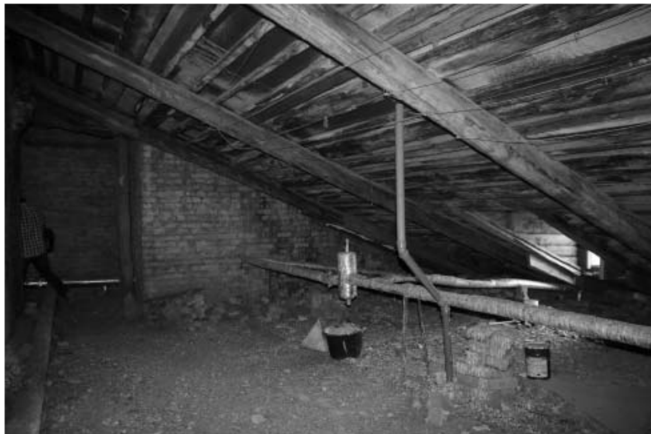
57. Пространство чердачного помещения
