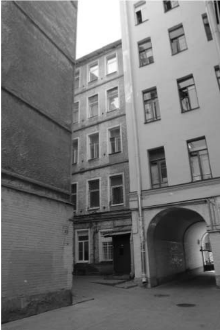
б. Фрагмент дворового фасада. Вид с северо-востока.
