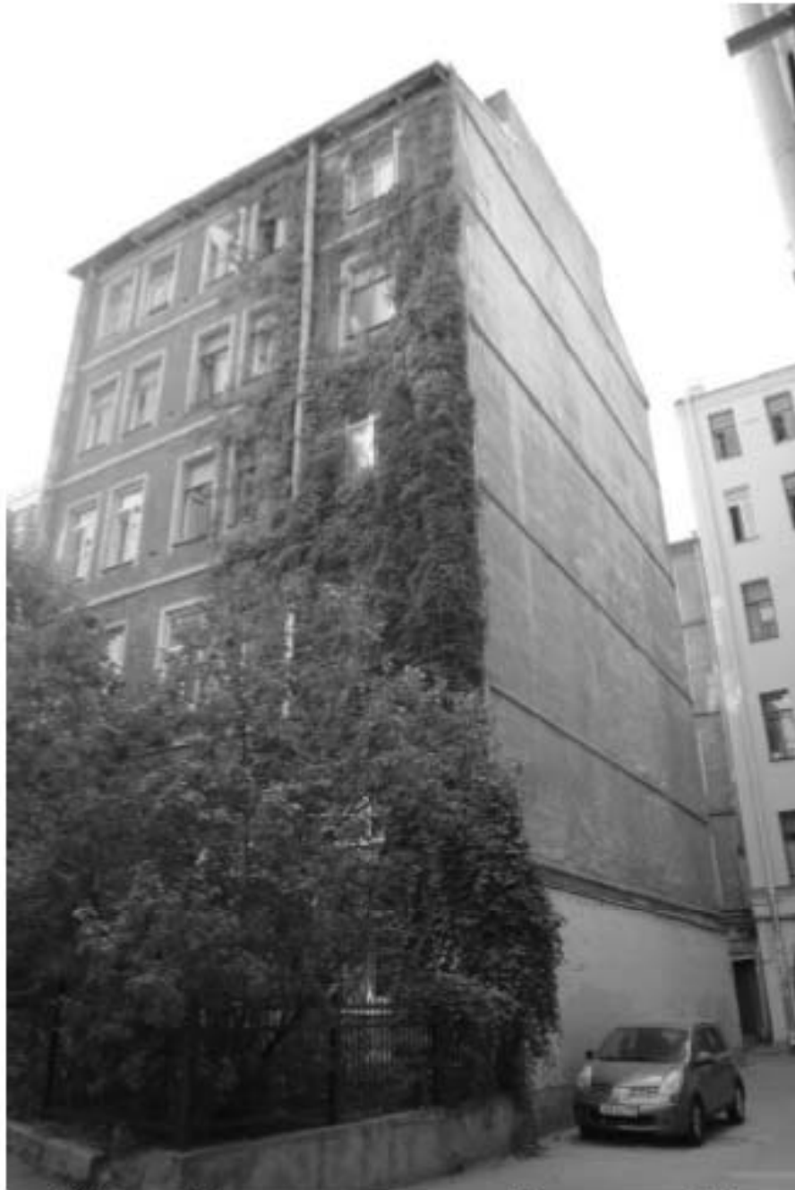
4. Дворовый фасад. Вид с северо-востока. Фотосъемка 15 июля 2021г.
