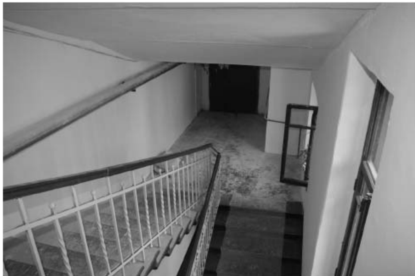
49. Интерьер парадной. Фрагмент лестницы.
