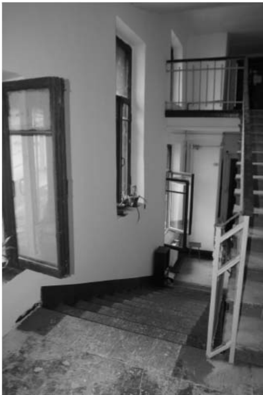
47. Интерьер парадной. Фрагмент лестницы.
