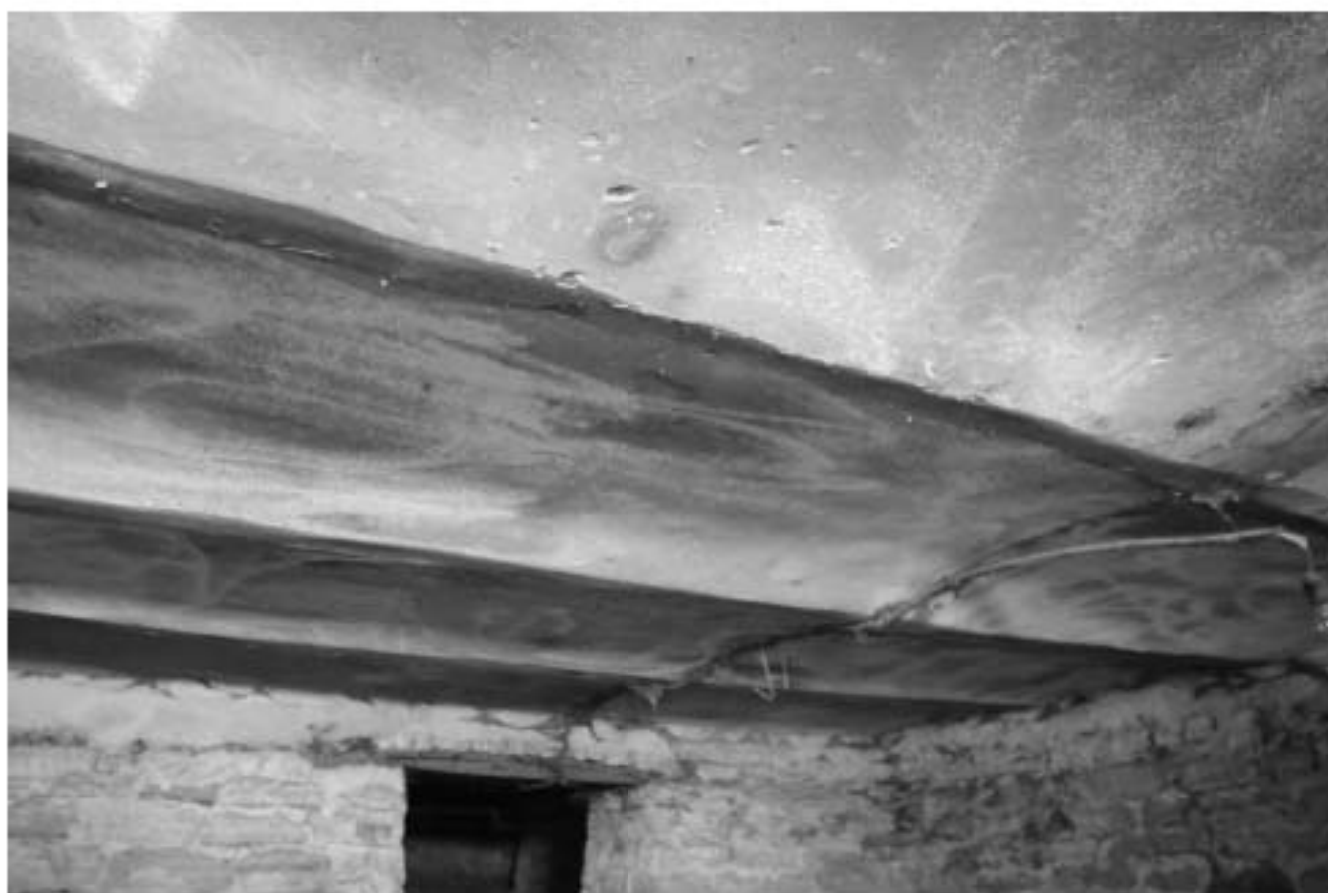
24. Фрагмент подвального помещения. Оформление свода
