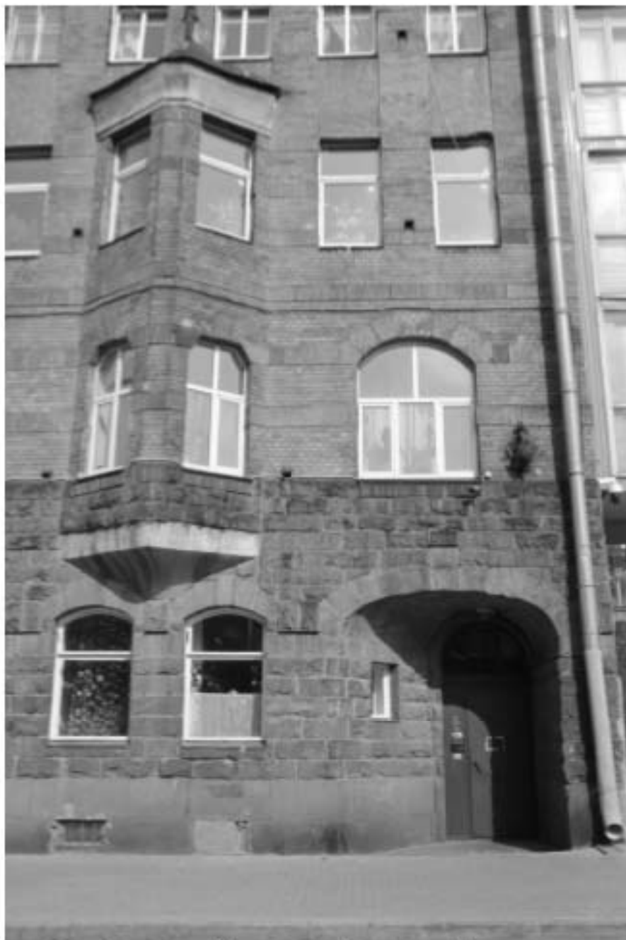
7. Фрагмент главного фасада с Таврической улицы. Дверь парадного входа. Вид с запада
