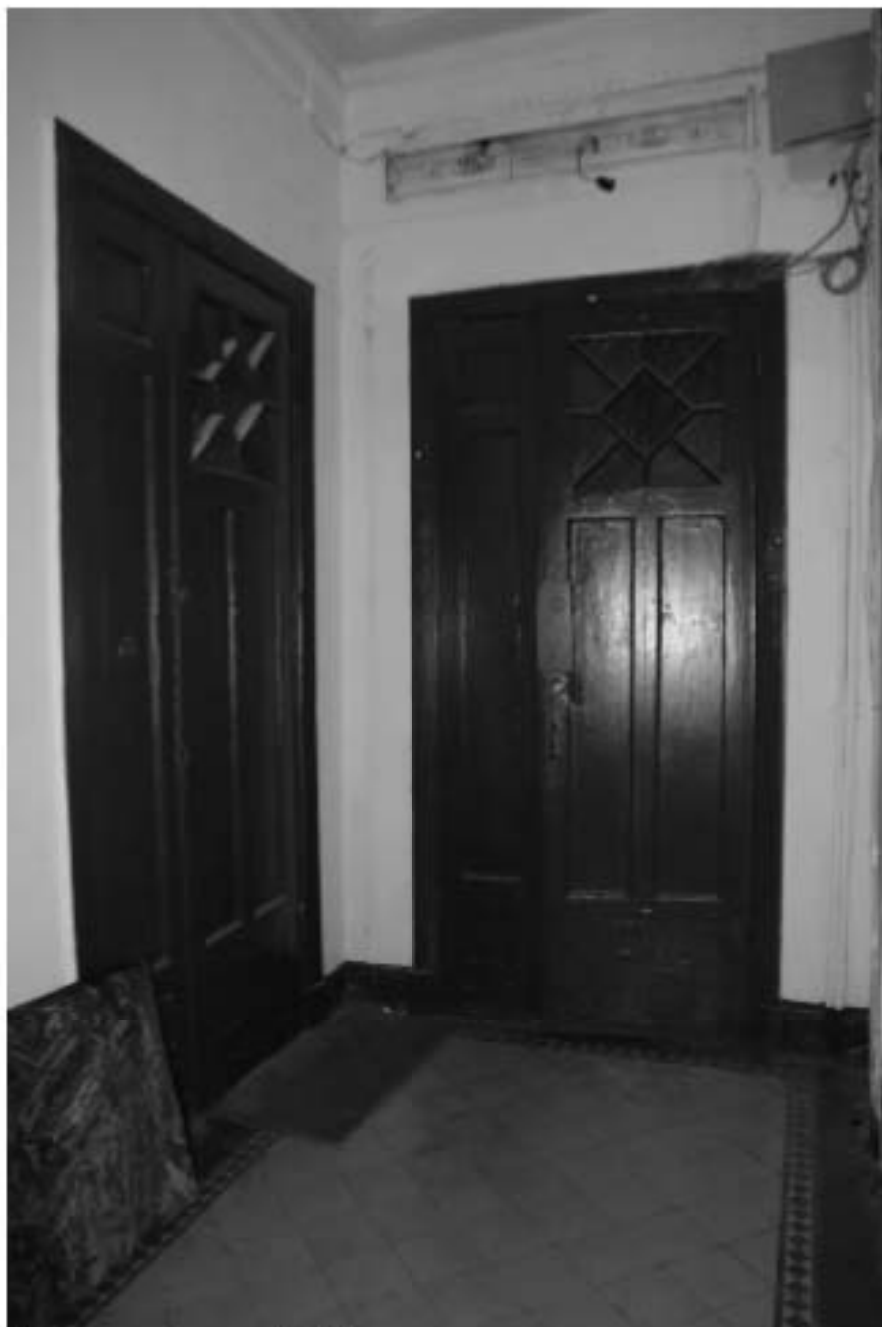
39. Интерьер парадной. Дверные заполнения жилых помещений.
