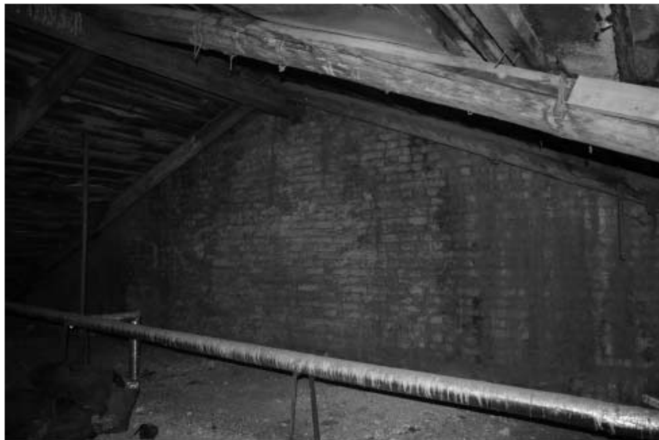
53. Пространство чердачного помещения
