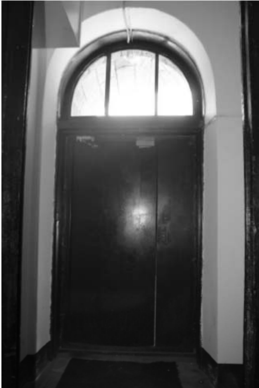
31. Интерьер вестибюля парадной. Дверное заполнение парадного входа
