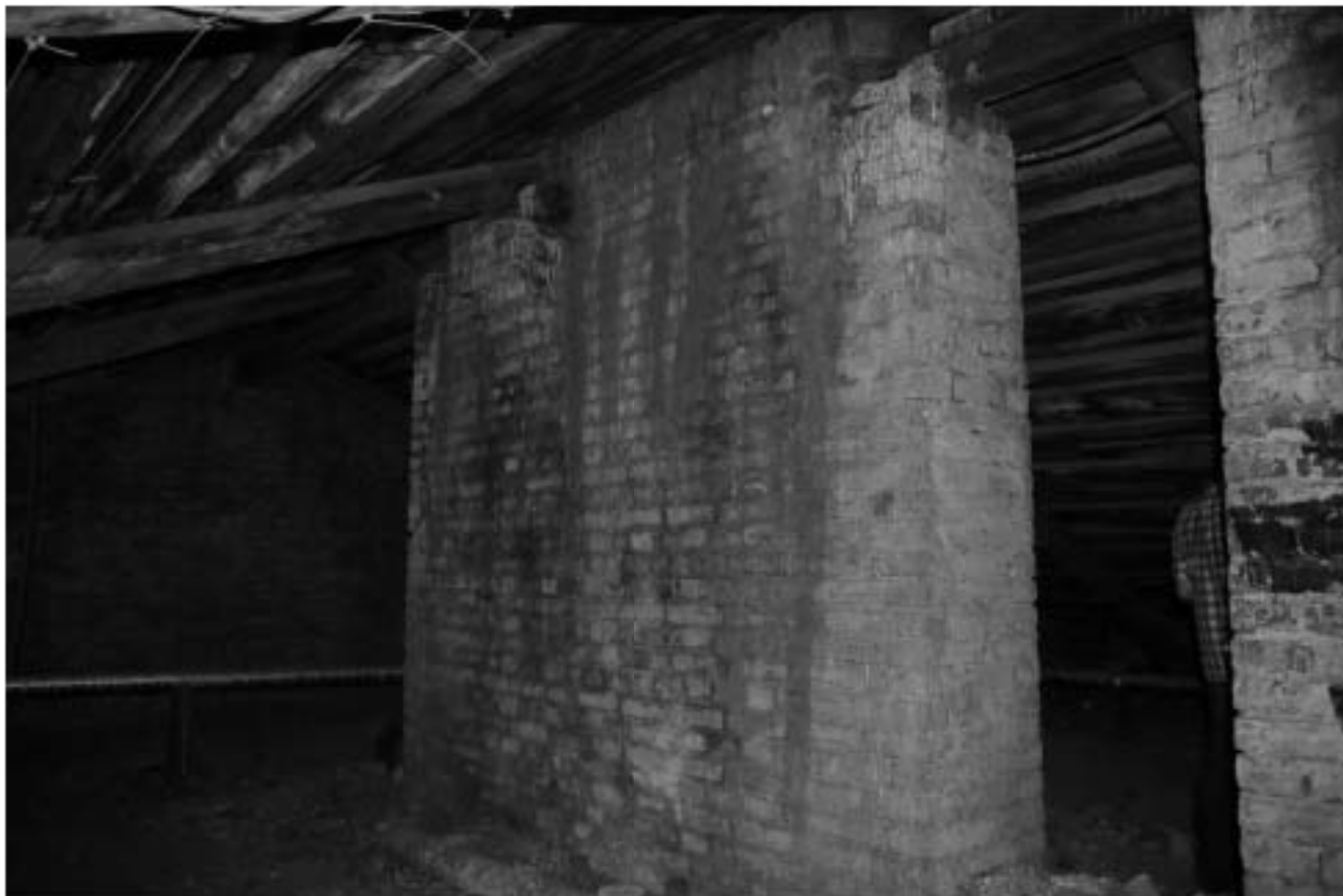
55. Пространство чердачного помещения
