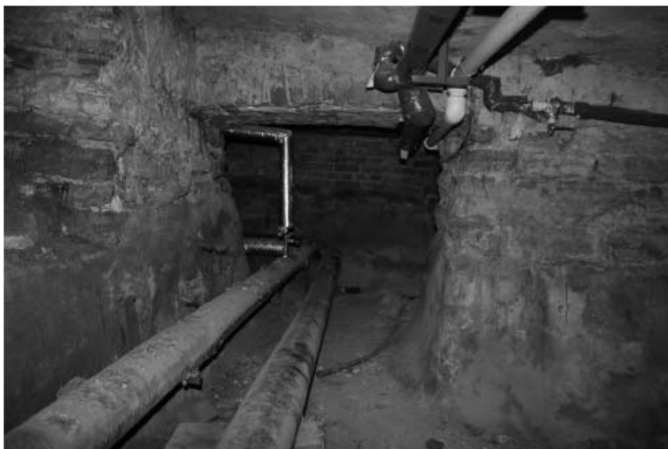
26. Фрагмент подвального помещения
