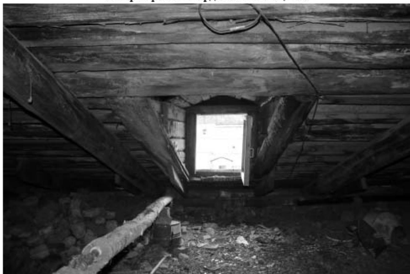
58. Пространство чердачного помещения. Чердачное окно.
