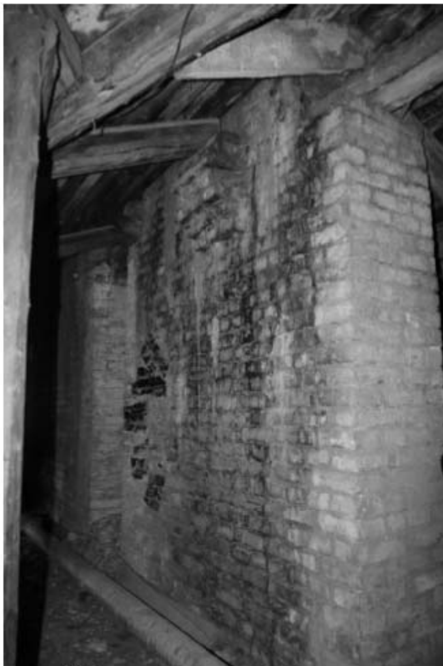
54. Пространство чердачного помещения
