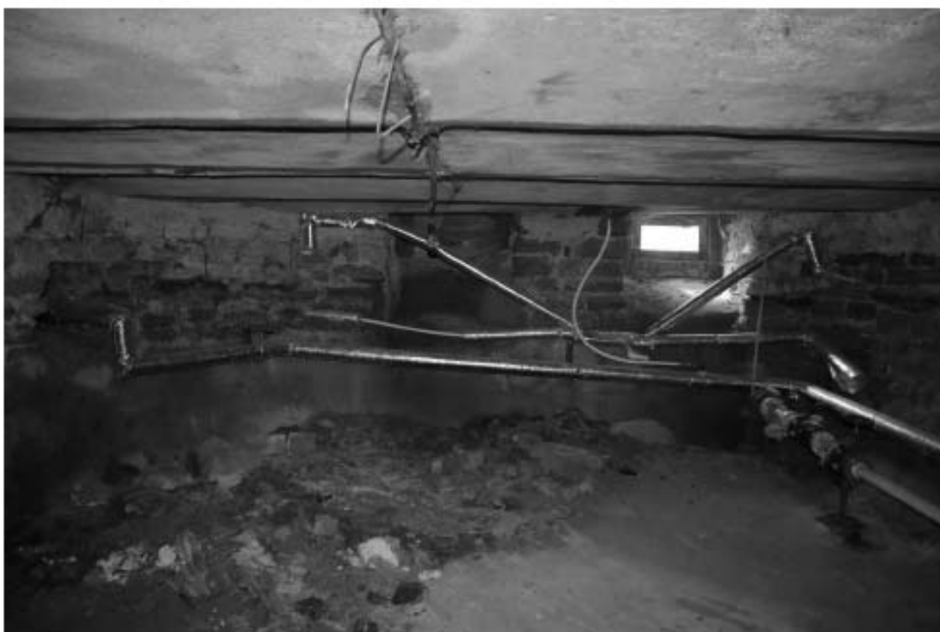
22. Фрагмент подвального помещения
