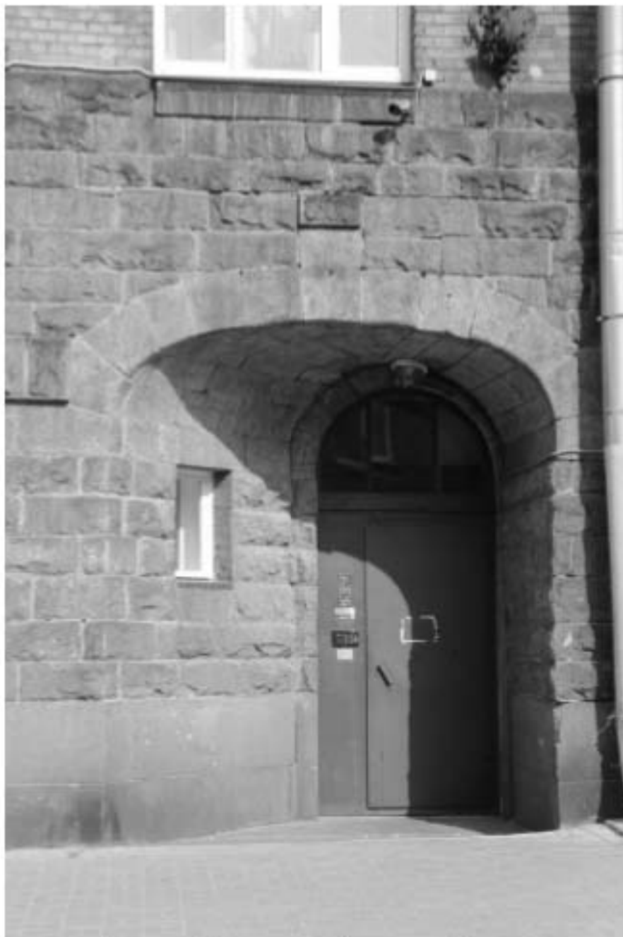
8. Фрагмент главного фасада с Таврической улицы. Двери парадного входа. Вид с запада
