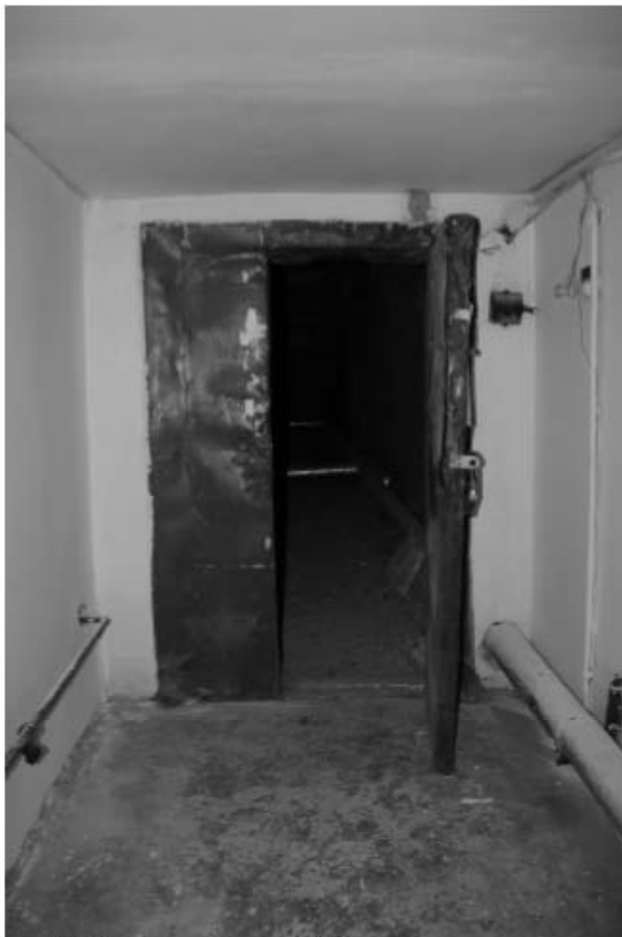
50. Интерьер парадной. Дверь входа на чердак
