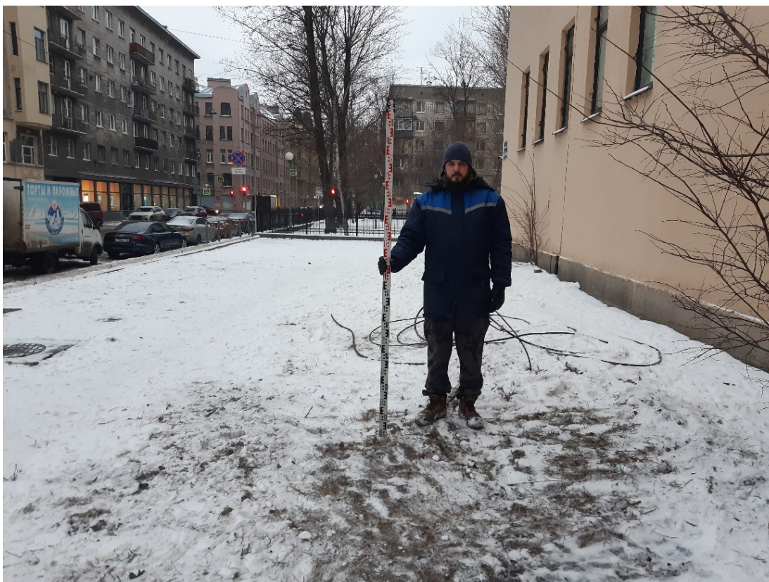
Рис. 21. Санкт-Петербург, Ул. Ленина д. 5 лит. Б. Шурф 1. Общий вид до начала работ. Вид на северо-запад.
