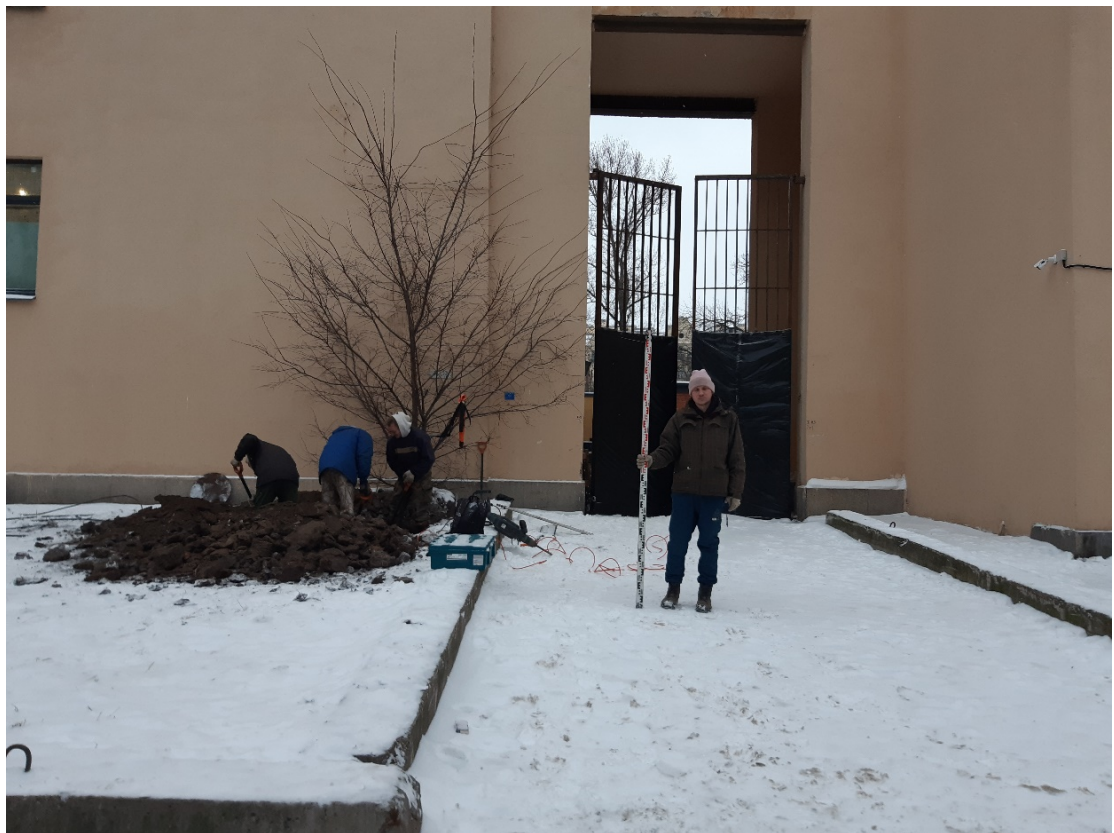
Рис. 20. Санкт-Петербург, Ул. Ленина д. 5 лит. Б. Общий вид трассы. Вид на северо-восток.
