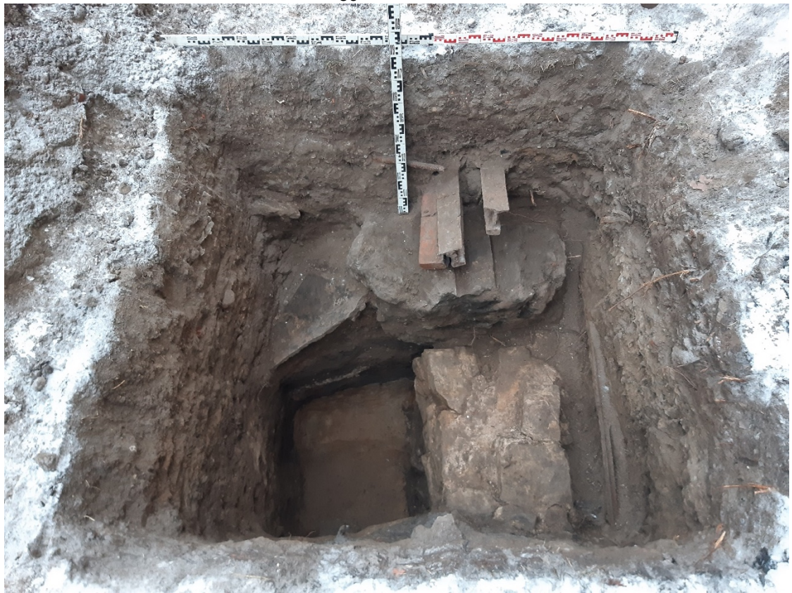
Рис. 24. Санкт-Петербург, Ул. Ленина д. 5 лит. Б. Шурф 1. Фотофиксация по желтоватой супеси (материку) с фрагментом фундамента и завалом из крупного строительного мусора. Уровень остановки работ. Вид на северо-запад.
