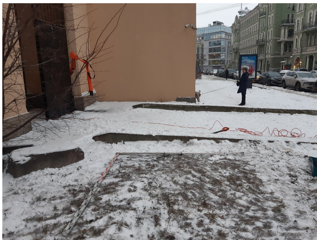
Рис. 22. Санкт-Петербург, Ул. Ленина д. 5 лит. Б. Шурф 1. Дневная поверхность шурфа до начала работ. Вид на юго-запад.
