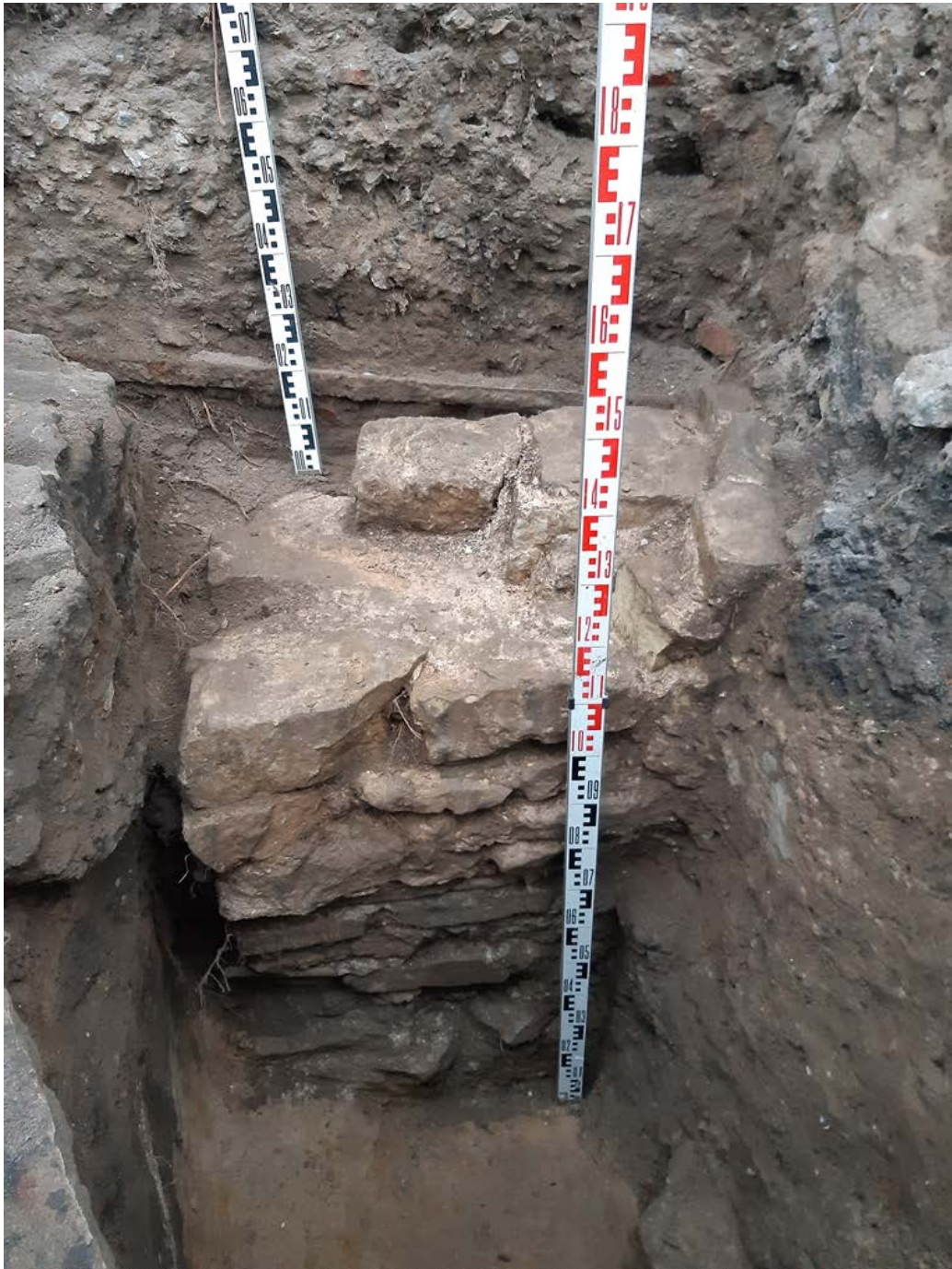
Рис. 31. Санкт-Петербург, Ул. Ленина д. 5 лит. Б. Шурф 1. Фотофиксация юго-западного фаса фрагмента бутового фундамента. Вид на северо-восток.
