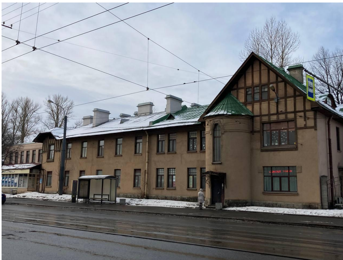
Фото 1. Лицевой фасад выявленного объекта культурного наследия «Дом Морского Водства (Главного гидрографического управления)»
