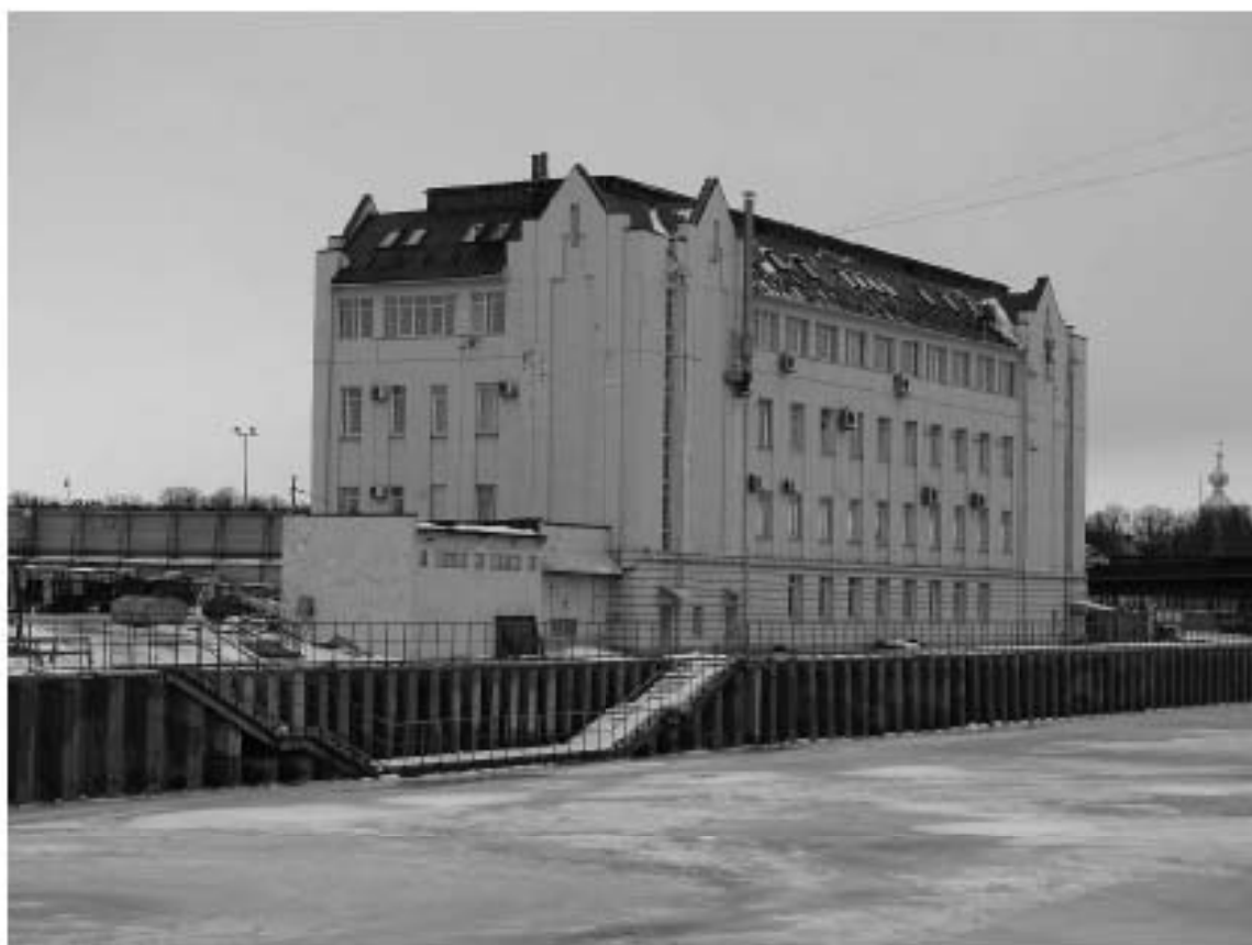
Рис. 3 Демонтируемое здание. Вид с юго-востока
