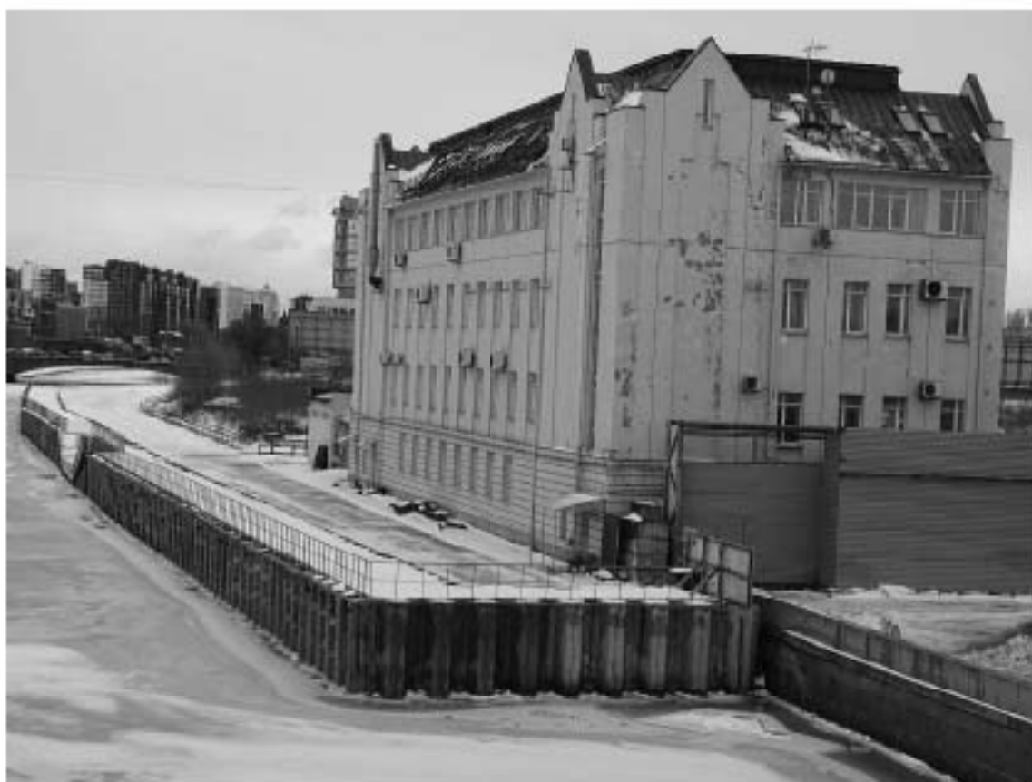
Рис. 1 Демонтируемое здание. Вид с севера
