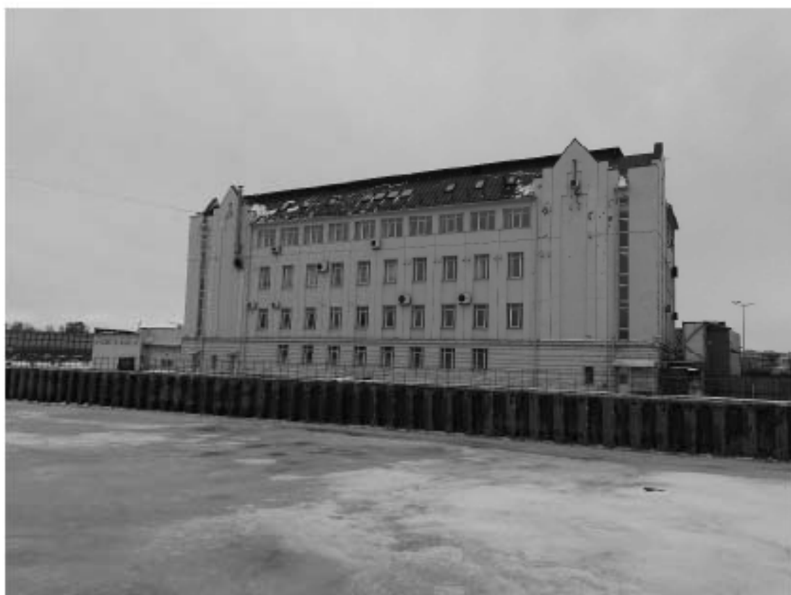
Рис. 2 Демонтируемое здание. Вид с северо-востока
