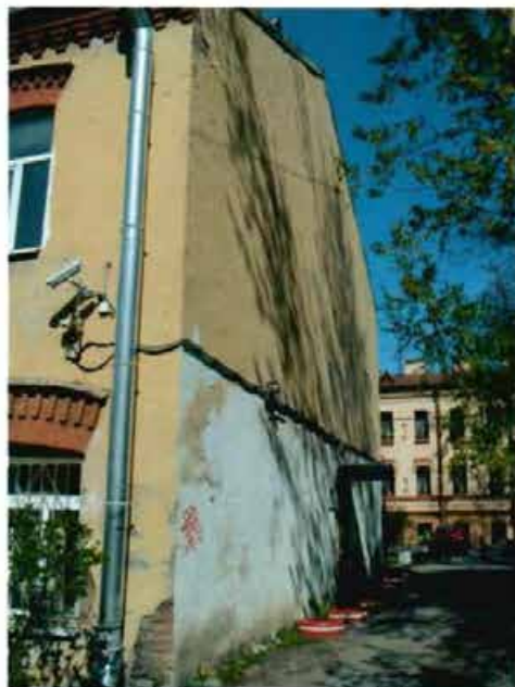
Фото 23. Вид на восточный фасад.
