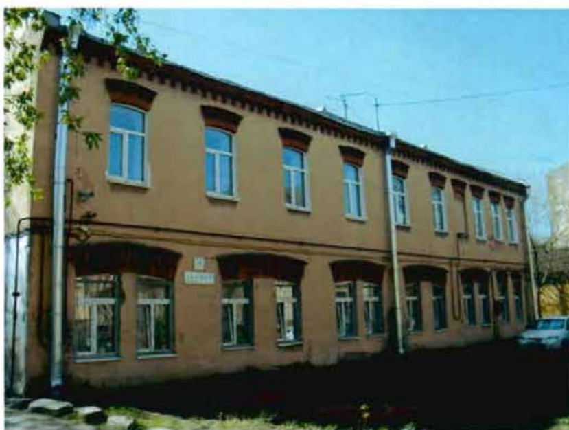
Фото 21. Вид на северный фасад.
