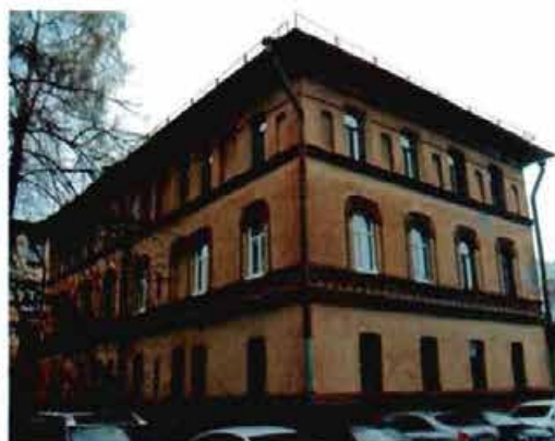
Фото 10. Вид на западный и южный фасады.
