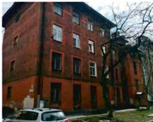
Фото 6. Вид на западный и северный фасады.
