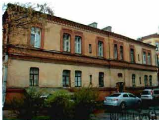
Фото 14. Вид на восточный фасад.
