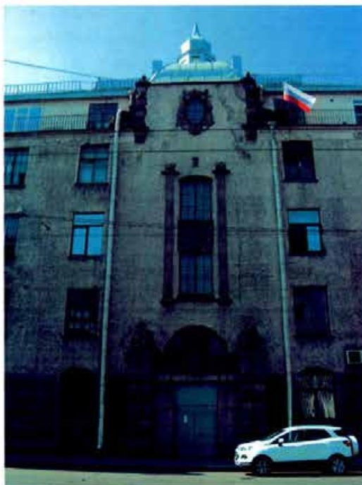
Фото 2. Вид на восточный фасад. Фрагмент.
