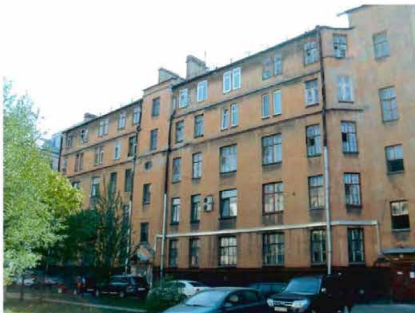
Фото 25. Вид на северный фасад. Фрагмент.
