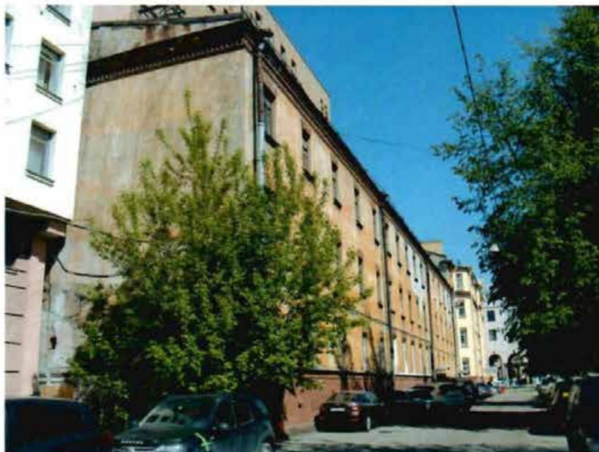
Фото 31. Вид на южный и западный фасады.
