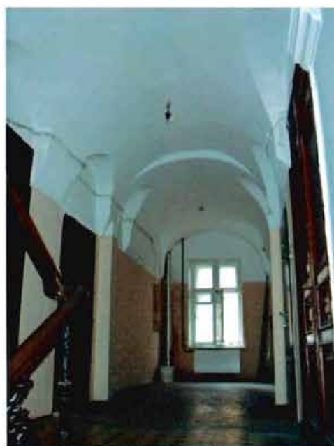
Фото 12. Вестибюль 2-го этажа. Цилиндрические своды с распалубками.
