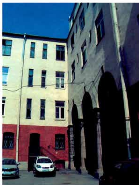
Фото 4. Вид на западный и южный фасады.
