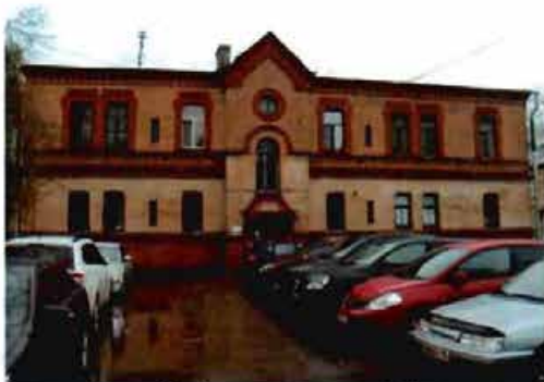
Фото 13. Вид на западный фасад.
