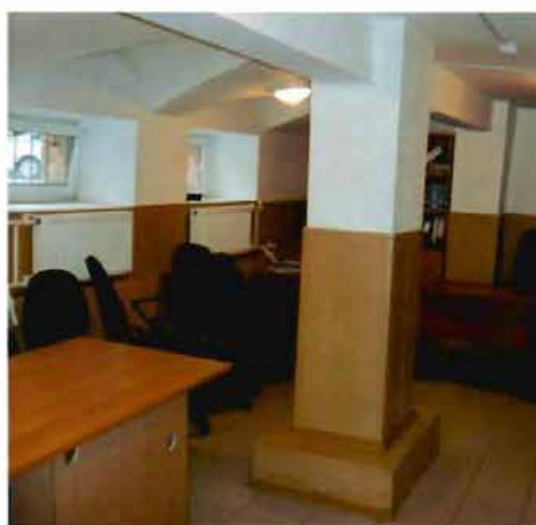
Фото 30. Пилоны в уровне подвального этажа. Фрагмент.
