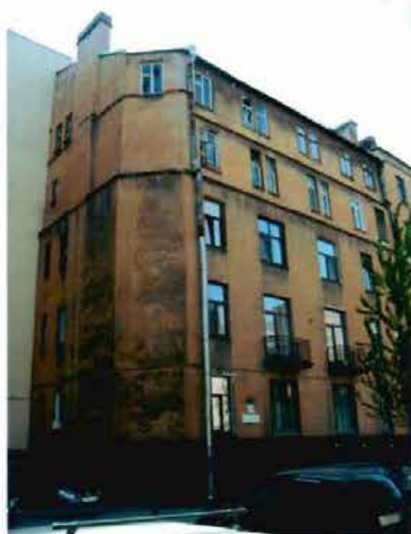
Фото 26. Вид на северный фасад. Фрагмент.
