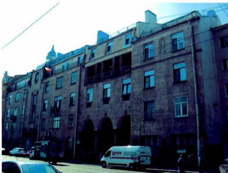
Фото 1. Вид на восточный фасад.
