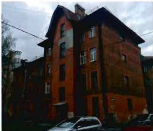
Фото 5. Вид на восточный и северный фасады.
