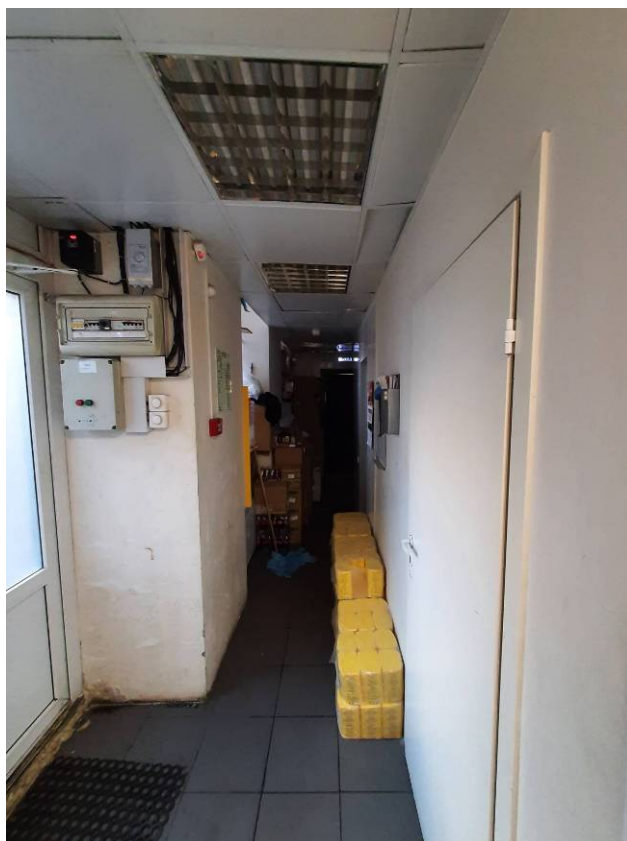
Фото 9. Интерьер помещения 2-Н выявленного объекта культурного наследия «Дом С.М. Дейчмана»
