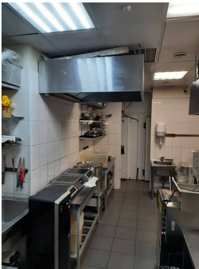
Фото 11. Интерьер помещения 2-Н выявленного объекта культурного наследия «Дом С.М. Дейчмана»
