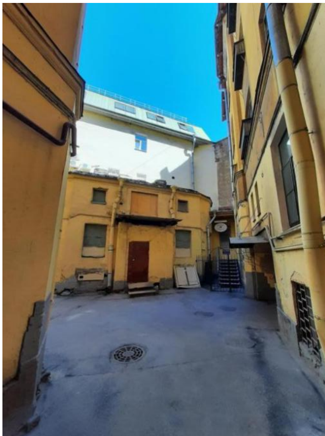
Фото 5 Фрагмент дворового фасада выявленного объекта культурного наследия «Дом Ф.Ф. Шпринга» расположенного по адресу: Санкт-Петербург, пер. Тучков, дом 11/5, литера А (Тучков пер., 11; Волховский пер., 5)
