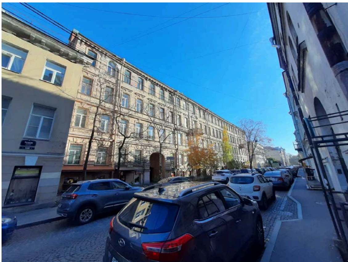
Фото 1 Фрагмент лицевого фасада выявленного объекта культурного наследия «Дом Ф.Ф. Шпринга» расположенного по адресу: Санкт-Петербург, пер. Тучков, дом 11/5, литера А (Тучков пер., 11; Волховский пер., 5)
