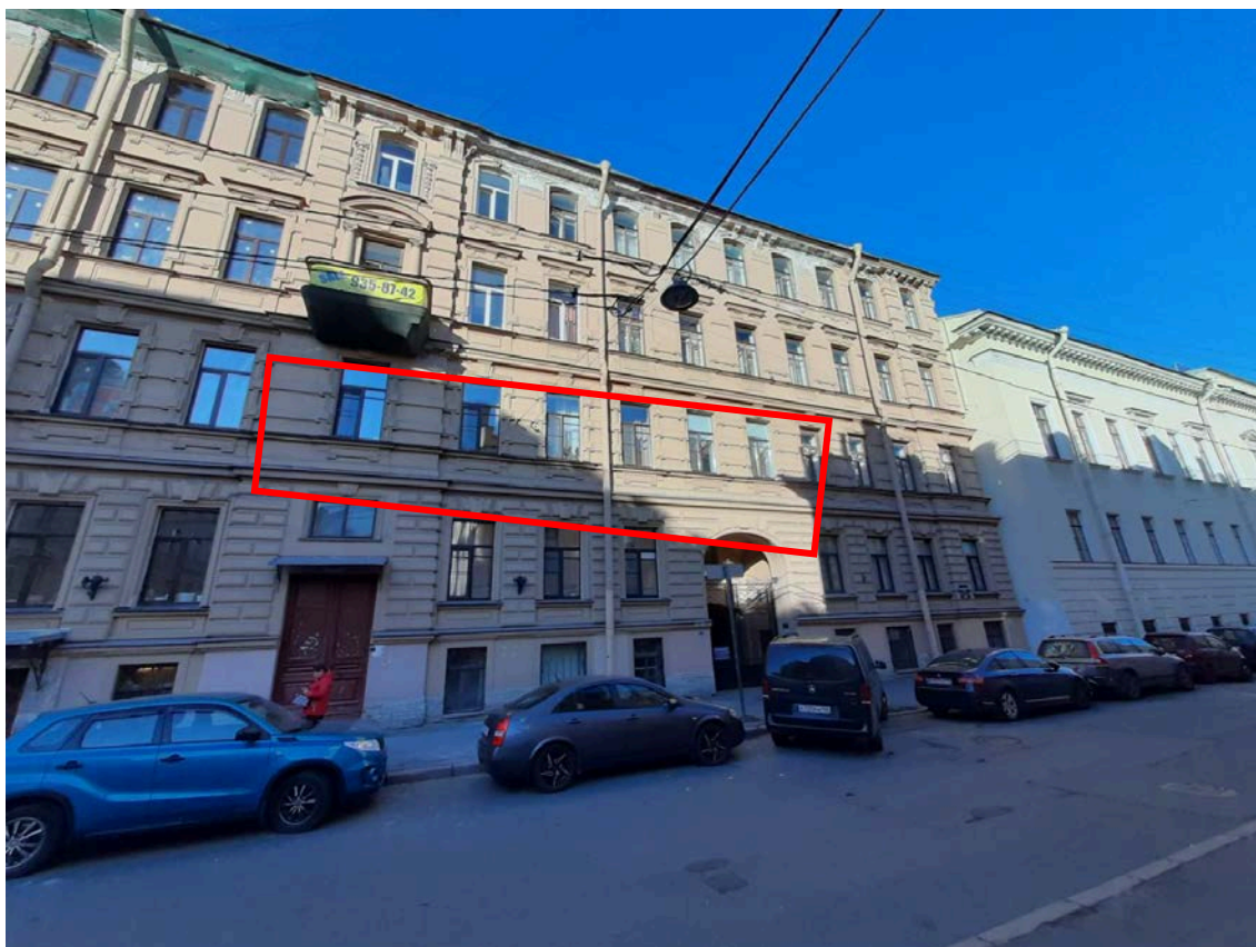
Фото 3 Фрагмент лицевого фасада выявленного объекта культурного наследия «Дом Ф.Ф. Шпринга» расположенного по адресу: Санкт-Петербург, пер. Тучков, дом 11/5, литера А (Тучков пер., 11; Волховский пер., 5), окна квартиры №32
