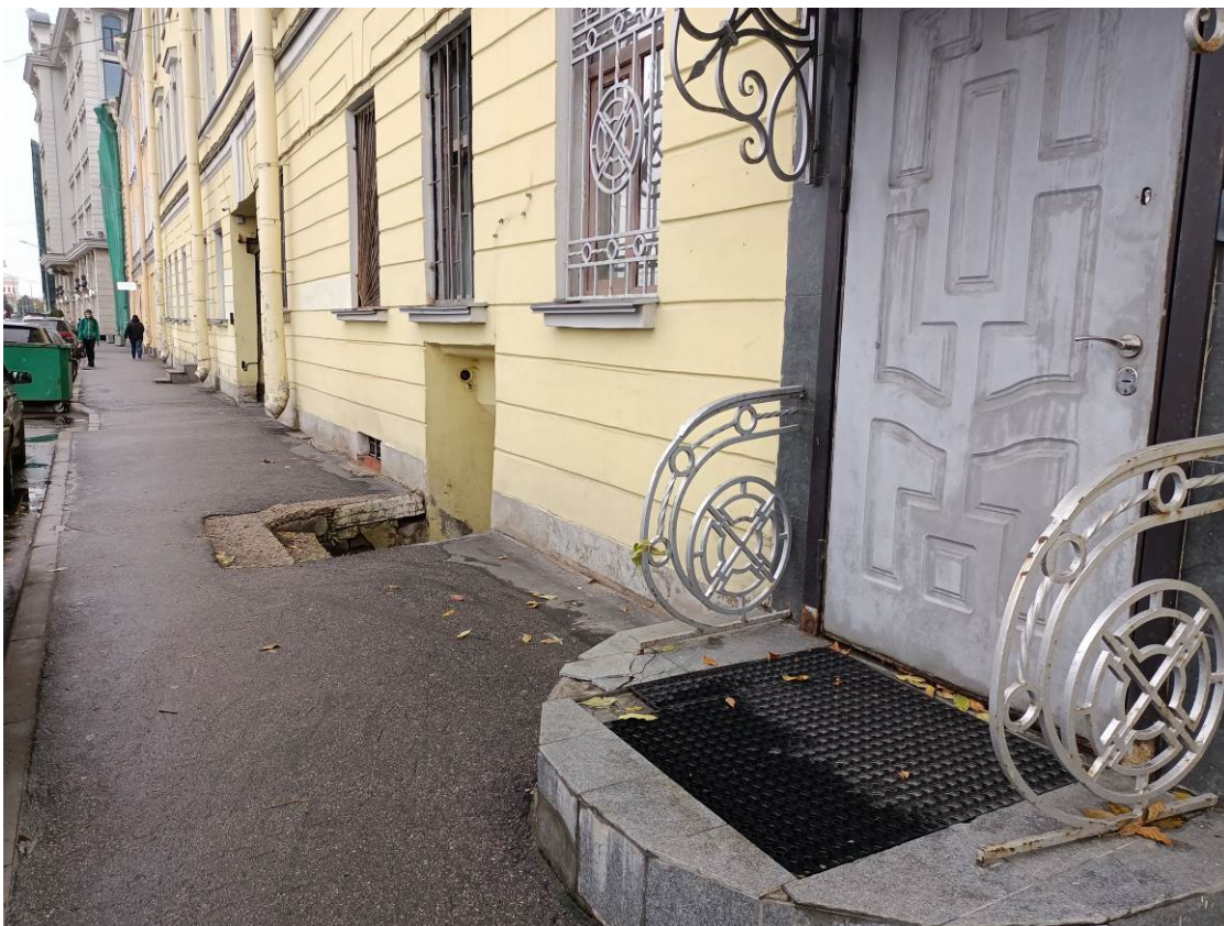
Фото 5. Точка 5 – Фрагмент лицевого фасада здания
