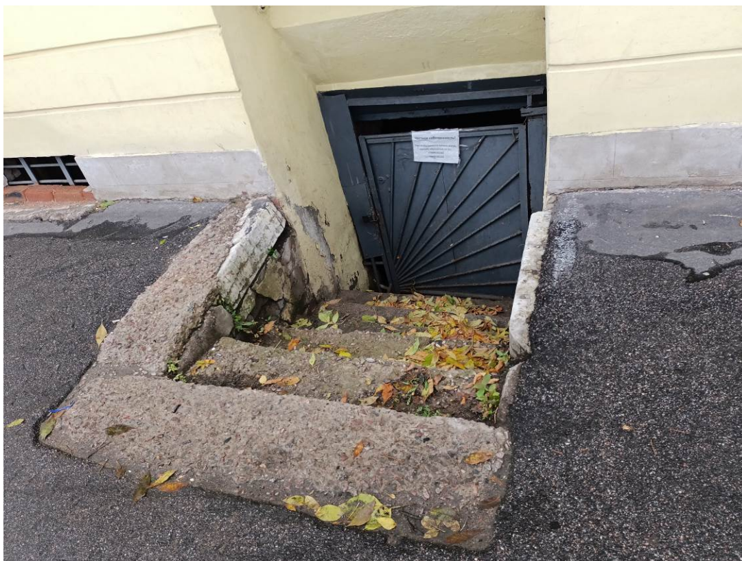
Фото 7. Точка 7 – Фрагмент лицевого фасада здания. Прямок пом. 2-Н
