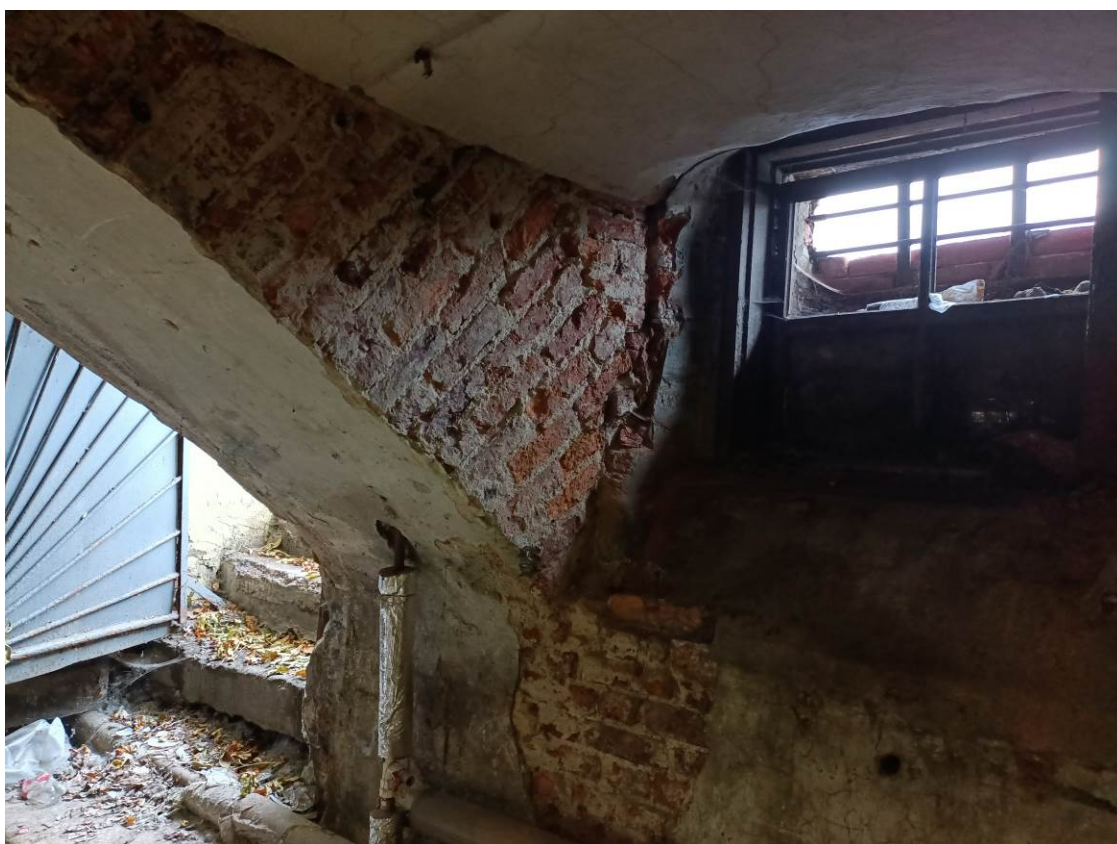
Фото 4. Точка 4 – пом. №2 (существующий оконный проем)
