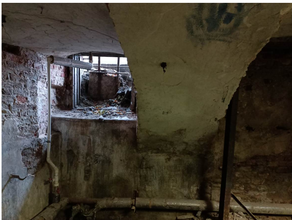
Фото 12. Точка 12 – пом. №1 (существующий оконный проем)
