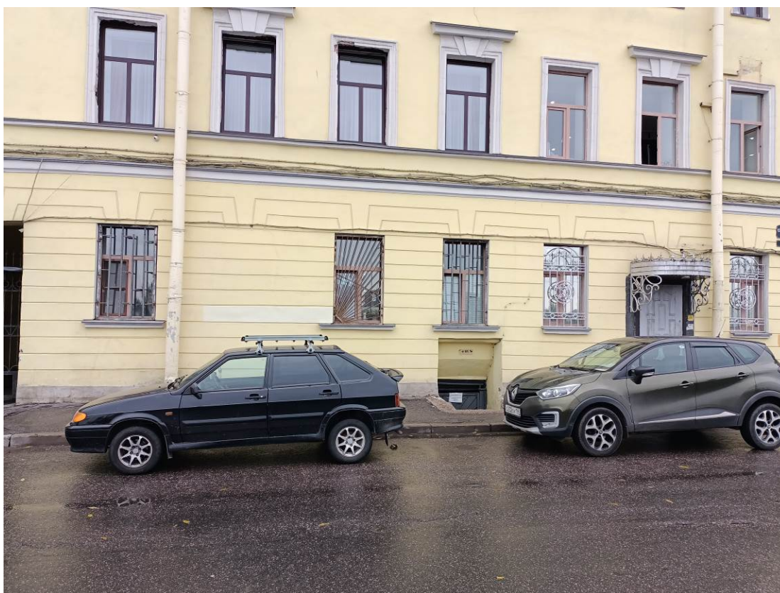
Фото 4. Точка 4 – Фрагмент лицевого фасада здания
