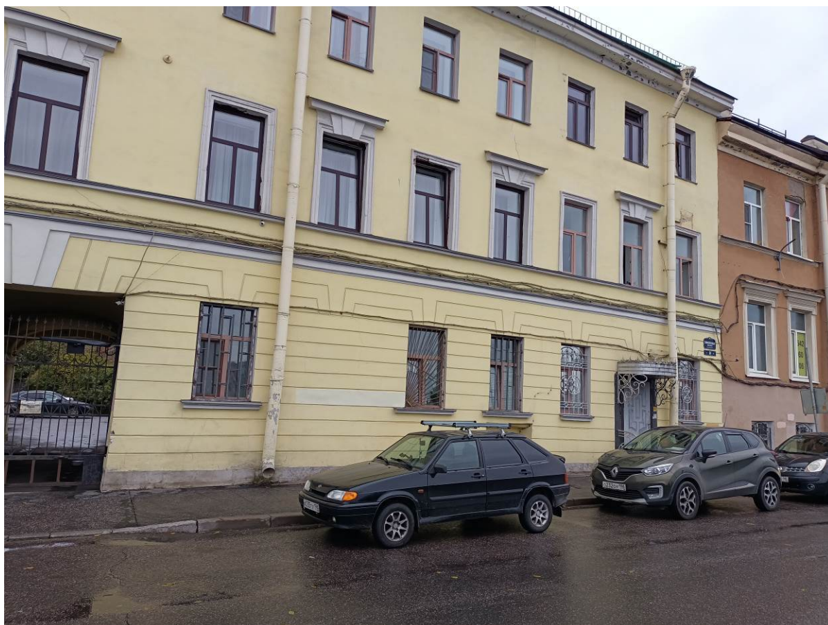
Фото 1. Точка 1 – Общий вид лицевого фасада здания
