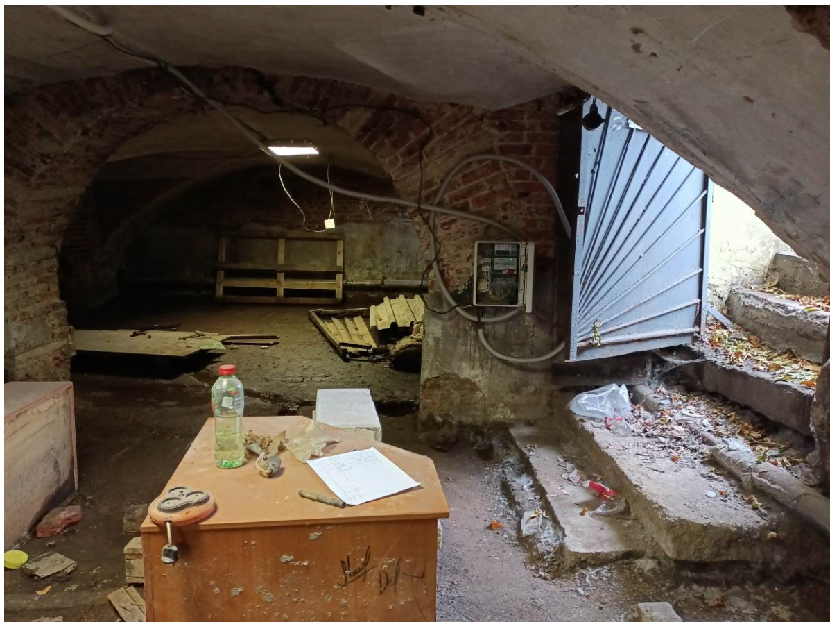
Фото 6. Точка 6 – пом. №2 (дверной проем)
