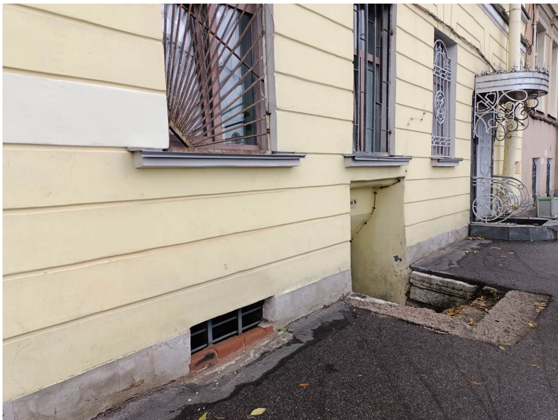
Фото 3. Точка 3 – Фрагмент лицевого фасада здания
