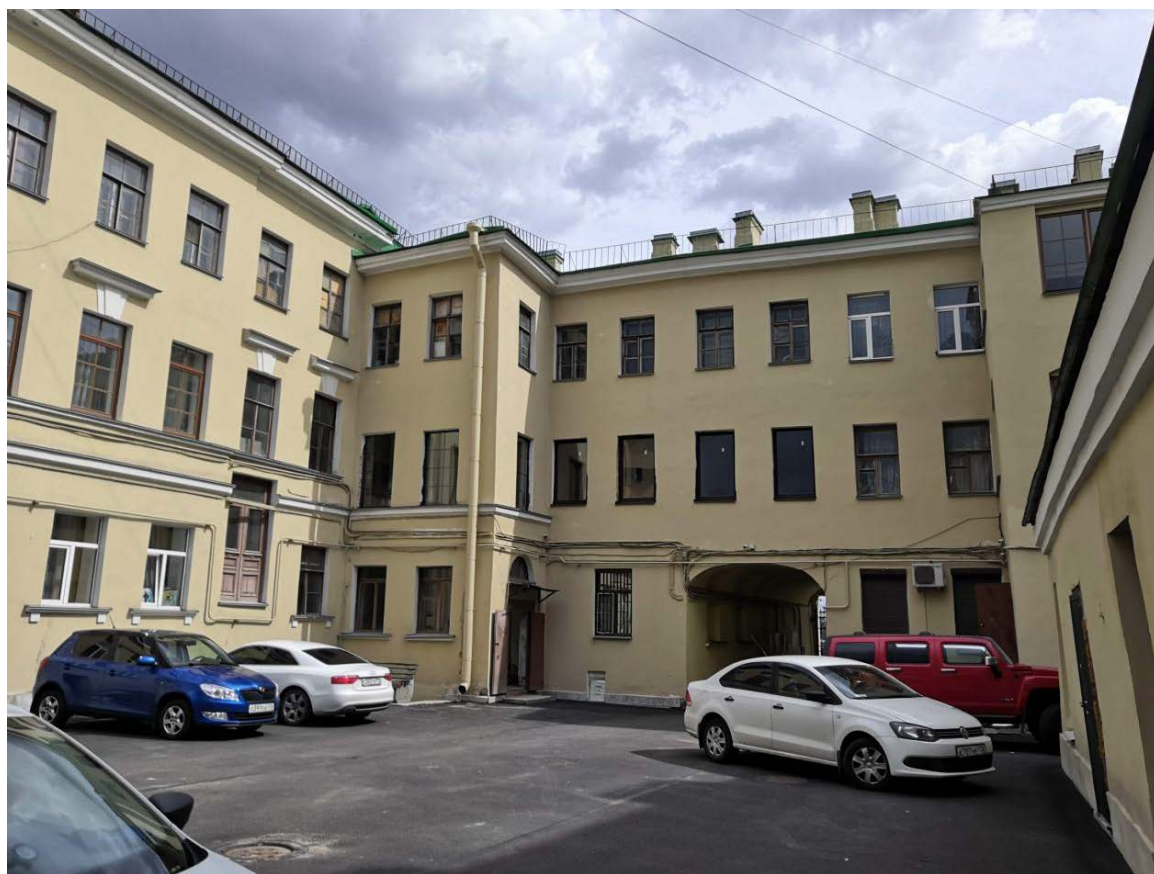
Фото 10. Точка 10 – Общий вид дворового фасада здания
