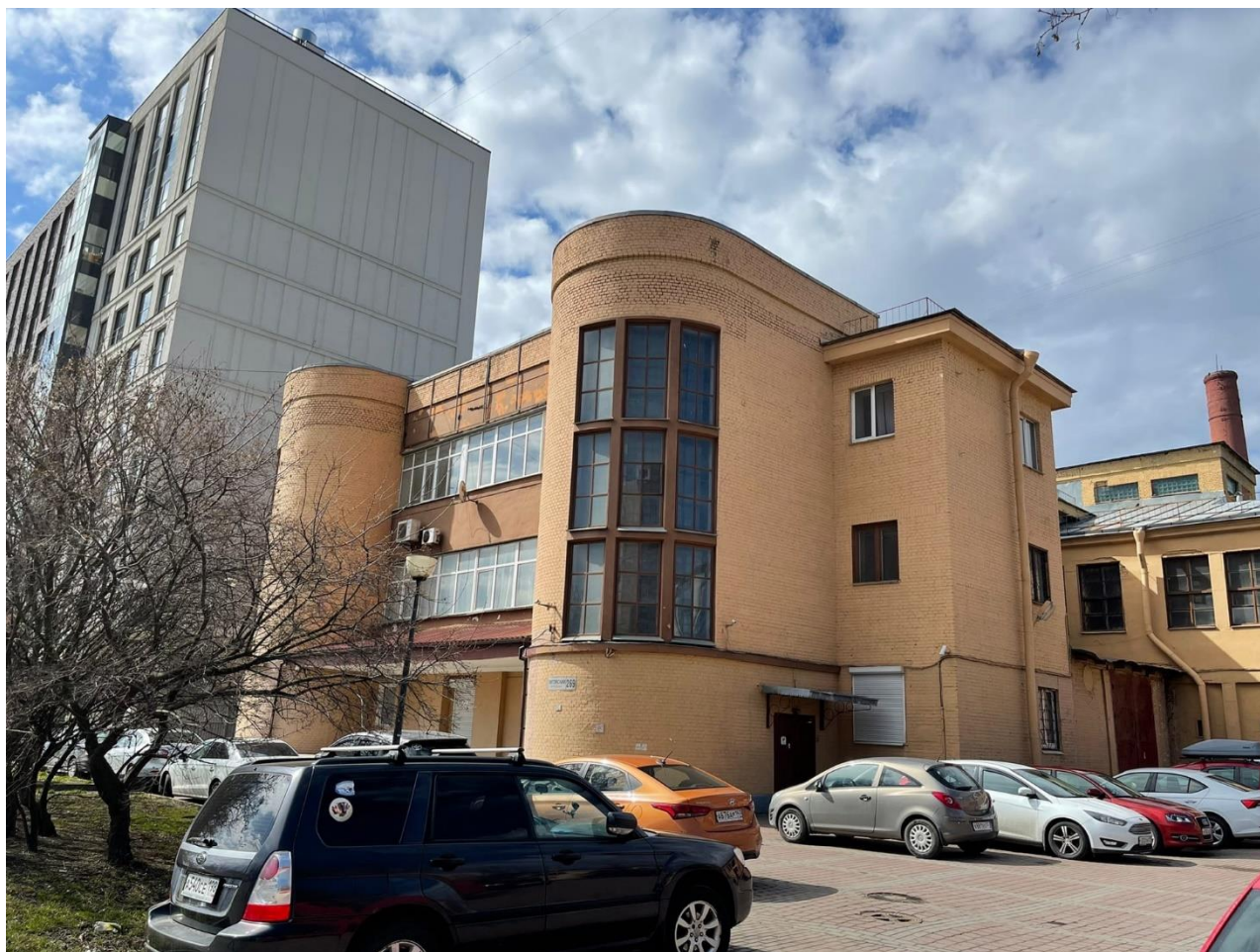
Фото 1. Фасад по Лиговскому пр. Юго-восток.
