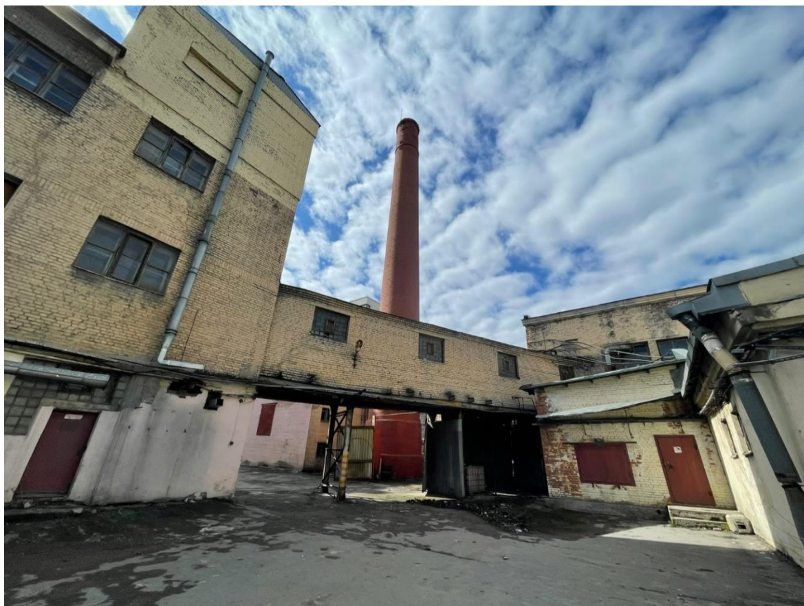
Фото 4. Одноэтажный надземный переход в уровне второго этажа (реконструкция зданий 1961–1962 гг.)
