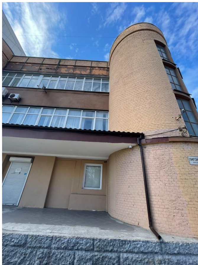
Фото 8. Фрагмент лицевого фасада по Лиговскому пр.
