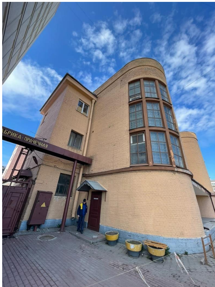
Фото 7. Полуциркульный левый выступ лицевого фасада с Лиговский пр.
