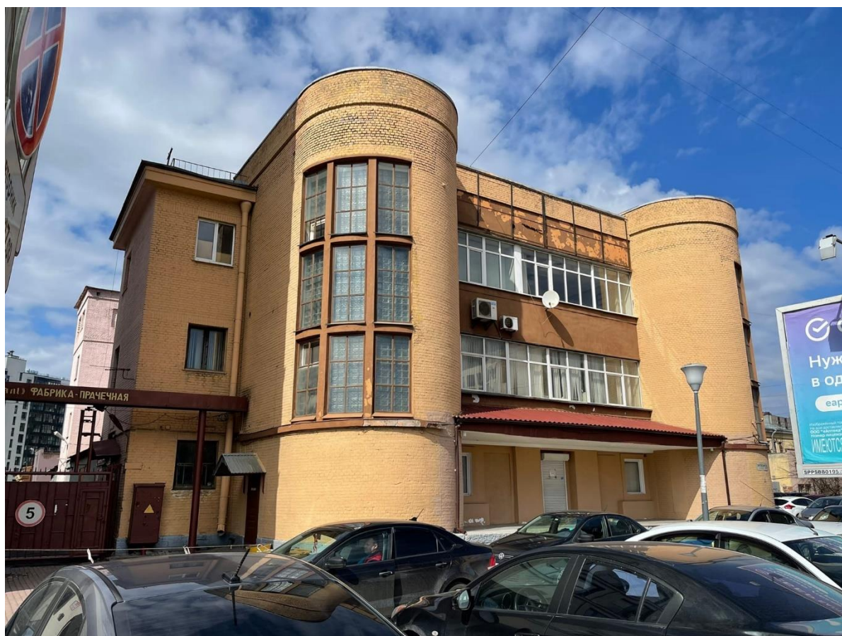
Фото 2. Фасад по Лиговскому пр. Юго-запад.
