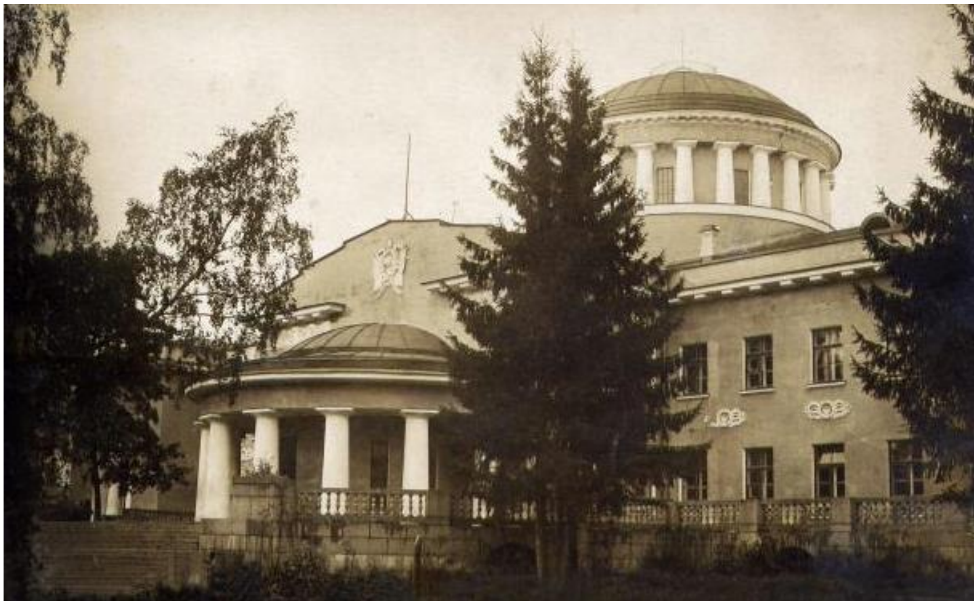
45. Большой дворец в Шуваловском парке - Всероссийский НИИ токов высокой частоты им. В.П. Вологодина. Главный корпус // https://www.citywalls.ru/photo87754.html
