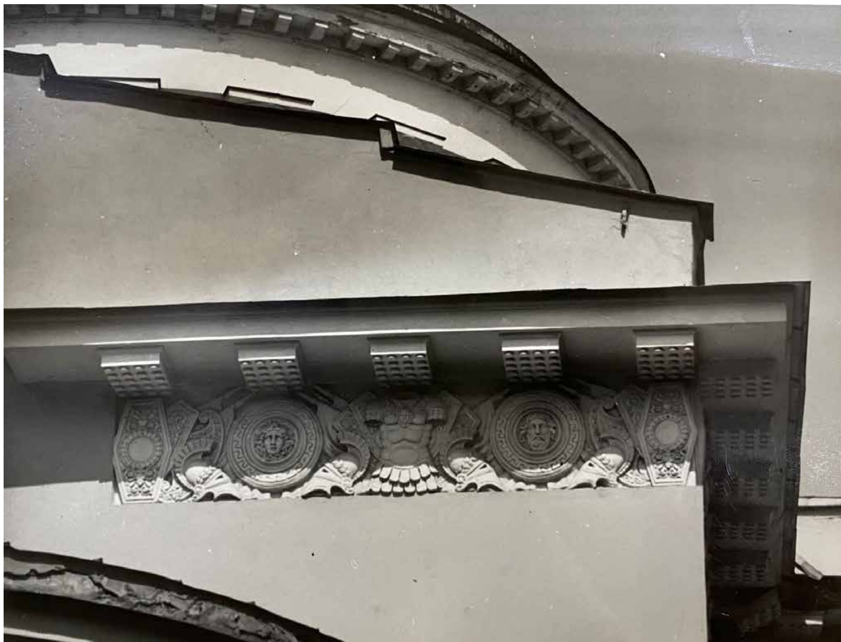
59. Ансамбль усадьбы Шуваловых (Е.А. Воронцовой-Дашковой). Большой дворец. Южный фасад. Центральная часть. Фрагмент фриза и венчающего карниза. Дата: 1985 г. Автор: В.И. Шлакан // Архив КГИОП, № 55311/1-Н.
