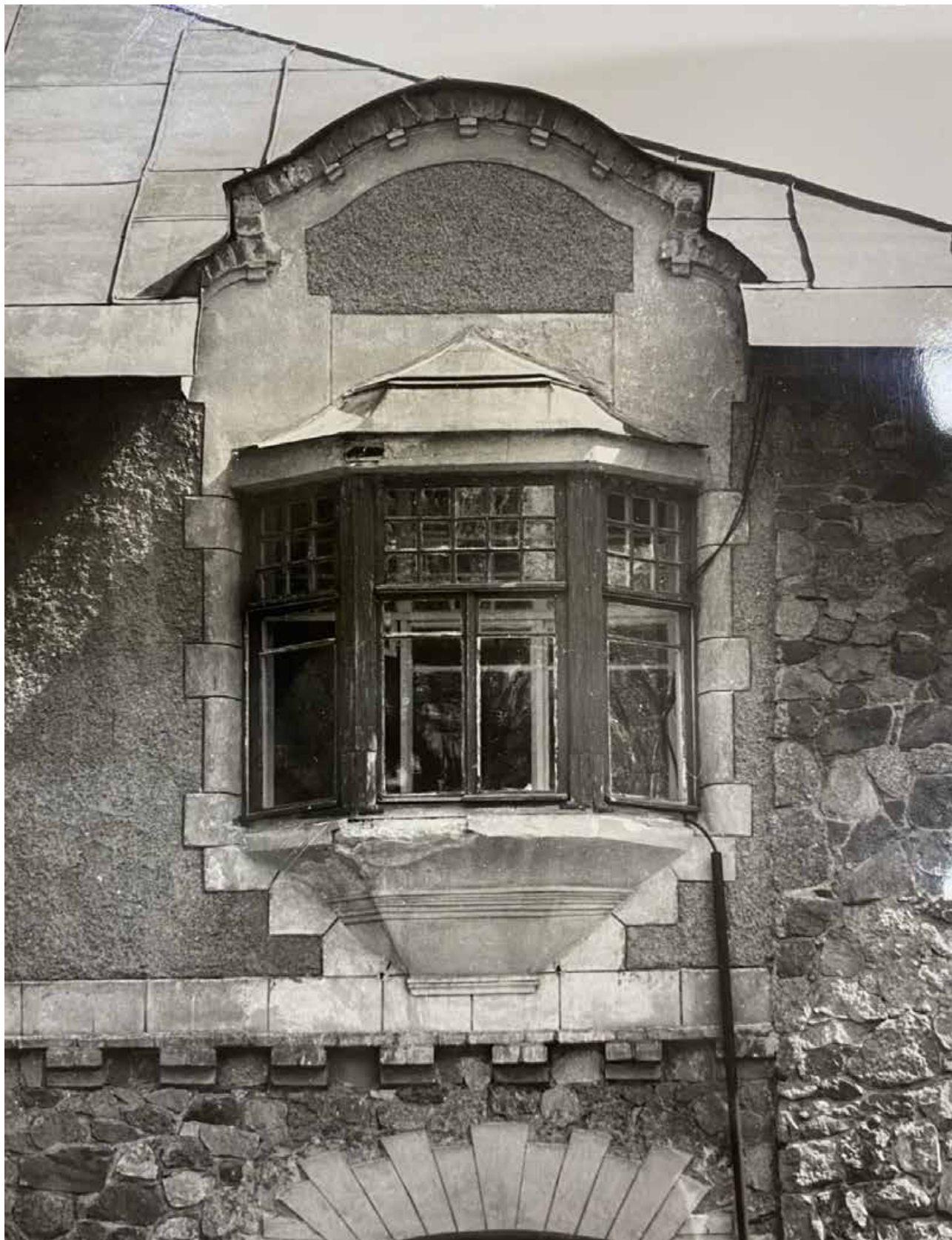
129. Ансамбль усадьбы Щуваловых. Ферма. Западный фасад. Эркерное окно 2-го этажа. Дата: 1985 г. Автор: В.И. Шлакан // Архив КГИОП, № 55338/1-Н.
