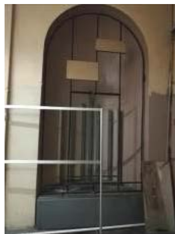
вестибюль при входе с северной стороны
