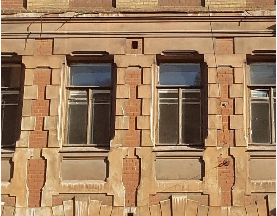
Фото 8. Оформление окон в уровне 3-го этажа. Лицевой фасад.
