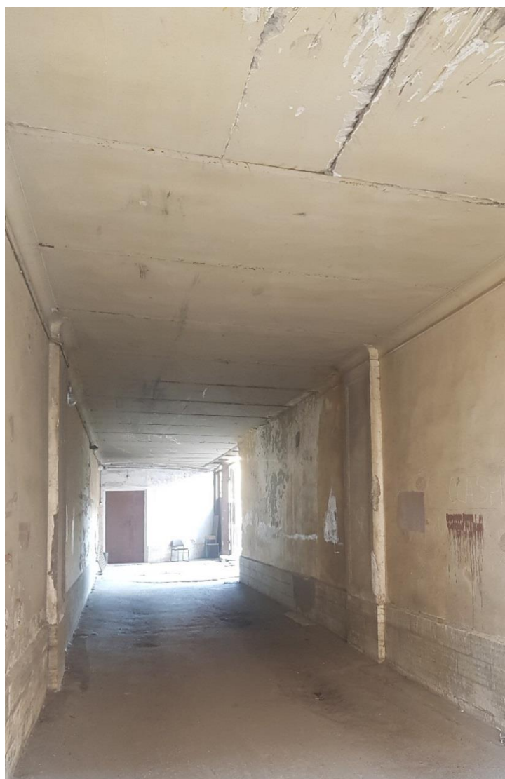
Фото 20. Воротный проезд по левой оси фасада.
