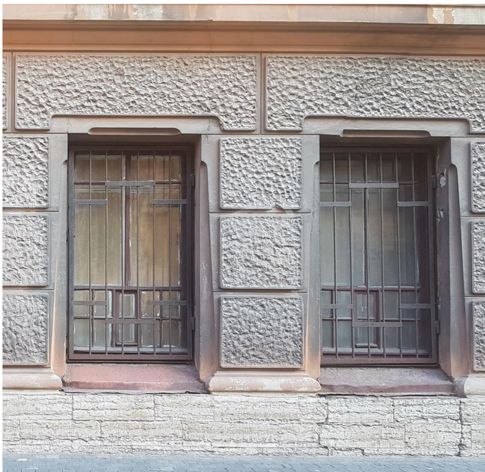
Фото 6. Оформление окон в уровне 1-го этажа. Лицевой фасад.
