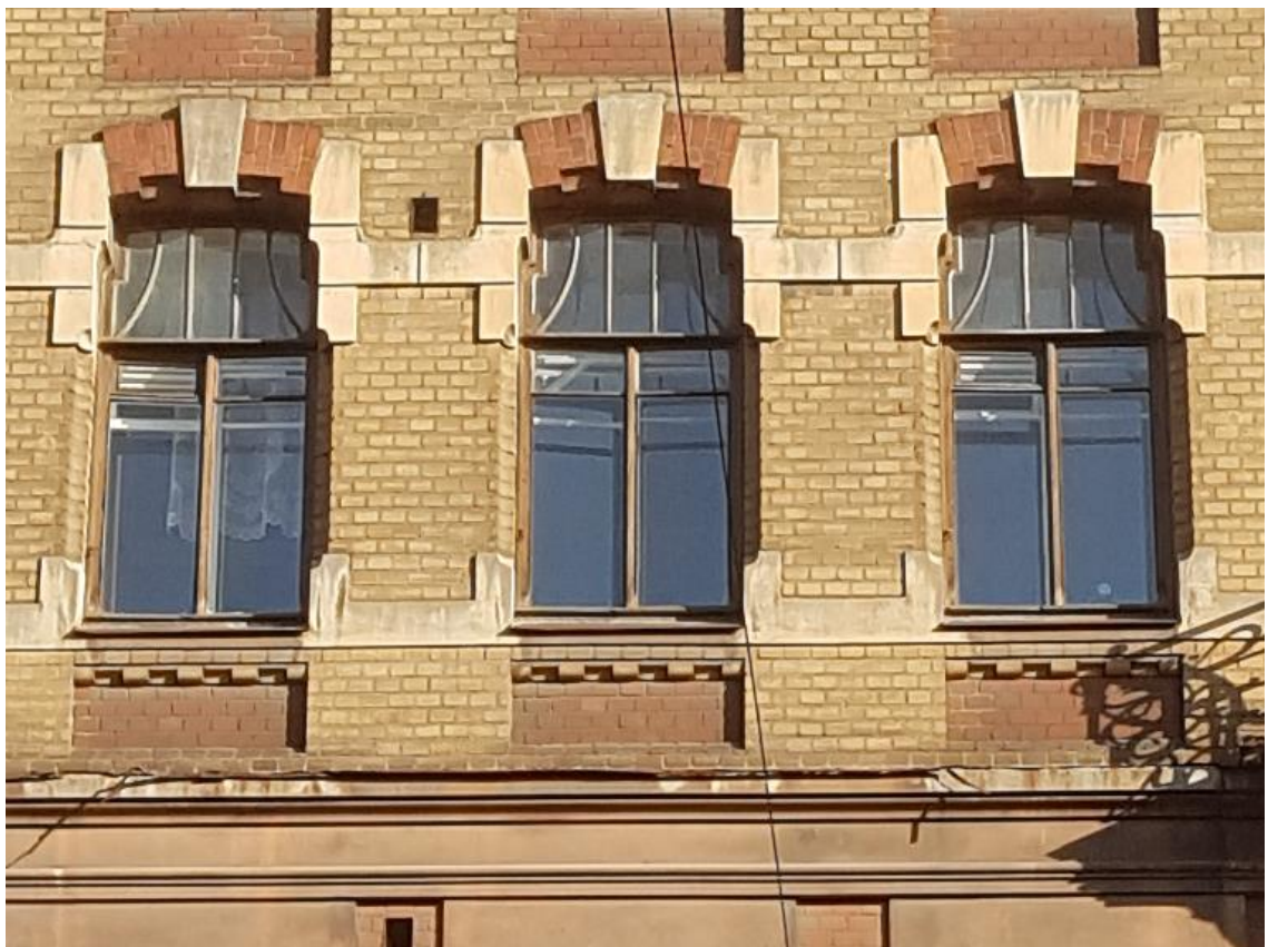
Фото 9. Оформление окон в уровне 4-го этажа. Лицевой фасад.
