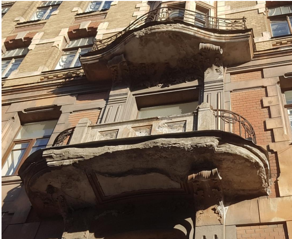
Фото 13. Балконы в уровне 3-го и 4-го этажей. Лицевой фасад.
