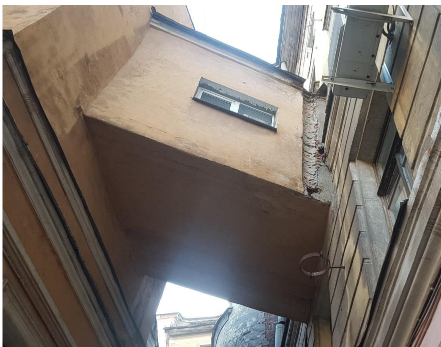
Фото 28. Переход, соединяющий объекты культурного наследия: «Доходный дом А.Ю. Тами и С.М. Дейчмана» и «Особняк П. Копылова»
