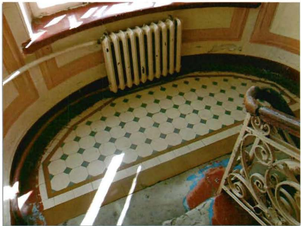
6. Оформление междуэтажных площадок парадной лестницы юго-западного объема здания.
