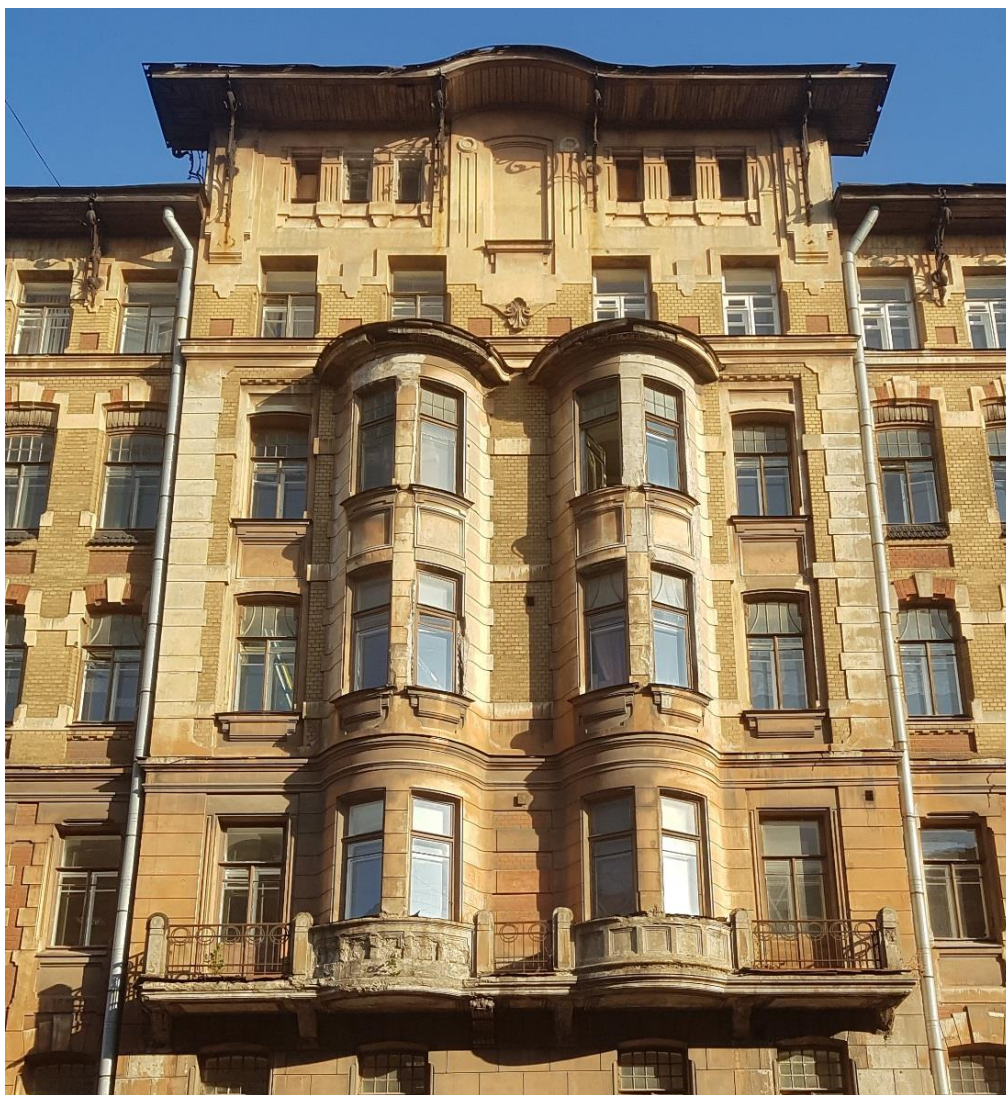
Фото 17. Центральная креповка в четыре световые оси. Лицевой фасад.
