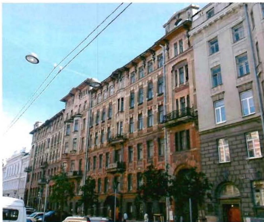
1. Лицевой фасад. Общий вид.
