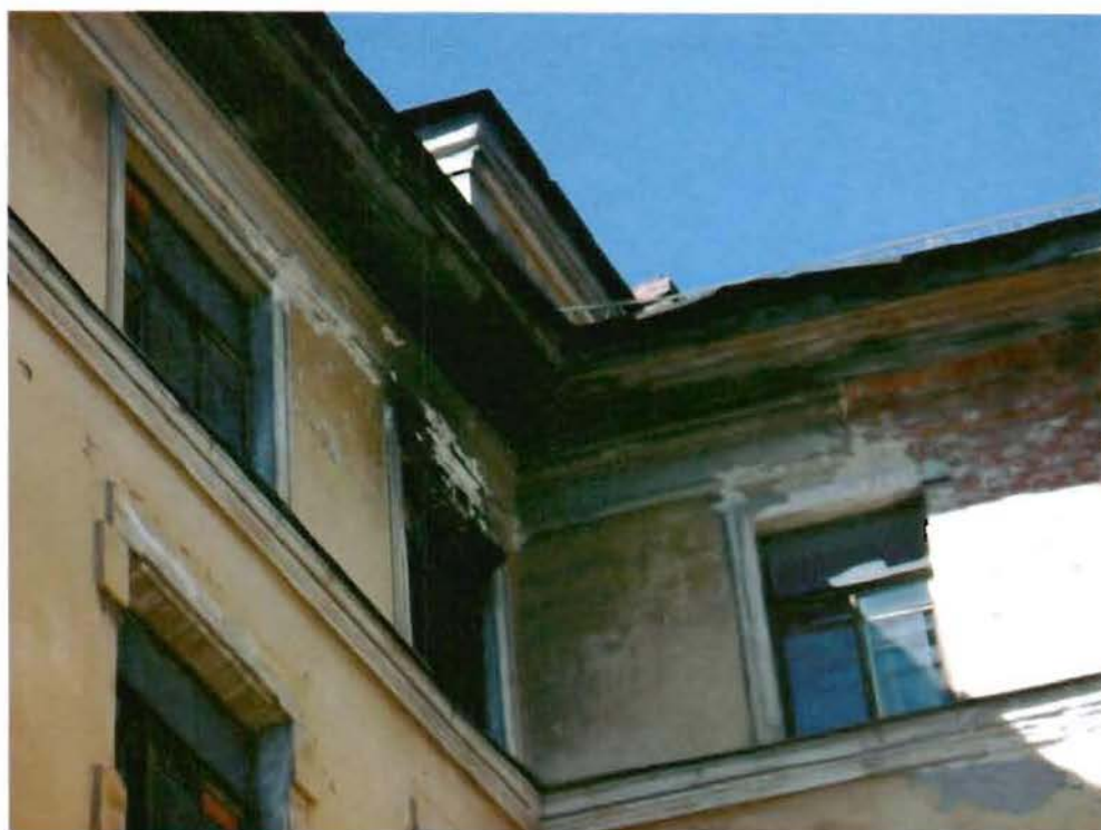
4. Венчающий карниз дворового фасада. Фрагмент.
