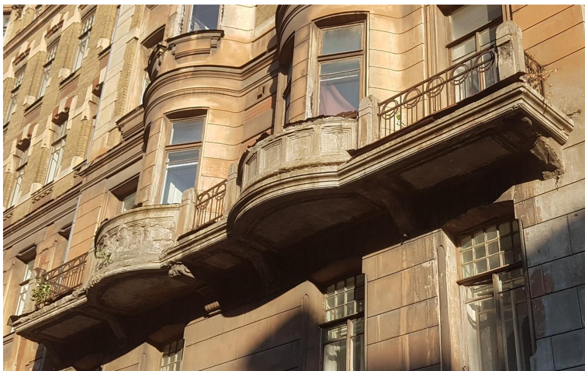
Фото 18. Балкон в уровне 3-го этажа по центральной оси лицевого фасада.
