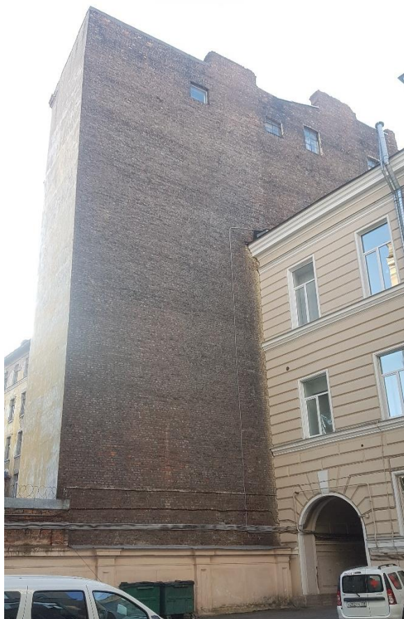
Фото 21. Брандмауэр. Вид со стороны двора дома №18 по ул. Правды.
