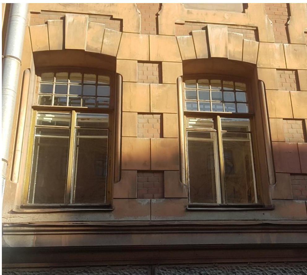
Фото 7. Оформление окон в уровне 2-го этажа. Лицевой фасад.
