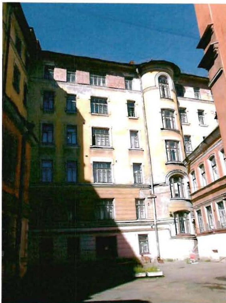
3. Дворовый фасад. Общий вид.
