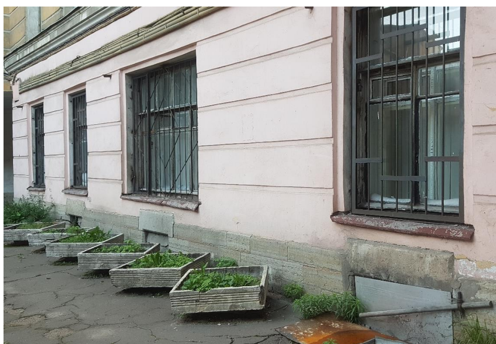
Фото 30. Оконные проемы в уровне подвала и 1-го этажа. Дворовой фасад.
