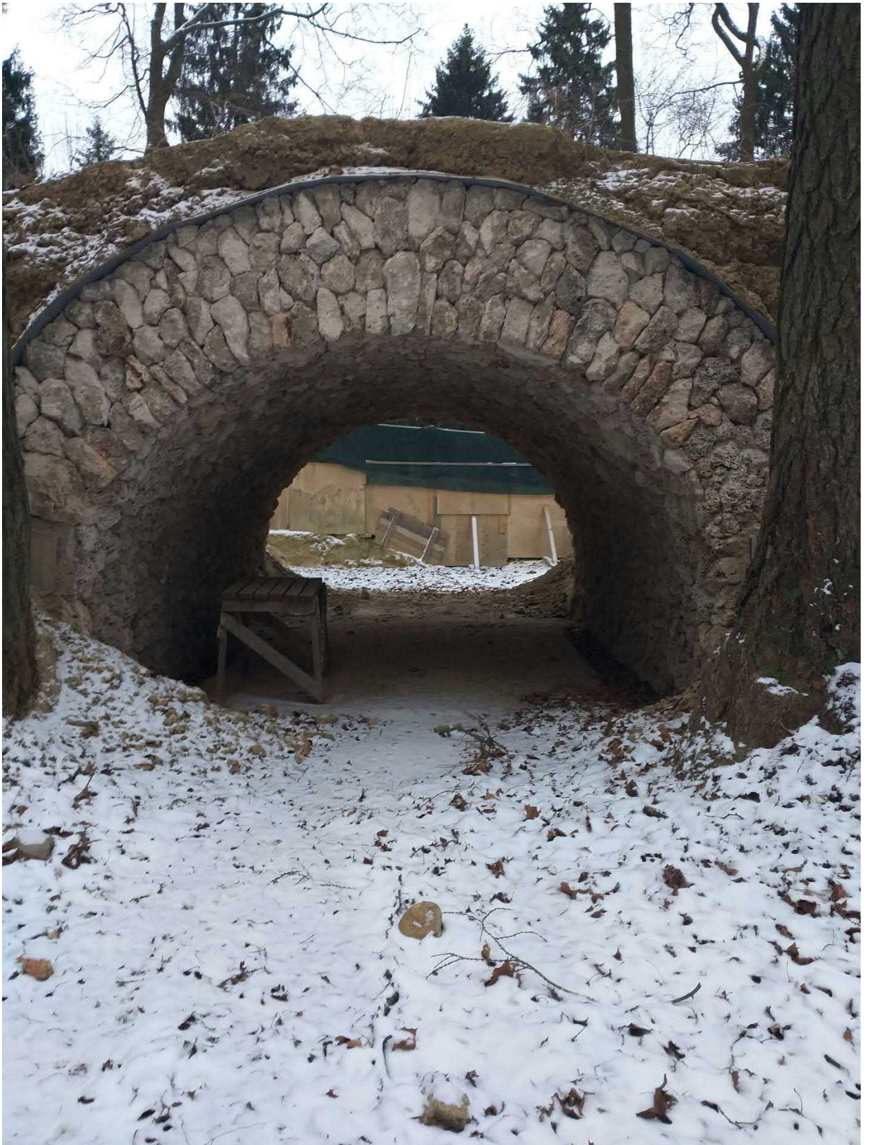
Фото 2. Туфовая арка. Северный вход
