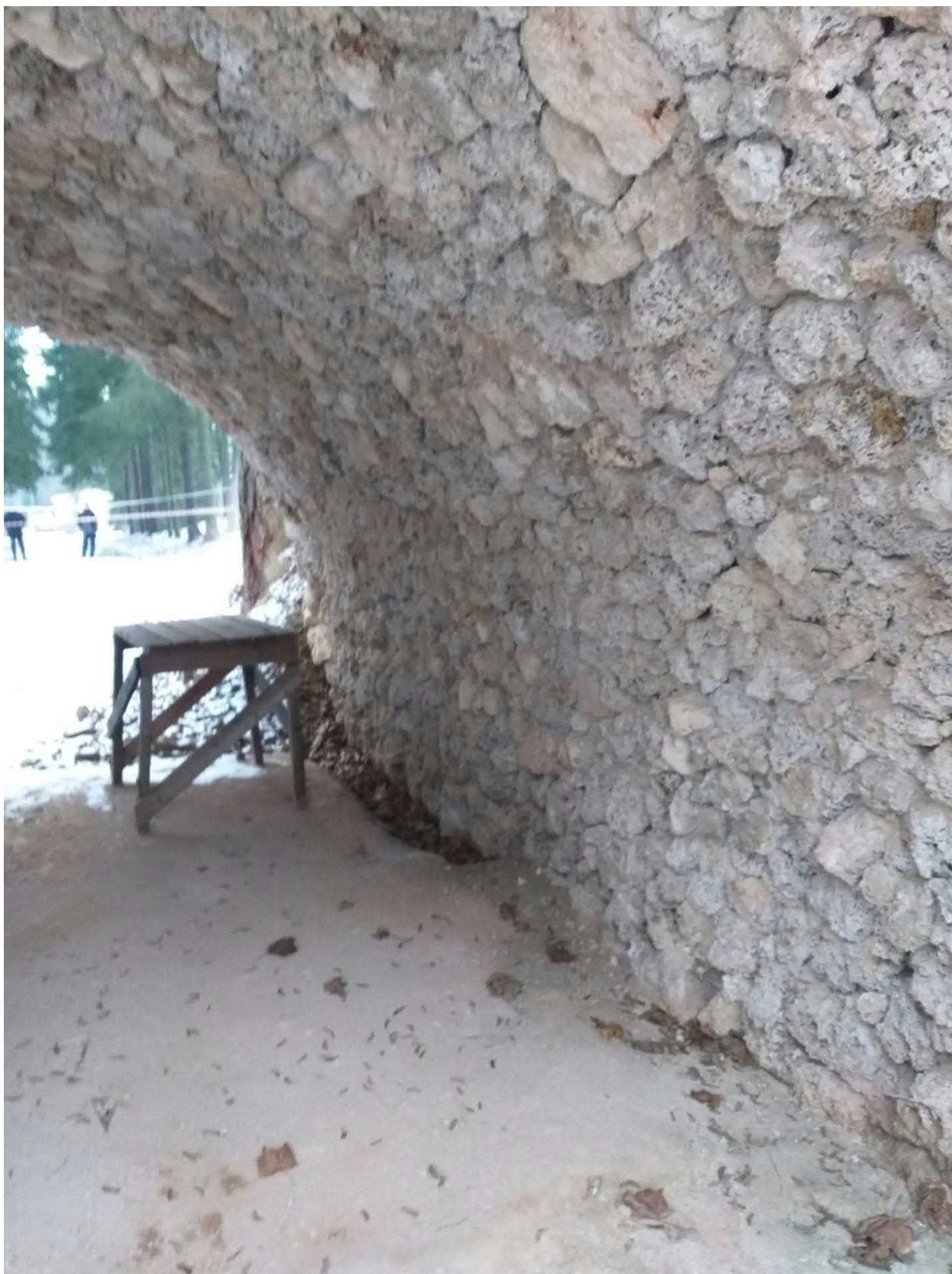
Фото 8. Туфовая арка. Подарочное пространство
