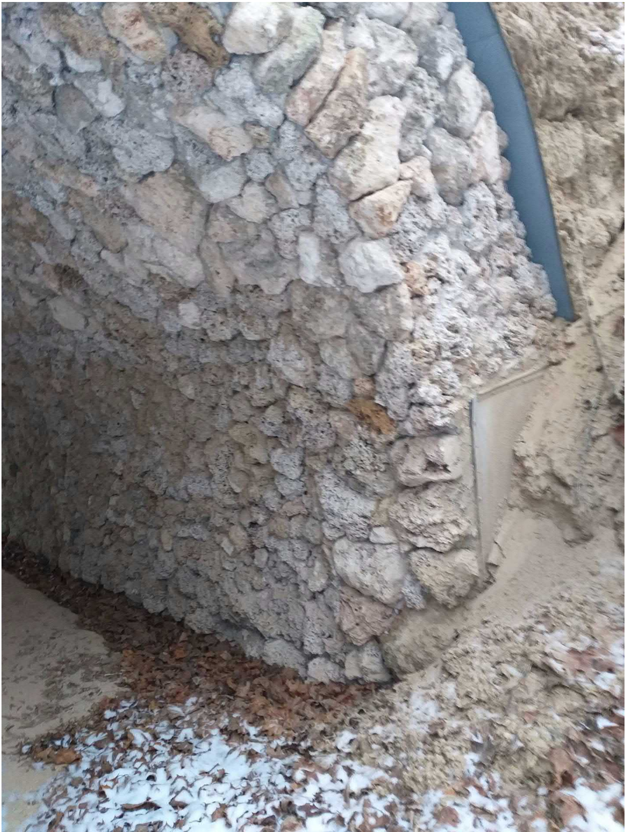
Фото 4. Туфовая арка. Подарочное пространство
