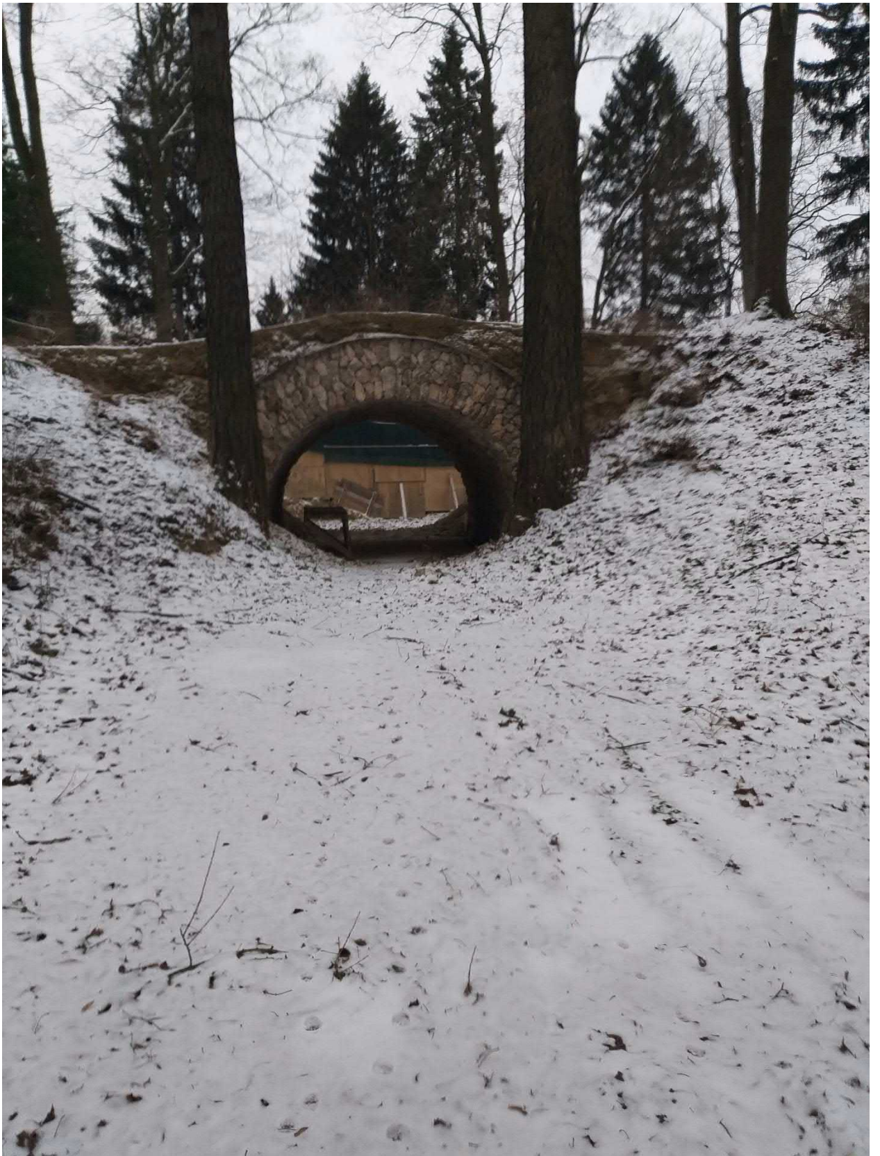
Фото 1. Туфовая арка. Северный вход
