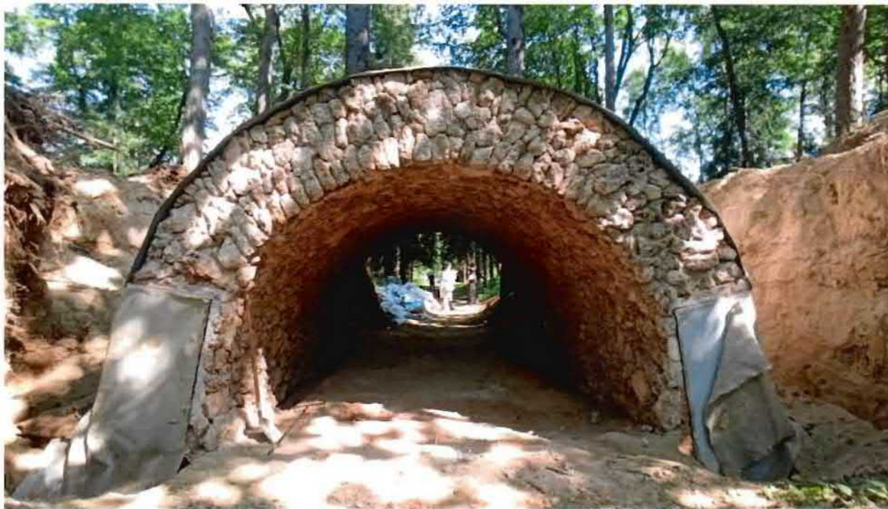
2. Вид на южный фасад объекта культурного наследия.
