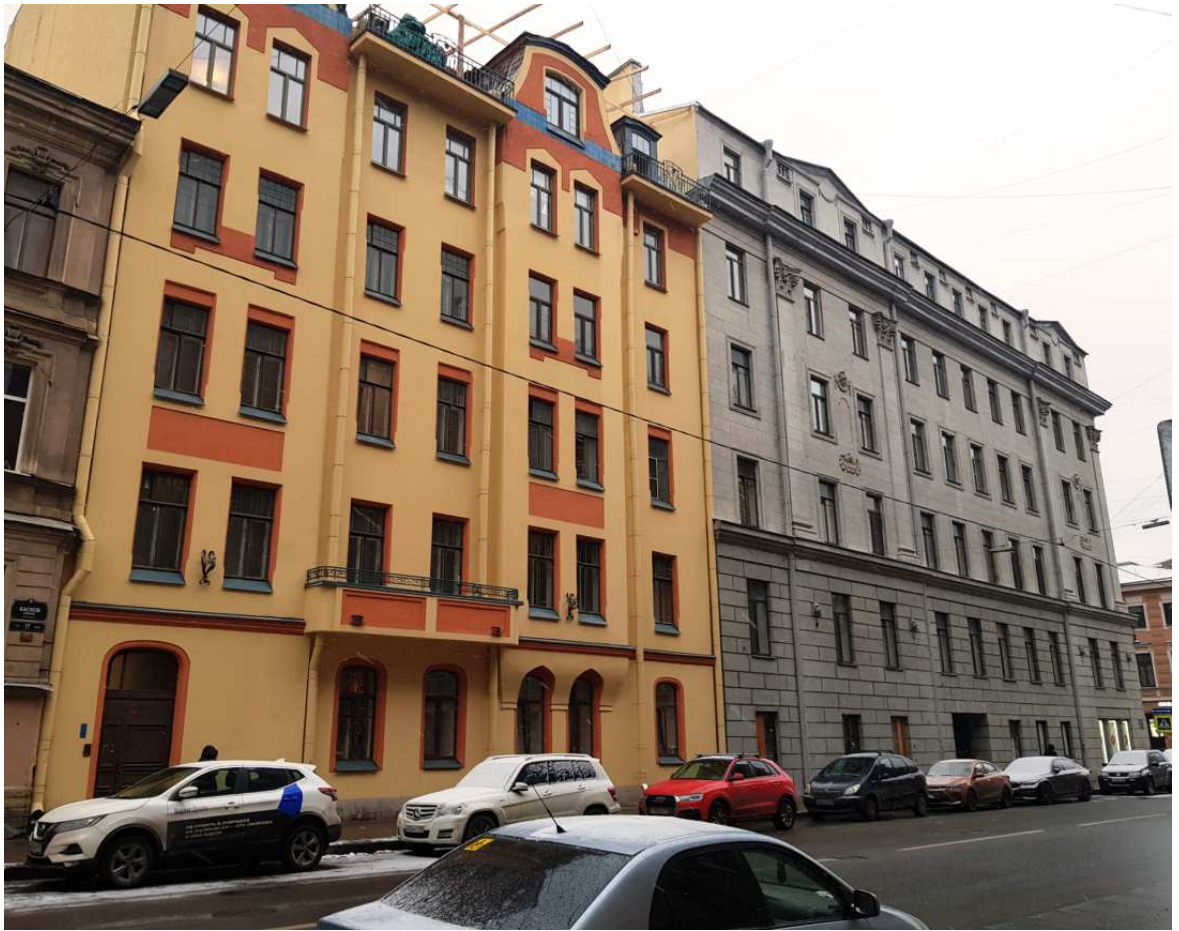
1. Выявленный объект культурного наследия «Доходный дом страхового общества «Россия»», общий вид северного фасада (по Баскову пер.)
