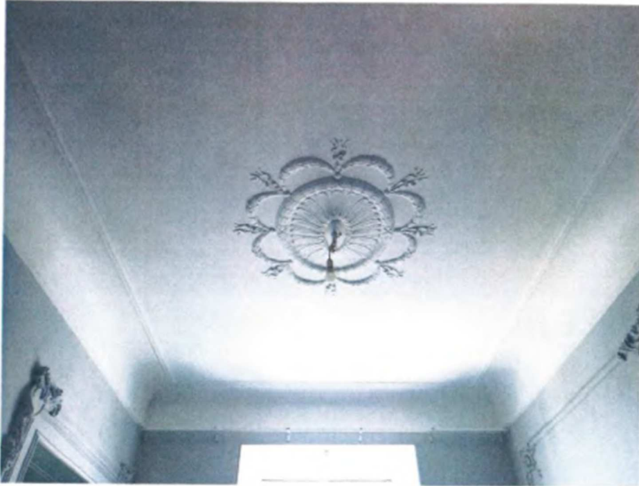
10. Басков пер., д. 13-15, лит. А, квартира № 3. Плафон комнаты (помещение 2 (16,9 м 2 ).
