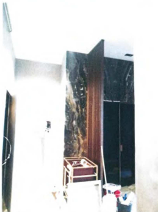
5. Басков пер., д. 13-15, лит. А. квартира № 3. Коридор (помещение 1 (15.8 м 2 )).
