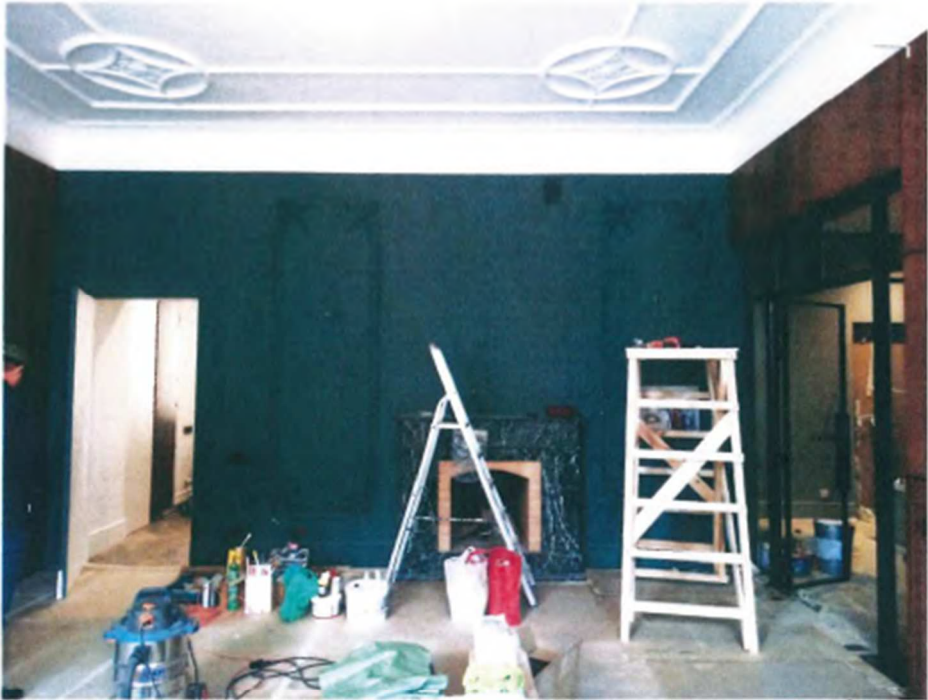
13. Басков пер., д. 13-15, лит. А, квартира № 3. Комната (помещение 3 (43,1 м 2 )).
