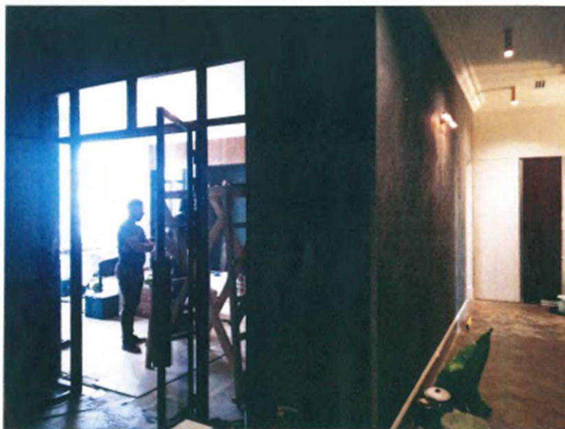
7. Басков пер., д. 13-15, лит. А, квартира № 3. Увеличена толщина перегородки и расширен дверной проем в комнату (помещение 3 (43,1 м 2 ), демонтирована перегородка между коридором (помещение 1 (15,8 м 2 ) и коридором (помещение 5 (10 м 2 )).
