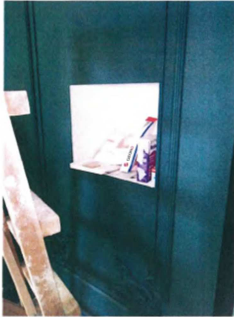
15. Басков пер., д. 13-15, лит. А, квартира № 3. Комната (помещение 3 (43,1 м 2 )). Ниша в стене
