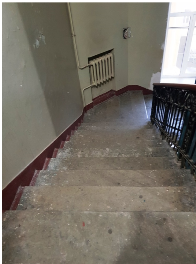
4. Общедомовая лестничная клетка.
