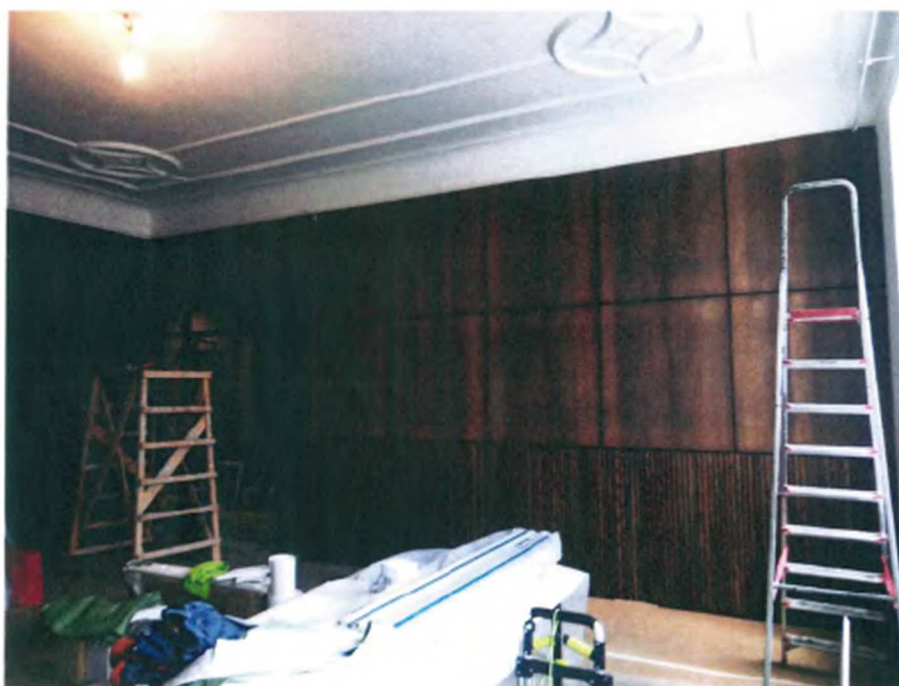
18. Басков пер., д. 13-15, лит. А, квартира № 3. Комната (помещение 3 (43,1 м 2 )).
