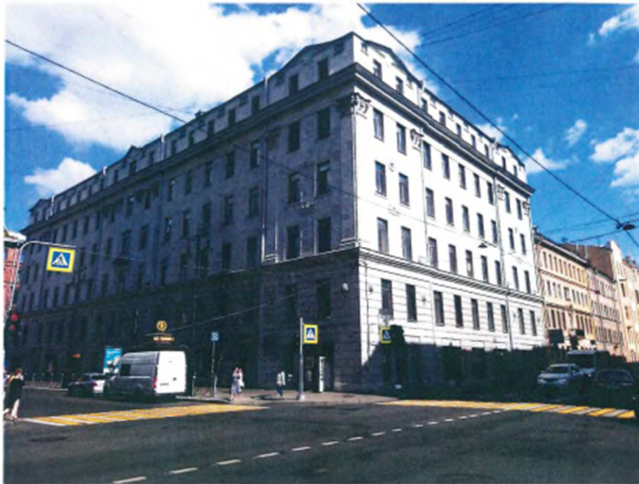
1. Басков пер., д. 13-15, лит. А. Общий вид здания. Вид с юго-запада
