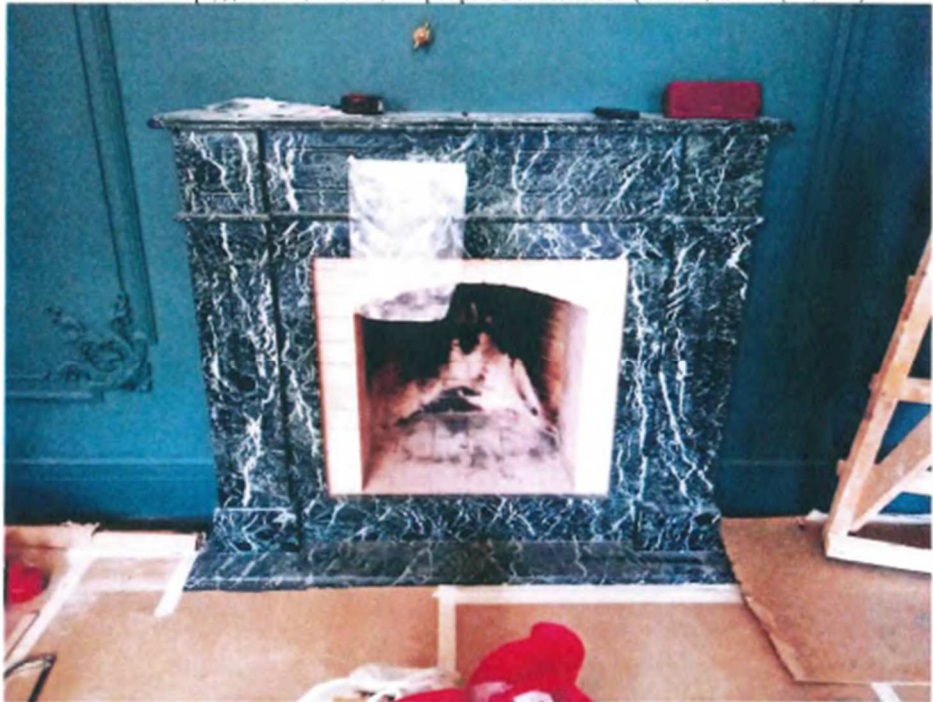
14. Басков пер., д. 13-15, лит. А, квартира № 3. Камин в комнате (помещении 3 (43,1 м 2 )).
