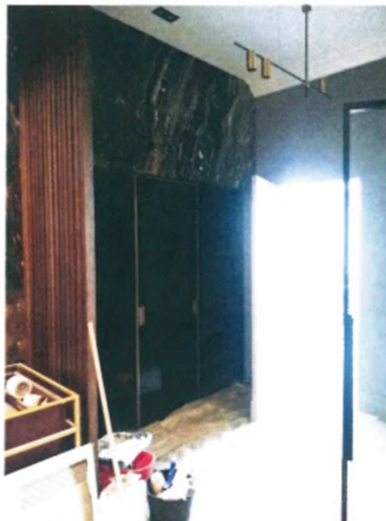
6. Басков пер., д. 13-15, лит. А, квартира № 3. Коридор (помещение 1 (15,8 м 2 )).
