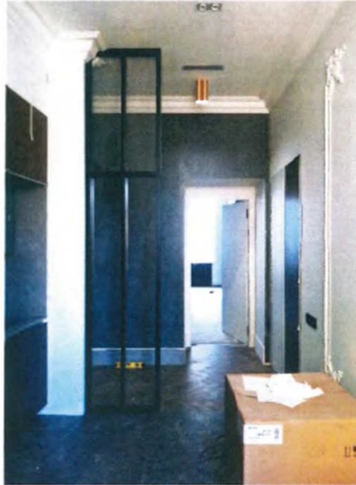
21. Басков пер., д. 13-15, лит. А, квартира № 3. Кухня (помещение 6 (10,9 м 2 )). Демонтирована часть перегородки между коридором (помещение 5 (10 м 2 ))
