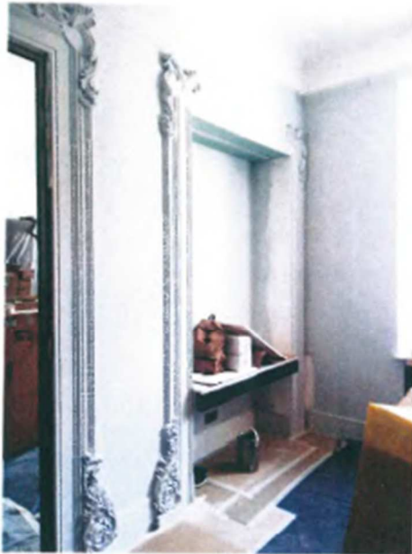
11. Басков пер., д. 13-15, лит. А, квартира № 3. Комната (помещение 2 (16,9 м 2 ).
