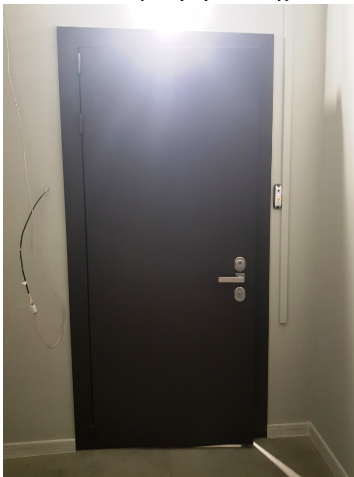
6. Дверное заполнение входа в квартиру №3.
