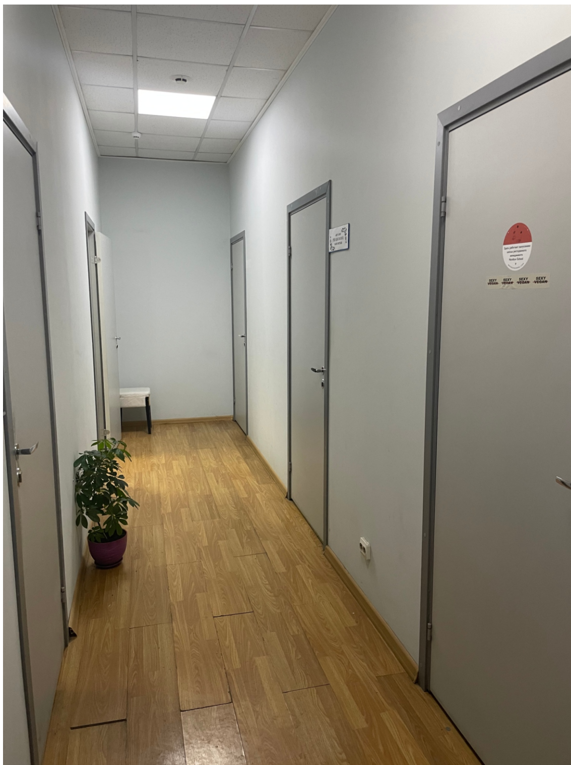
14. «Дом Д.А.Дурдина». Кирочная ул., д.12, литера А. Интерьер помещения 9-Н в уровне 2-го этажа. Фрагмент. Фото: 25.01.2023.
