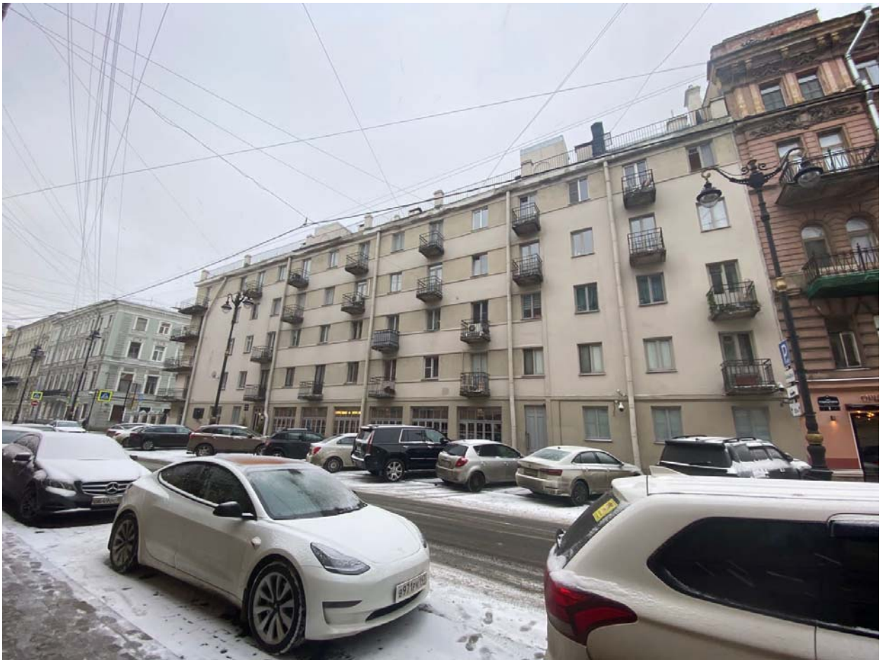
Фото №1. Лицевой фасад по улице Рубинштейна.
