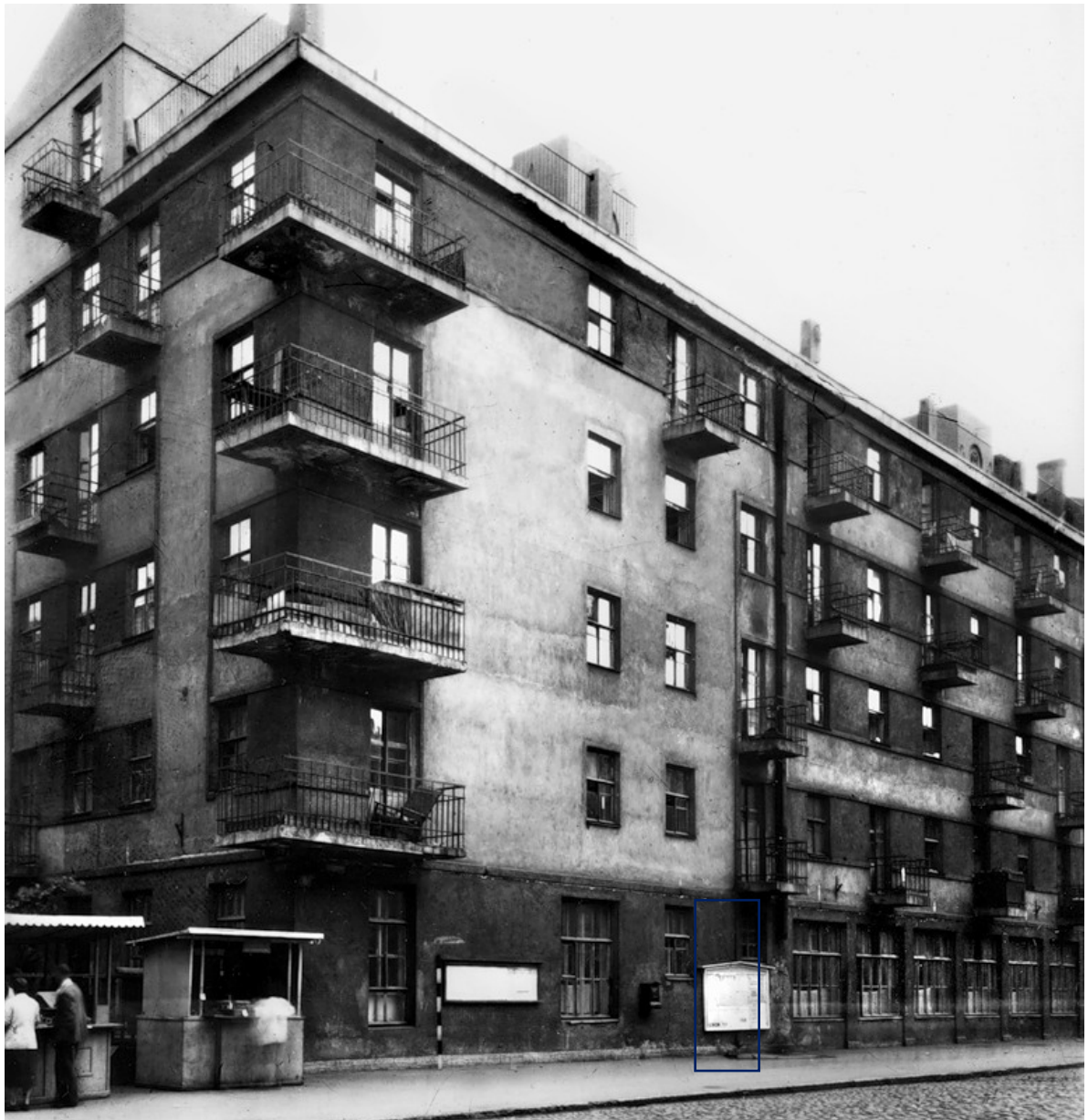
Илл. 1. Фотография 1955-1965 гг. Вид с юга, с пересечения ул. Рубинштейна и Графского переулка. Источник: http://retro-piter.livejournal.com/219016.html . Оконный проем, на месте которого позднее устроен дверной проем.
