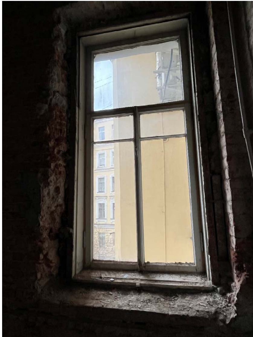
Фото №12. Квартира №17, деревянное оконное заполнения.
