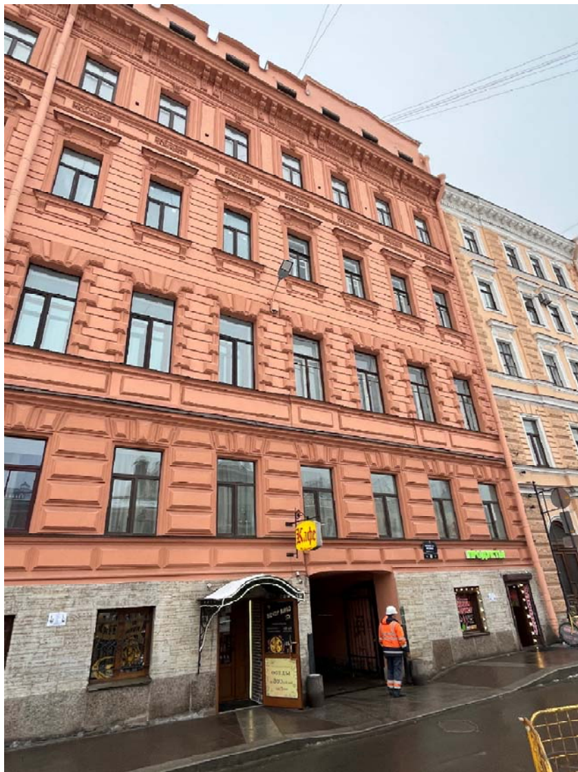
Фото №2. Западный лицевой фасад по наб. р. Фонтанки, фрагмент.
