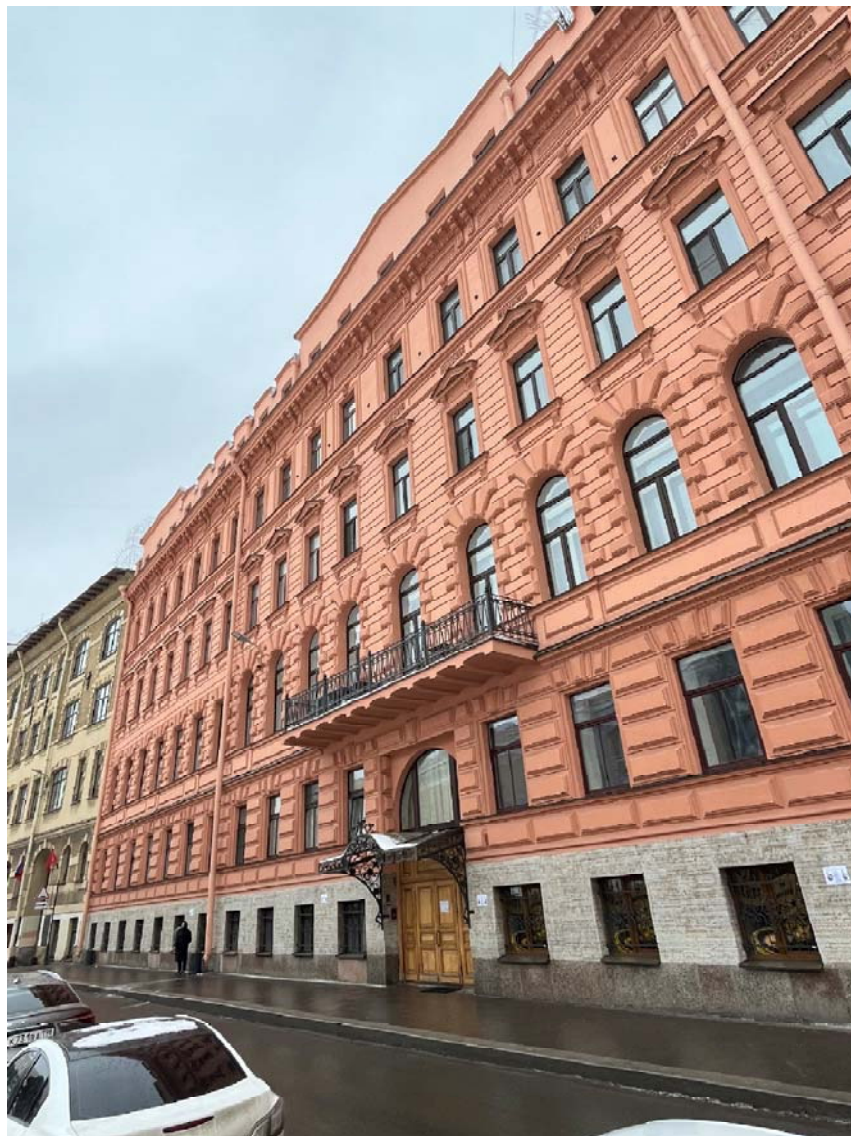
Фото №3. Западный лицевой фасад по наб. р. Фонтанки, фрагмент.
