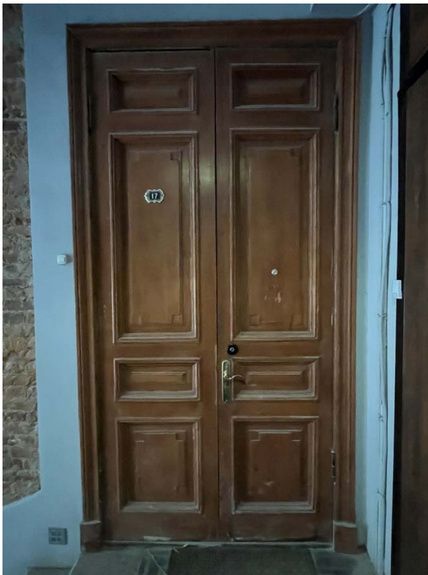
Фото №14. Квартира №17, деревянное дверное заполнение входа в квартиру.
