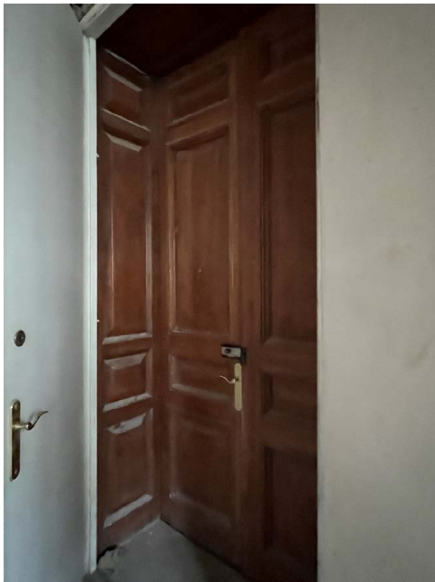
Фото №13. Квартира №17, деревянное дверное заполнение входа в квартиру.
