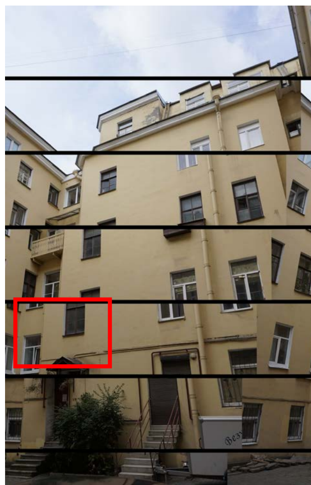
Фото 3. Оконные проемы квартиры № 34. Дворовый фасад.
