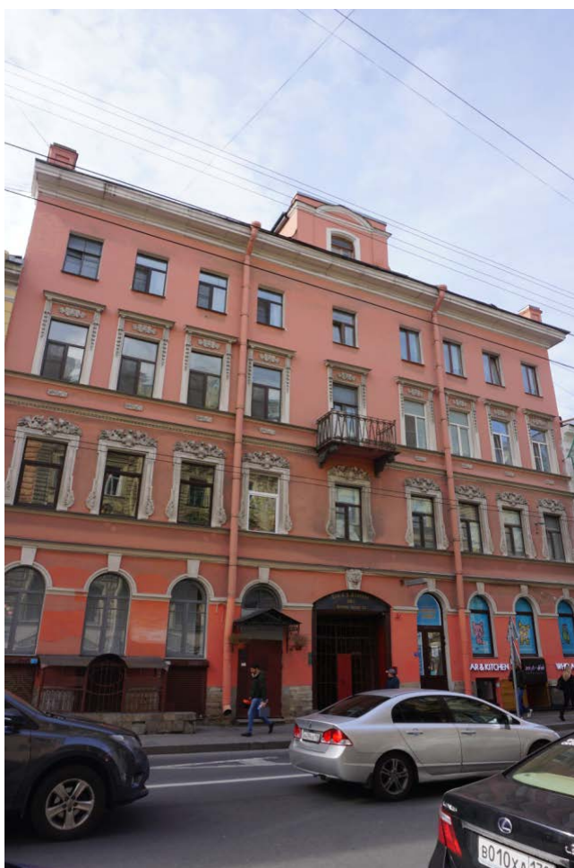
Фото 2. Лицевой фасад, дома № 39, выходящий на Гороховую улицу.
