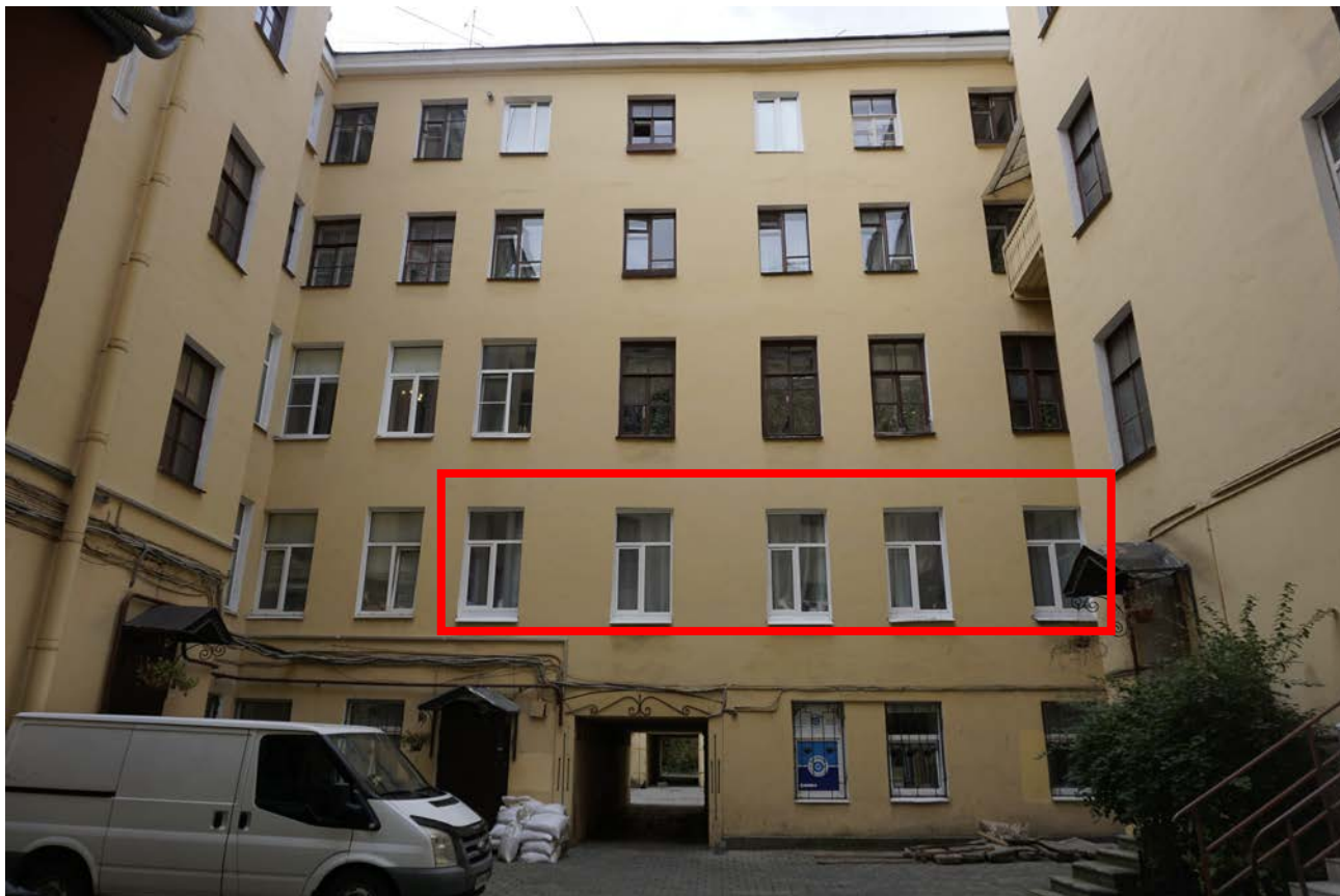
Фото 4. Оконные проемы квартиры № 34. Дворовый фасад.
