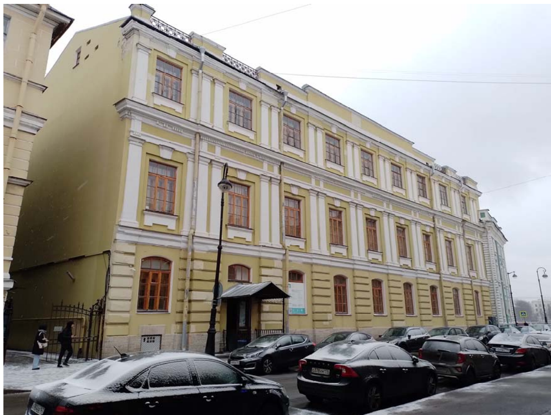
Фото 7. Корпус по Таможенному переулку. Вид с северной стороны. Съемка 24.01.2023 г. Трушковский В.Э.
