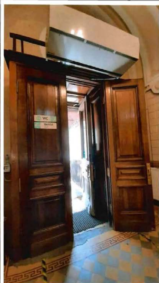
13. Тамбур парадного входа
