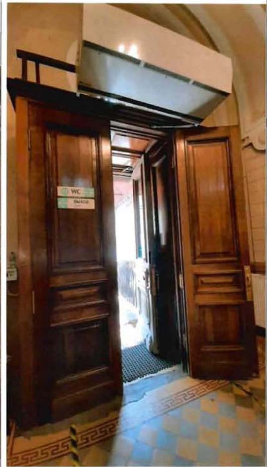
13. Тамбур парадного входа
