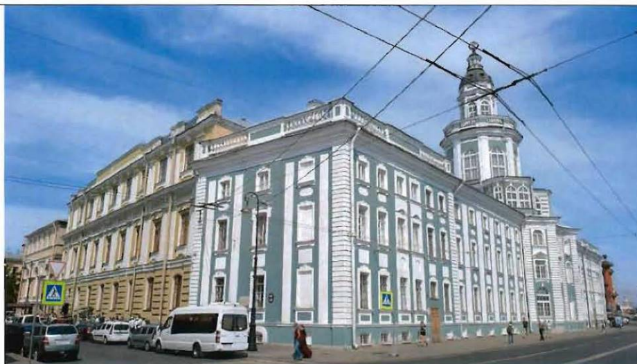
1. Общий вид объекта культурного наследия
