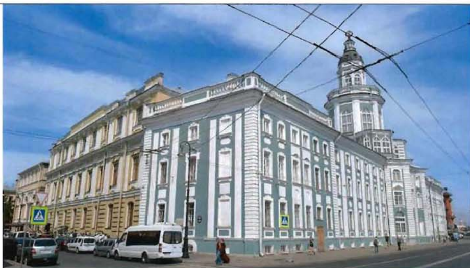
1. Общий вид объекта культурного наследия
