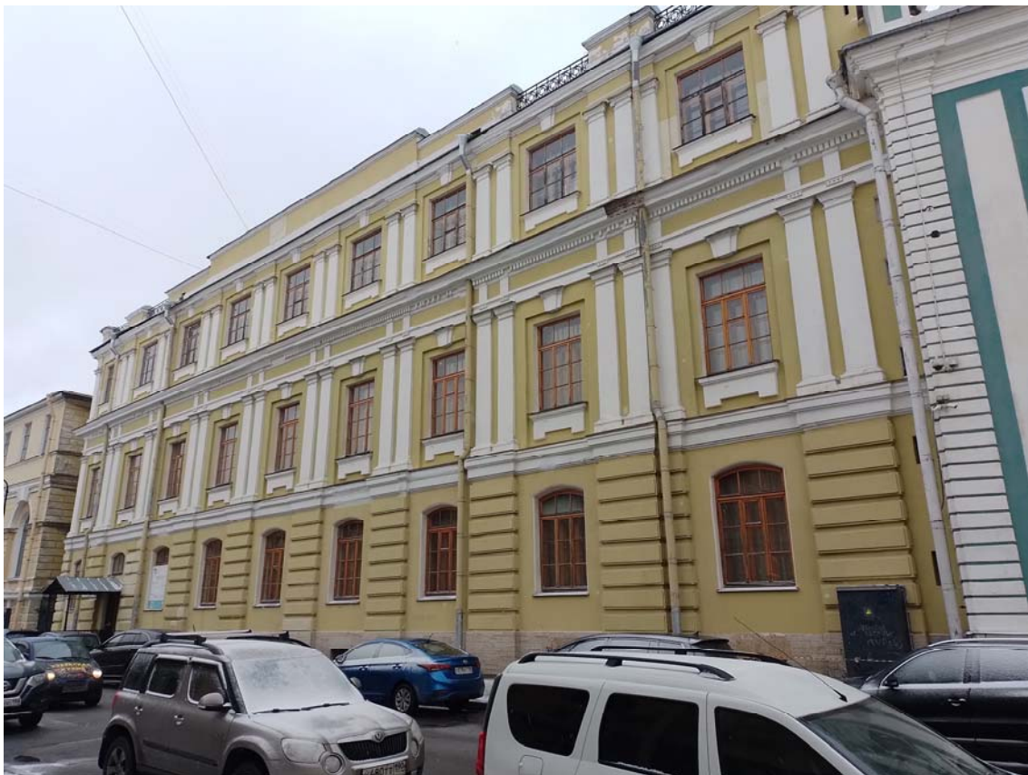
Фото 3. Корпус по Таможенному переулку. Лицевой фасад. Вид с южной стороны. Съемка 24.01.2023 г. Трушковский В.Э.
