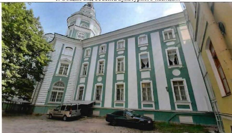
2. Фрагмент дворового фасада корпуса по Университетской набережной
