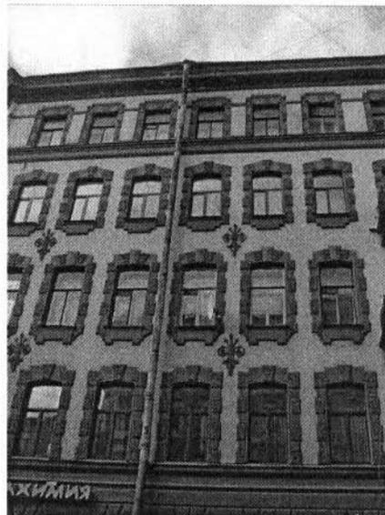
профилированные наличники, рустованное обрамление, замковые камни в виде веерного руста оконных проемов 1-го этажа;
