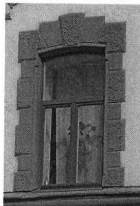
профилированные наличники (линейный руст и руст «под шубу»), замковые камни с бриллиантовым рустом, фигурные филенки в подоконном пространстве оконных проемов 3-го этажа;
