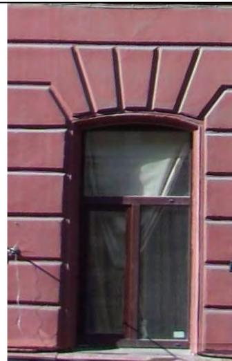
профилированные наличники (линейный руст и руст «под шубу»), рустованные замковые камни оконных проемов 2-го этажа;
