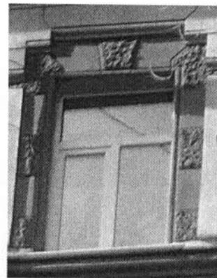
венчающий профилированный раскрепованный карниз;
