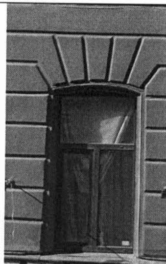
профилированные наличники (линейный руст и руст «под шубу»), замковые камни оконных проемов 2-го этажа;
