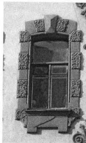
профилированные наличники (линейный руст и руст «под шубу»), замковые камни, фигурные филенки в подоконном пространстве оконных проемов 4-го этажа;
