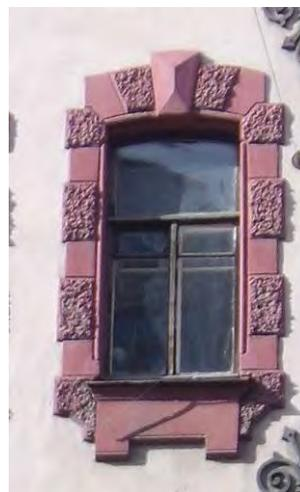
профилированные наличники (линейный руст и руст «под шубу»), рустованные замковые камни, фигурные филенки в подоконном пространстве оконных проемов 4-го этажа;
