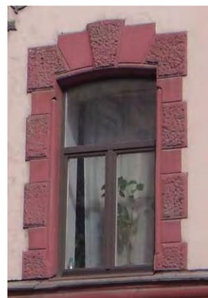
профилированные наличники (линейный руст и руст «под шубу»), рустованные замковые камни с бриллиантовым рустом, фигурные филенки в подоконном пространстве оконных проемов 3-го этажа;
