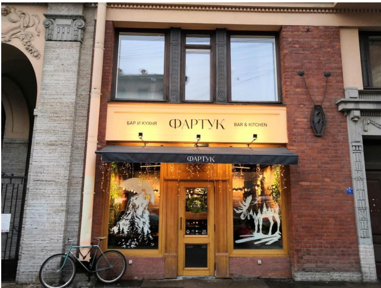
Фото 2. Фрагмент лицевого фасада по ул. Рубинштейна. Вид на входную группу помещения 2-Н
