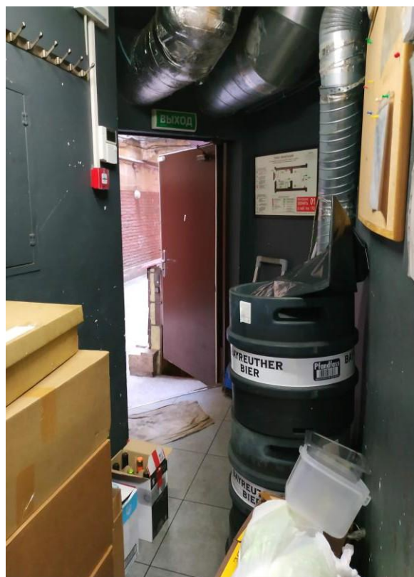
Фото 15. Помещение 2-Н (ч.п. 6)
