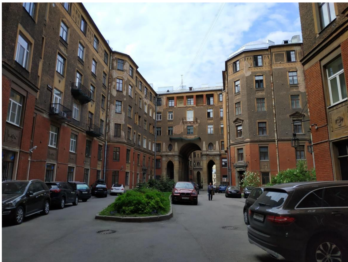
Фото 6. Дворовые фасады здания
