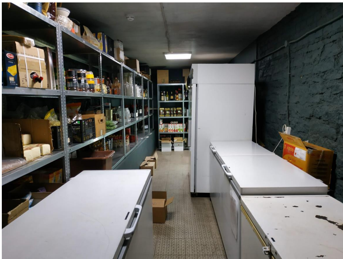
Фото 27. Помещение 2-Н (ч.п. 14)
