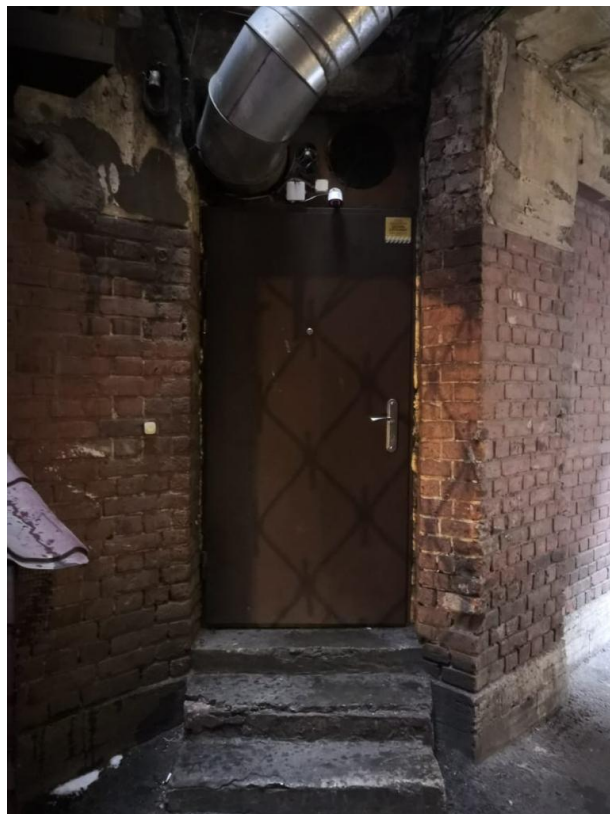
Фото 13. Вид на дверной проем, ведущий в помещения 2-Н, со стороны двора-колодца
