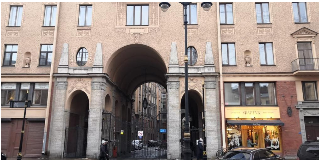
Фото 3. Фрагмент лицевого фасада по ул. Рубинштейна
