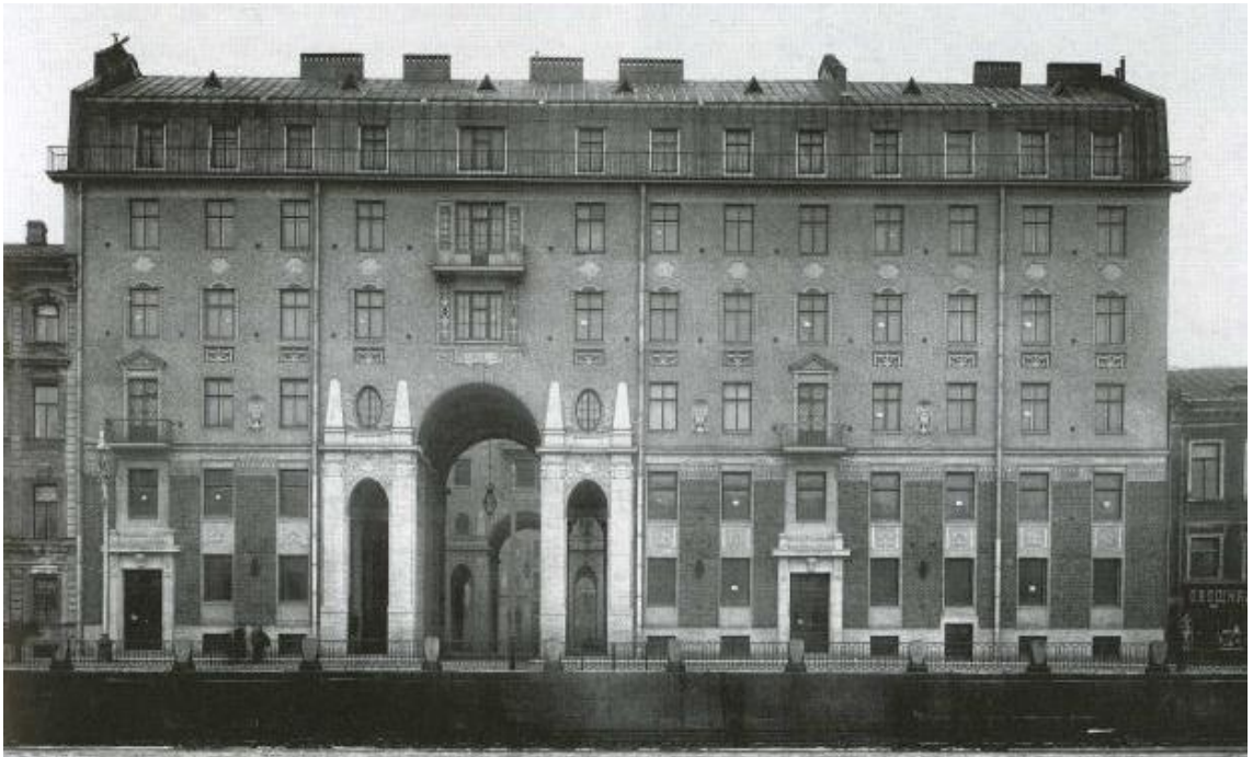
23. Доходный дом графа М. П. Толстого по наб. реки Фонтанки. 1912 г. — Citywalls.ru — архитектурный сайт Петербурга [Электронный ресурс]. URL: http://www.citywalls.ru .
