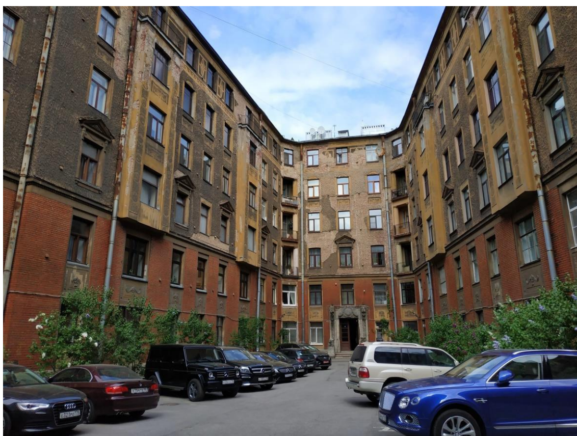
Фото 7. Дворовые фасады здания
