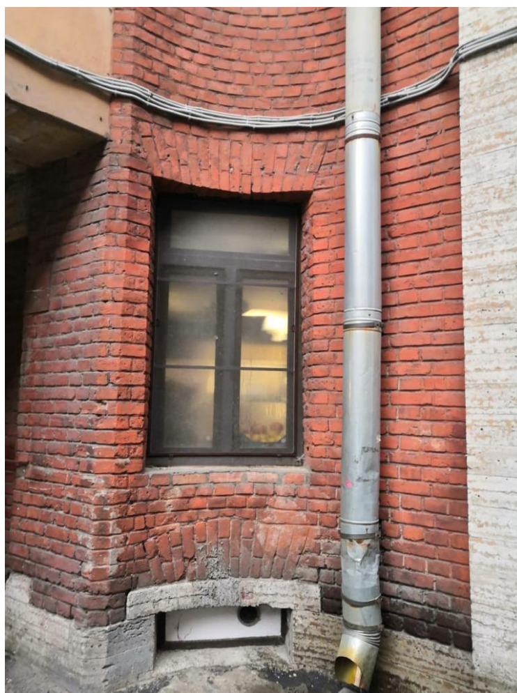
Фото 11. Вид на оконные проемы помещения 2-Н со стороны дворового фасада и воротный проезд, ведущий во двор-колодец
