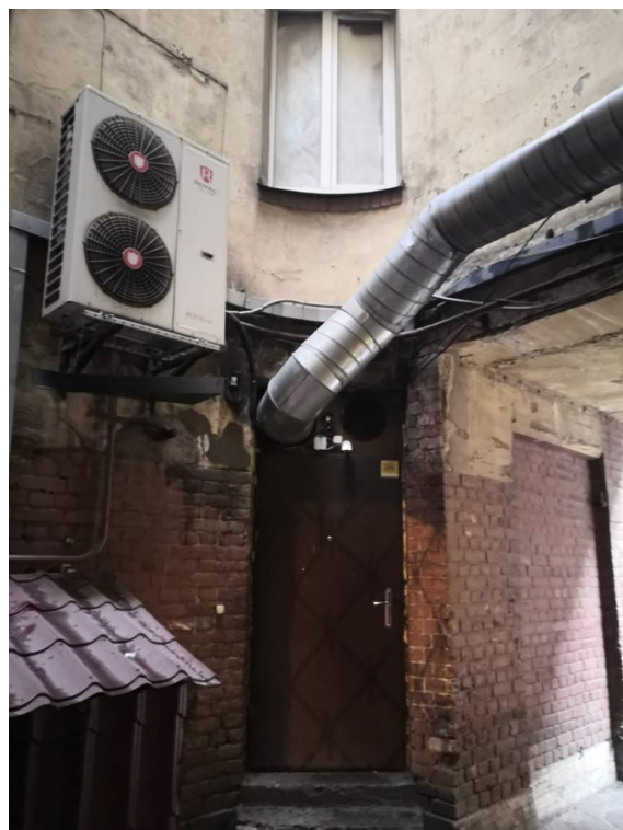
Фото 14. Вид на дверной проем, ведущий в помещения 2-Н, со стороны двора-колодца
