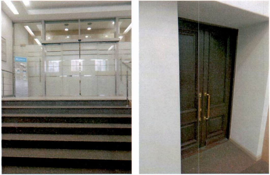
Фото №10, 11. Входные группы тамбура 1-го этажа.
