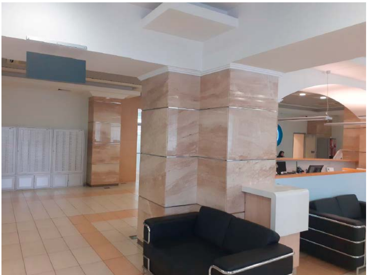
9. Помещение холла №37 объекта культурного наследия регионального значения «Комплекс казарм Семеновского и Егерского полков. Солдатская казарма» расположенного по адресу: г. Санкт-Петербург, Звенигородская ул., д. 3, литера А. 23.11.2020.
