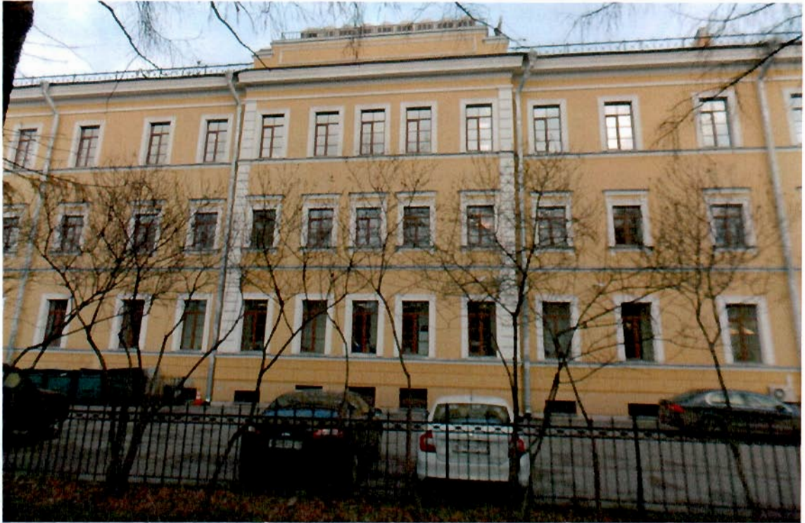
Фото №3. Дворовой фасад. Вид со стороны сада Театра юных зрителей.
