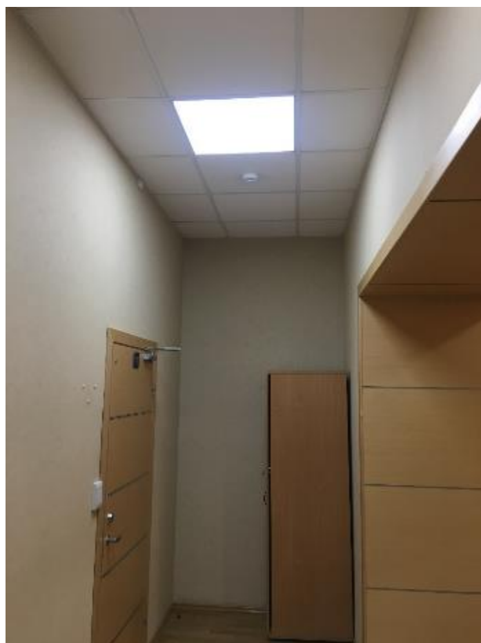
39. Помещение №10 объекта культурного наследия регионального значения «Комплекс казарм Семеновского и Егерского полков. Солдатская казарма». 23.11.2020.
