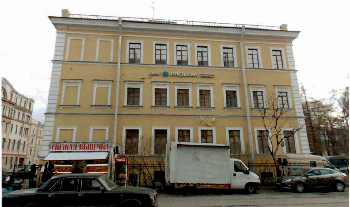
Фото №4. Торцевой (северо-западный) фасад.
