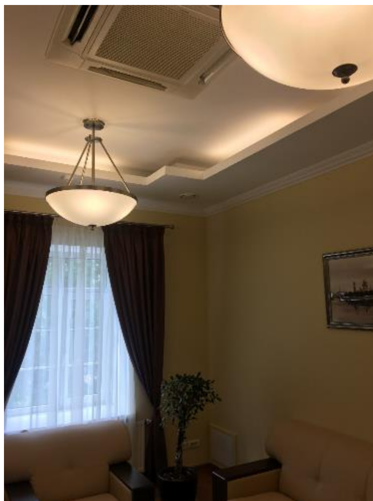
45. Помещение №34 объекта культурного наследия регионального значения «Комплекс казарм Семеновского и Егерского полков. Солдатская казарма». 23.11.2020.
