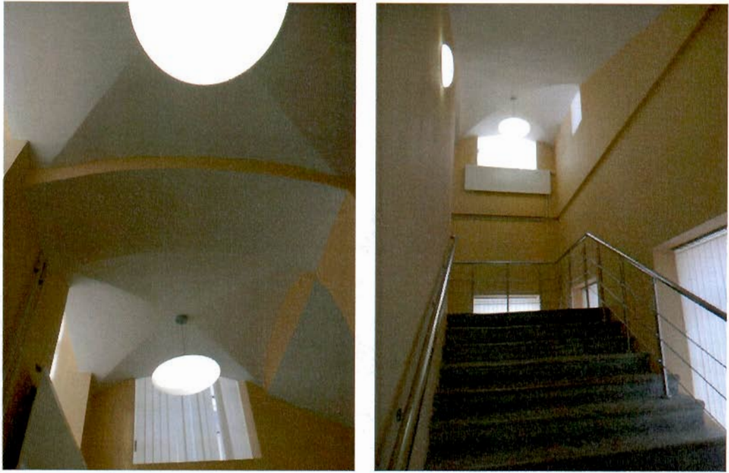
Фото №7, 8. Сводчатые перекрытия лестниц и лестничный марш.
