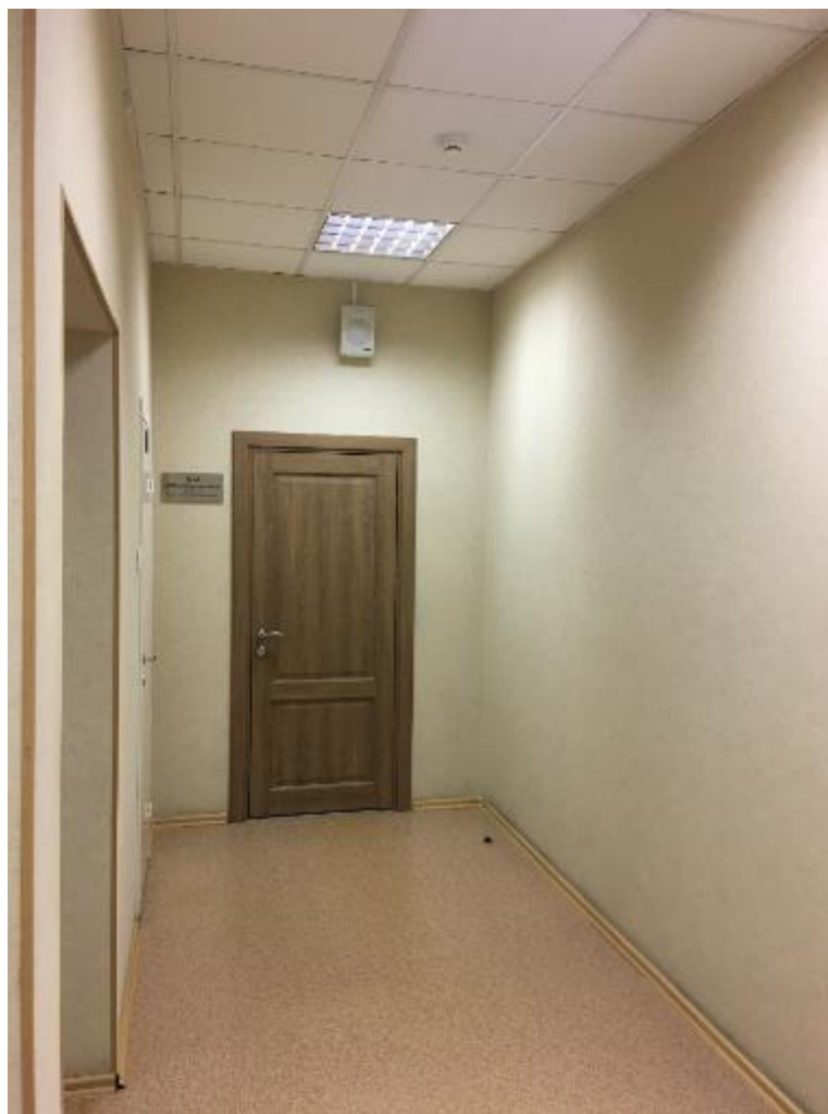
31. Помещение №23 объекта культурного наследия регионального значения «Комплекс казарм Семеновского и Егерского полков. Солдатская казарма». 23.11.2020.
