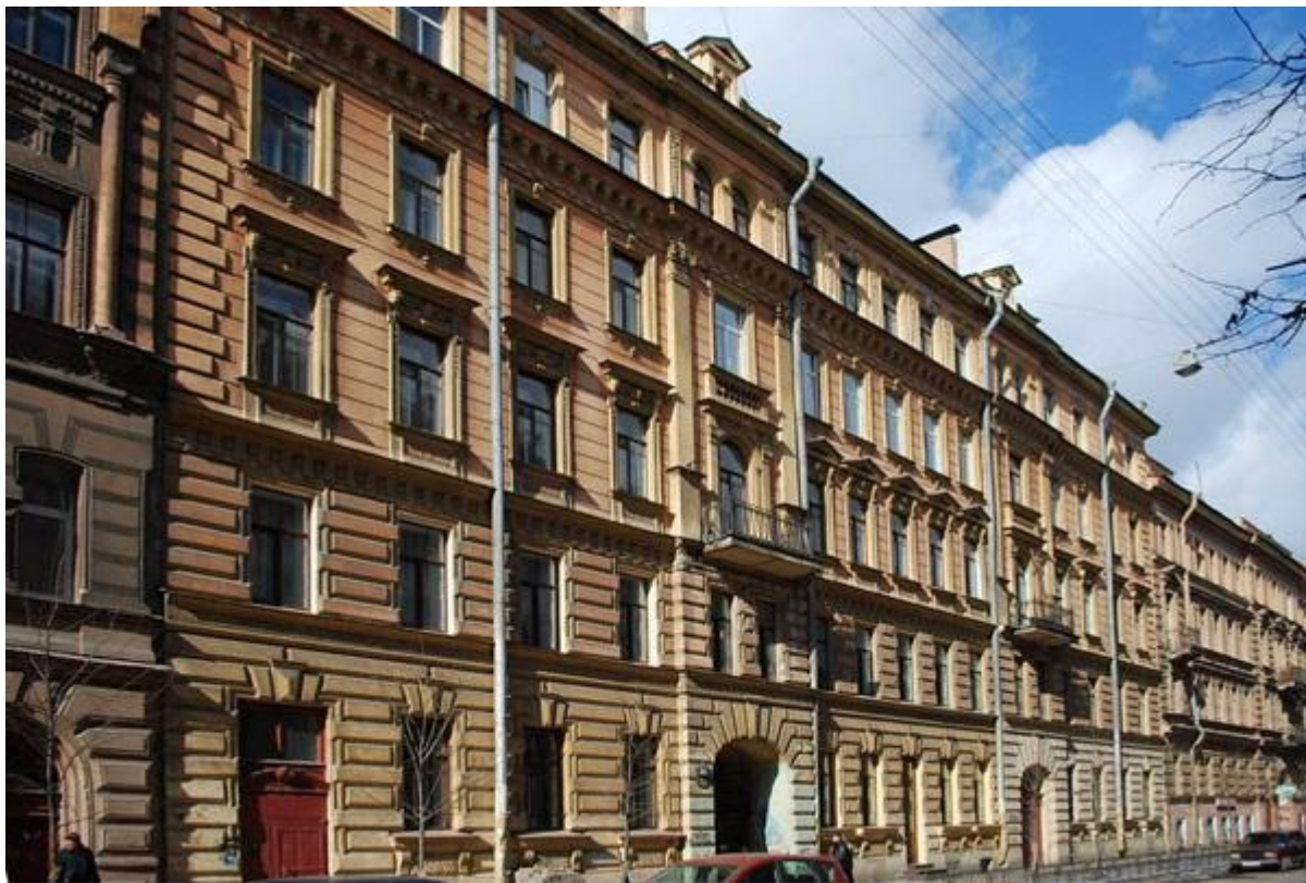
Илл. 26. Доходный дом И.А. Афанасьева - Доходный дом М.И. Афанасьева. Ул. Пушкинская, д. 17.2009 г. https://www.citywalls.ru/photo21502.html
