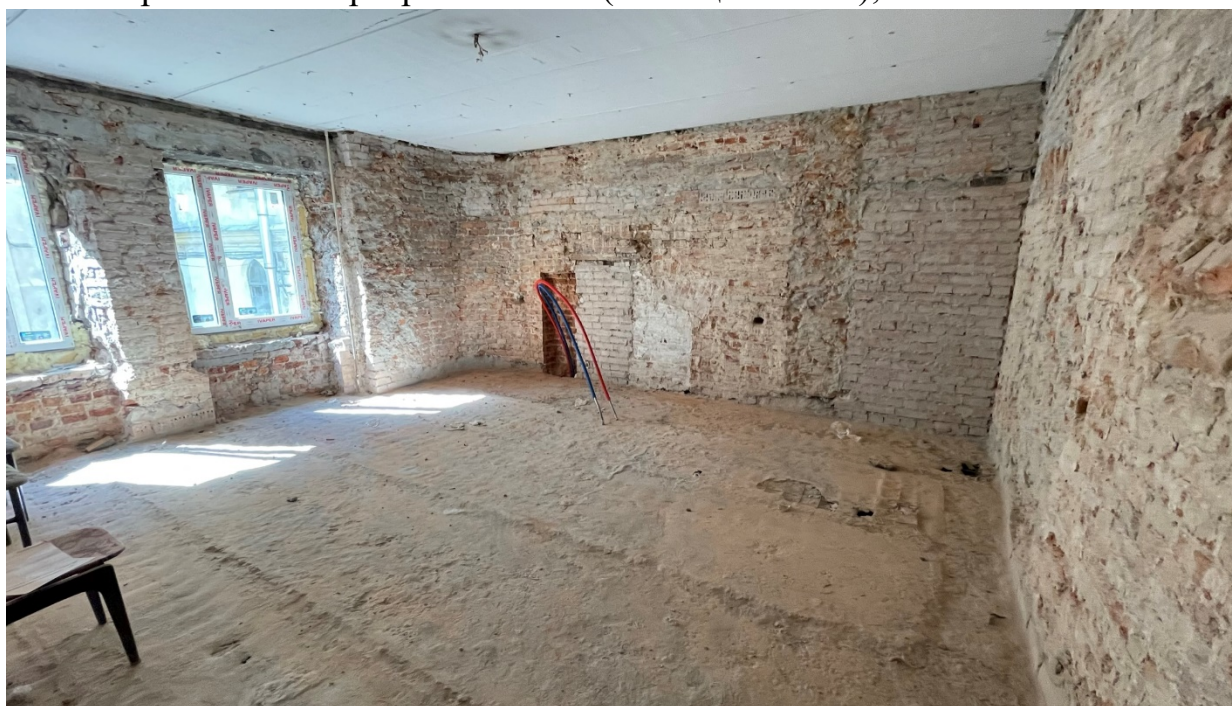
11. Вид на холл из коридора (помещение №6);
