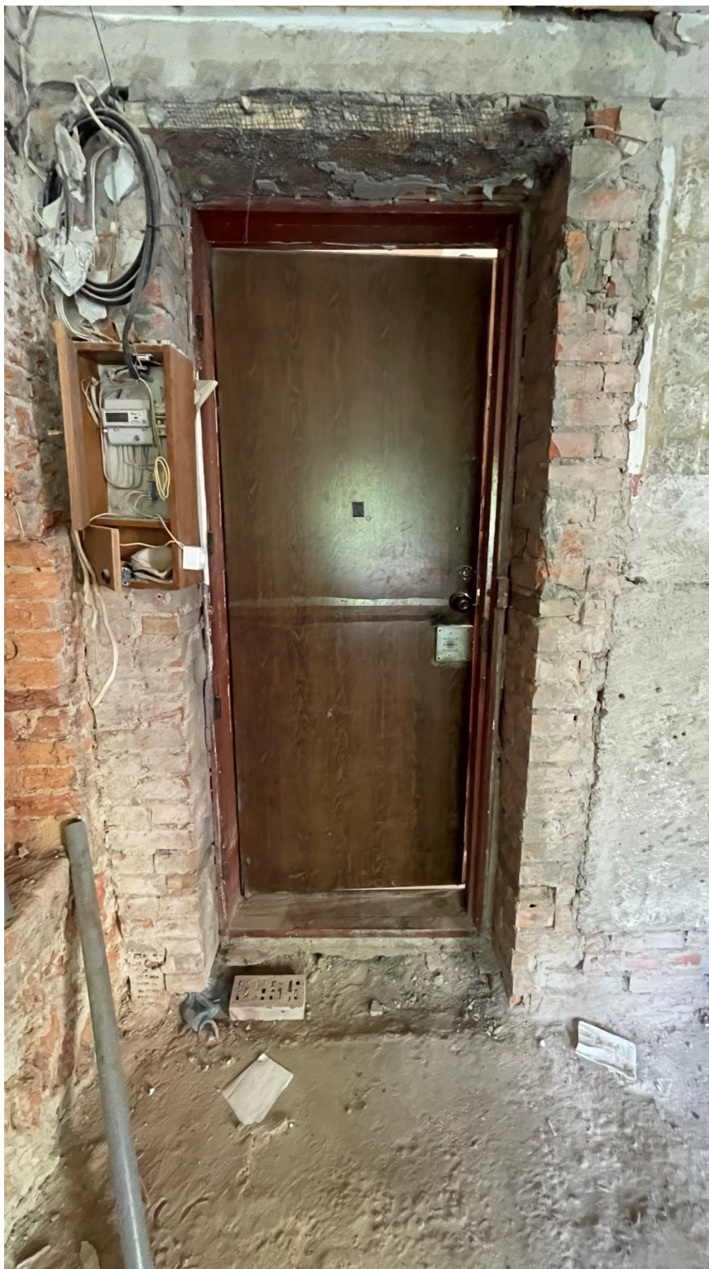
5. Вид на входную дверь в квартире №14;
