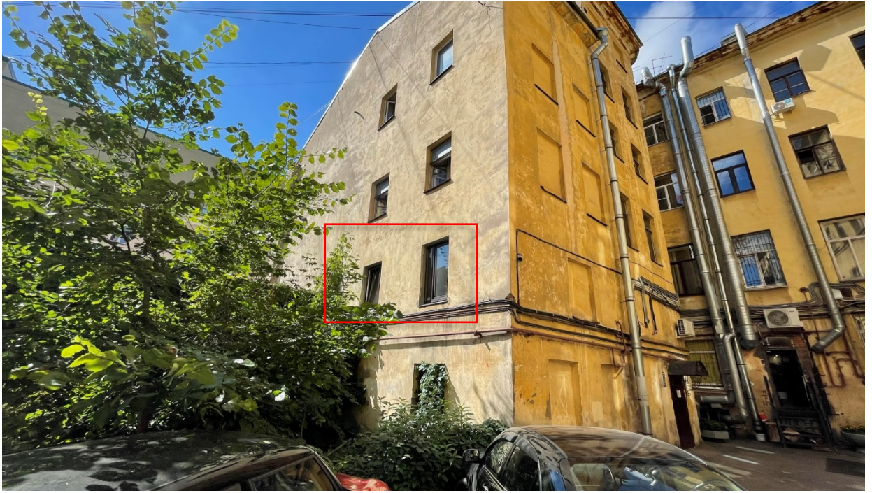
3. Вид на западный и северный дворовые фасады здания;
