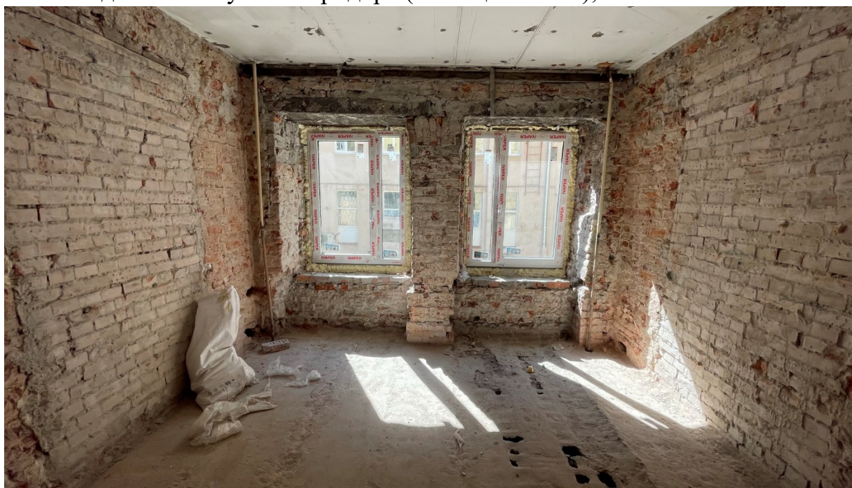
9. Фрагмент интерьера гостиной (помещение №5);
