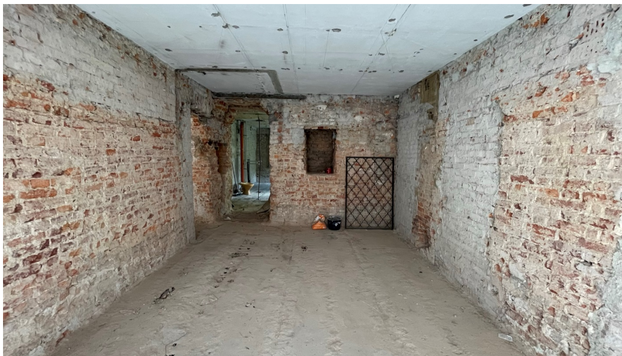
10. Фрагмент интерьера гостиной (помещение №5);
