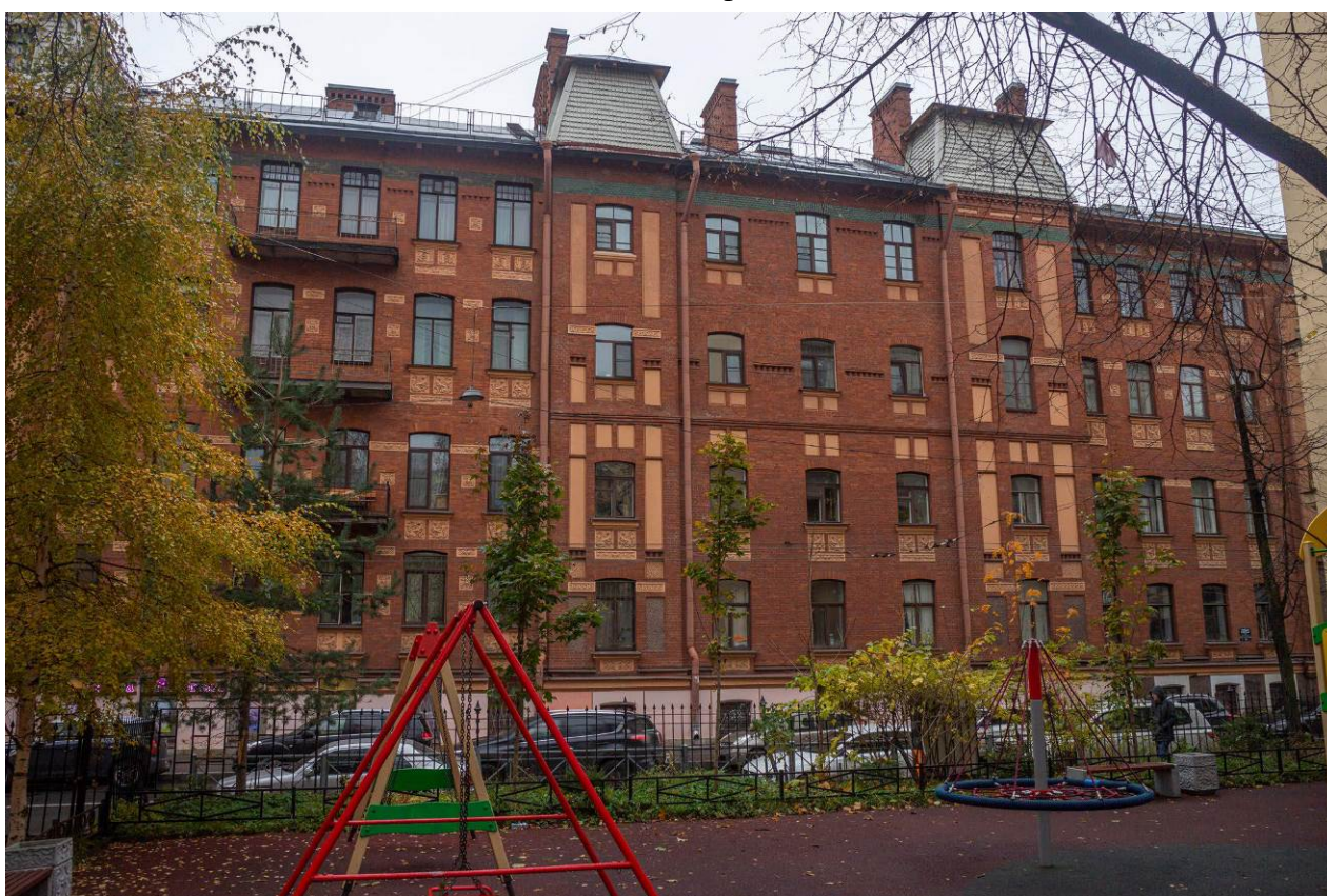
Фото 6. «Дом Е.Ц. Кавоса». Общий вид южного лицевого фасада. Дата съемки: 16.09.2022
