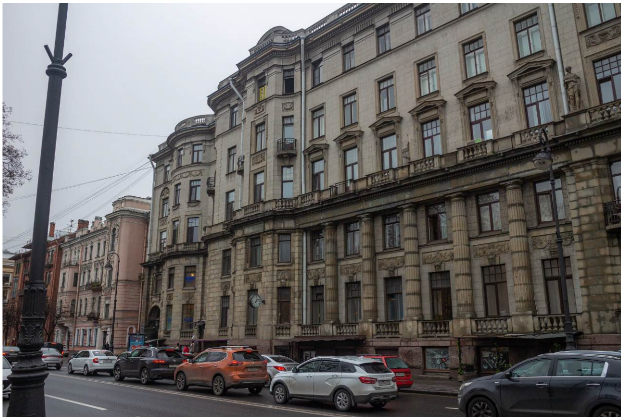
Фото 3. «Дом, где в 1926-1934 гг. в квартире 20 жил секретарь Ленинградского губкома ВКП(б) Киров С.М.». Фрагмент лицевого фасада южного объема здания. Дата съемки: 16.09.2022
