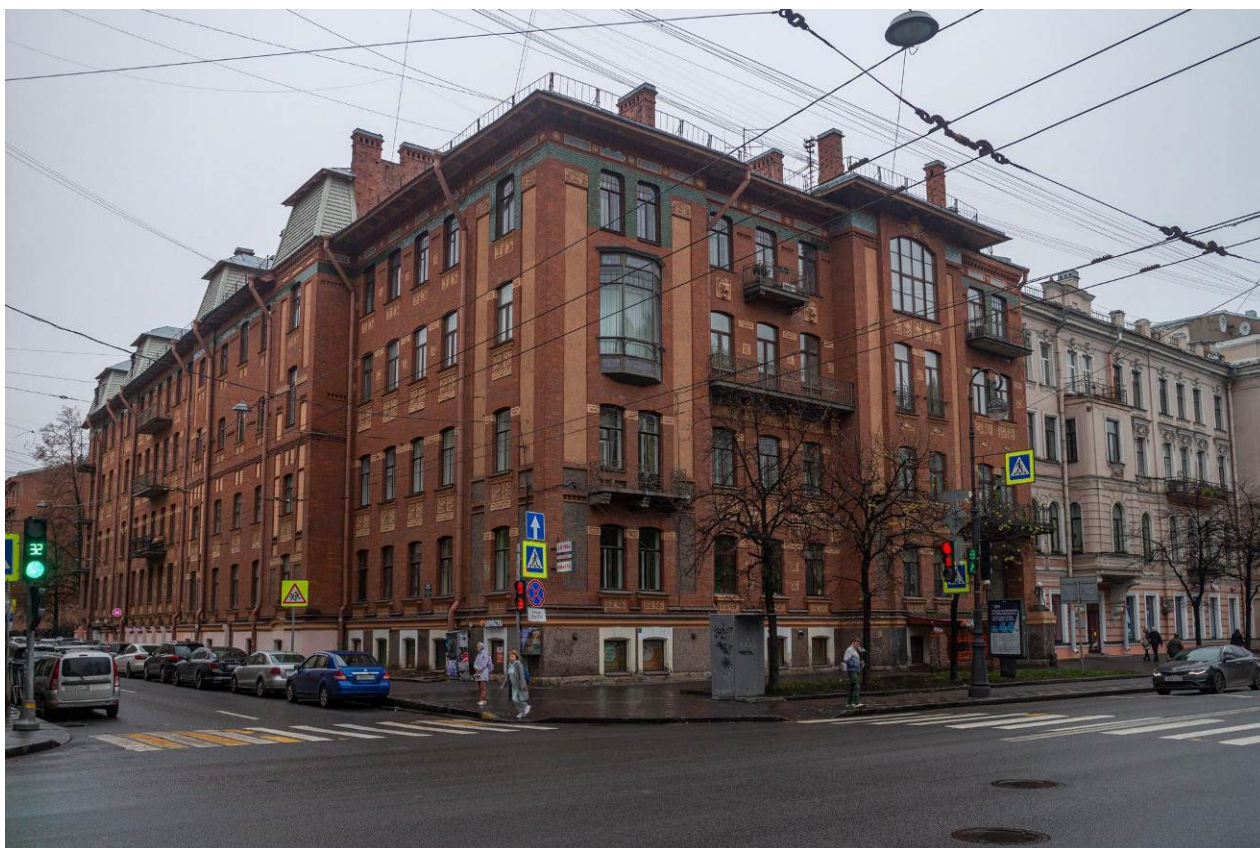
Фото 5. «Дом Е.Ц. Кавоса». Общий вид лицевых фасадов. Дата съемки: 16.09.2022
