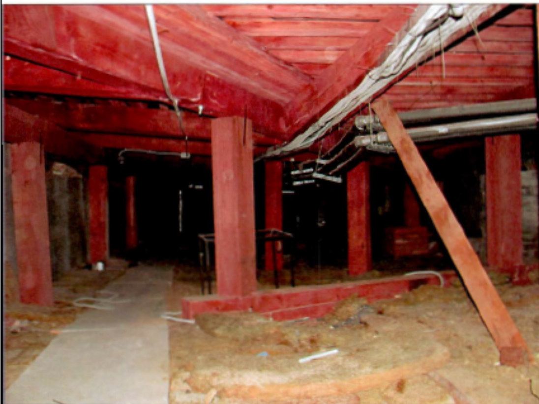
16. «Посольство Германии». Чердак. Стропильная система.
