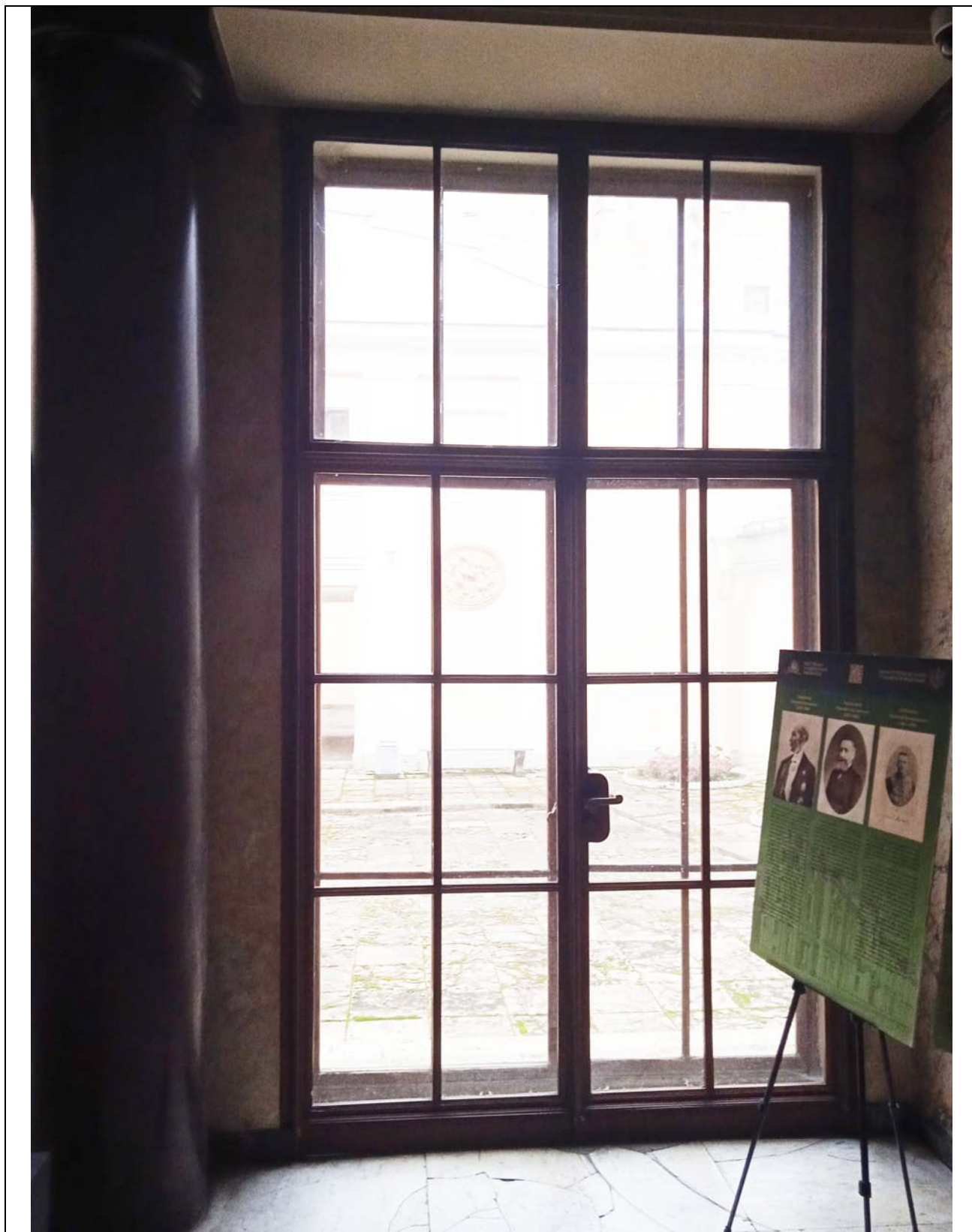
7. Посольство Германии. Вестибюль. Дверное заполнение.
