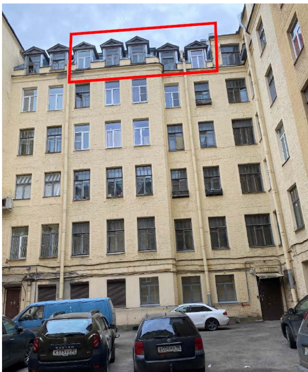
2. Оконные заполнения квартиры №10 в уровне мансардного этажа выявленного объекта культурного наследия «Дом М.Д. Корнилова», расположенного по адресу: г. Санкт-Петербург, Малый проспект П.С., д. 26-28, литера А. 26.10.2022.
