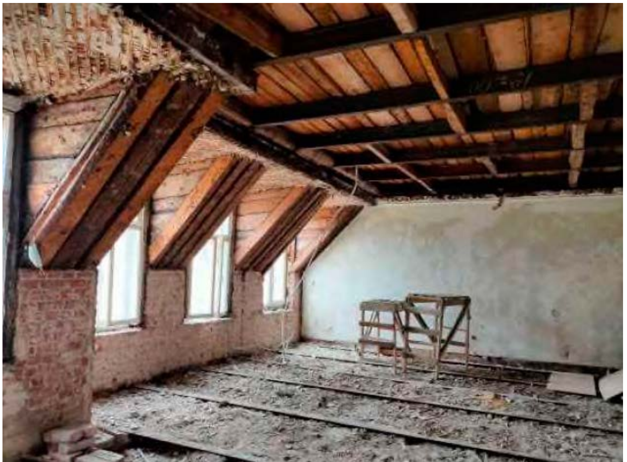
4. Помещение №14 квартиры №10 в уровне мансардного этажа выявленного объекта культурного наследия «Дом М.Д. Корнилова», расположенного по адресу: г. Санкт-Петербург, Малый проспект П.С., д. 26-28, литера А. 26.10.2022.
