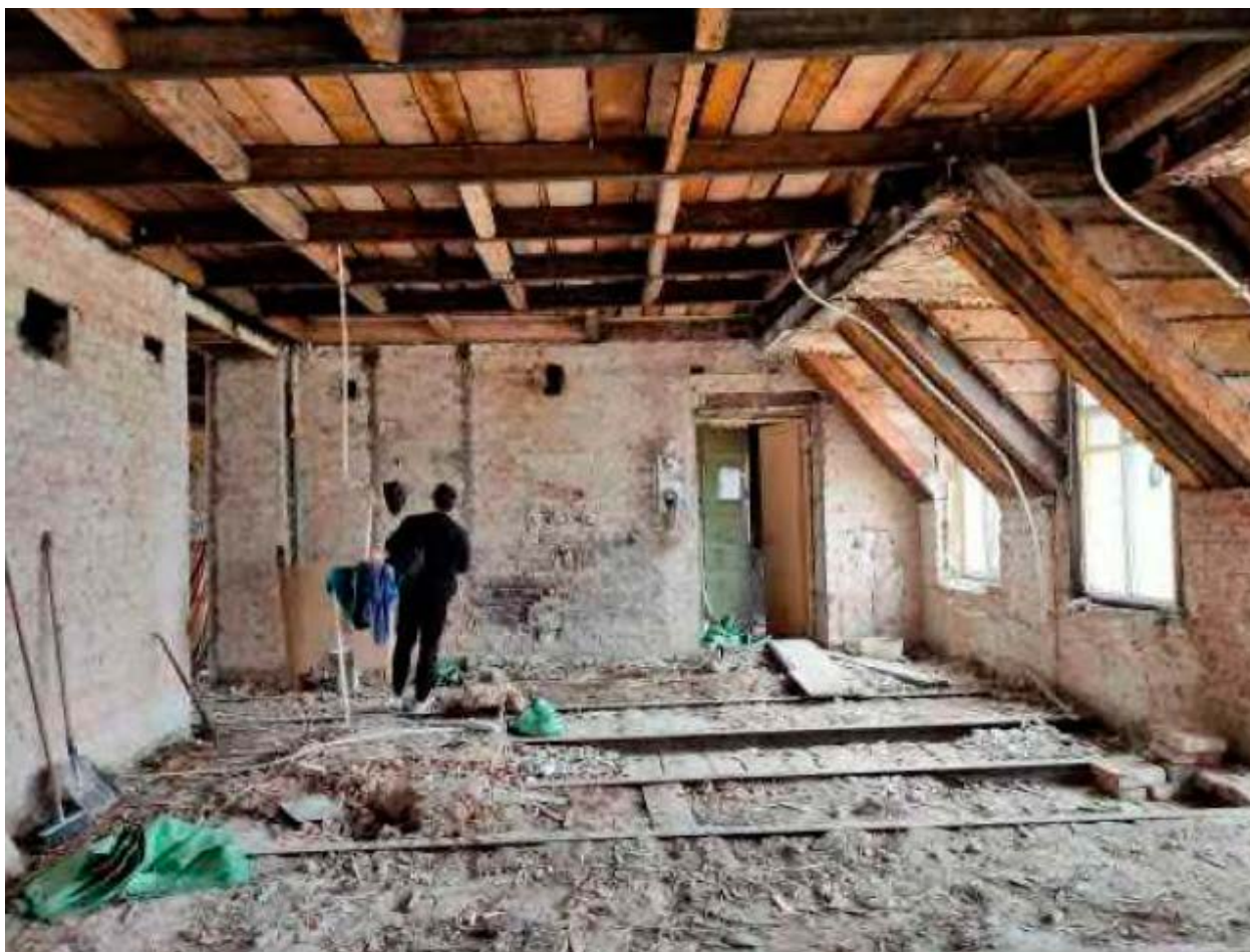
6. Помещения №№6-8 квартиры №10 в уровне мансардного этажа выявленного объекта культурного наследия «Дом М.Д. Корнилова», расположенного по адресу: г. Санкт-Петербург, Малый проспект П.С., д. 26-28, литера А. 26.10.2022.
