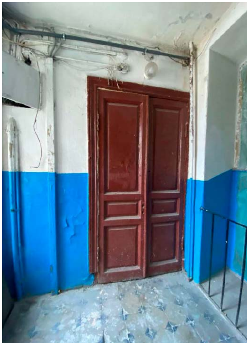
7. Входные дверные заполнения квартиры №10 в уровне мансардного этажа выявленного объекта культурного наследия «Дом М.Д. Корнилова», расположенного по адресу: г. Санкт-Петербург, Малый проспект П.С., д. 26-28, литера А. 26.10.2022.
