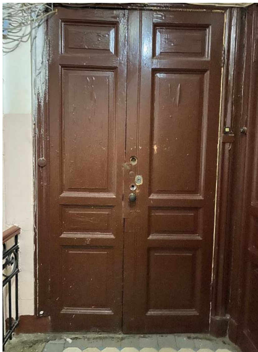
3. Входные дверные заполнения квартиры №10 в уровне мансардного этажа выявленного объекта культурного наследия «Дом М.Д. Корнилова», расположенного по адресу: г. Санкт-Петербург, Малый проспект П.С., д. 26-28, литера А. 26.10.2022.
